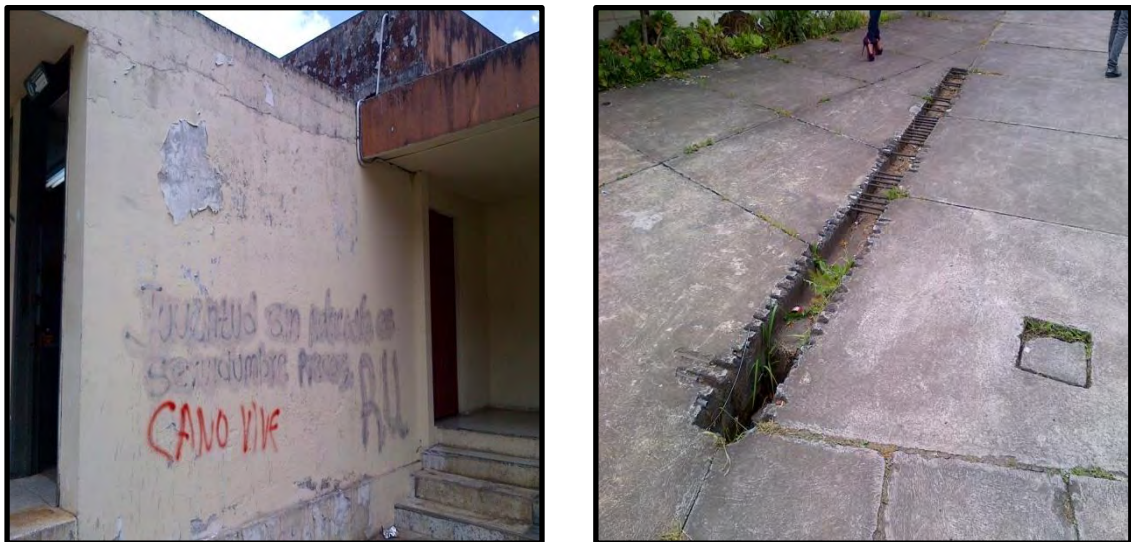
Figura 39. Deterioro físico de las instalaciones del campus universitario – Bloque I (2012)
