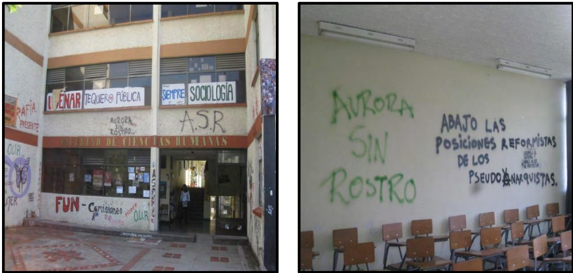
Figura 40. Deterioro físico y contaminación visual del Bloque III – UDENAR Torobajo
