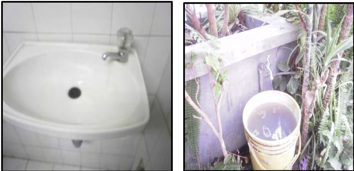
Figura 33. Mal manejo del agua en las instalaciones de la Universidad
