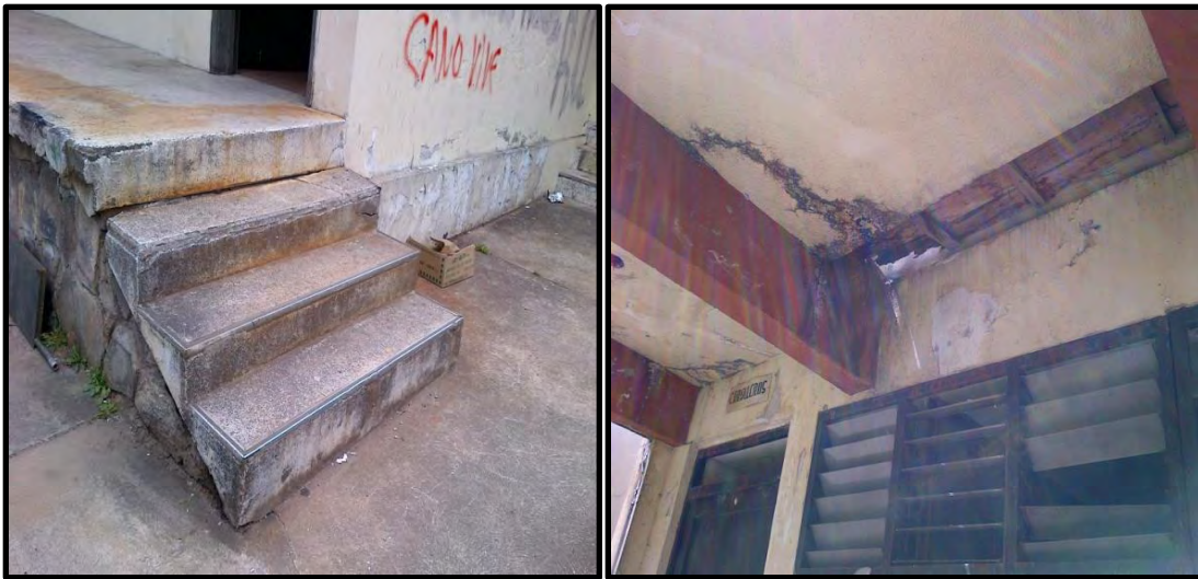
Figura 38. Deterioro de las instalaciones Bloque I (2012)
