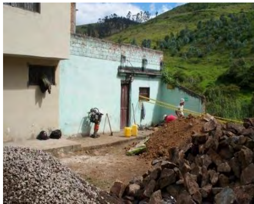
Figura 6. Carrera 31B con Calle 21 a .
