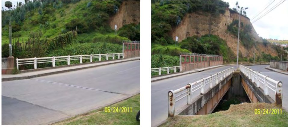
Figura 9. Malla sobre el Puente.
