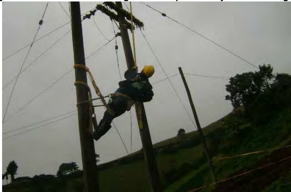
Figura 8. Se observa las reglas de oro para trabajo eléctrico seguro
