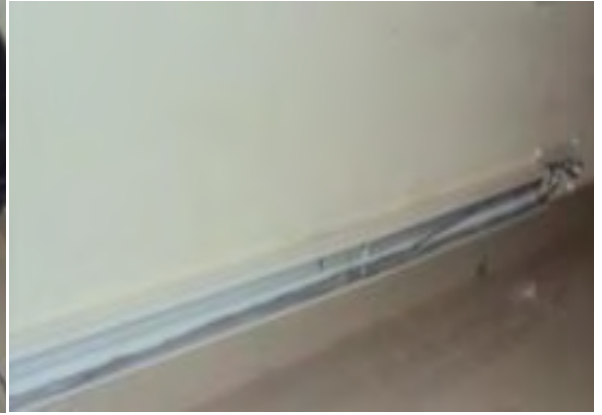
Foto 16. Tendido del Cable Hasta Soporte de Toma
