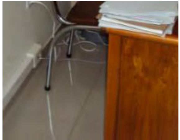
Foto 22. Canaleta Cubierta Acabado en Toma
