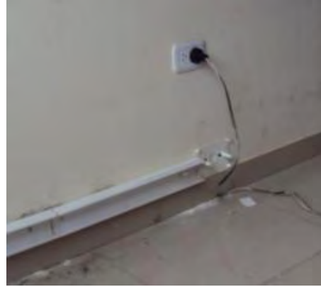
Foto 12. Tendido de Canaleta con Soporte para Toma
