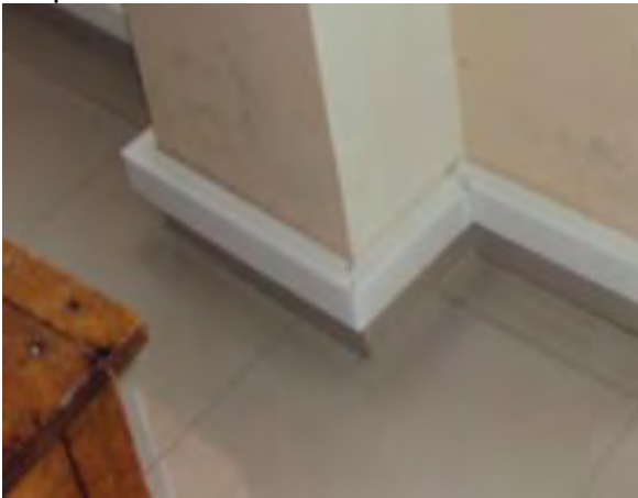
Foto 21. Canaleta Cubierta Acabado en Esquinas
