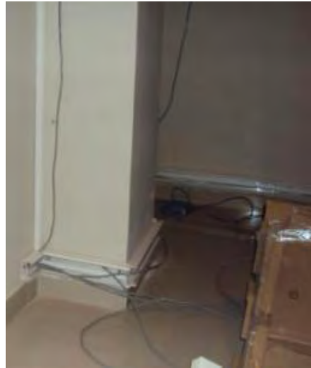
Foto 18. Tendido del Cable con Acabado en Esquina
