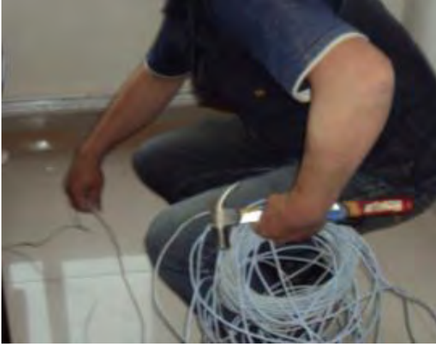
Foto 15. Utilización de cableado
