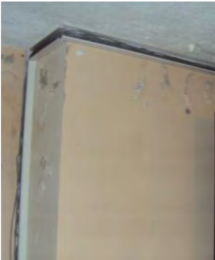
Foto 17. Tendido de Cable Puntos Elevados
