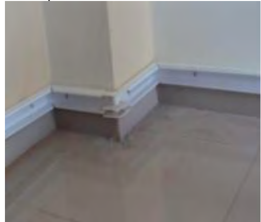
Foto 14. Tendido de Canaleta acabado en esquina.
