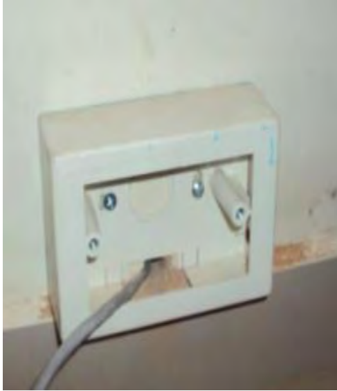
Foto 19. Tendido de Cable Toma
