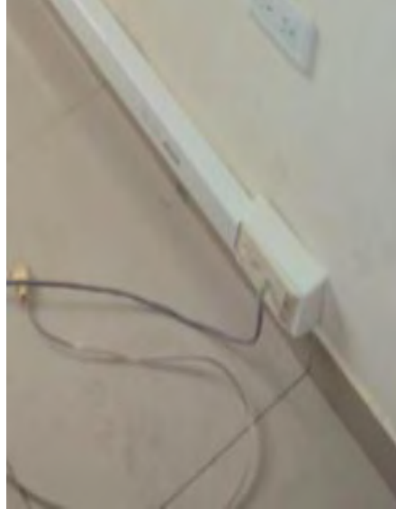
Foto 20. Tendido del Cable Toma No. 2
