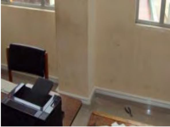
Foto 11. Tendido de Canaleta Continuación
