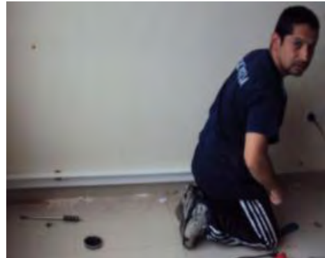
Foto 10. Tendido de Canaleta
