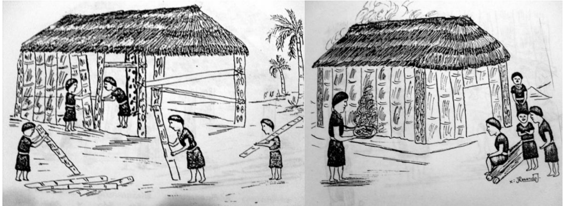
Figura 51. Construcción de las paredes y limpieza de materiales sobrantes de la vivienda – año 1964 - Sibundoy – Putumayo - Dibujos Andrés Juajibioy - Año 2.000
