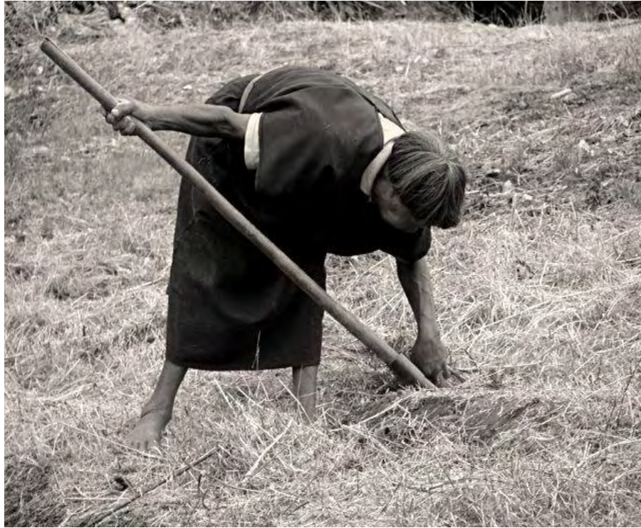
Figura 45. Limpieza de predio para iniciar construcción de vivienda– Nicolás Narváez– año 1984 - Sibundoy – Putumayo -
