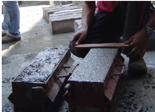
Figura 18. Terminado de vigas con palustre
