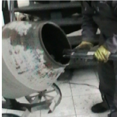
Figura 9 . Mezcla mecánica de agregados
