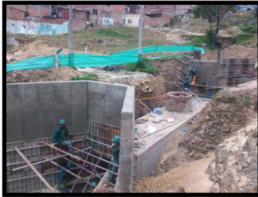
Imagen 77. Box culvert Carrera 18C.
