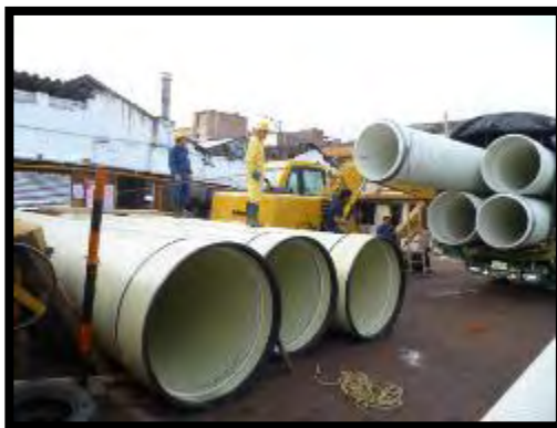
Imagen 29. Transporte y almacenamiento de tubería.
