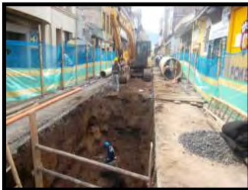
Imagen 19. Excavación para tubería de 54" de diámetro.
