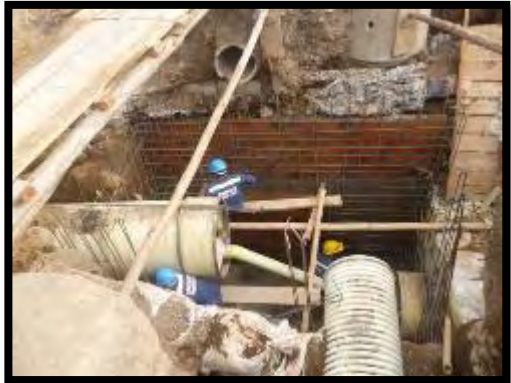
Imagen 38. Construcción de cámara en concreto reforzado para tubería de 60".
