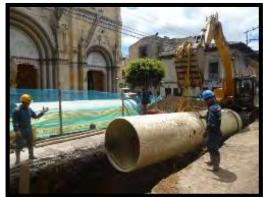
Imagen 30. Instalación de tubería de 48" con retroexcavadora.
