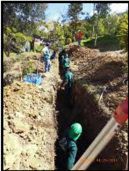
Imagen 67. Excavación manual sector Alpes
