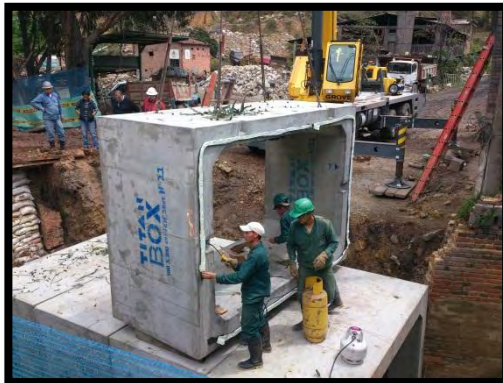
Imagen 64. Instalación de cinta viscoelástica para sello de juntas.
