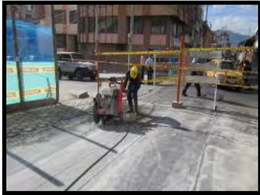
Imagen 15. Demolición de pavimento.
