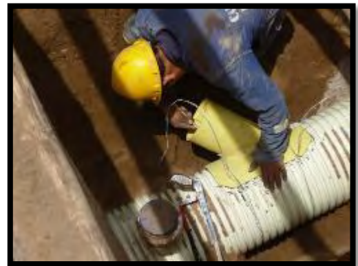
Imagen 44. Instalación de silla yee.
