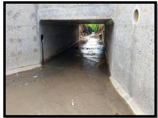
Imagen 86. Cabezal de salida box calle 68 Santa Librada.
