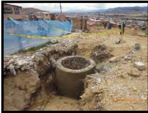
Imagen 71. Construcción de pozos de inspección.
