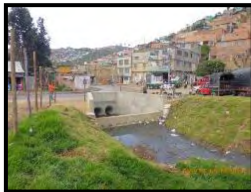
Imagen 56. Estado final del cabezal y recuperación del espacio público.
