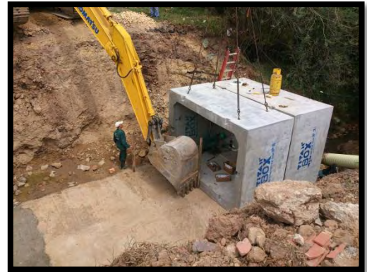
Imagen 65. Unión de cajones con retroexcavadora.
