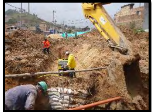
Imagen 90. Relleno y compactación.
