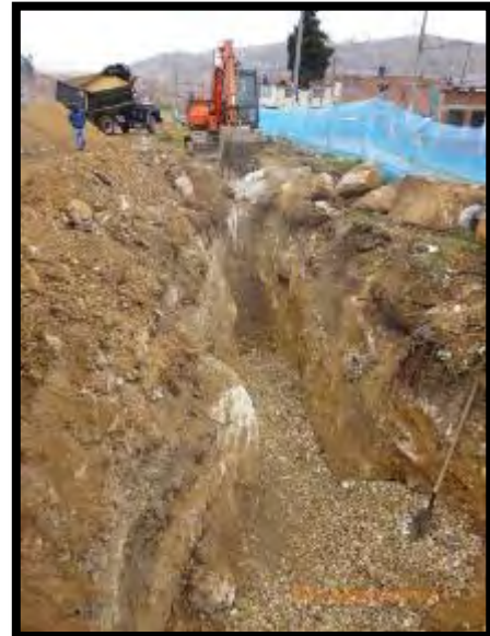
Imagen 68. Excavación con retroexcavadora sector Quintas
