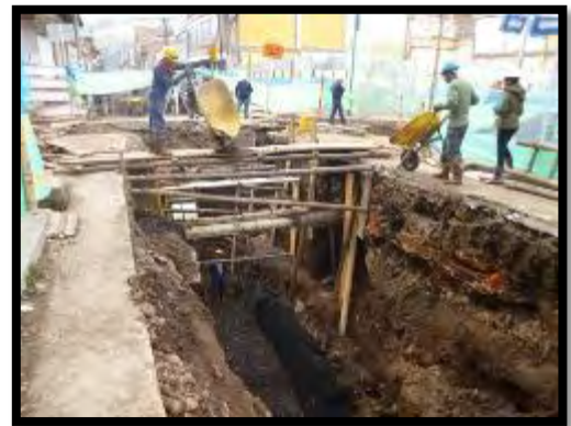
Imagen 28. Profundas Encamado de tubería
