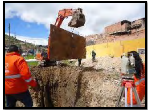
Imagen 88. Instalación laminas metálicas para entibado.
