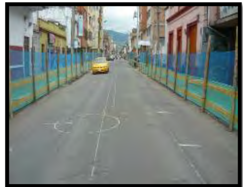
Imagen 10. Demarcación con pintura
