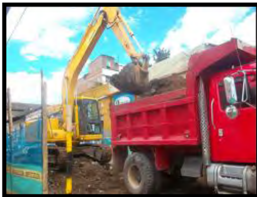
Imagen 23. Cargue de volquetas con retroexcavadora.
