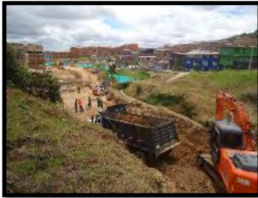
Imagen 87. Corredor de obra – Quebrada Santa librada.
