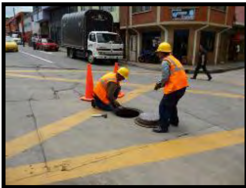
Imagen 9. Inspección de redes existentes.
