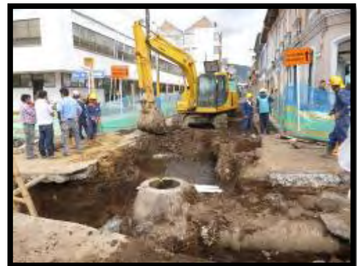
Imagen 20. Excavación con retroexcavadora CAT200.
