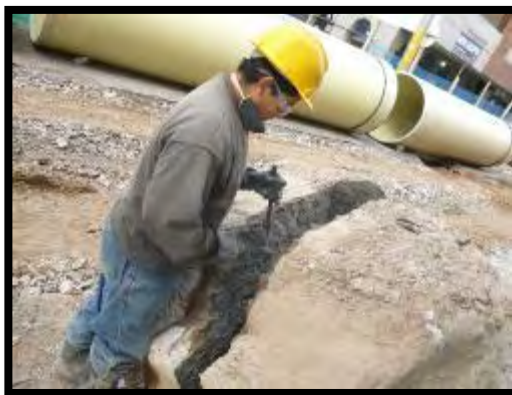
Imagen 17. Demolición de roca.
