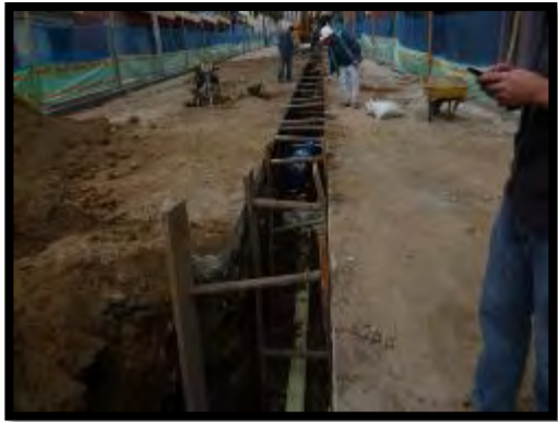
Imagen 21. Excavación para tubería de diámetro 10”.
