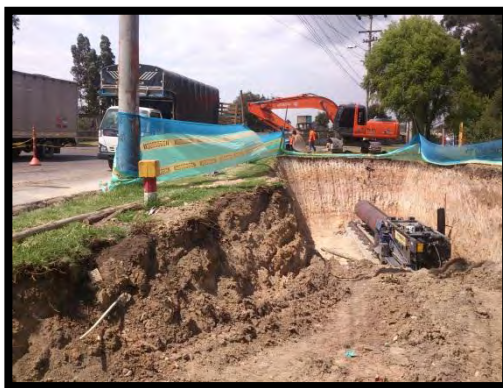
Imagen 91. Excavación y disposición de maquinaria.
