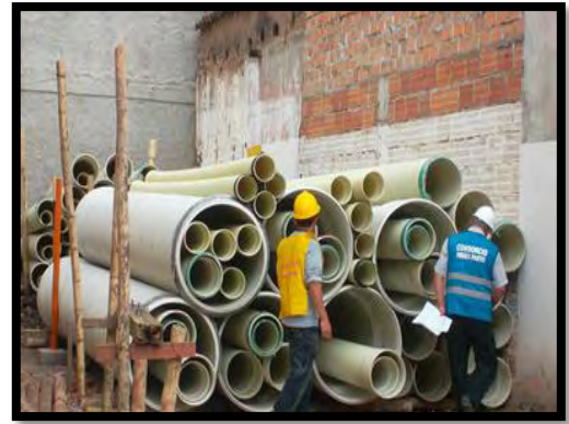
Imagen 32. Almacenamiento de tubería.
