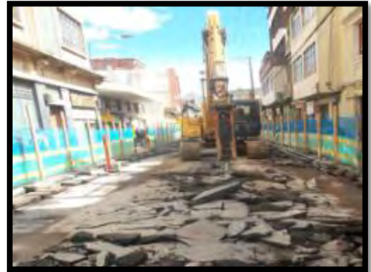
Imagen 16. Demolición de red antigua.
