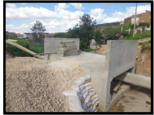
Imagen 78. Box culvert Carrera 18G.
