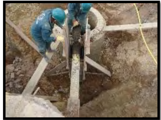
Imagen 76. Recubrimiento en concreto.
