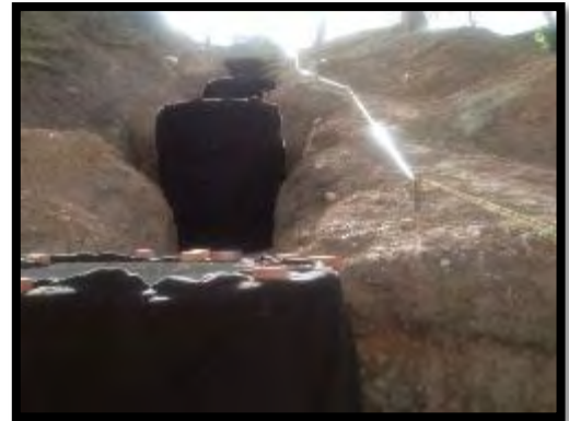
Imagen 72. Instalación de geotextil y relleno.
