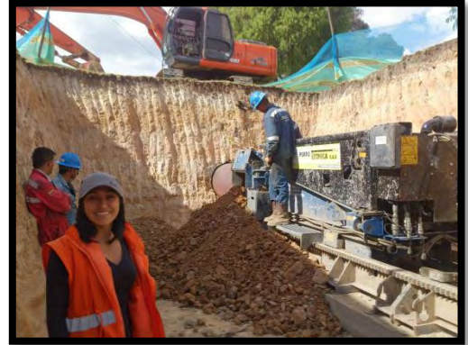
Imagen 94. Recorte y extracción de material por medio de tornillos sinfín.
