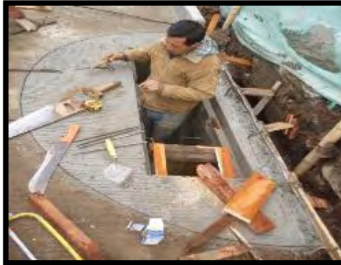
Imagen 42. Construcción de sumideros.
