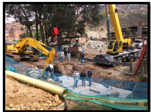
Imagen 62. Maquinaria PH y retroexcavadora.
