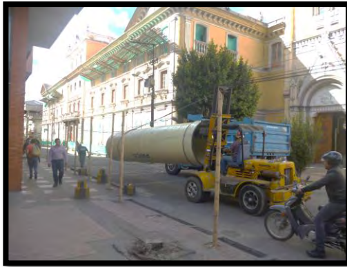
Imagen 31. Transporte de tubería con montacargas”.
