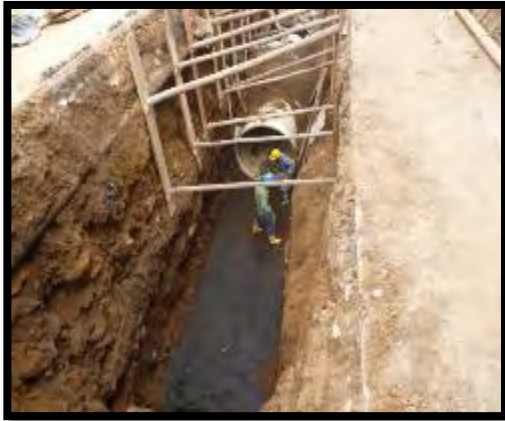
Imagen 27. Entibado de excavaciones
