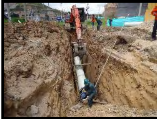
Imagen 89. Instalación de tubería de 20”.
