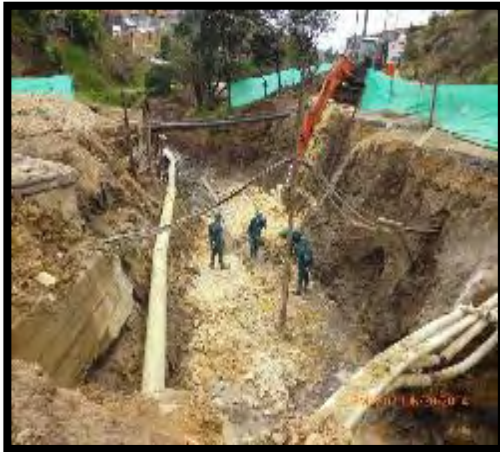
Imagen 58. Excavación para box culvert cra 18G quebrada Limas.
