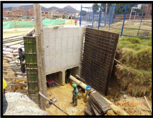
Imagen 57. Cabezal de entrada box culvert Trv. 18C barrio La Joya.
