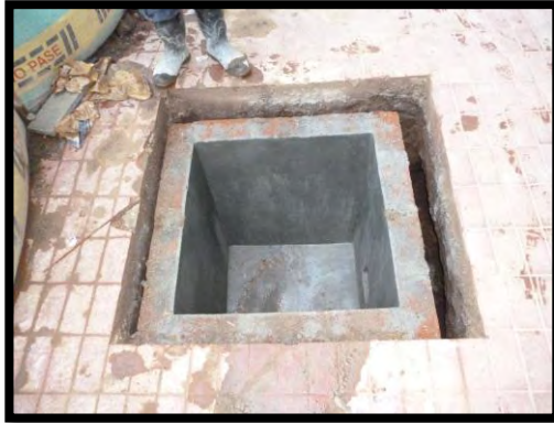
Imagen 45. Construcción de cajillas con ladrillo en sogá.
