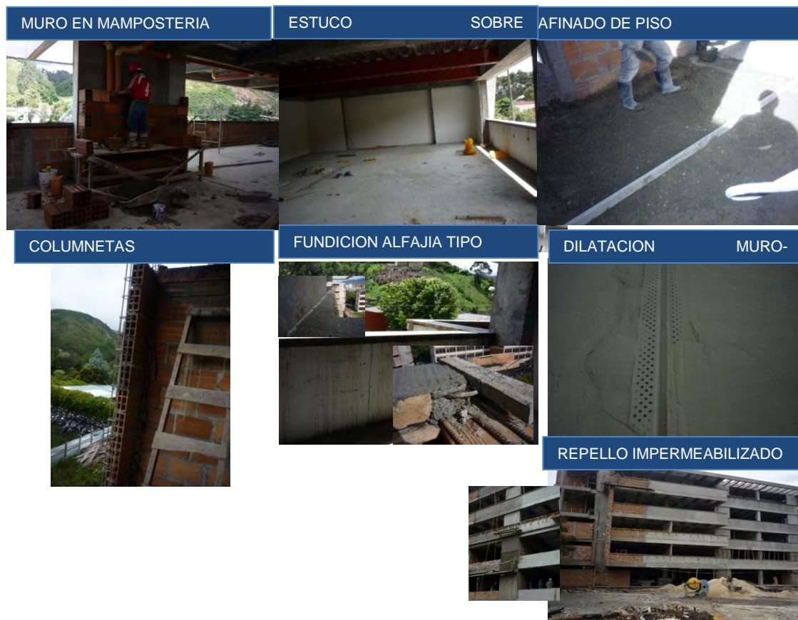
Ilustración 59. Mamposteria - pañetes - Estuco para muros
