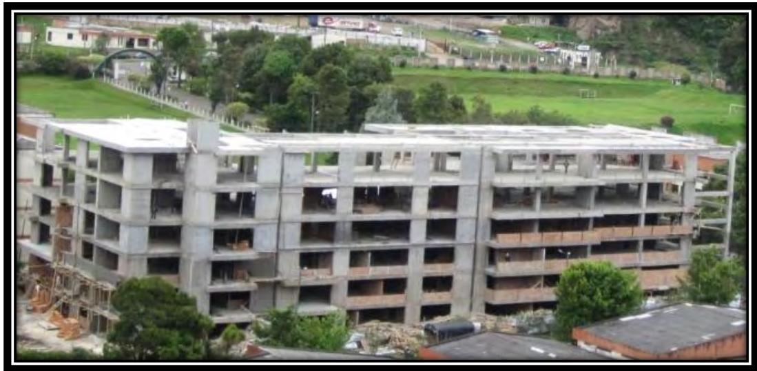
Ilustración 34 Estado inicial de la obra a intervenir
