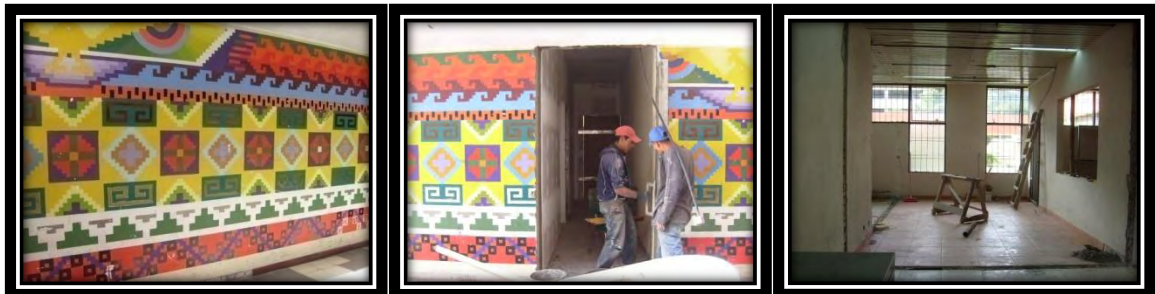
Ilustración 7. Demolición de muro en ladrillo E=15 cm.
