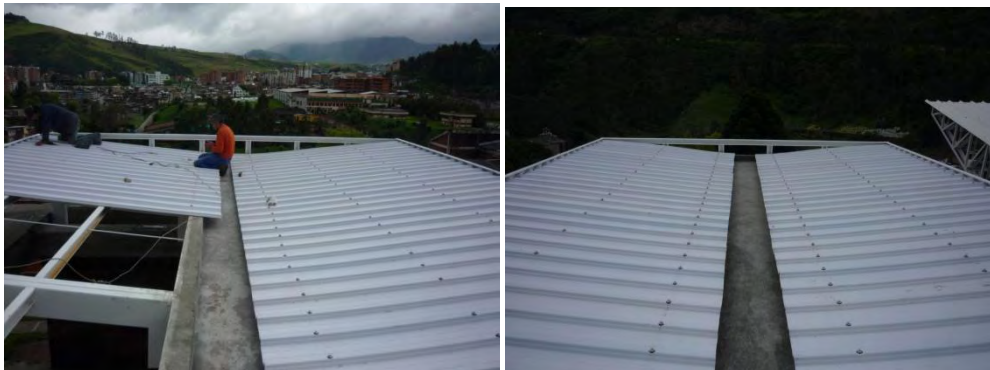
Ilustración 77. Instalación de Teja EKOROOFT
