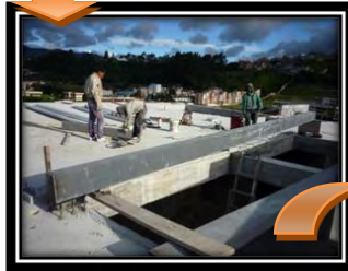
INSTALACION DE PERFIL CAJON
