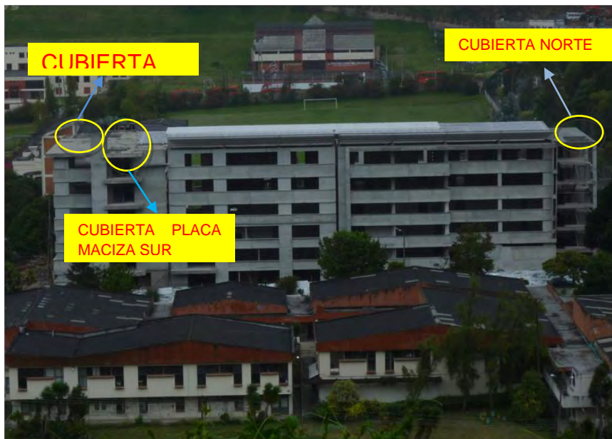
Ilustración 70. Estado inicial de la Obra
