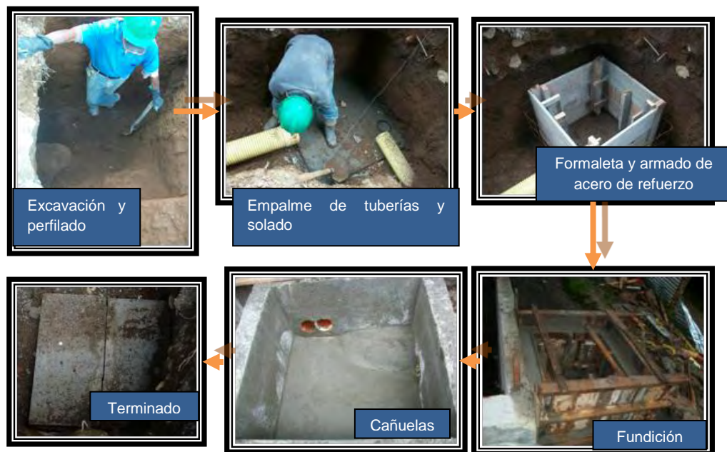
Ilustración 46. Elaboración de caja de inspección en concreto
