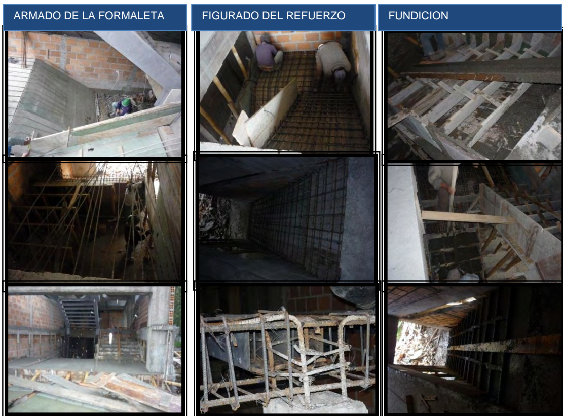
Ilustración 58 Armado de formaleta, forjado de acero de refuerzo, fundición de escaleras de concreto
