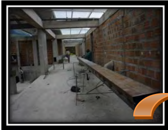
ELABORACION DE CERCHA EN PERFIL
