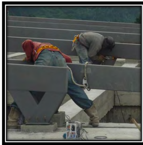
UTILIZACION DE MASCARA PARA SOLDAR Y ARNEX PARA TRABAJAR EN ALTURA
