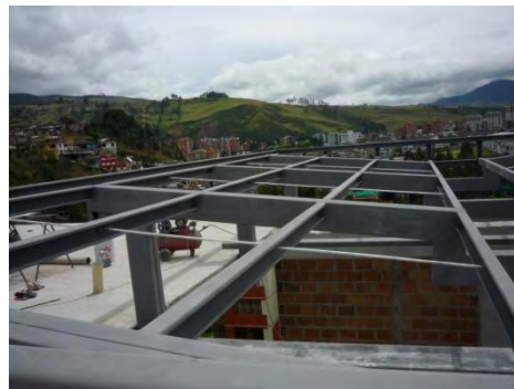
Ilustración 76. Tensores en varilla roscadas 1/2"
