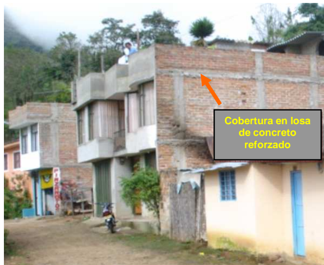
Figura 15. Cubierta en concreto reforzado
