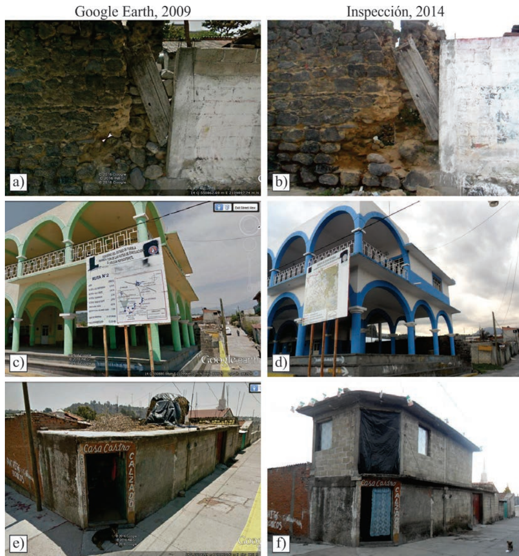
Figura 5 Verificación de diferencias entre Google Earth, 2009 (lado izquierdo) y las mismas edificaciones observadas durante la visita de campo en 2014 (lado derecho). a y b) Estado de dos muros. c y d) Alcaldía. e y f) Modificación estructural en vivienda.
