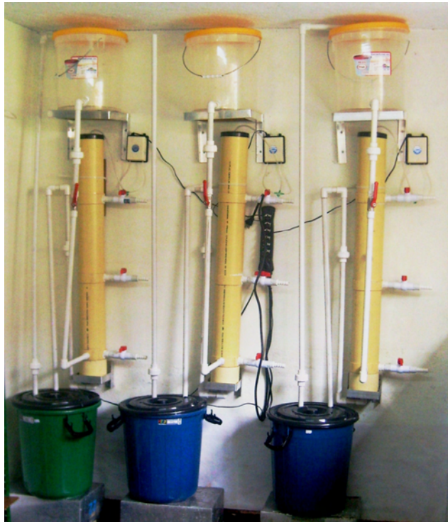
Figura 9. Montaje final tres BFAs. (Fuente: esta investigación).
