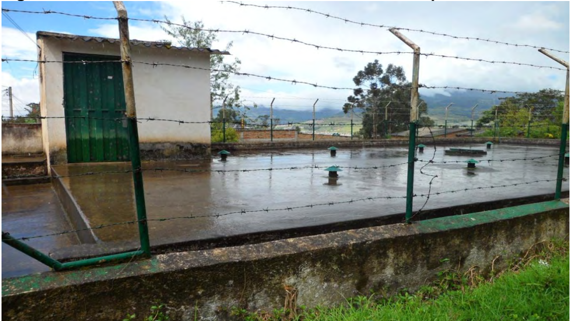
Figura 27. Caseta de Cloración Barrio el Rosario Municipio de Pasto.
