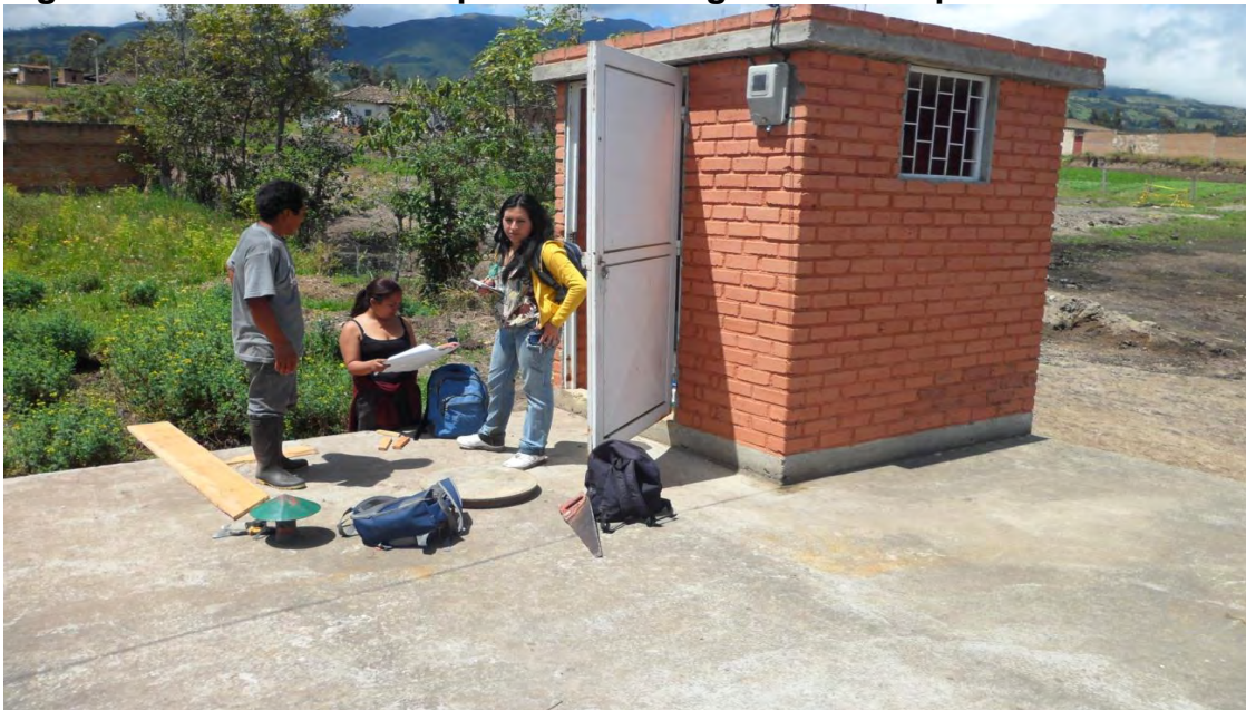
Figura 40. Estación 9 Tanque Centro Jongovito Municipio de Pasto.
