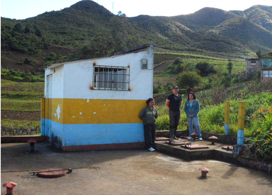
Figura 25. Tanque de almacenamiento y cloración del Corregimiento de Jamondino Municipio de Pasto.
