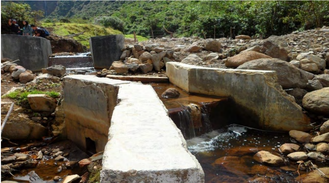
Figura 21. Bocatoma Antigua Corregimiento de Jamondino Municipio de Pasto.
