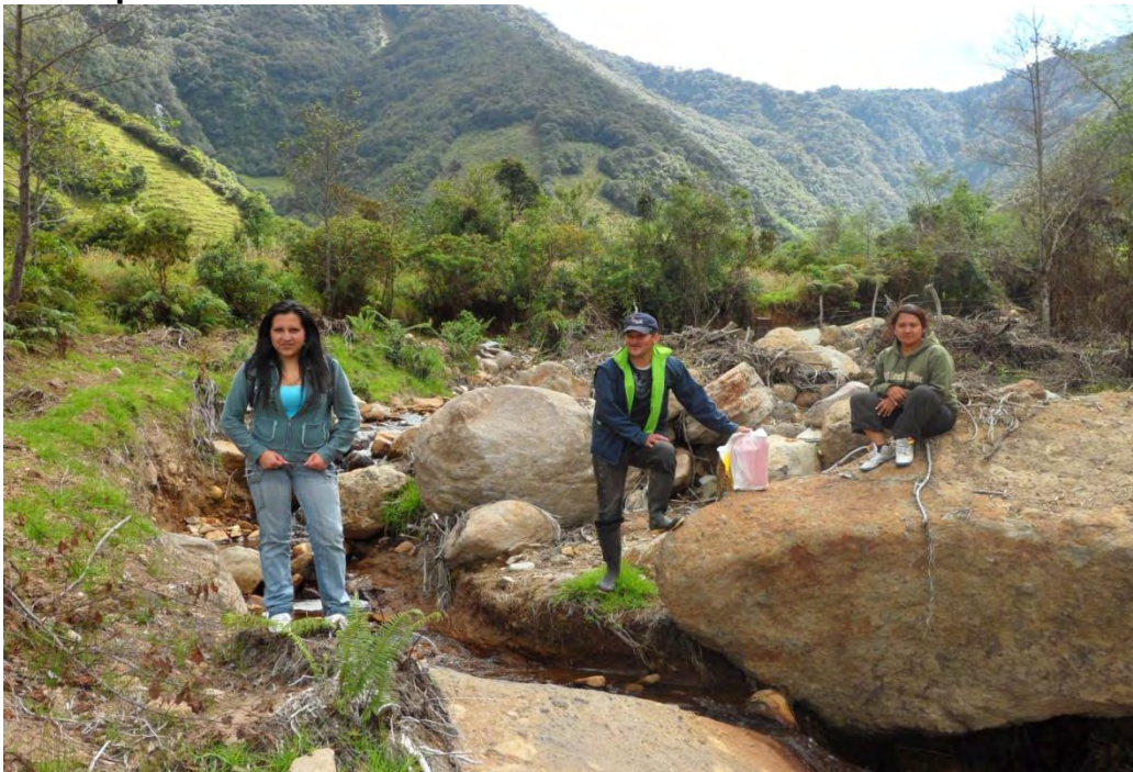
Figura 20. Zona Afectada por Deslizamiento Corregimiento de Jamondino Municipio de Pasto.
