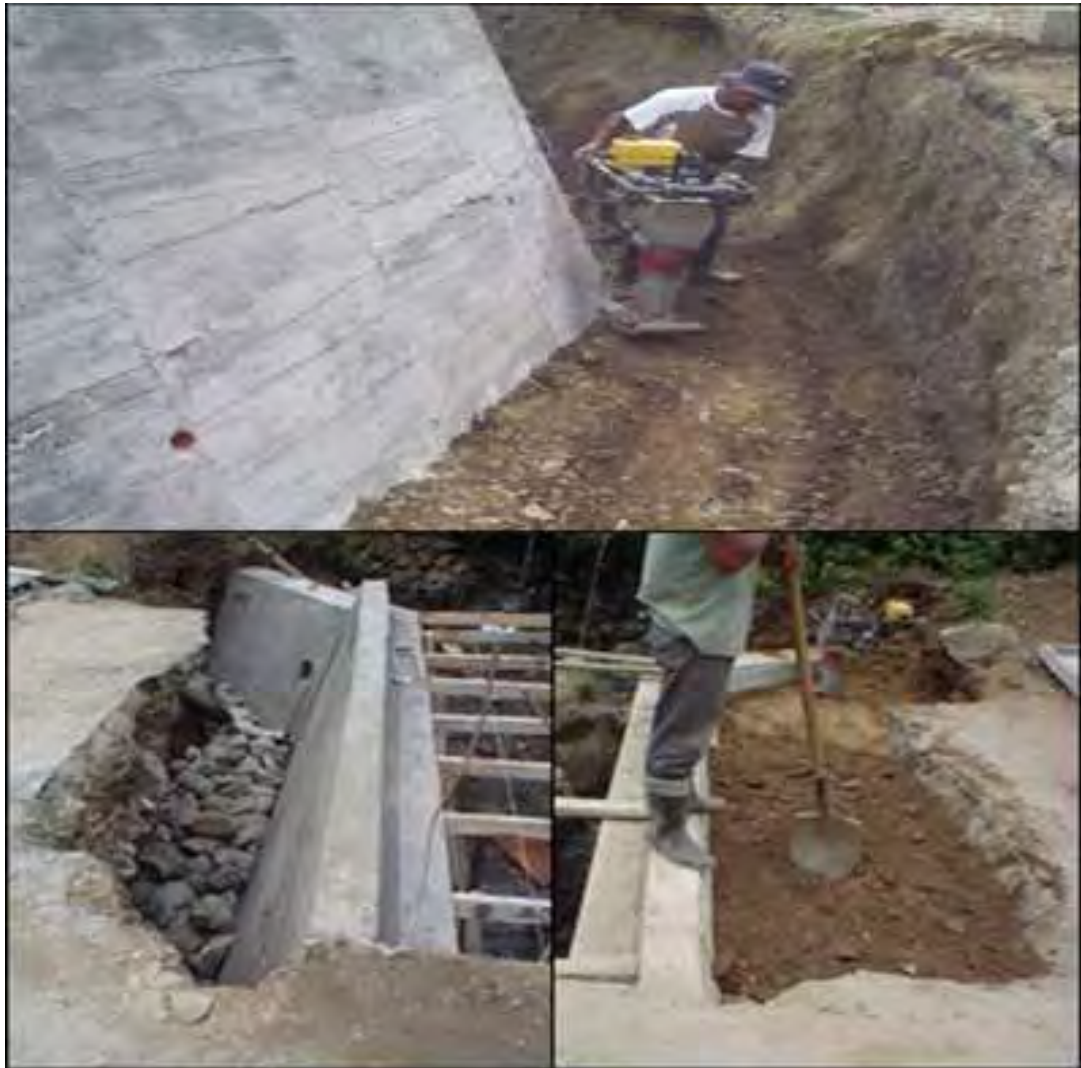
Figura 64 Relleno compactado sobre estribo y aleta.
