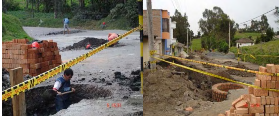
Figura 15 Excavación y construcción cámaras de quiebre
