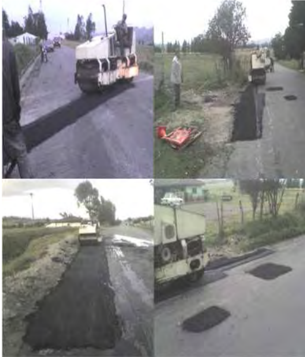
Figura 33 Compactación y terminación del parche
