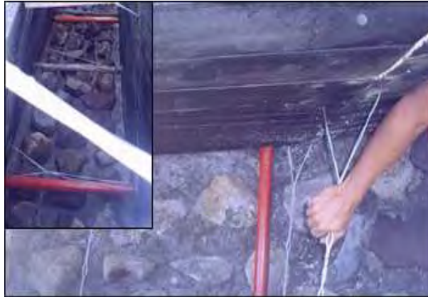
Figura 62 Instalación de tubería para drenaje.
