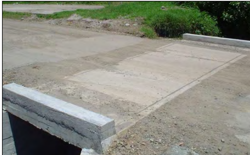
Figura 71 Vista de losa sin formaleta.
