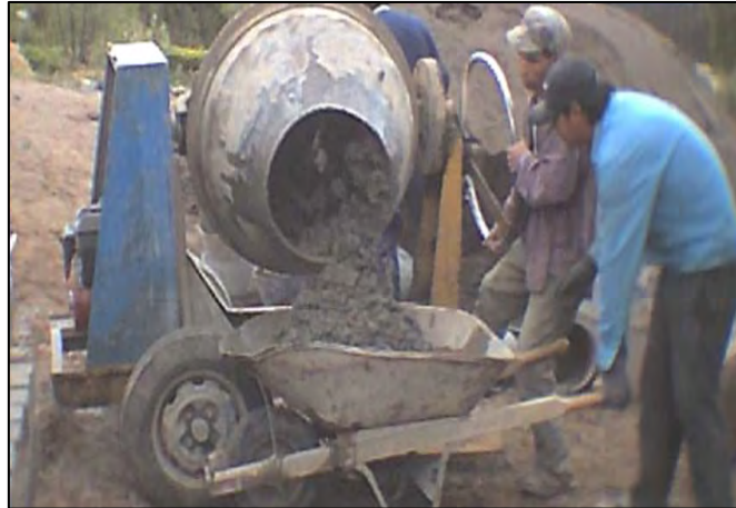
Figura 25 Transporte del concreto
