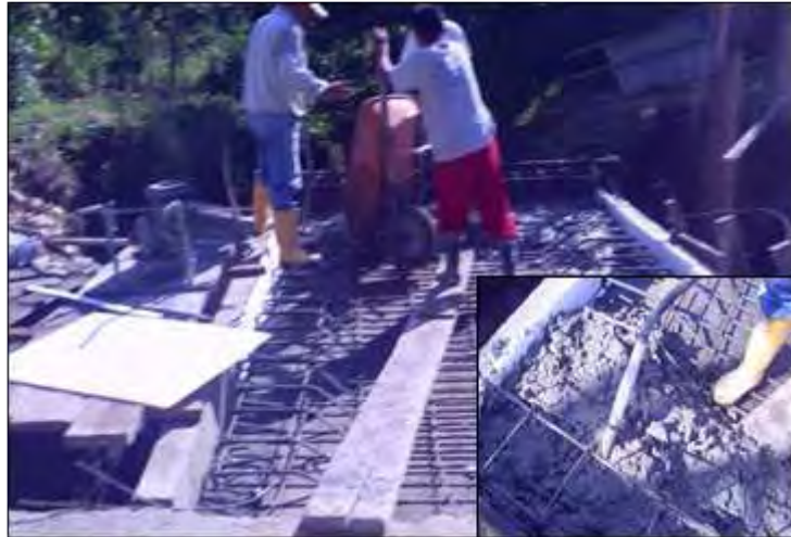
Figura 69 Fundición de losa.
