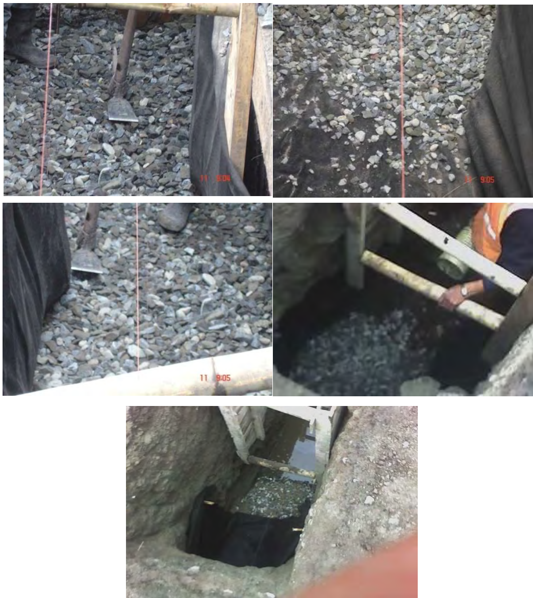
Figura 17 Cama de triturado para tubería con geotextil.
