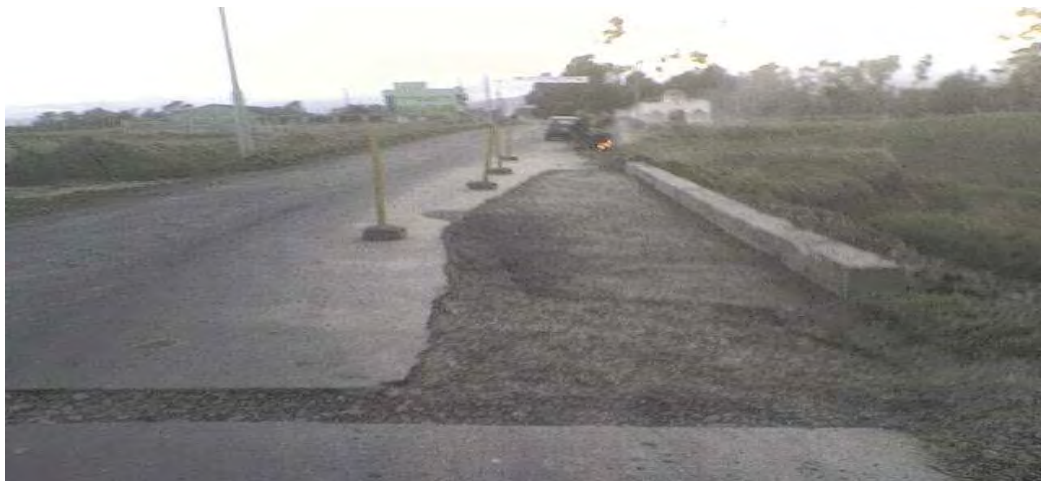
Figura 28 Replanteo y demarcación.
