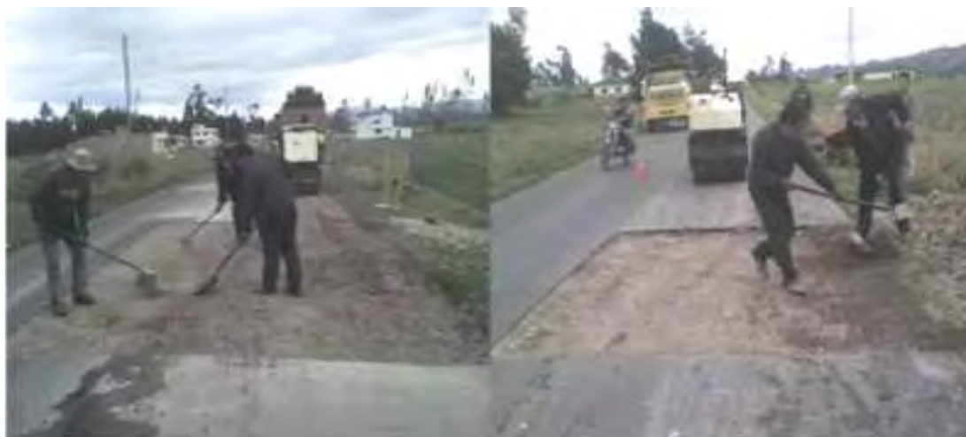
Figura 31 Preparación de la superficie
