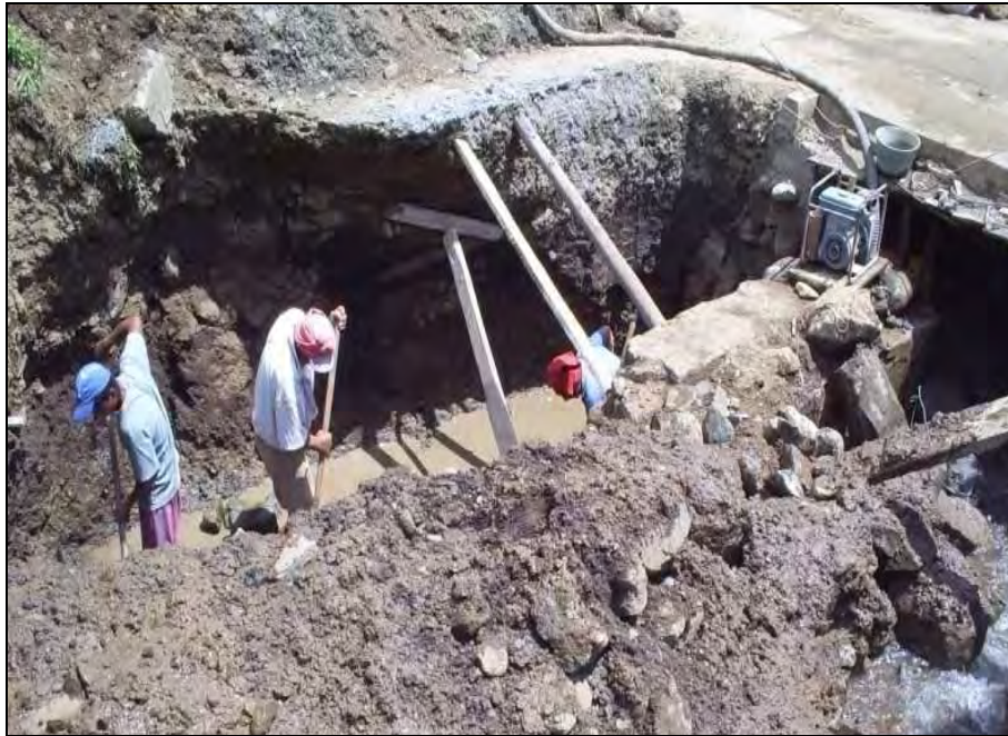
Figura 40 Excavaciones para cimentación.
