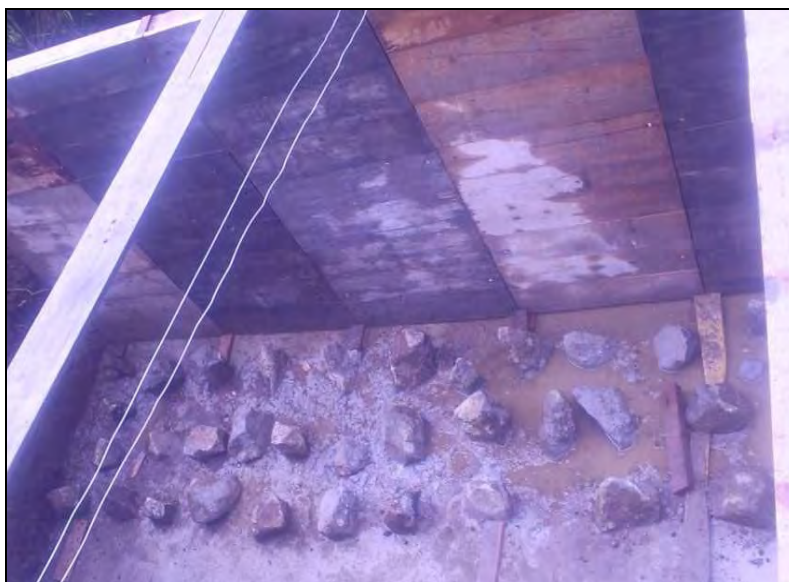
Figura 58 Encofrado para elevación.
