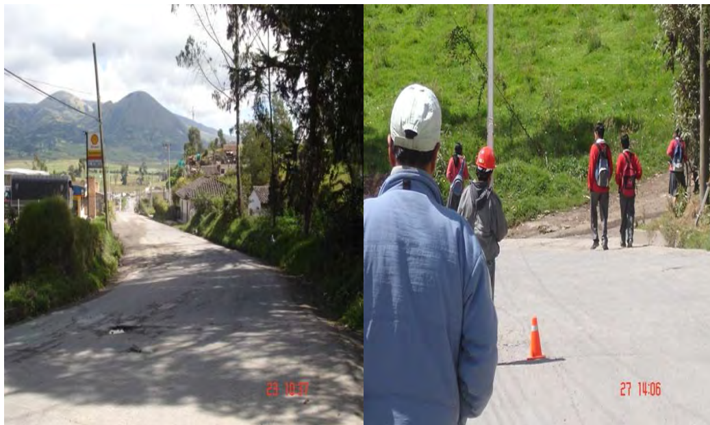
Figura 3 Replanteo y demarcación.
