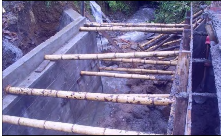
Figura 55 Canaletas para vaciado del concreto.
