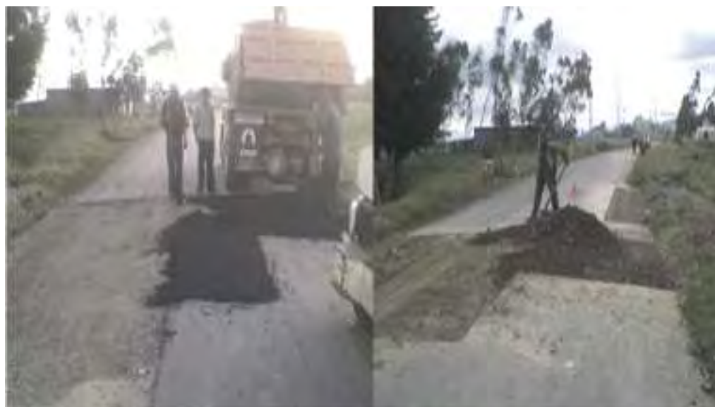
Figura 32 Colocación de mezcla asfáltica
