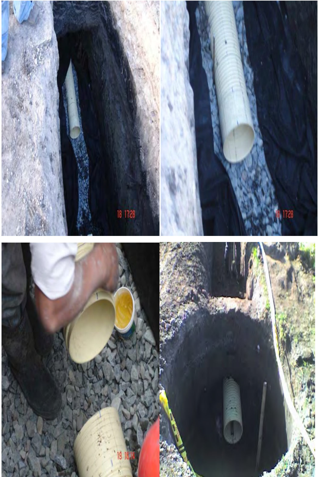
Figura 18 Instalación de tubería corrugada
