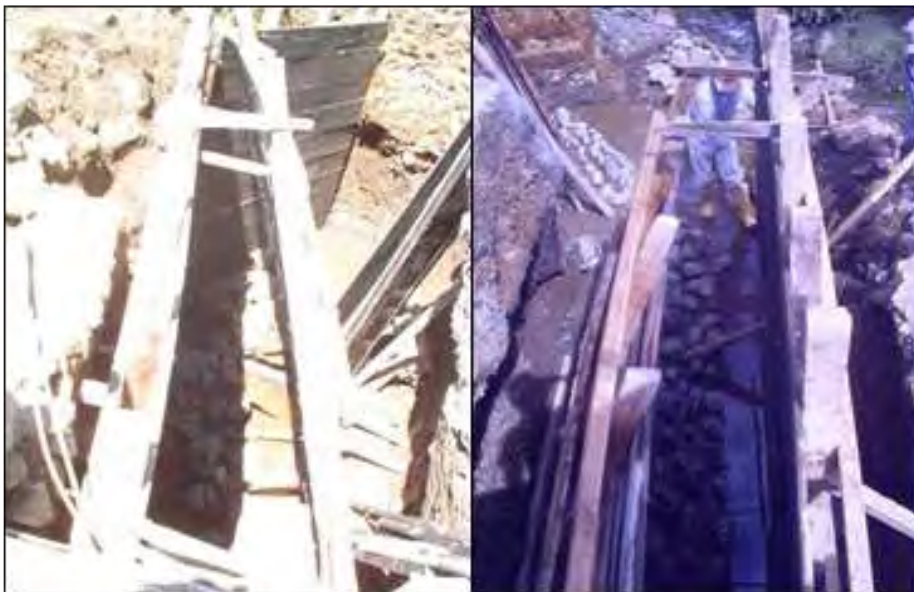
Figura 53 Encofrado para elevación.
