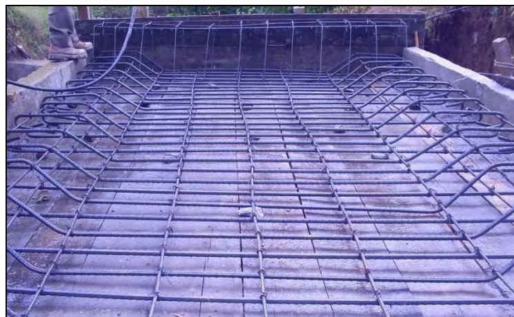
Figura 68 Colocación de refuerzo para losa.
