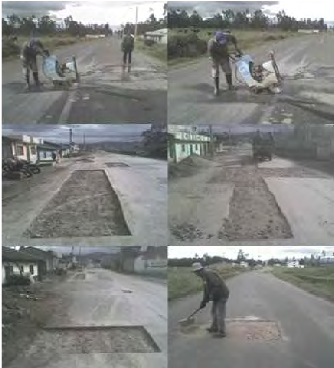
Figura 30 Corte y remoción de área deteriorada
