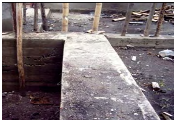
Figura 63 Vista estructura sin formaleta.
