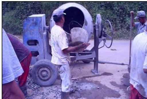
Figura 45 Producción del concreto en obra
