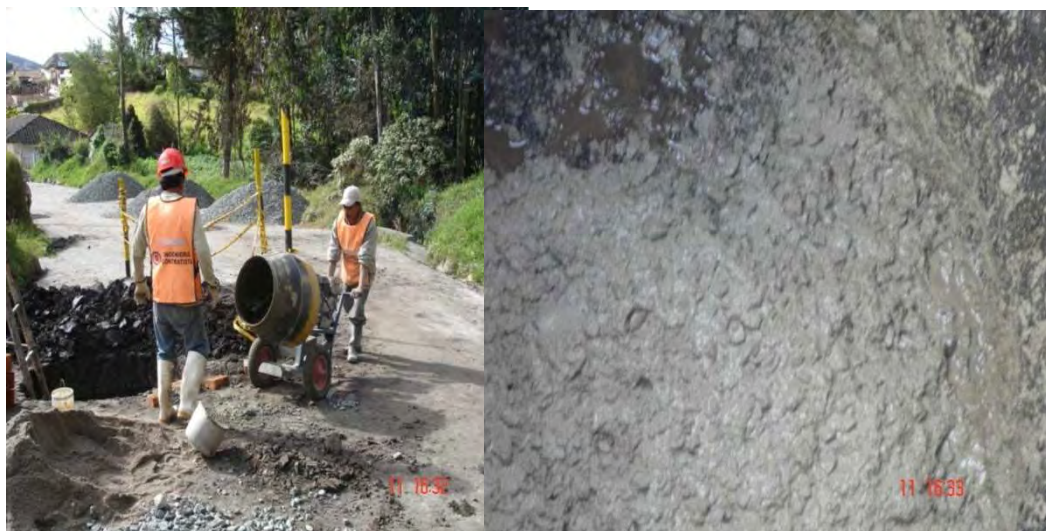
Figura 26 Vaciado del concreto
