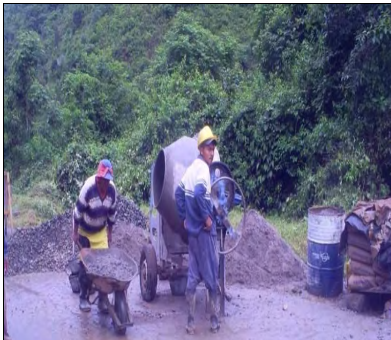
Figura 48 Transporte del concreto
