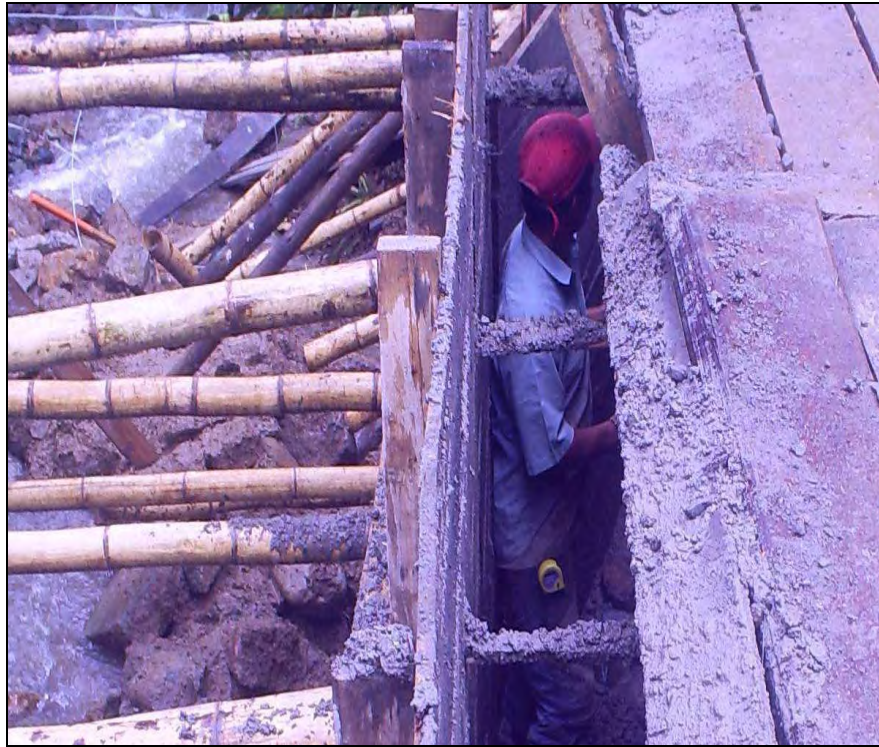
Figura 57 Instalación de tubería para drenaje.
