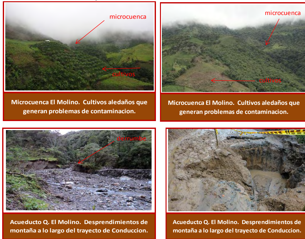
Figura 3. Impacto por deslizamientos en el área de influencia de la microcuenca y conducción, fuente El Molino
