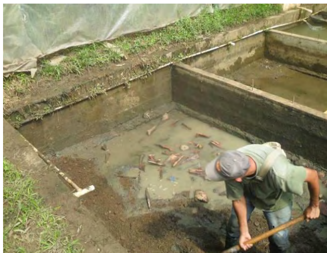
Figura 14. Remoción de lodos y nivelación del fondo del estanque.
