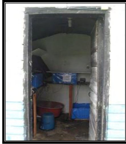
Figura 7 . Adecuación del área
