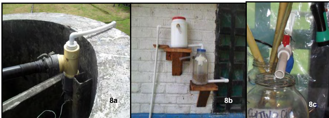
Figura 8. Sistema de captación y almacenamiento de agua.
