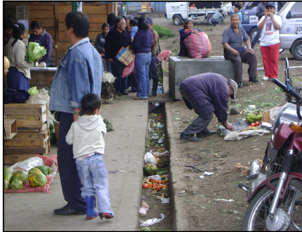
Fotografía 22. Residuos sólidos en alcantarillas y canales en el sector Antigua Plaza de Ferias, plaza de mercado El Potrerillo, San Juan de Pasto (N).
