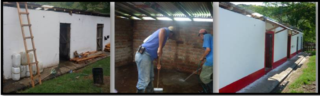
Figura 43. Antes y después de la adecuación de bodegas de almacenamiento
