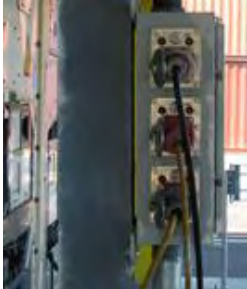
Montajes de estilo andamio y poste
