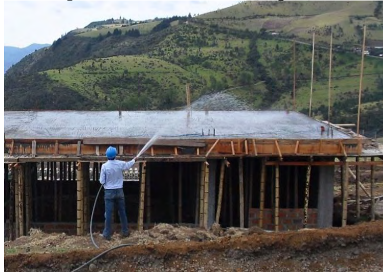
Figura 65 Curado de losa aligerada
