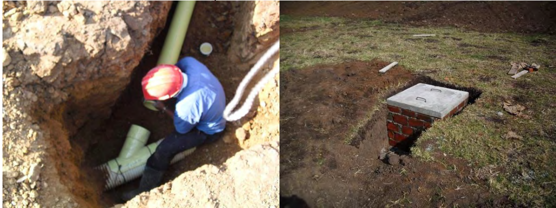
Figura 19 Empalme de instalación domiciliaria a colector / Caja de inspección terminada
