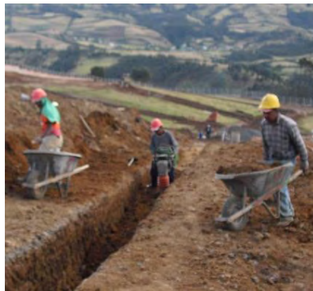
Figura 18 Relleno con material del sitio compactado con saltarín entre cámaras S2 – S3
