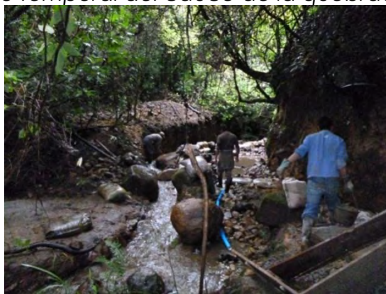
Figura 34 Desvió temporal del cauce de la quebrada Chachatoy
