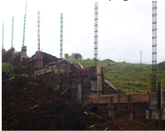
Figura 8 Fundición columnas y vigas de corona
