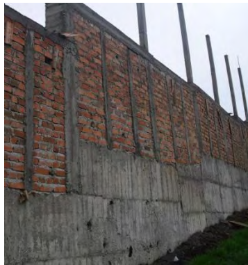
Figura 11 Muro de contención – Costado norte
