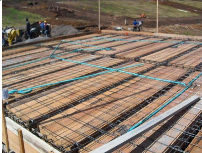
Figura 64 Instalación ductería eléctrica por losa
