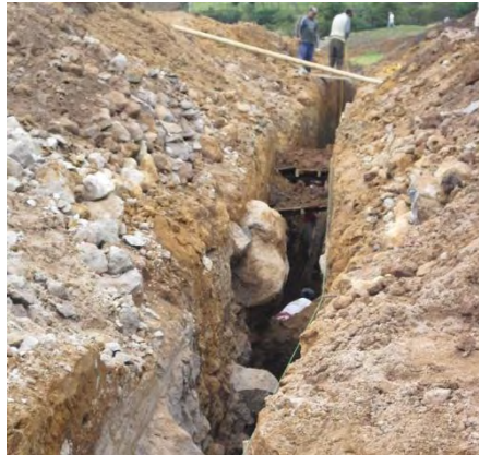
Figura 15 Excavación en Roca entre cámaras PL12 – PL17
