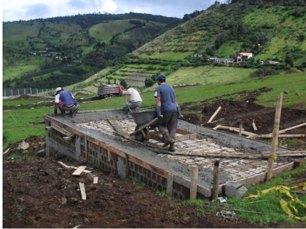
Figura 55 Fundición de tapa de estructura para tanque estacionario de gas
