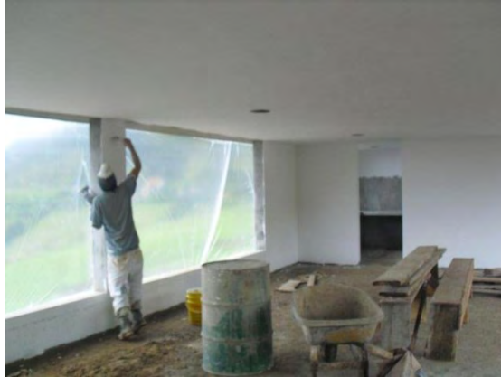
Figura 68 Estuco sobre muros interiores
