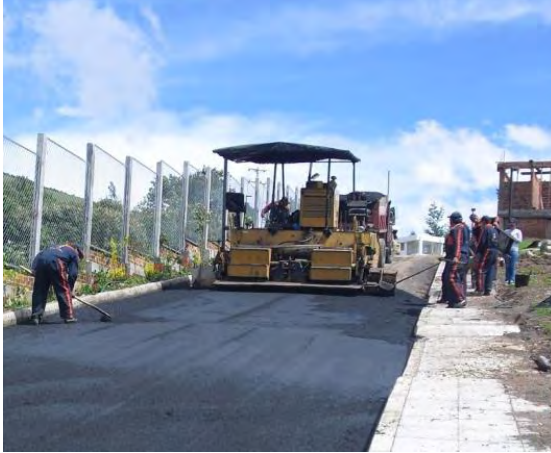
Figura 49 Extensión de mezcla asfáltica con finisher
