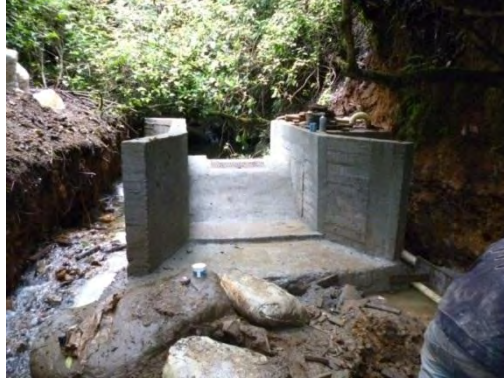
Figura 38 Vista general bocatoma terminada
