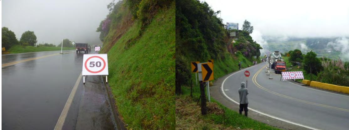
Figura 32 Señalización vial durante el descargue de concreto premezclado
