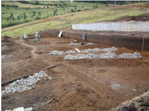
Figura 71 Construcción filtros en espina de pescado
