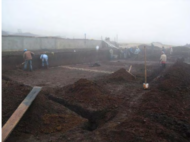
Figura 70 Excavación en cancha blanda para construcción filtros
