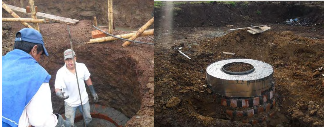
Figura 17 Construcción cámara de inspección S4A/ Fundición tapa de cámara de inspección S1A
