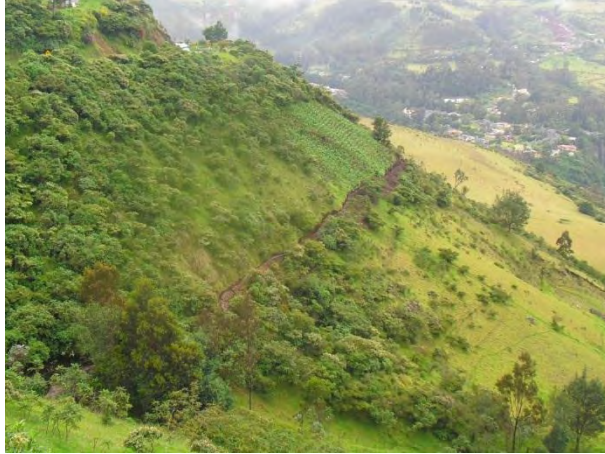
Figura 26 Vista tramo 1 – 2 – 3 de línea de conducción
