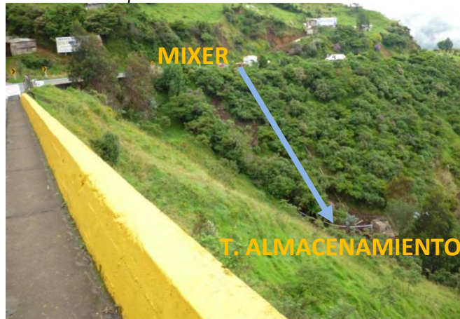
Figura 31 Trayectoria de suministro de concreto premezclado para tanque de almacenamiento
