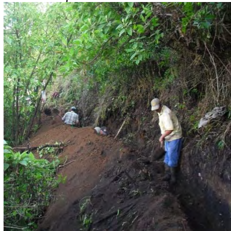
Figura 27 Excavación para tramo 4 de línea de aducción
