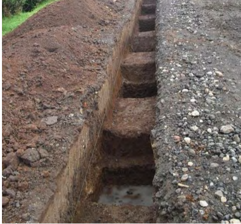
Figura 6 Excavación manual para cerramiento – Costado oriental
