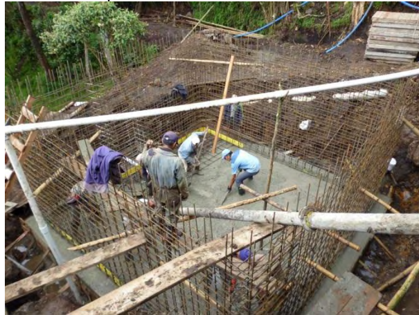
Figura 29 Fundición con concreto premezclado de placa de piso de tanque de almacenamiento
