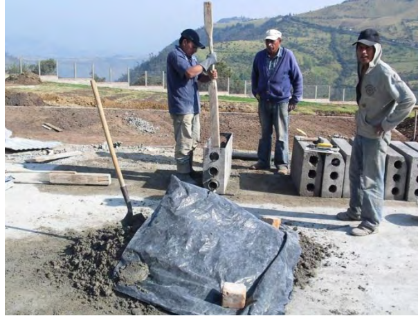
Figura 52 Elaboración de sardineles prefabricados
