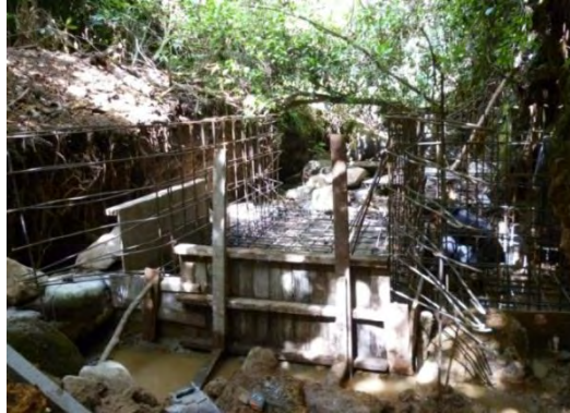
Figura 37 Colocación y amarre de acero de refuerzo en bocatoma
