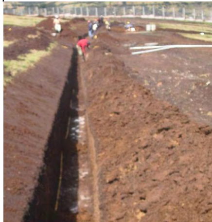
Figura 23 Zanja para la instalación de tubería de acueducto
