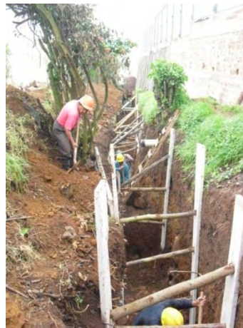
Figura 13 Entibado entre cámaras S16 – S17
