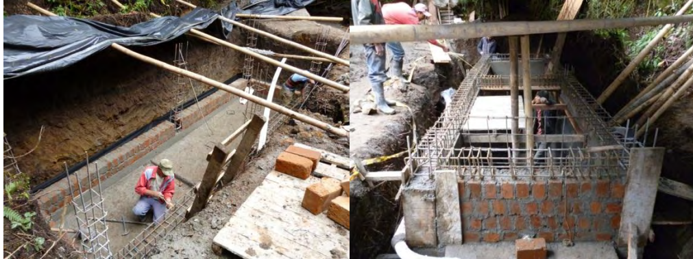
Figura 41 Construcción del desarenador
