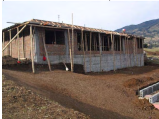
Figura 62 Apuntalamiento volados para fundición de losa
