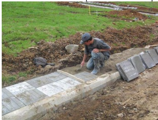
Figura 53 Instalación de losetas prefabricadas para andenes
