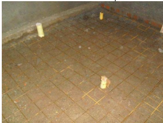
Figura 67 Instalacion malla electrosoldada para fundicion de contrapiso
