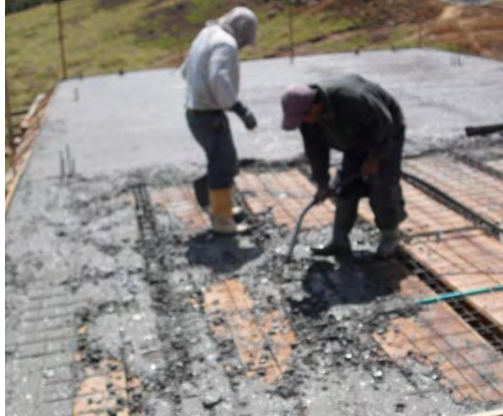
Figura 61 Vibrado de concreto en vigas aéreas de losa
