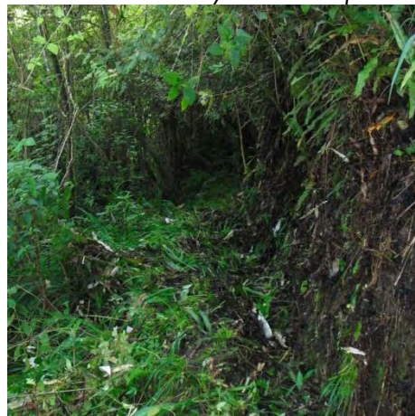
Figura 25 Desmonte de arbustos y maleza previo a la excavación
