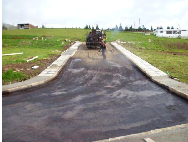
Figura 48 Imprimación- Acceso a BH8
