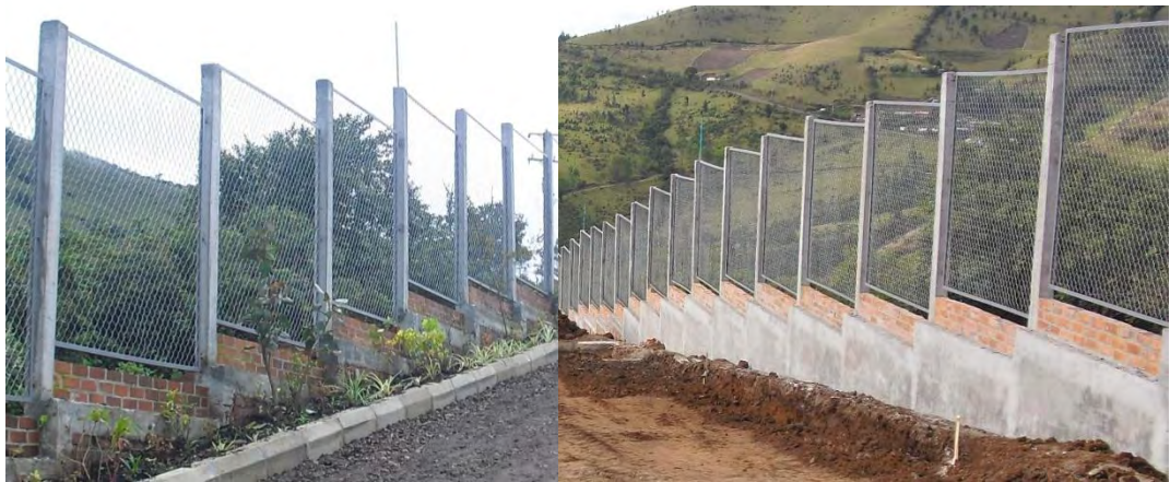
Figura 9. Muro de cerramiento tipo terminado
