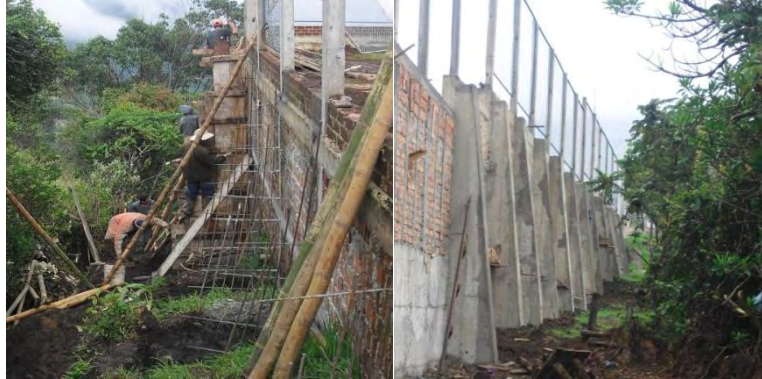
Figura 10 Construcción contrafuertes– Costado norte y sur
