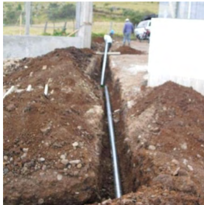
Figura 58 Instalación tubería IMT en cruce con vía principal
