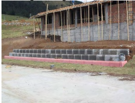
Figura72 Vista general graderías cancha múltiple
