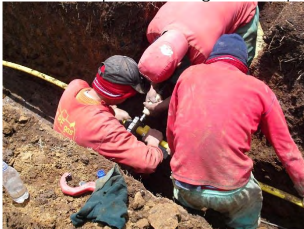
Figura 56 Instalación accesorio para red de gas con equipo de termofusión
