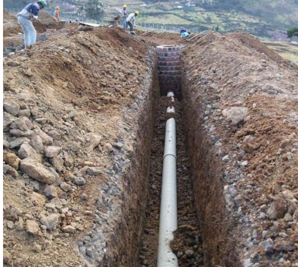
Figura 16 Instalación tubería PVC estructurada entre cámaras PL13 – PL14
