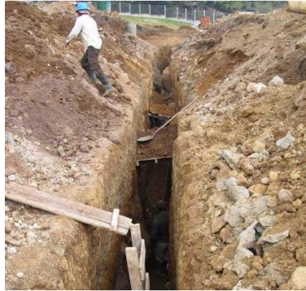
Figura 14 Excavación en conglomerado entre cámaras S12 – S7
