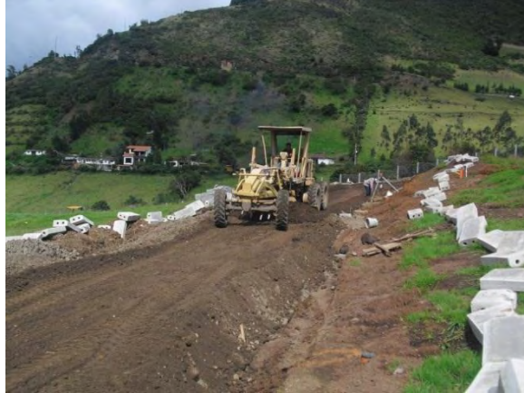
Figura 45 Extensión de material de subbase con motoniveladora
