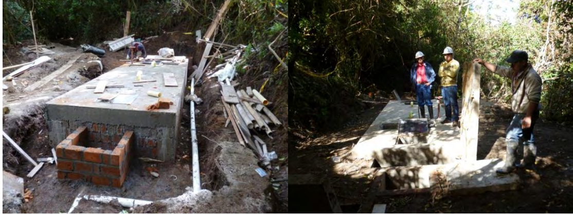
Figura 42 Vista general desarenador terminado
