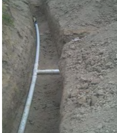
Figura 24 Instalación tubería PVC UP y accesorios de la red matriz
