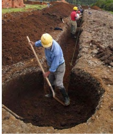
Figura 12 Excavación en material común entre cámaras S1 – S2
