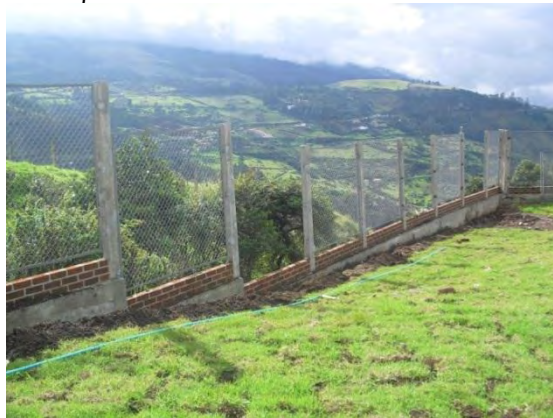
Figura 60 Tendida de tubería ¾" para el alumbrado del perímetro del condominio
