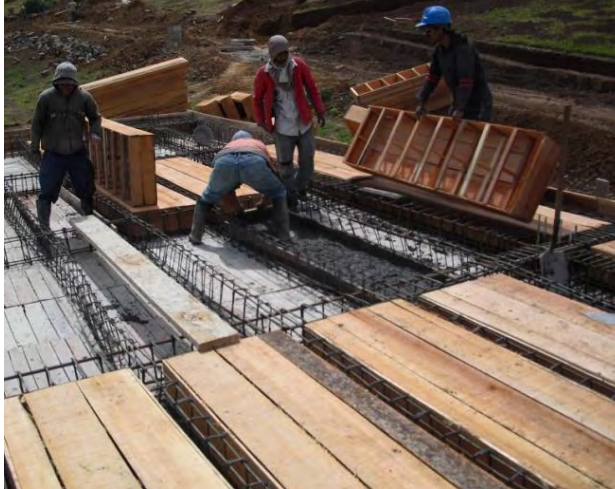
Figura 63 Fundición loseta inferior e instalación de casetones en tablilla
