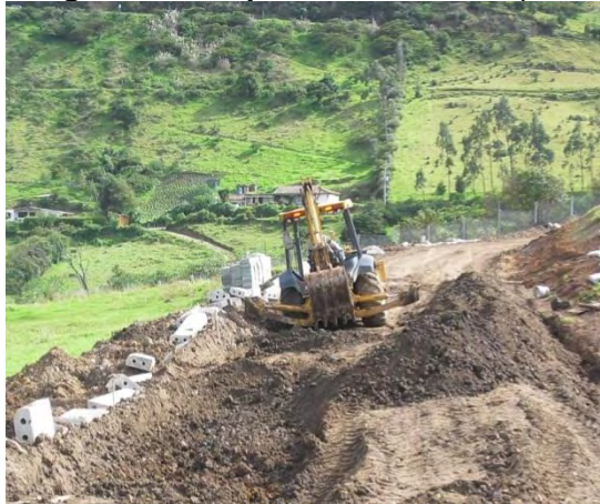
Figura 44 Cajeo en Vía Principal
