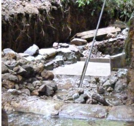
Figura 36 Mejoramiento de piso en concreto ciclópeo en Bocatoma
