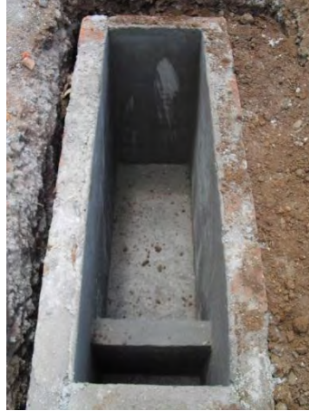
Figura 20 Sumidero construido (sin tapa y rejilla)
