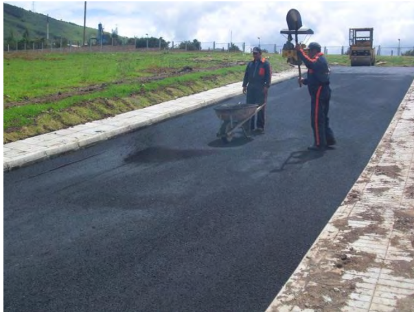
Figura 50 Tendido manual de mezcla asfáltica fina – Acceso BH4
