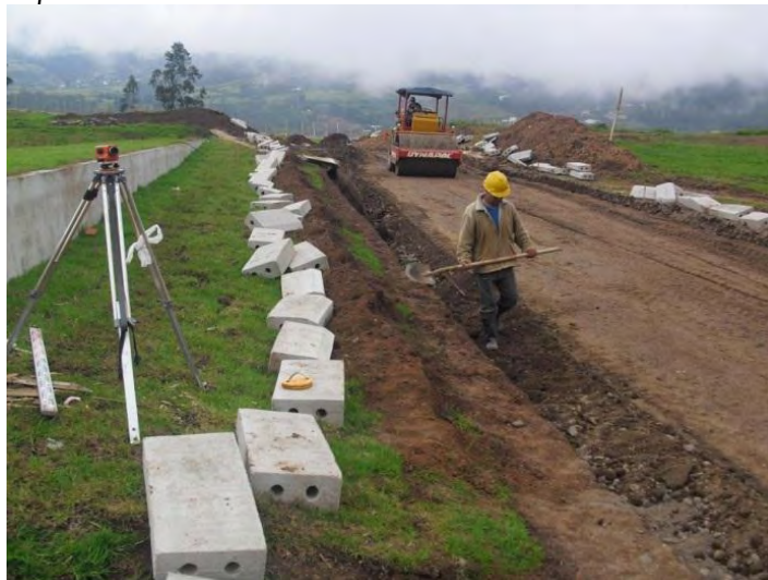
Figura 47 Compactación del material de base con vibrocompactador
