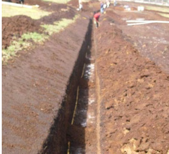
Figura 57 Instalación de tubería de polietileno para sistema de gas – Ramal 1
