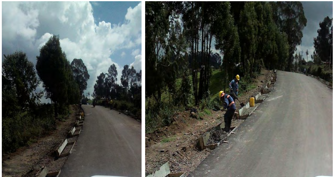
Figura 45. Construcción y terminado de cunetas.
