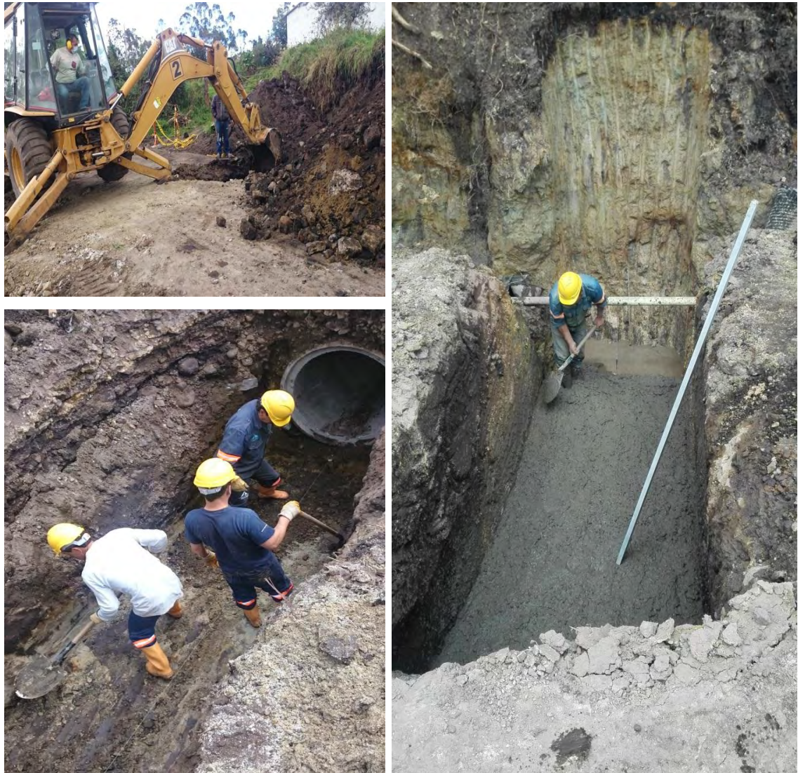
Figura 29. Excavación, nivelación y solado para tubería de 36".
