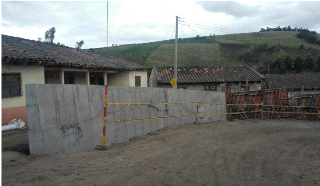
Figura 36. Muro de contención fundido el primer módulo.
