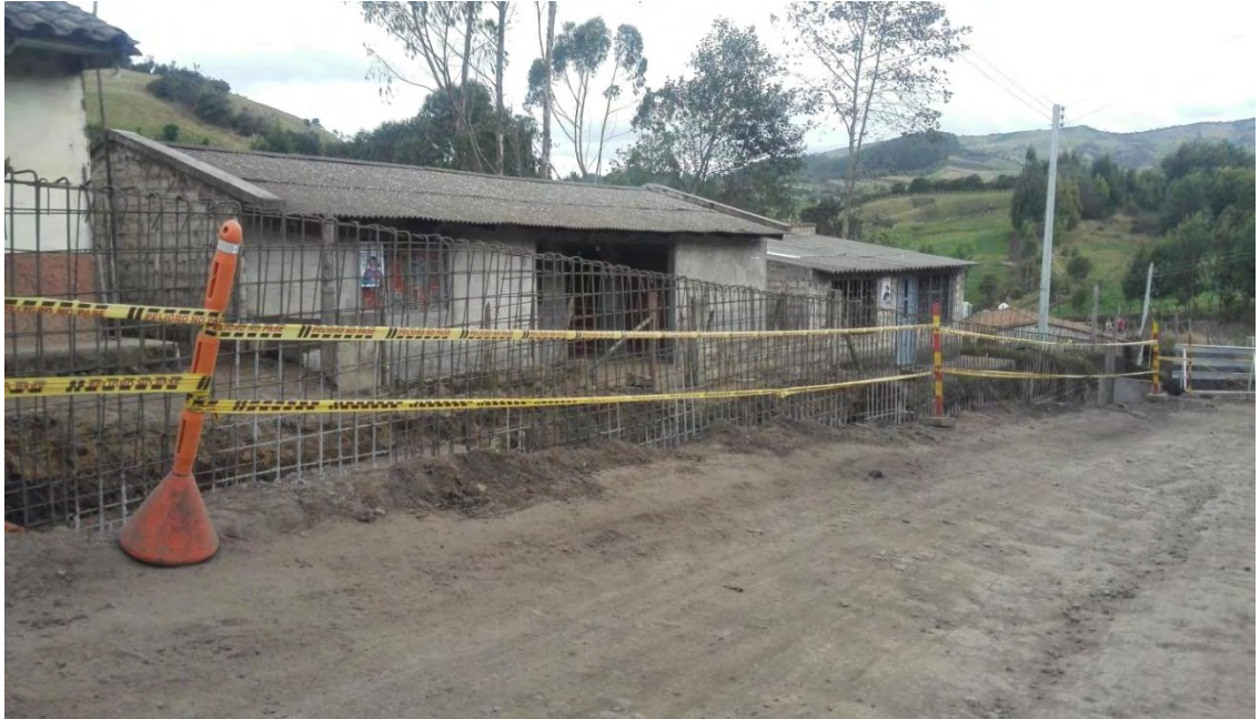
Figura 38. Muro de contención con módulo 3 armado el acero de refuerzo.
