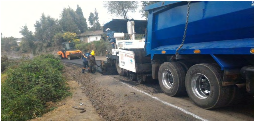
Figura 42. Instalación de primera capa de mezcla asfáltica MDC-19
