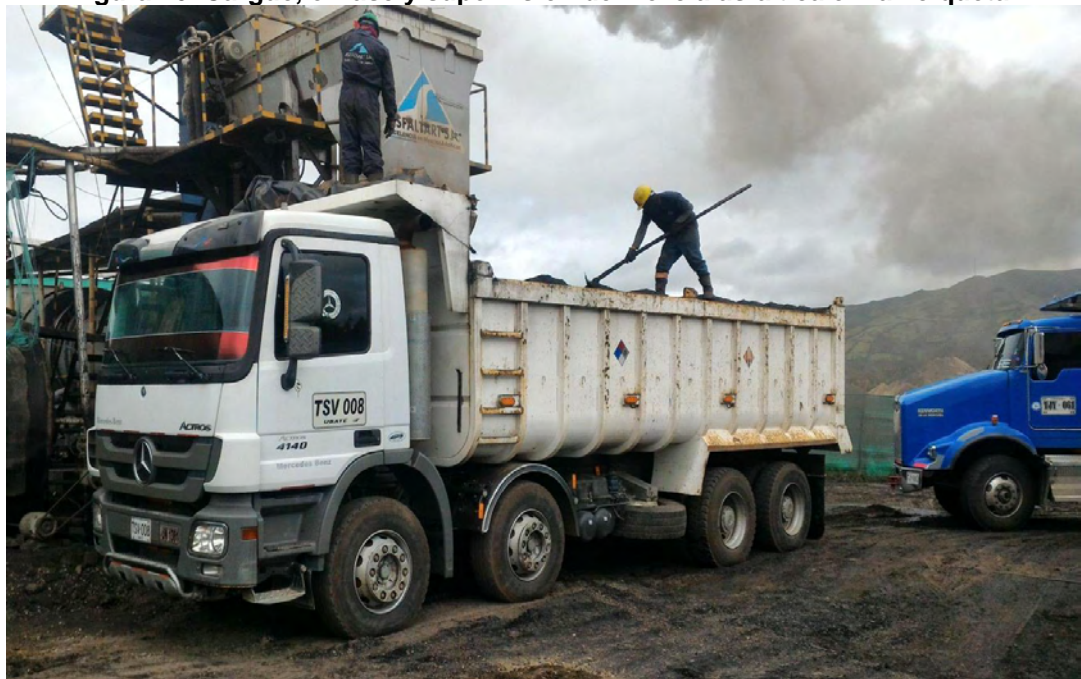
Figura 26. Cargue, enrase y supervisión de mezcla asfáltica en la volqueta.
