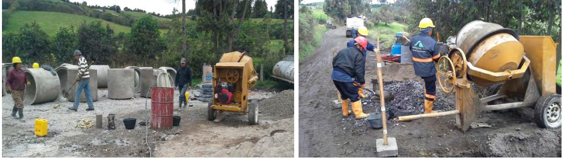
Figura 10. Producción de concreto en obra para tubería de 36", solados y atraques de alcantarillas.
