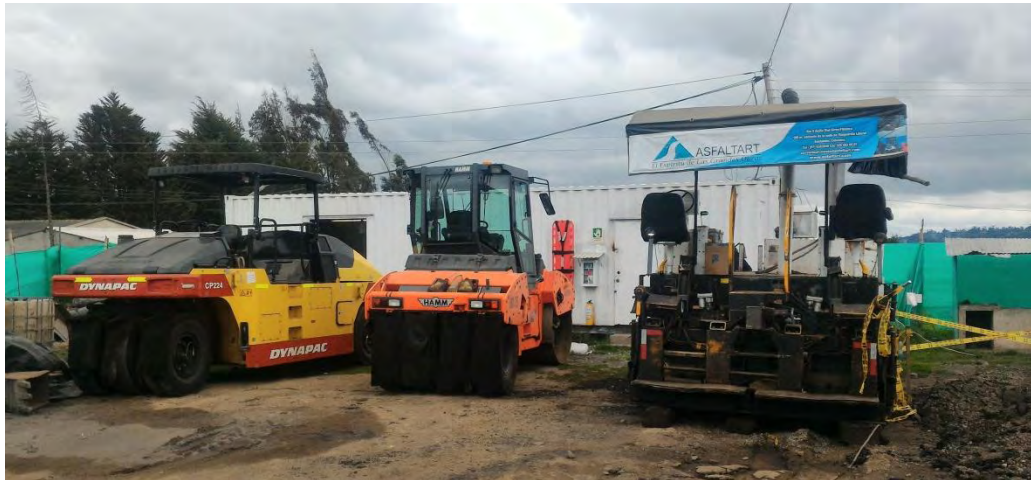
Figura 41. Equipo para instalación de mezcla asfáltica.
