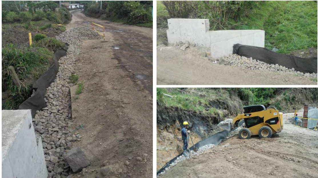
Figura 28. Filtro geodren vial instalado.
