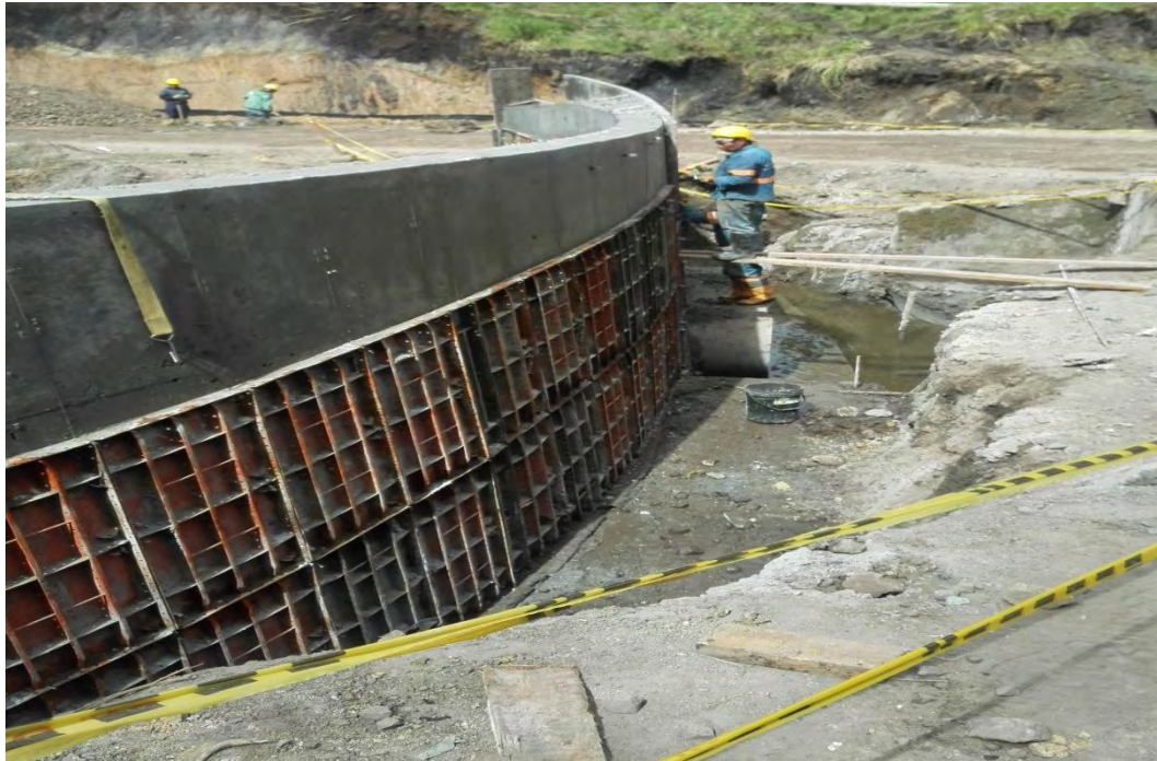
Figura 39. Muro de contención terminado y retirando formaleta.
