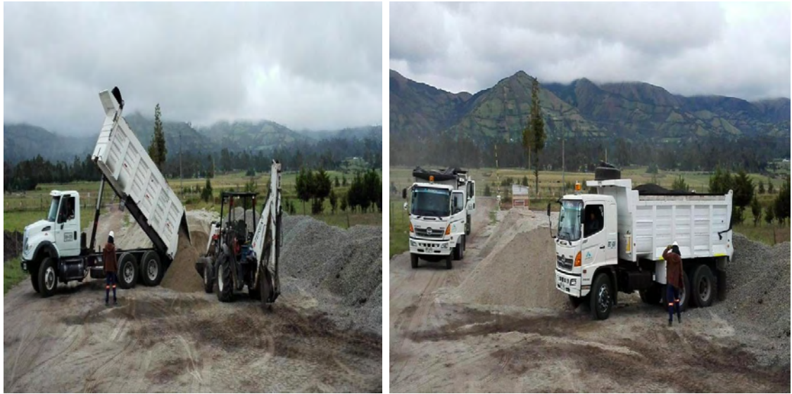
Figura 3. Recepción y acopio de materiales para concreto (arena y triturado).
