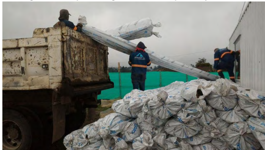
Figura 7. Recepción de geomalla biaxial para mejoramiento.
