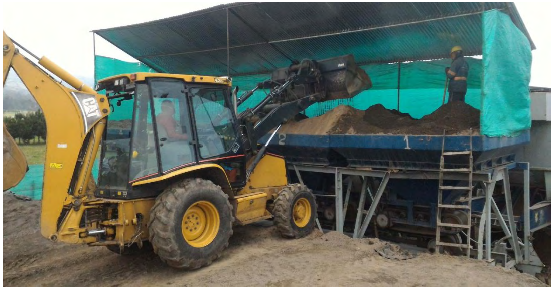
Figura 23. Cargue de materiales a las tolvas.
