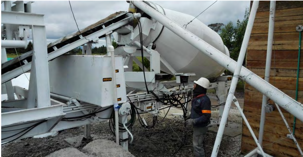
Figura 12. Planta de concreto móvil artesanal.
