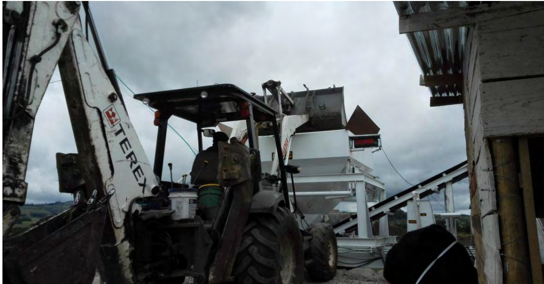
Figura 13. Cargue de materiales con retrocargador a la tolva.
