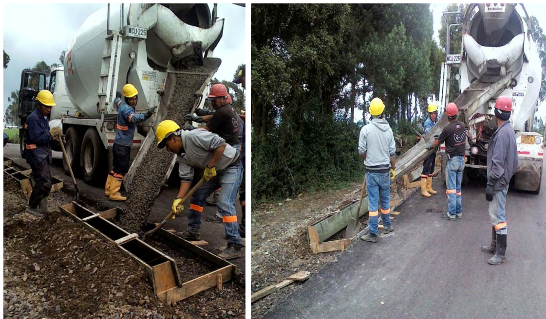
Figura 46. Vaciado del concreto a las cunetas.
