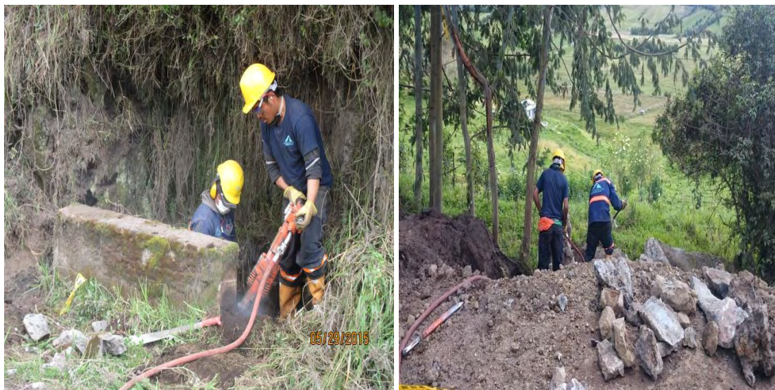
Figura 33. Demolición de estructuras existentes.
