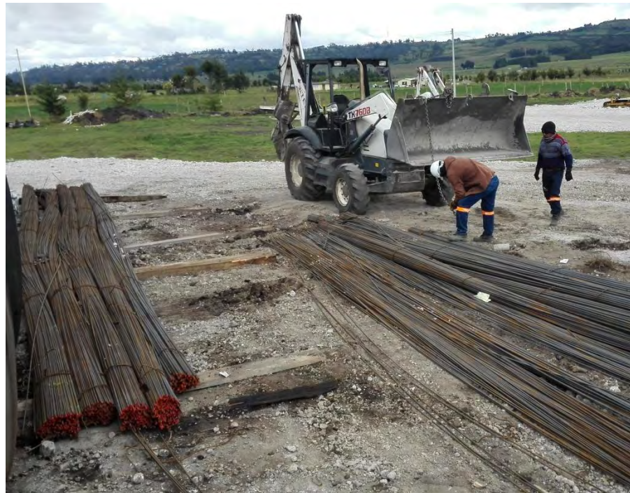
Figura 4. Recepción y acopio de acero de refuerzo.
