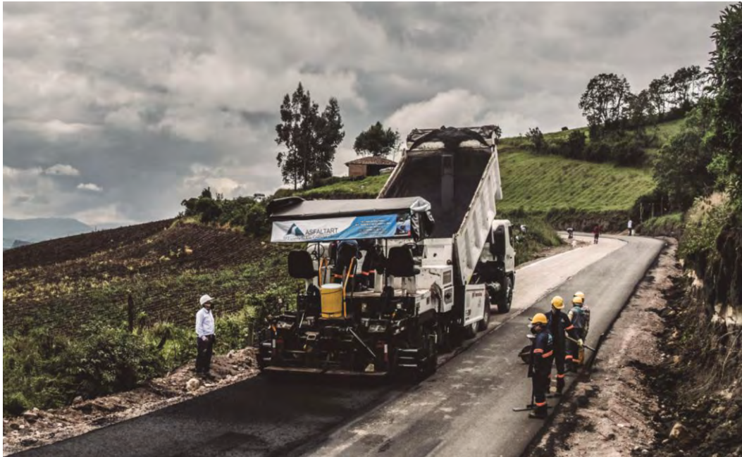
Figura 43. Instalación de mezcla asfáltica para segunda capa.
