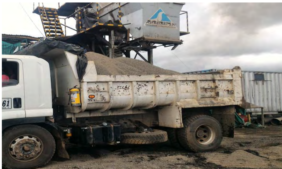
Figura 20. Procedimiento para secar el material antes de producir mezcla asfáltica.
