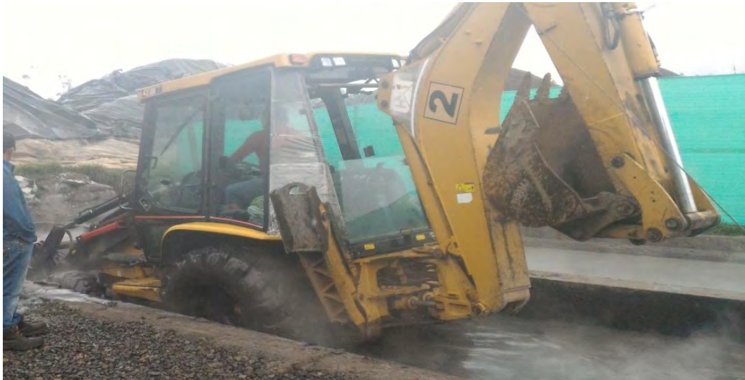
Figura 27. Limpieza de la piscina de lodos.
