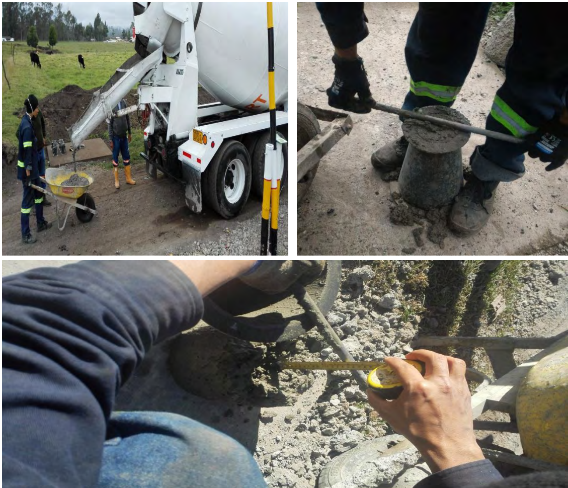
Figura 17. Toma Slump para medir asentamiento del concreto.
