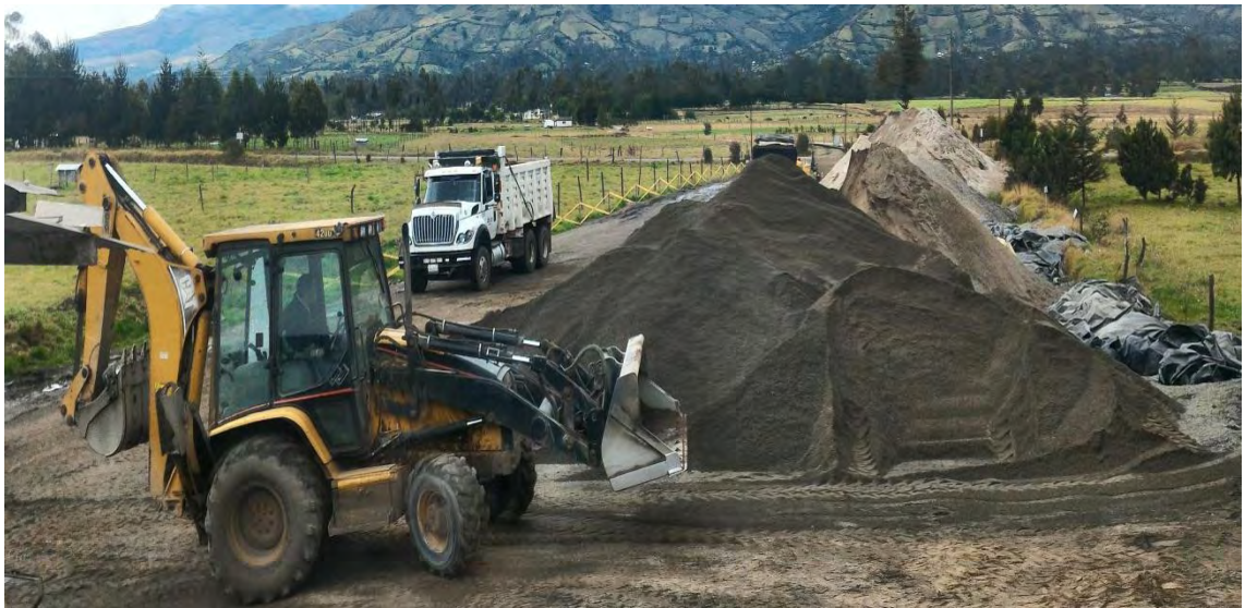
Figura 22. Acopio de materiales para mezcla asfáltica.
