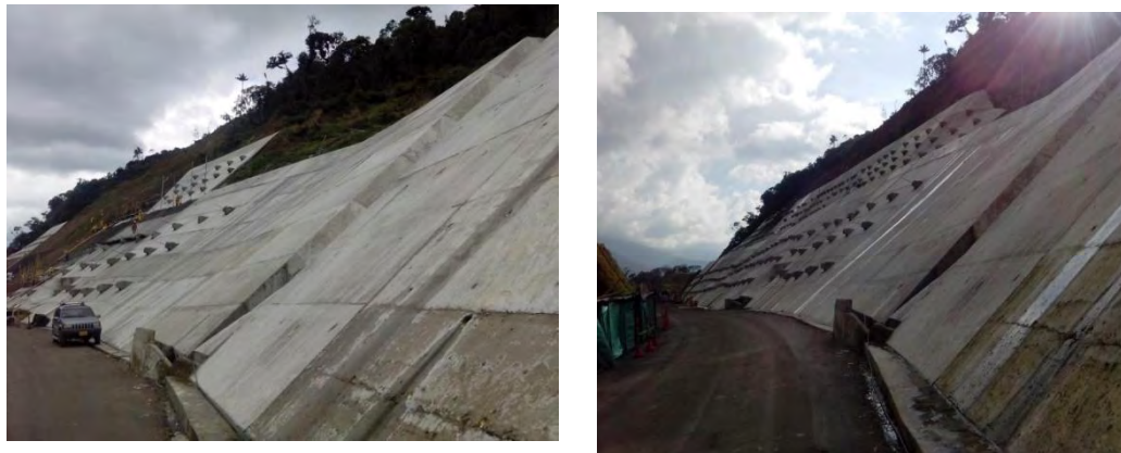
Figura 13. Acabados y limpieza de obra.
