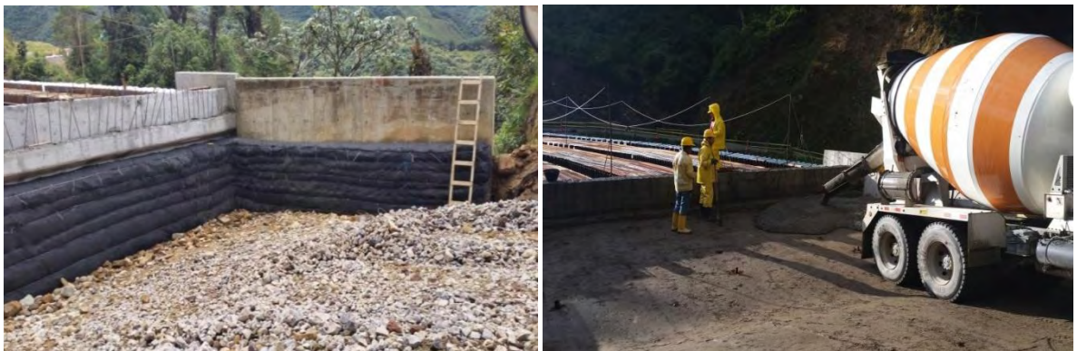
Figura 15. Filtro terminado e inicio construcción placas de aproximación.
