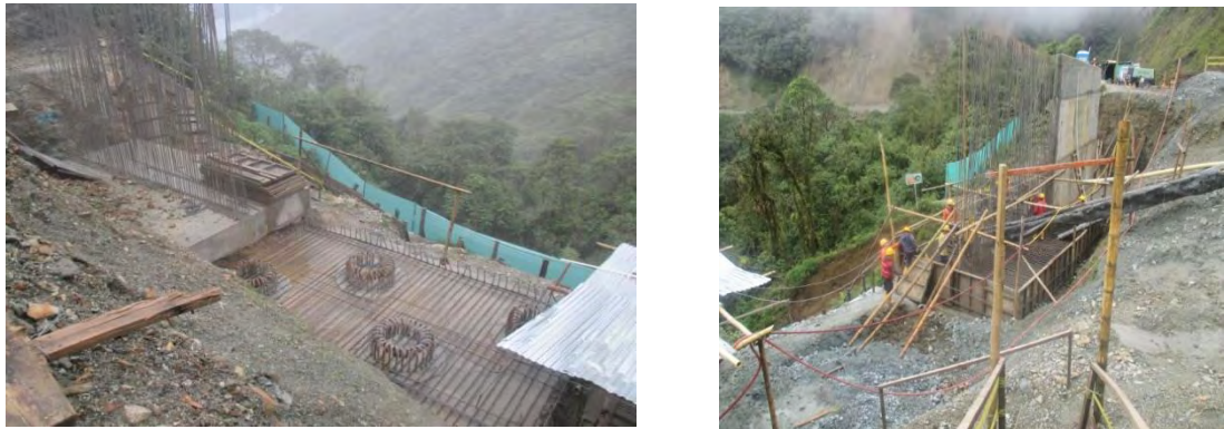
Figura 5. Refuerzo y encofre del muro por módulos.
