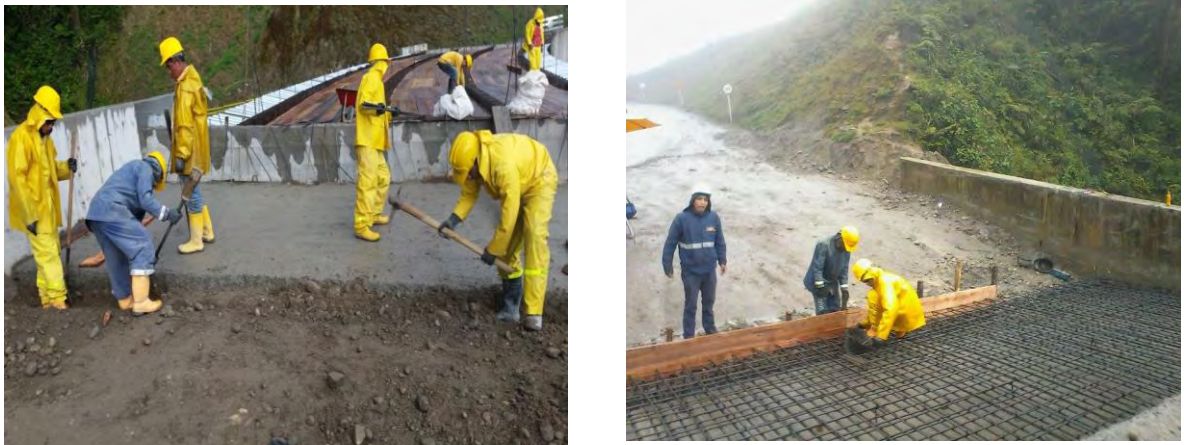
Figura 16. Ubicación y amarre del refuerzo placas de aproximación y encofre.
