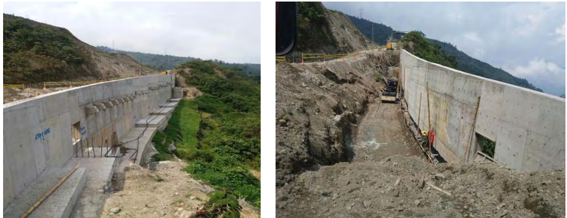
Figura 7. Construcción muros de cierre y filtro.
