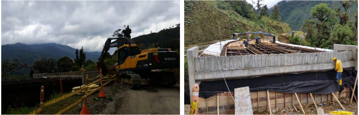
Figura 14. Excavación e inicio construcción filtro y encofre placa vehicular.
