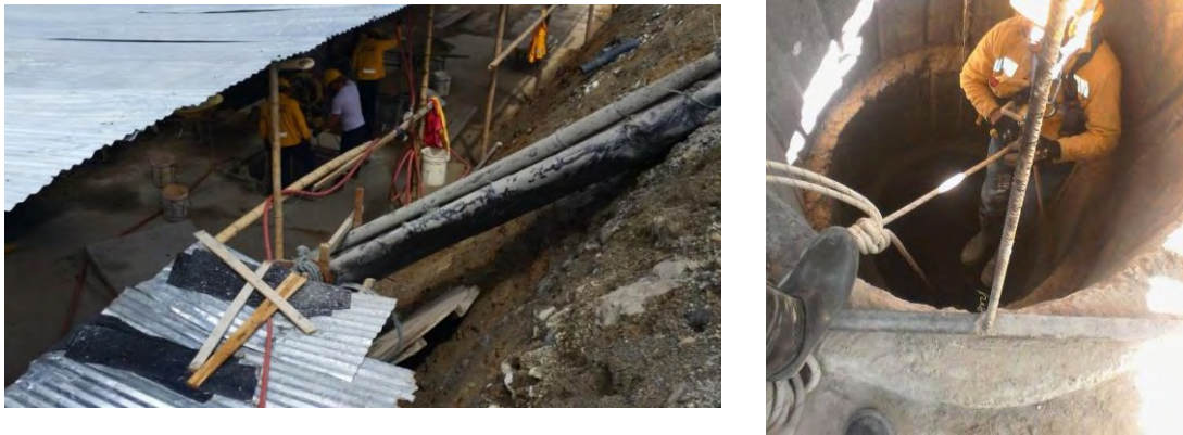
Figura 2. Excavación y fundición anillos caisson
