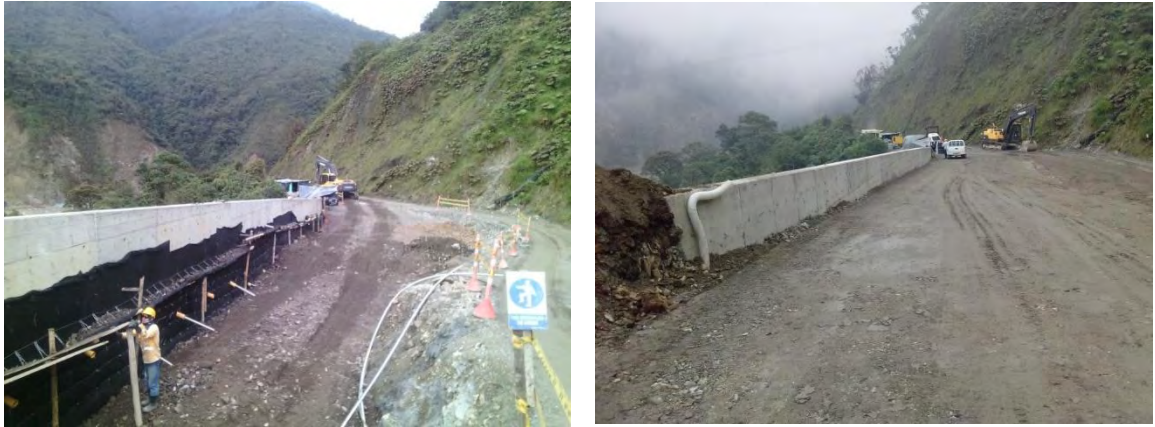
Figura 8. Construcción filtro, lleno y compactación.
