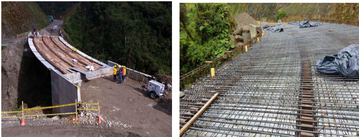
Figura 17. Disposición del acero de refuerzo sobre la placa vehicular del puente 4.
