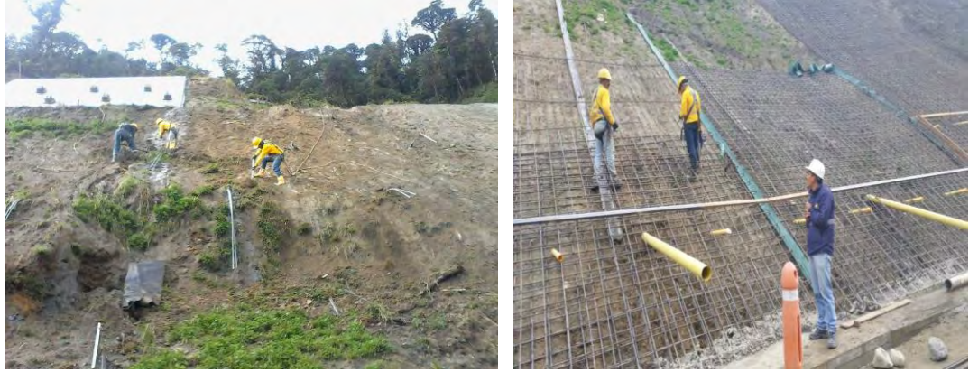
Figura 9. Perfilado del talud y ubicación y amarre del refuerzo.
