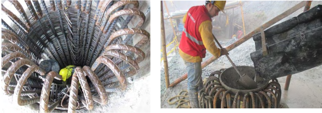
Figura 4. Amarre y fundición cuerpo caisson.
