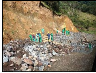
Figura 46. Gaviones SDM PR3+699 – PR3+737.
