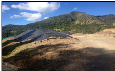
Figura 1. Acopio de arena y de grava situadas en el stock de materia les de la obra K2+250 del Trayecto 6-1.
