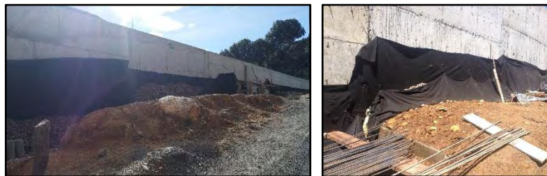
Figura 43. Filtro en espaldar de muro de contención PR5+895 – PR6+120.
