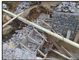
Figura 47. Gaviones encoleta a Box – Couvert PR0+740.
