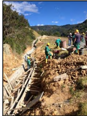
Figura 18. Canal enrocado SDM PR14+300.
