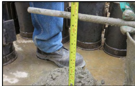
Figura 15. Toma de asentamiento con cono de abrams durante vaciado de concreto en las obras realizadas del trayecto 5A.
