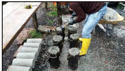
Figura 35. Toma de cilindros de concreto para ensayo de resistencia a la compresión en las obras del trayecto 3
