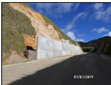
Figura 27. Cunetas iniciales y finales PR0+429 – PR0+470.
