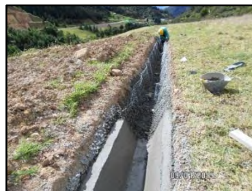
Figura 19. Zanja de coronación SDM PR14+300.
