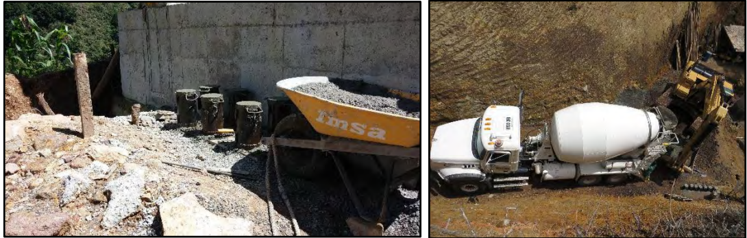
Figura 29. Toma de cilindros de concreto para ensayo de resistencia a la compresión en las obras del trayecto 6-1.
