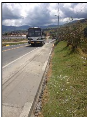
Figura 33. Cunetas margen derecha PR80+276 – PR81+360 y margen izquierda iniciales PR71+045 – PR71+341.
