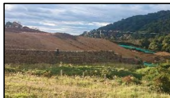
Figura 45. Gaviones SDM PR0+200.
