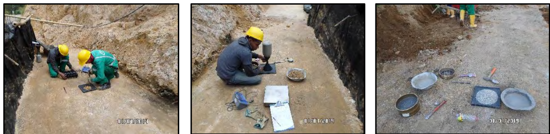
Figura 49. Toma de densidades método de cono y arena en capas granulares del Trayecto 6-1.
