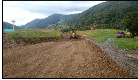
Figura 40. Material seleccionado para subrasante PR3+270 – PR3+500.
