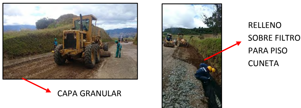
Figura 37. Capa granular de subbase y relleno sobre filtro para piso cuneta.
