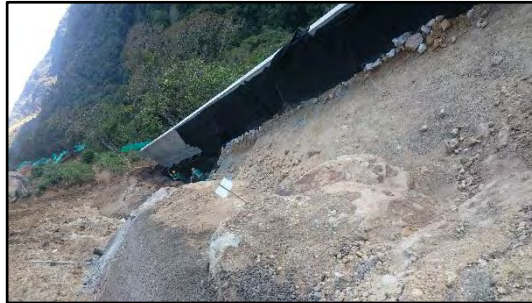
Figura 42. Relleno en espaldar de muro de contención PR5+895 – PR6+120.
