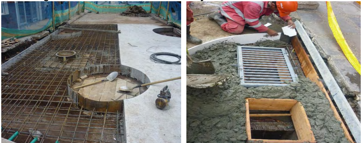
Fotografía 31. Instalación de refuerzo y construcción de sumideros.
