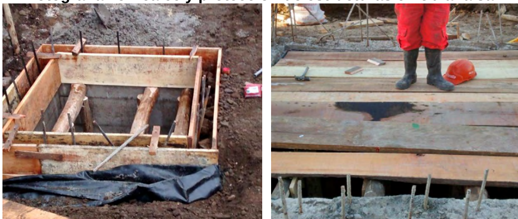
Fotografía 25. Realce y protección de estructuras en obra falsa.
