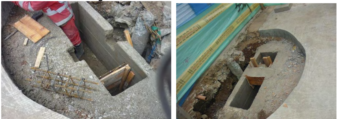
Fotografía 26. Construcción de sumideros.
