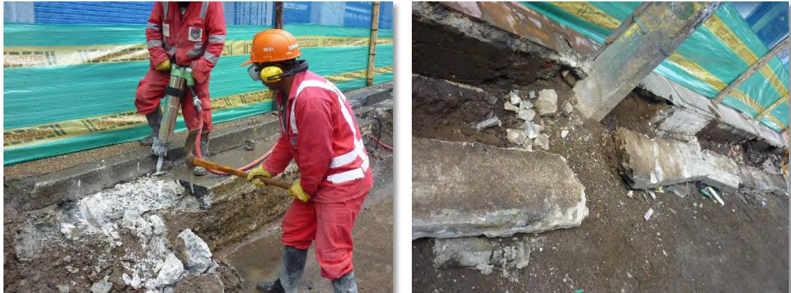
Fotografía 5. Demolición de sardineles.
