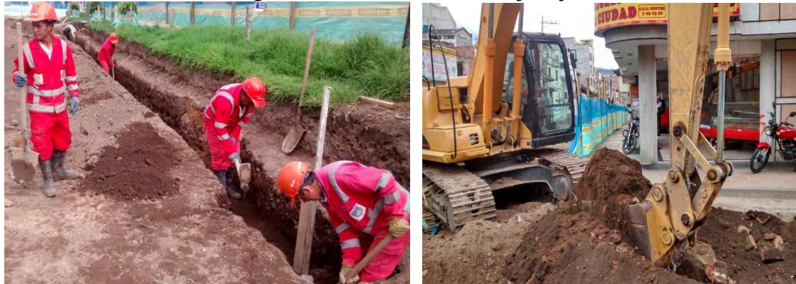
Fotografía 12. Excavaciones y cajeo.
