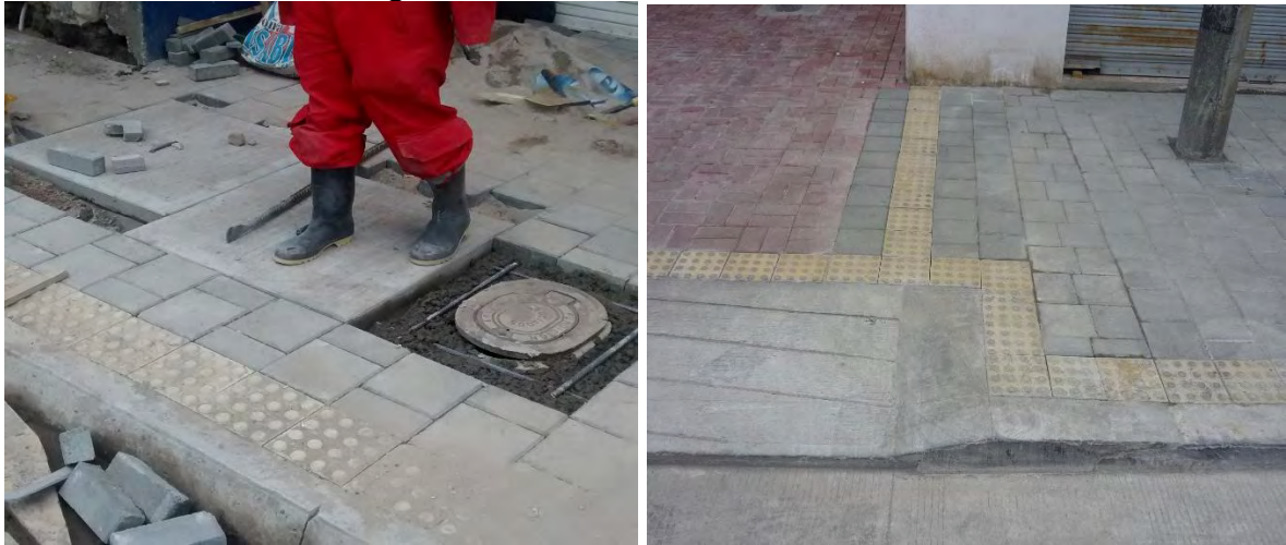
Fotografía 36. Construcción de andenes.
