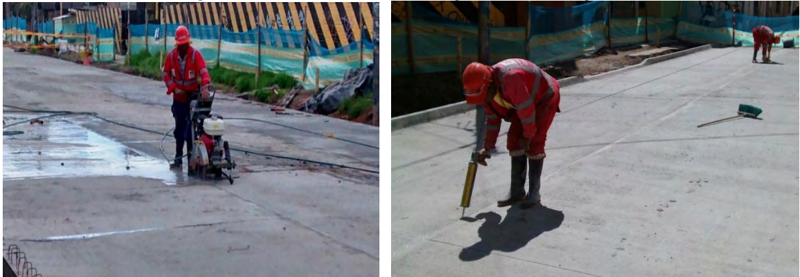
Fotografía 32. Corte de losas y sellado de juntas.
