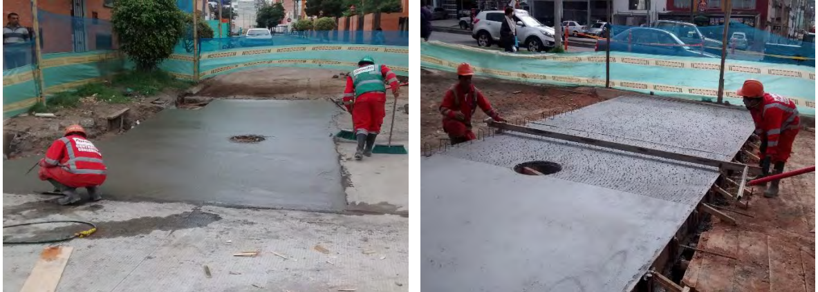
Fotografía 30. Acabado llana metálica y con rastrillo.
