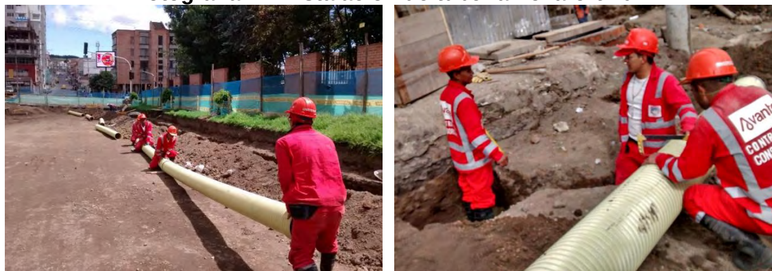
Fotografía 17. Instalación de tubería novafort 10”.
