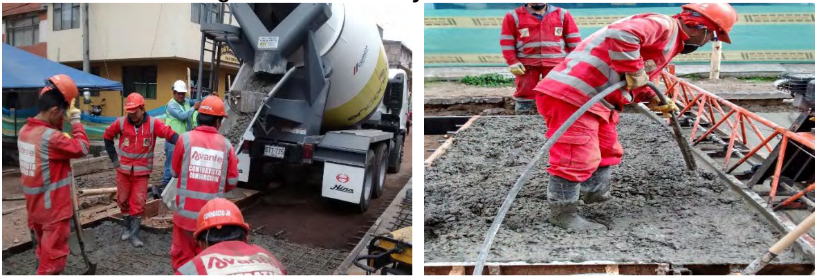
Fotografía 28. Vaciado y vibrado de concreto.
