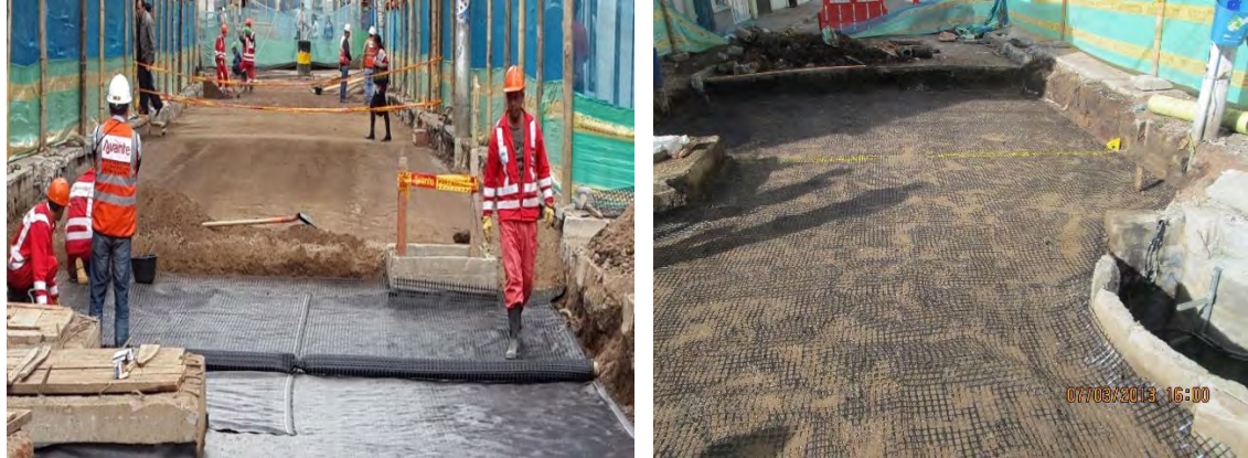
Fotografía 21. Instalación de geomalla biaxial.
