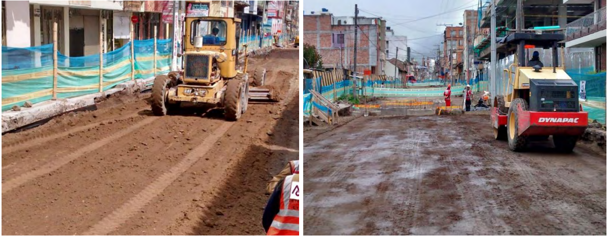
Fotografía 23. Instalación y compactación sub-base granular.
