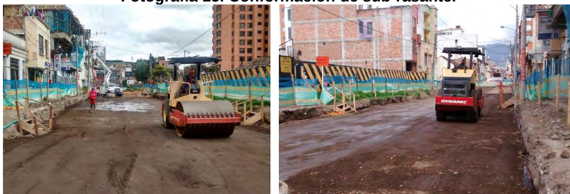
Fotografía 15. Conformación de sub-rasante.
