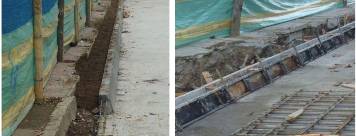
Fotografía 33. Construcción de sardineles.
