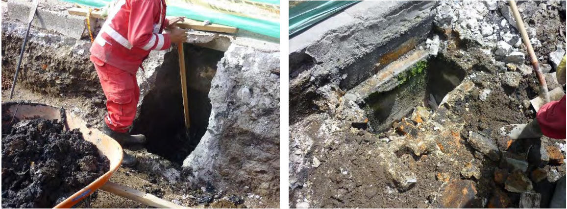
Fotografía 7. Demolición de sumideros existentes.
