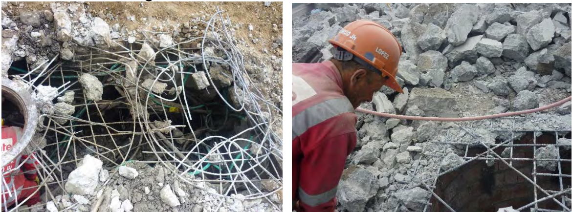
Fotografía 8. Demolición de cámaras existentes.
