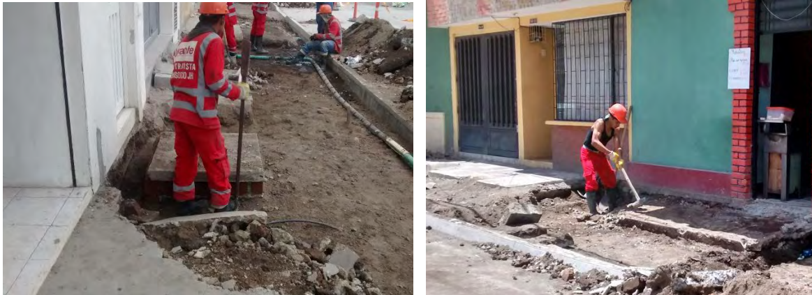
Fotografía 9. Demolición de andenes
