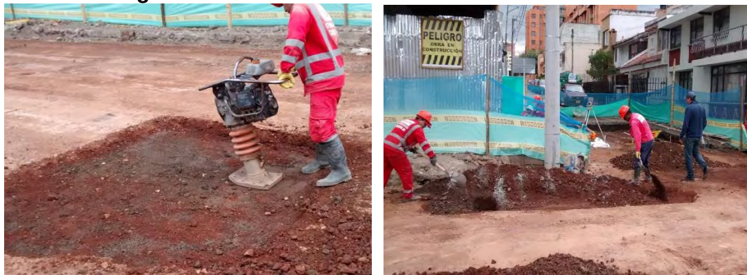
Fotografía 20. Recebo estabilizado con suelo cemento.
