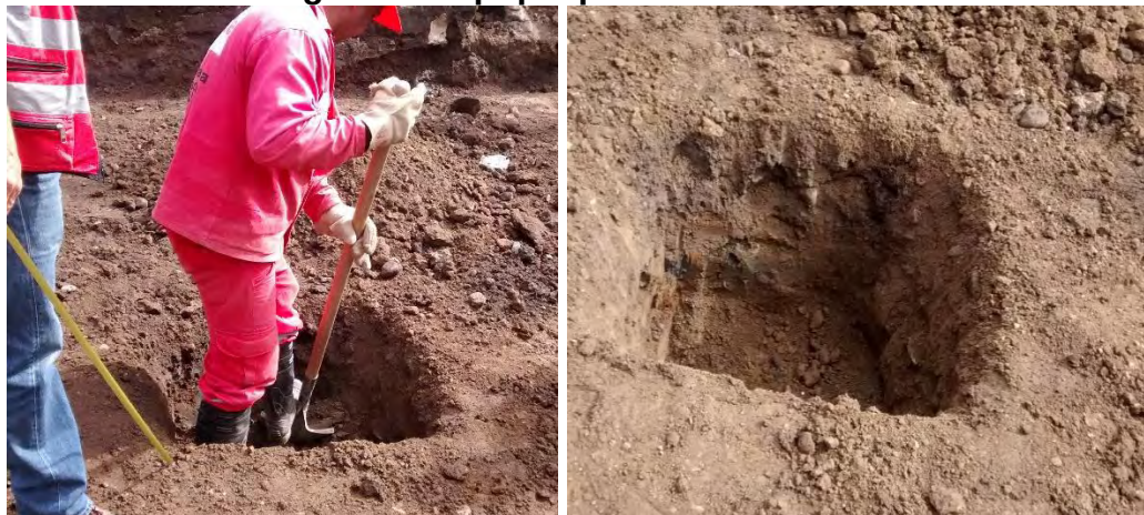
Fotografía 1. Apique para muestra de CBR.
