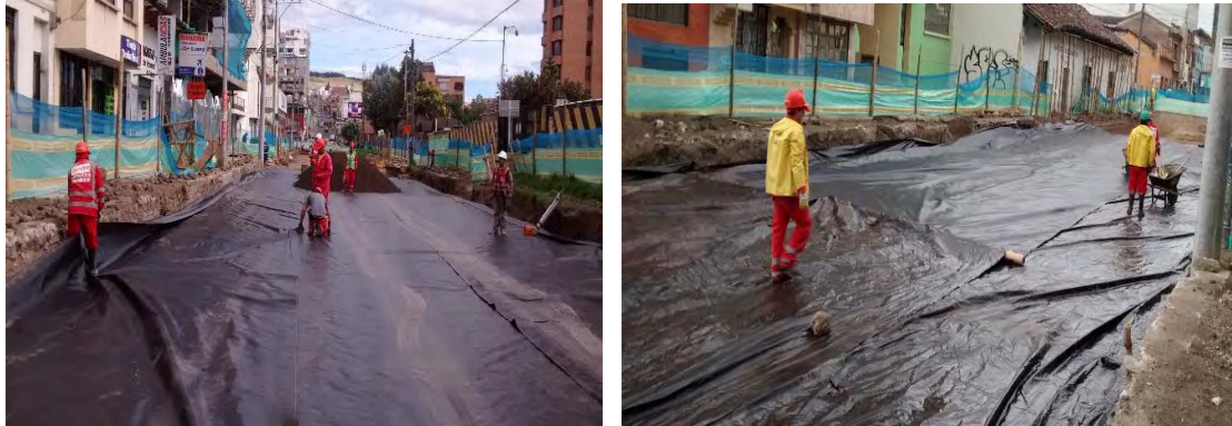
Fotografía 18. Instalación de geotextil T-2400.
