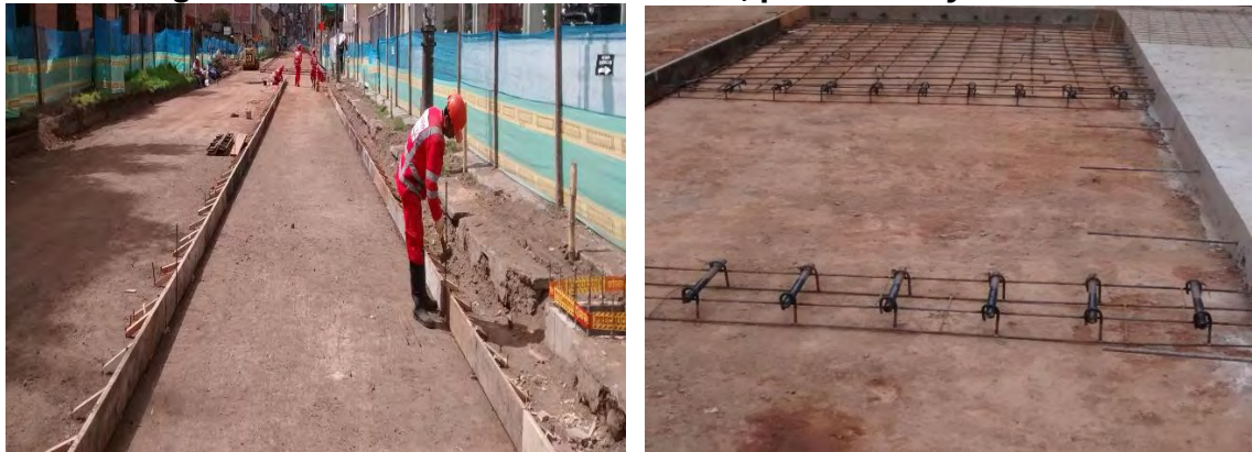
Fotografía 27. Instalación de formaleta, pasadores y canastillas.
