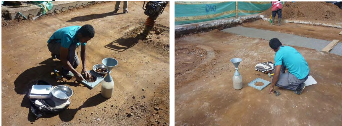
Fotografía 37. Toma de densidades - método del cono y arena.
