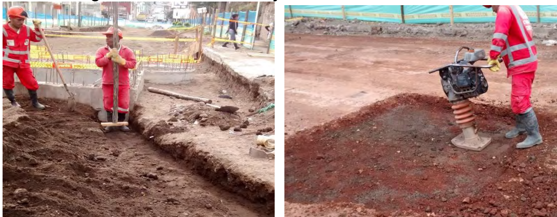
Fotografía 19. Rellenos - mejoramientos de sub – rasante.
