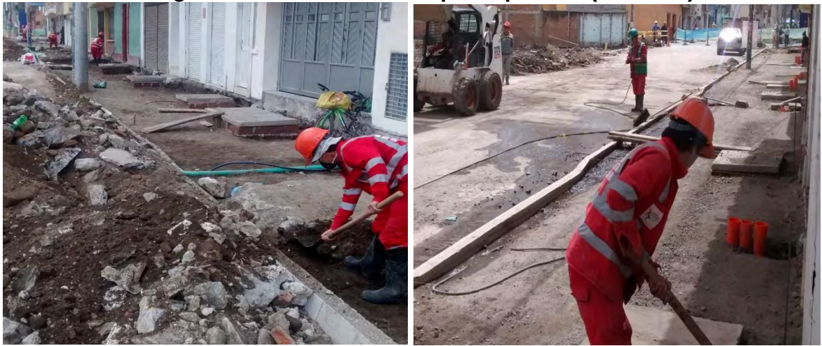
Fotografía 34. Intervención espacio público (andenes).
