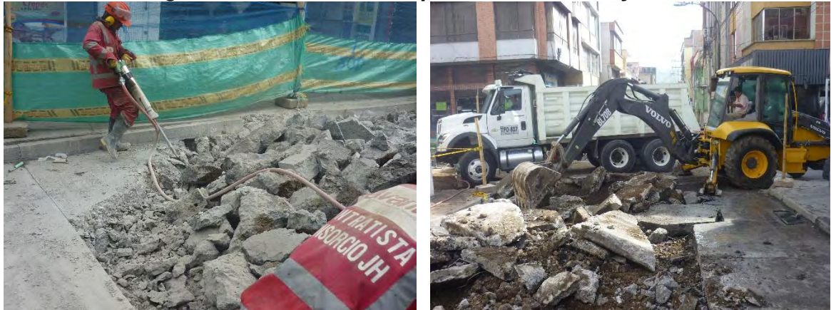
Fotografía 6. Demolición de placa de concreto y asfalto.
