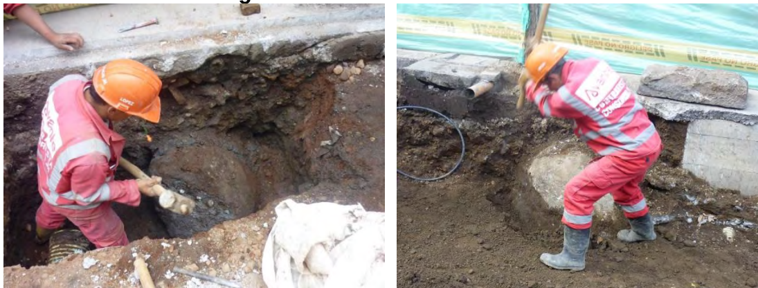
Fotografía 10. Demoliciones en roca.
