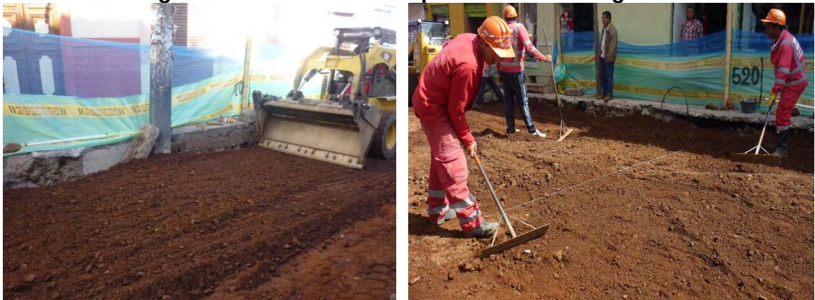
Fotografía 22. Instalación carpeta de sub-base granular.
