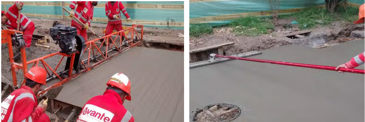
Fotografía 29. Acabado con regla vibratoria y flotador.
