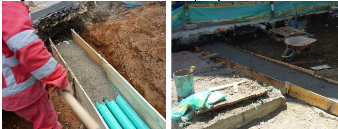
Fotografía 24. Construcción de cárcamos para protección de redes secas.
