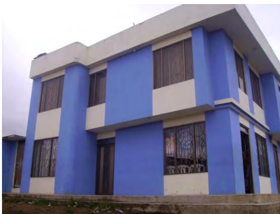
Fotografía 24. Casa con plancha dos pisos, construida con ladrillo
