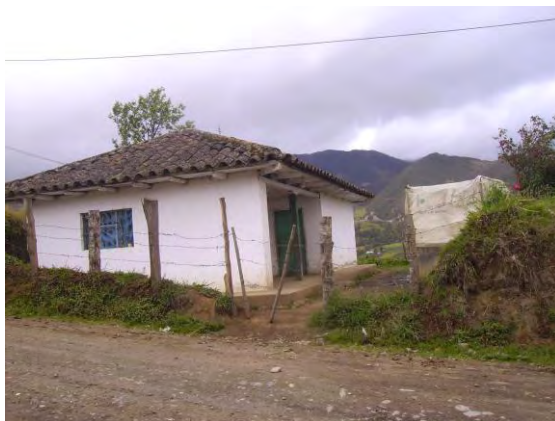
Fotografía 23. Casa construida en tapia y teja de barro.
