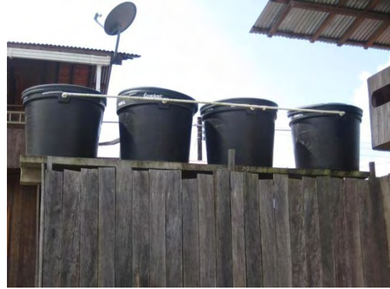
b. Almacenamiento de la casa aguatera
