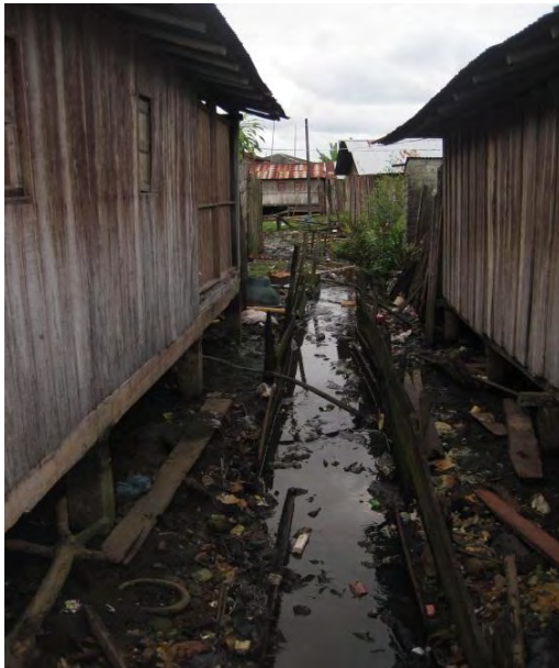
b. Contención con elementos improvisados
