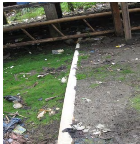
b. Tubería bajo casa vecina
