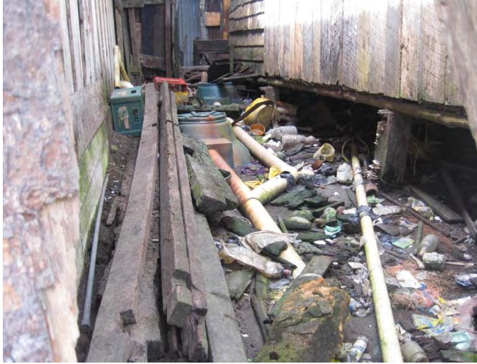
a. Tuberías a cielo abierto
