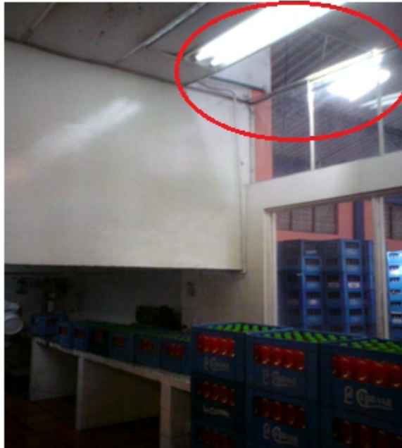
Imagen 12. Techos Producción de Agua
