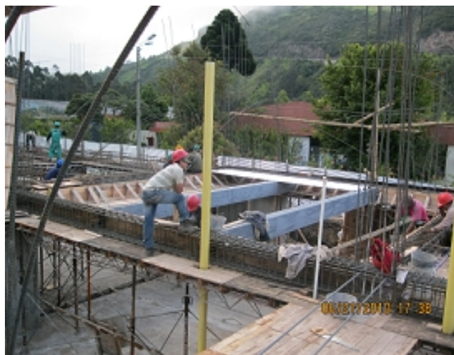
Fotografía No. 46. Instalación de perfiles - nivel N+3.00 zona entro.
