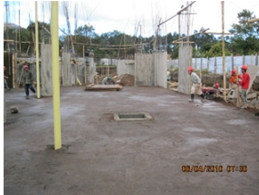
Fotografía No. 40. Instalación de polysec y malla electrosoldada - zona centro.
