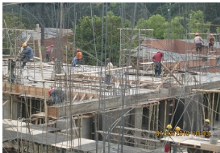
Fotografía No. 65. Armado de refuerzo de columnas y pantallas - nivel N+9.00 zona centro.
