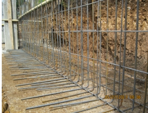
Fotografía No. 73. Armado refuerzo muro de contención – eje 5 zona norte.
