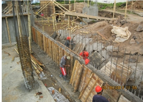
Fotografía No. 81. Muro de contención fundido hasta media altura, icopor colocado en la dilatación entre pantalla y muro de contención – eje 5 zona norte.
