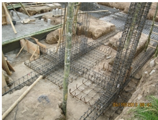
Fotografía No. 24. Refuerzo de vigas de cimentación ejes 3 y 3' - zona centro.
