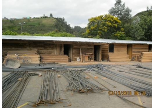
Fotografía No. 6. Localización y replanteo ejes cimentación con equipo de topografía zona central.
