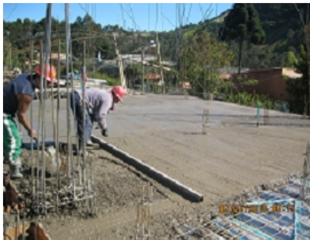
Fotografía No. 52. Fundición losa superior - nivel N+3.00 zona centro.
