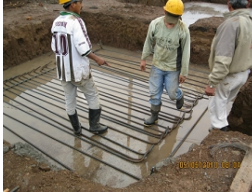
Fotografía No.15. Colocado de panelas que garantizan el recubrimiento del refuerzo, zapata 21 ejes I2 - zona centro.
