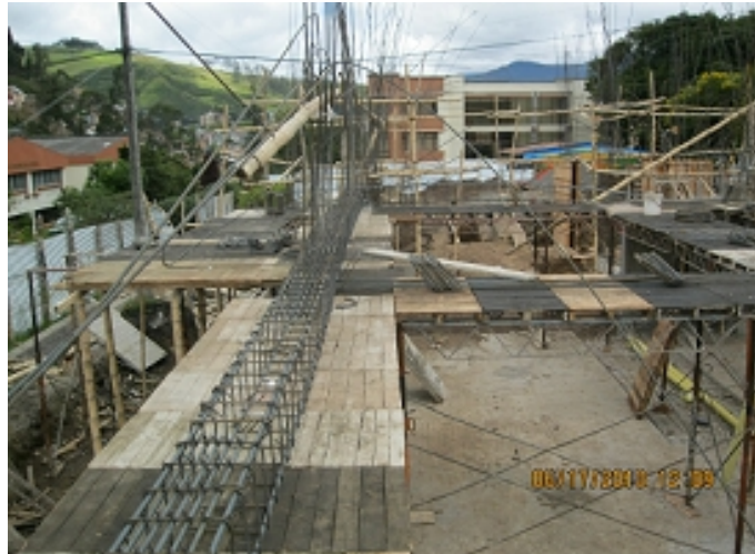
Fotografía No. 45. Armado refuerzo de viga V-101 - nivel N+3.00 zona centro.
