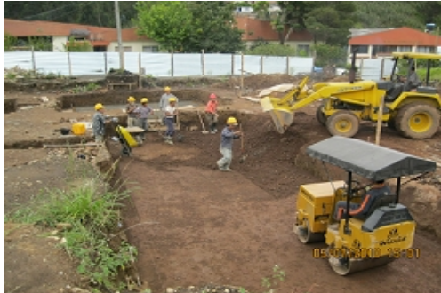
Fotografía No. 11. Se templó hilo de referencia para controlar niveles de relleno de zapatas 26 y 27 ejes J2, J3 zona centro.
