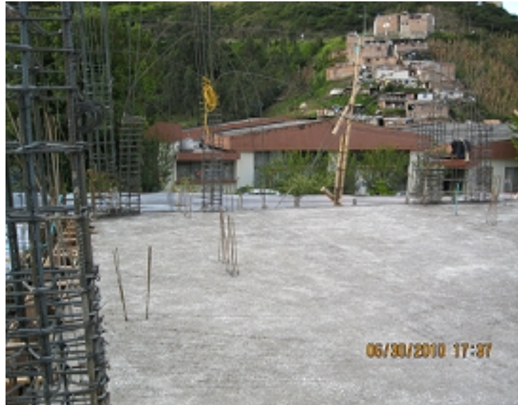
Fotografía No. 53. Curado de placa con antisol - nivel N+3.00 zona centro.
