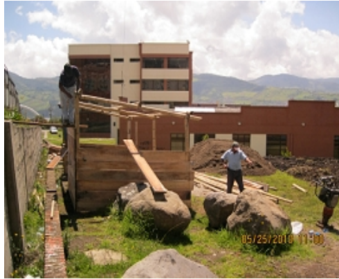
Fotografía No. 93. Excavación con máquina para explanación lote - construcción Gimnasio Fondo de Salud sede VIPRI de la Universidad de Nariño.
