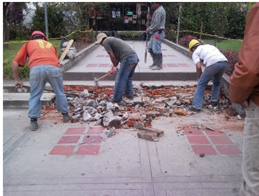
Fotografía No. 124 Solado de limpieza para construcción rampa acceso a biblioteca ALBERTO QUIJANO GUERRERO.
