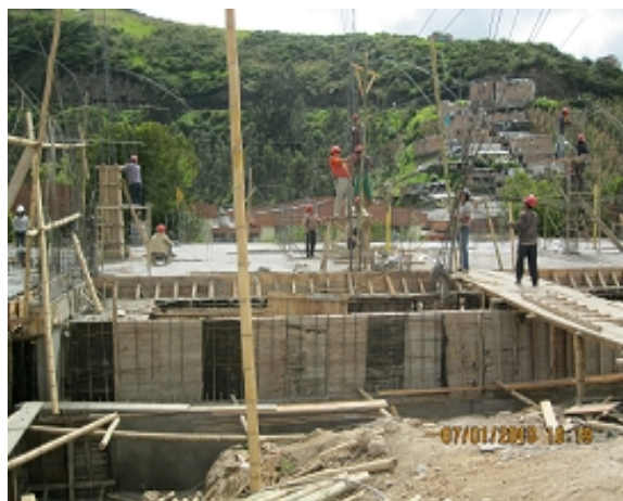
Fotografía No. 54. Armado de refuerzo columnas y pantallas - nivel N+6.00 zona centro.
