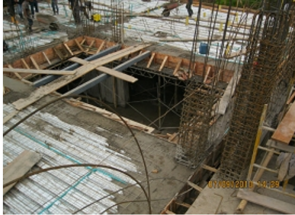
Fotografía No. 51. Fundición vigas losa de entrepiso - nivel N+3.00 zona centro.
