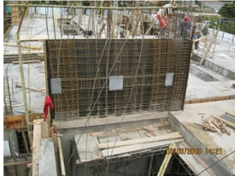
Fotografía No. 56. Encofrado de pantalla PT-1H - nivel N+6.00 zona centro.
