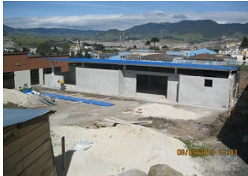
Fotografía No. 116. Vista lateral - construcción Gimnasio Fondo de Salud sede VIPRI de la Universidad de Nariño.
