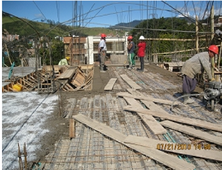
Fotografía No. 64. Fundición losa de entrepiso - nivel N+6.00 zona centro.
