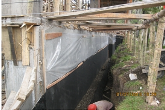
Fotografía No. 86. Perforación de tubería sanitaria para construcción de filtro muro de contención.
