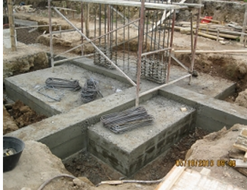
Fotografía No. 23. Zapata fundida e= 50cm, zapata 21 ejes H2 zona centro.
