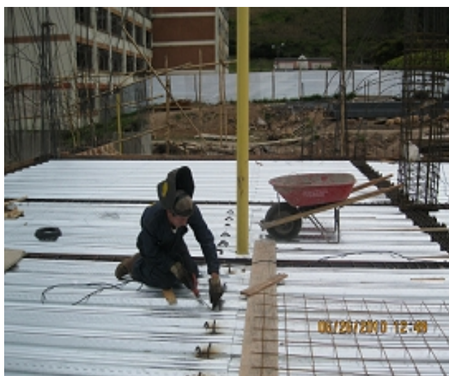
Fotografía No. 48. Soldadura de conectores de cortante sobre el metaldeck - nivel N+3.00 zona centro.
