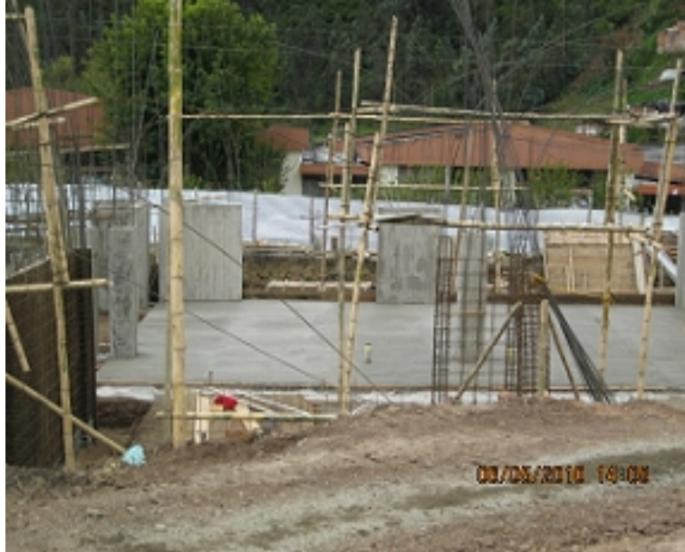
Fotografía No. 42. Terminado placa de contrapiso - zona centro.
