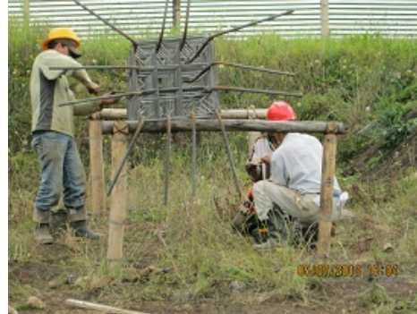
Fotografía No. 29. Armado refuerzo de columna C-J2 - zona centro.
