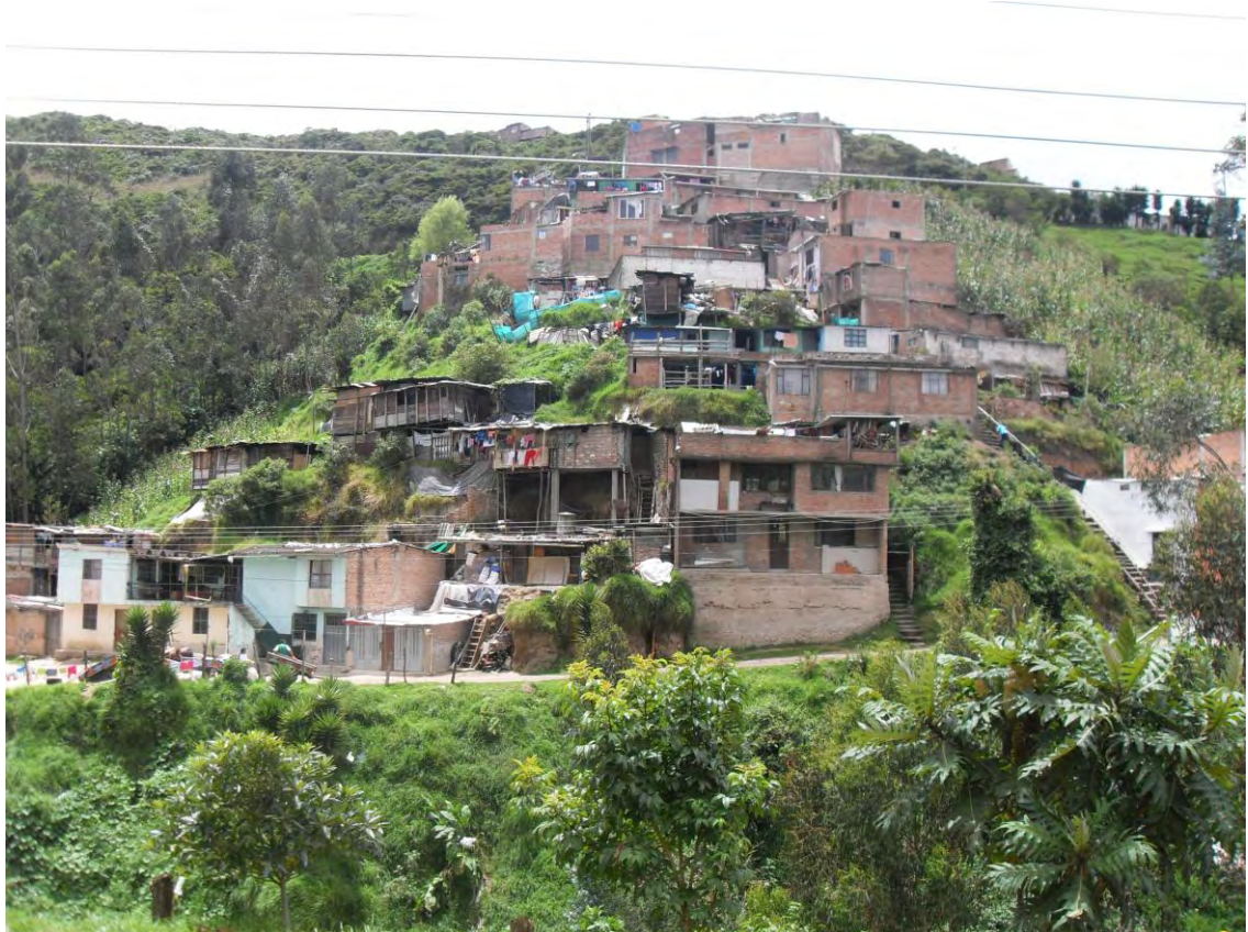
Fotografía 3. Asentamiento urbano sobre área de riesgo, Juanoy bajo norte de la ciudad
