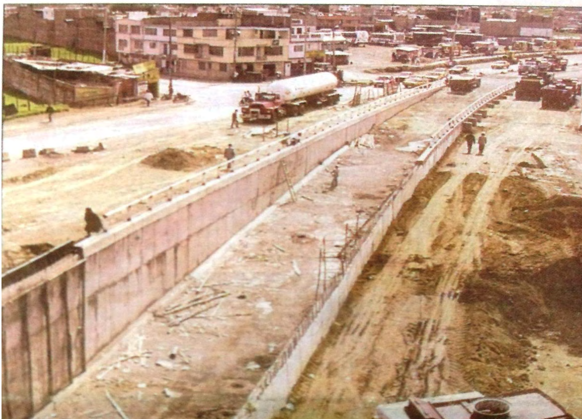
Fotografía 2. Construcción interconexión vial sector Estadio Libertad
