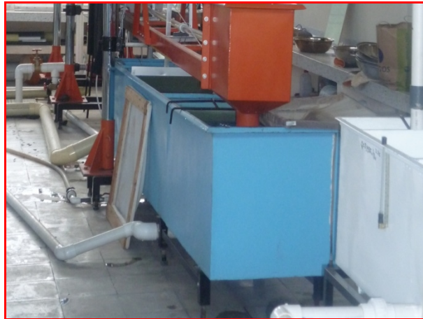
Fotografía 5. 7. Tuberías para la recirculación del agua.
