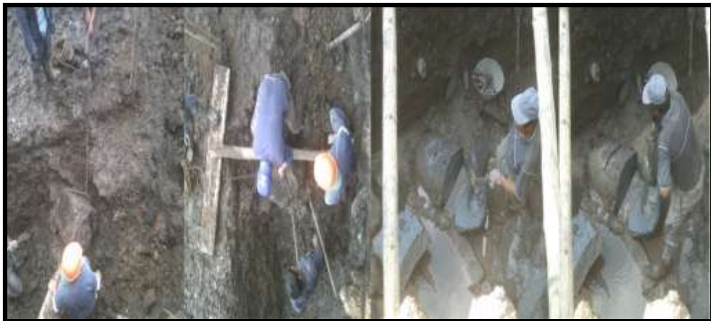
Figura 159 Retiro y corte de rocas
