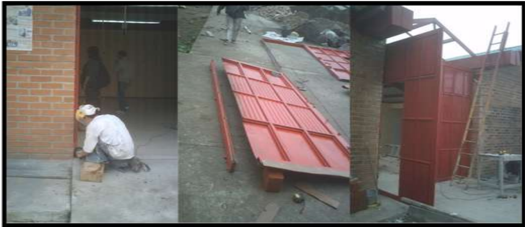
Figura 95 Retiro y adecuación d puerta metálica
