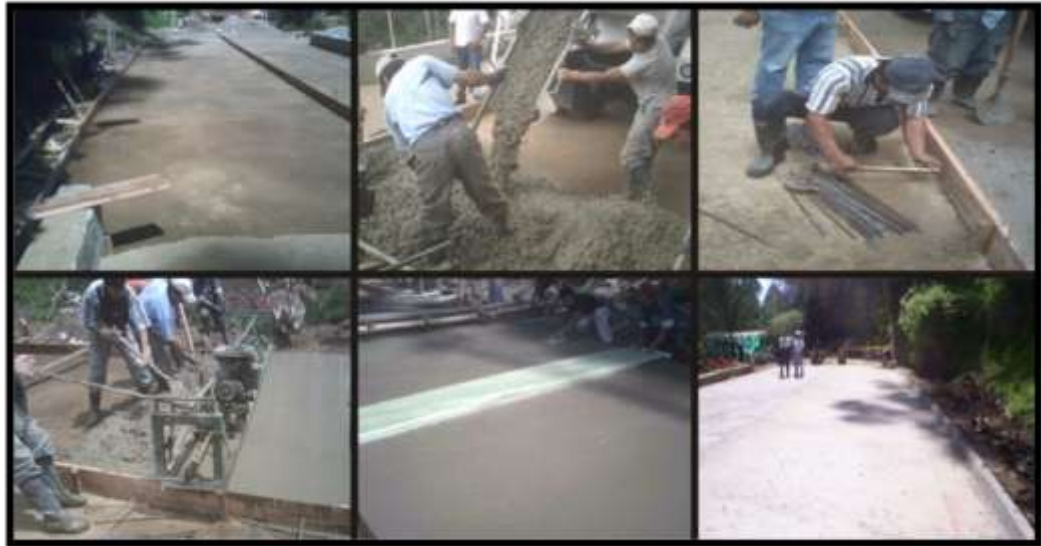
Figura 185 Suministro de concreto prefabricado para losa de pavimento
