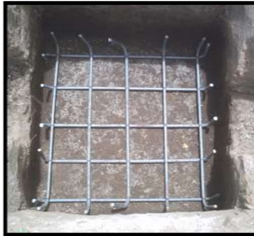
Figura 44 Encofrado con talud del terreno para zapata
