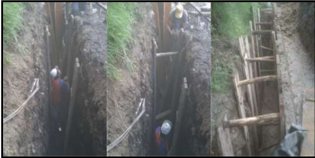
Figura 132 Excavación con entibados
