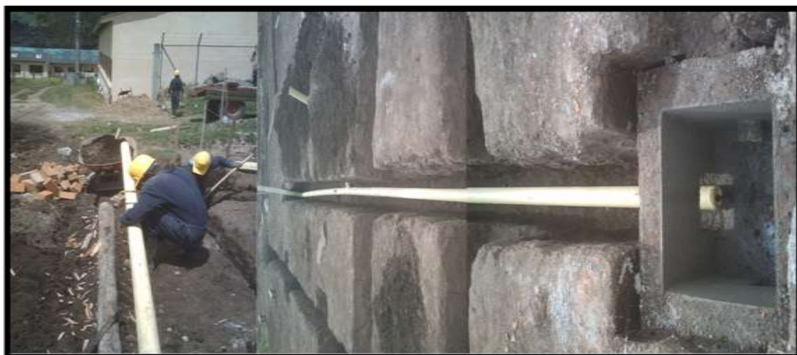
Figura 76 Corte e instalación de tubos sanitarios
