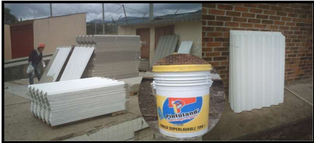
Figura 87 Pintura de la cara interna de la cubierta
