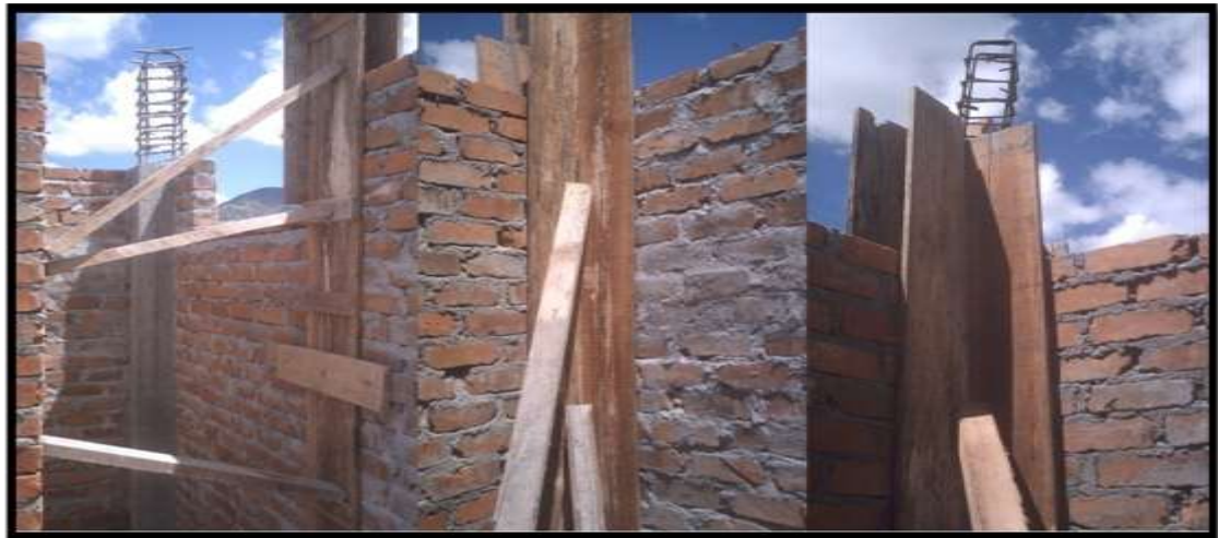
Figura 63 Encofrado de columnetas.
