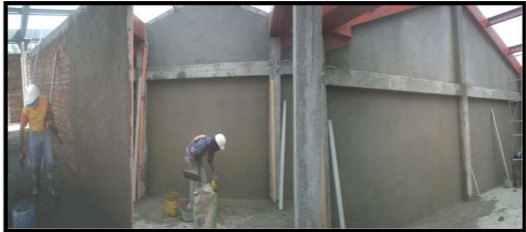
Figura 80 Pañete muros vigas y columnas
