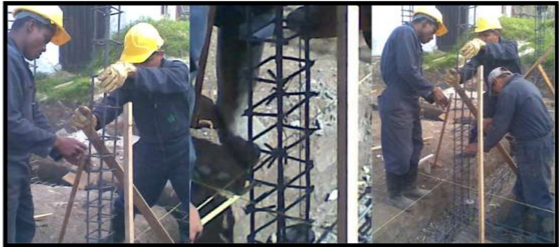
Figura 62 Armado de columnetas
