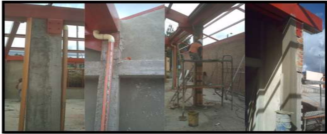
Figura 100 Embebida de bajantes de aguas lluvias
