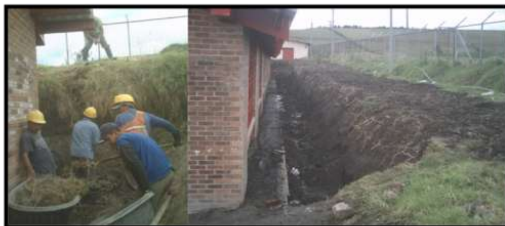
Figura 119 Excavación de futuras zonas verdes
