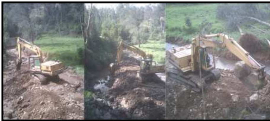
Figura 152 Excavación a máquina para desvío de quebrada.
