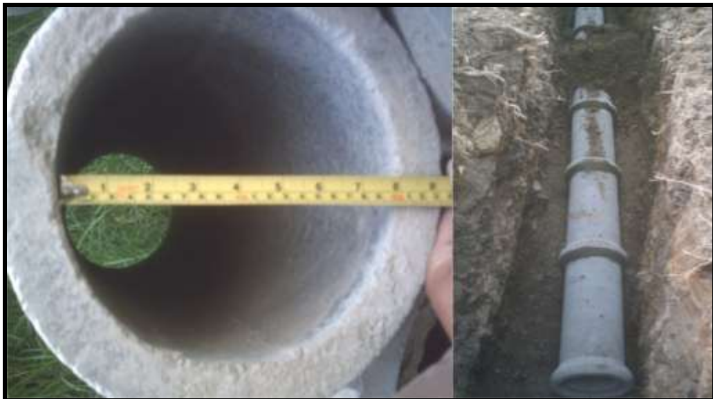
Figura 145 Tubería de concreto
