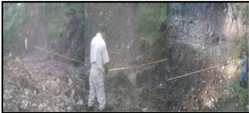
Figura 150 Localización y replanteo para muro de gaviones
