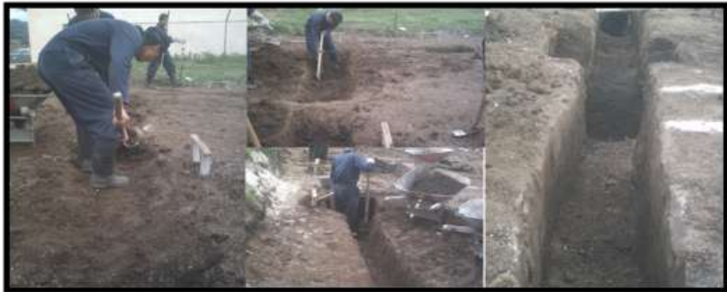
Figura 46 Excavación vigas de cimentación.
