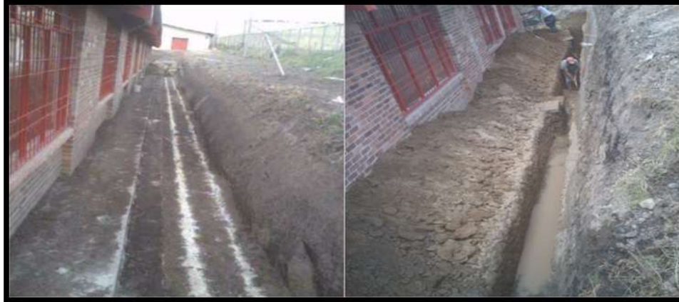
Figura 112 Excavación para filtro francés
