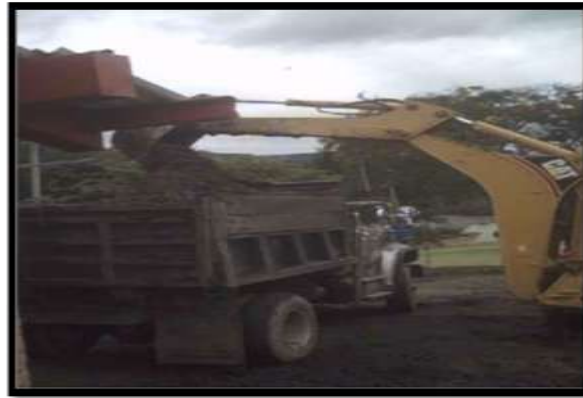
Figura 116 Retiro de material sobrante
