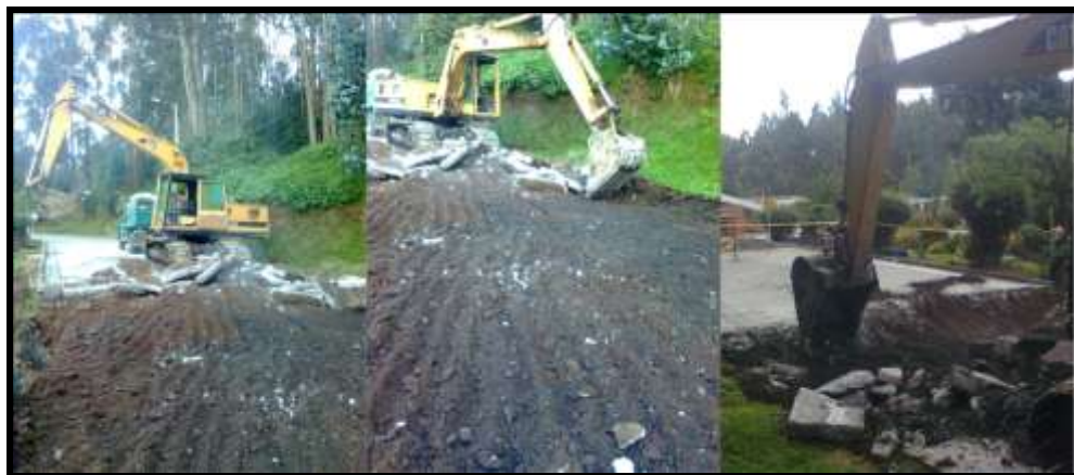
Figura 151 Demolición placa de concreto.
