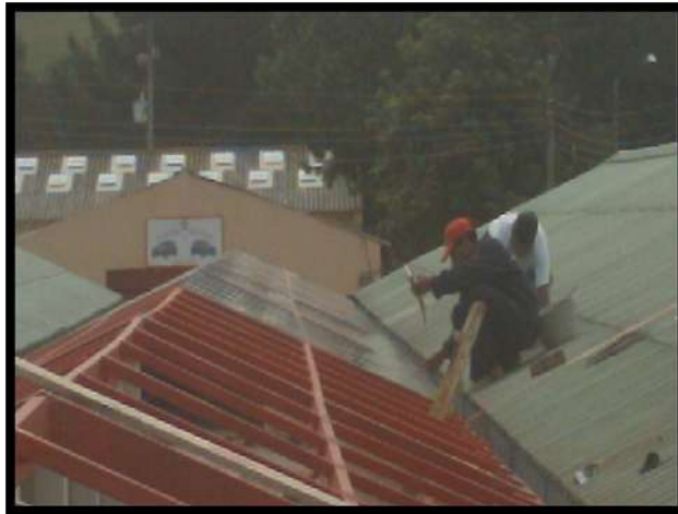
Figura 93 Instalación de vidrio para cubierta
