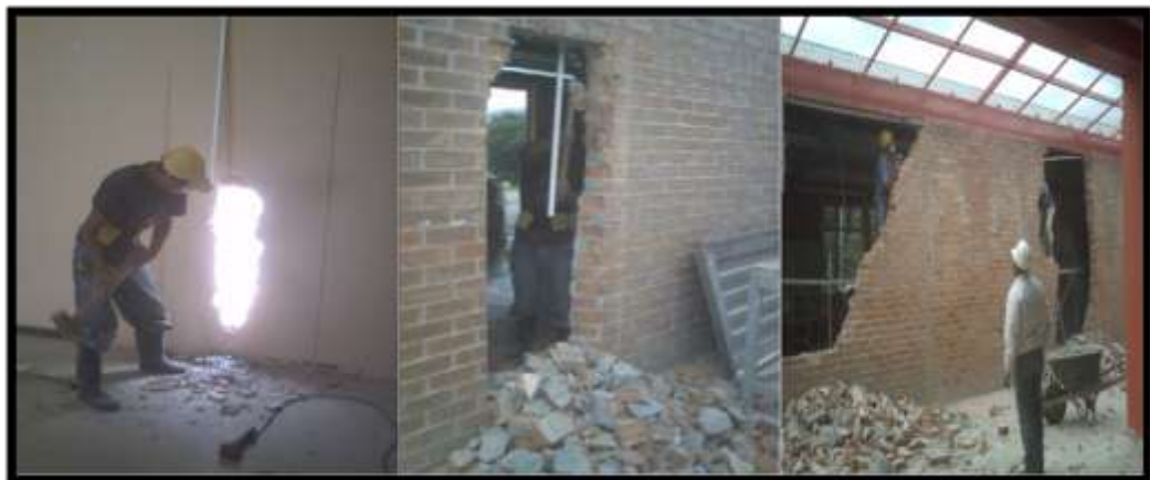
Figura 101 Demolición de muros
