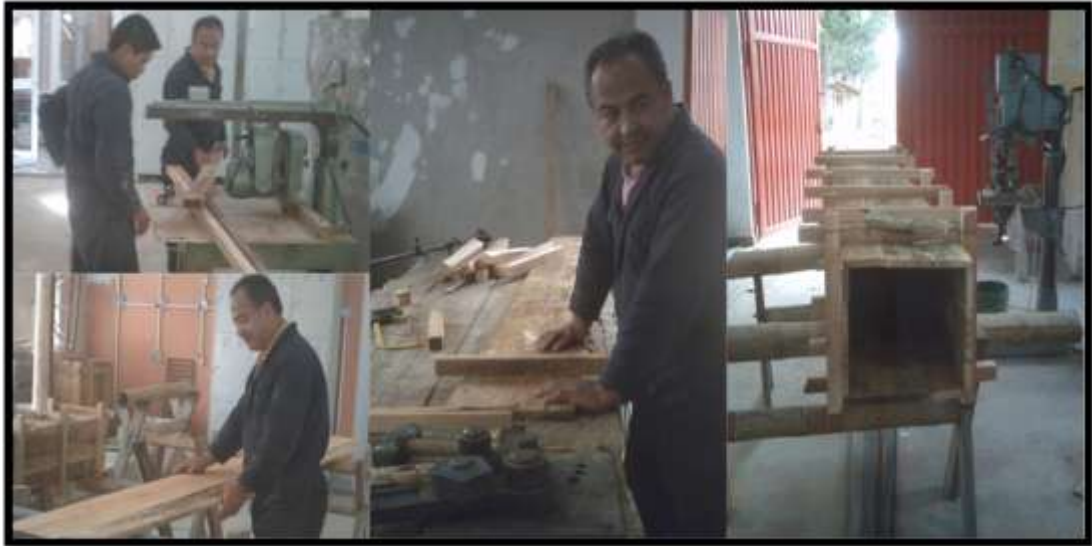
Figura 32 Construcción del encofrado
