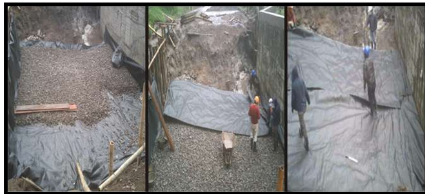
Figura 180 Instalación y suministro de geotextil y triturado
