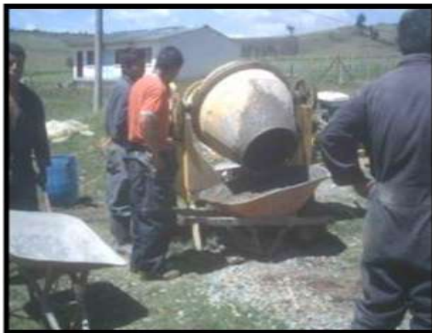
Figura 38 Transporte de concreto
