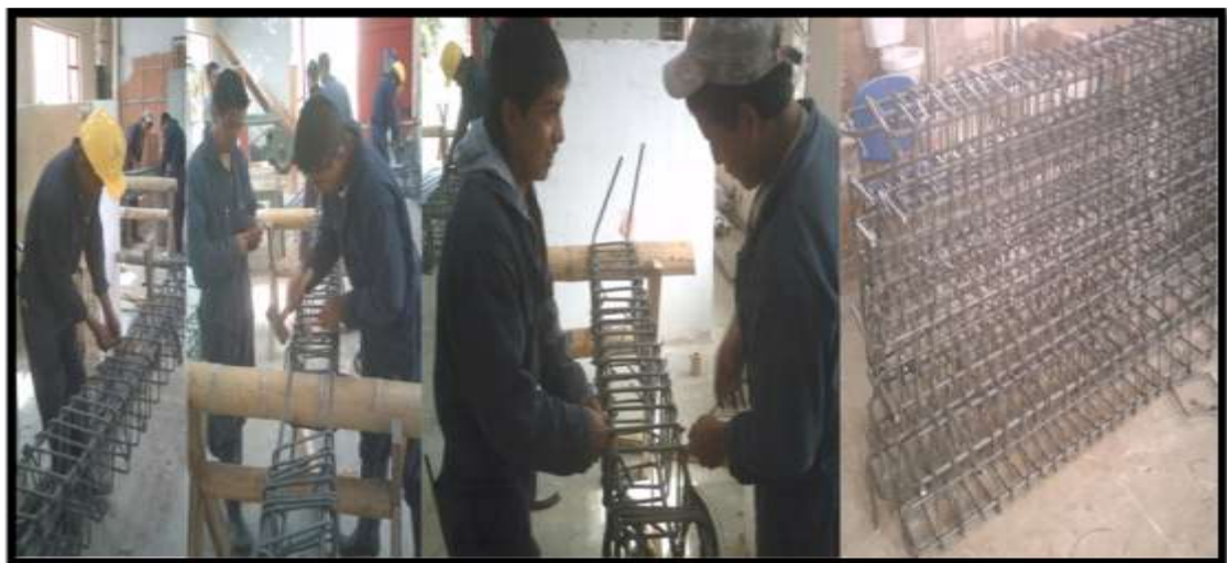
Figura 58 Armado de columnas
