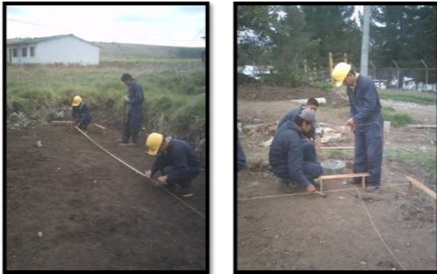
Figura 28 Localización y replanteo
