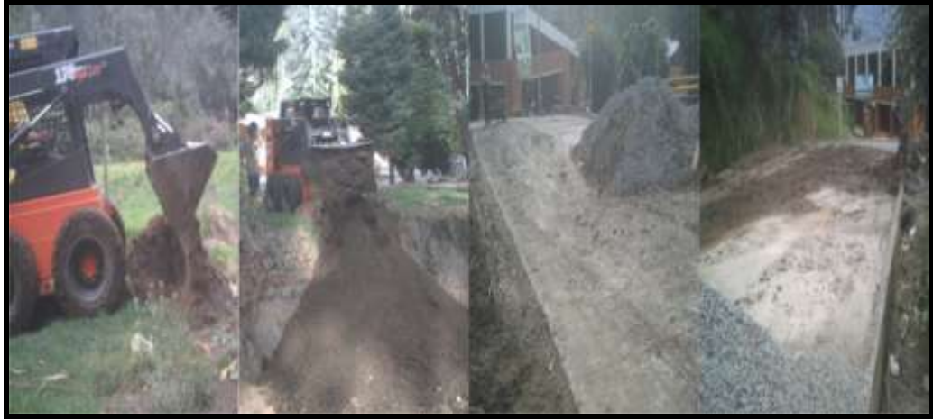
Figura 148 Limpieza del sitio de trabajo
