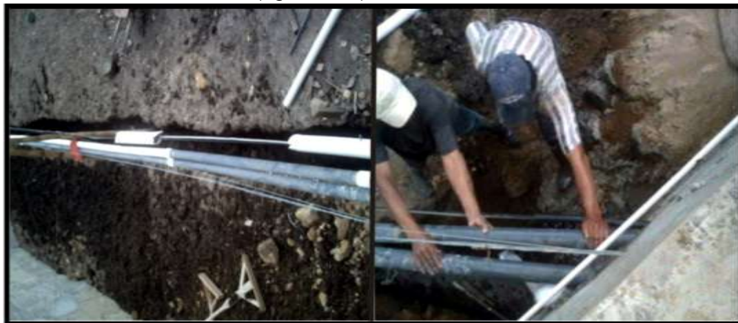
Figura 191 Adecuación de instalaciones
