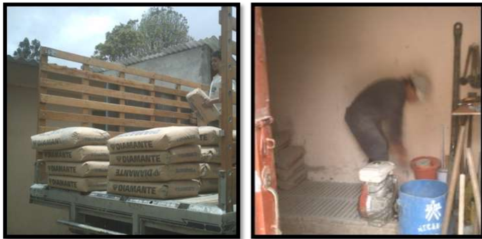
Figura 35 Almacenamiento de cemento.
