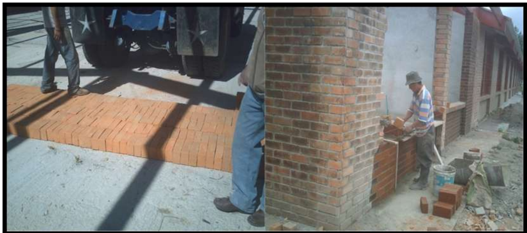
Figura 81 Muro en ladrillo común
