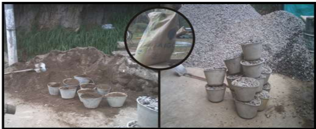
Figura 167 Materiales para fundición muro de contención
