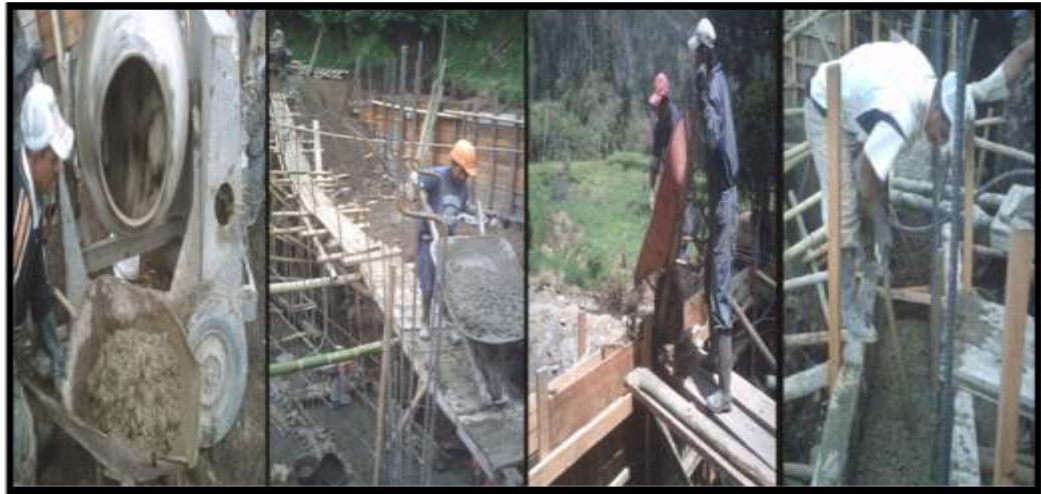
Figura 169 Transporte, colocación y vibrado de concreto
