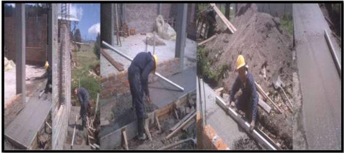
Figura 72 Fundición de andenes.
