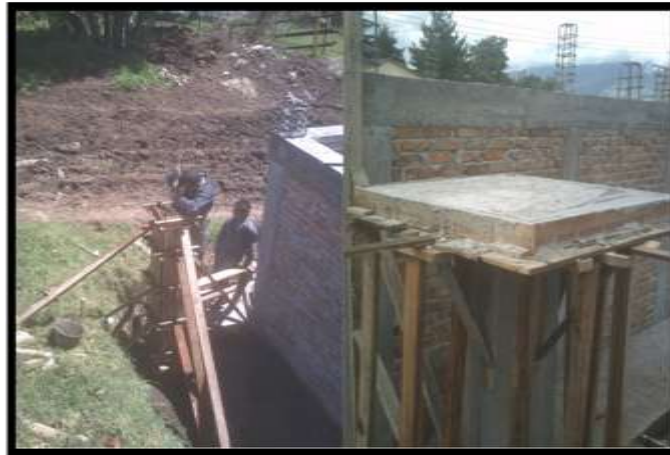
Figura 67 Fundición de columna para el soporte del tanque
