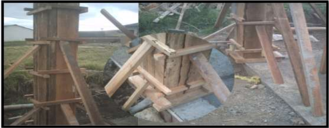
Figura 59 Encofrado de columnas
