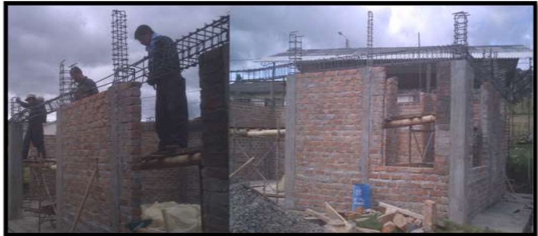
Figura 48 Armado de refuerzo de vigas
