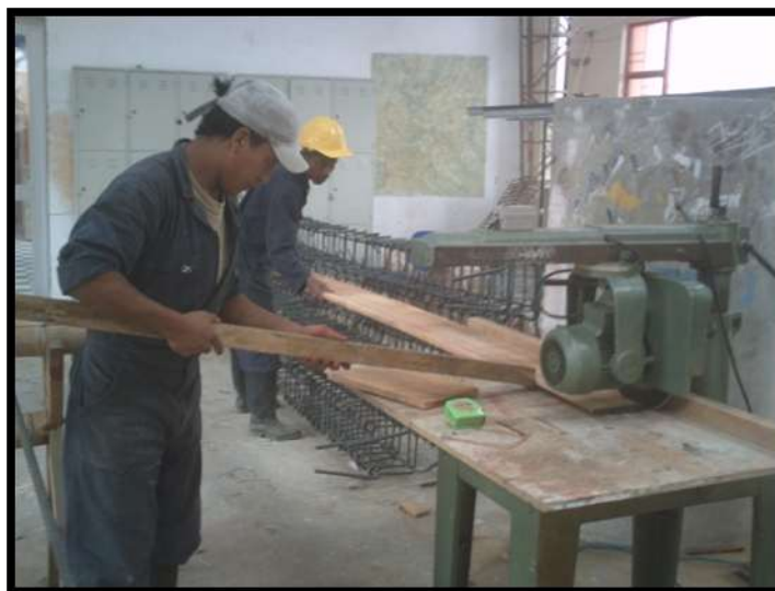
Figura 31 Trabajos con madera.
