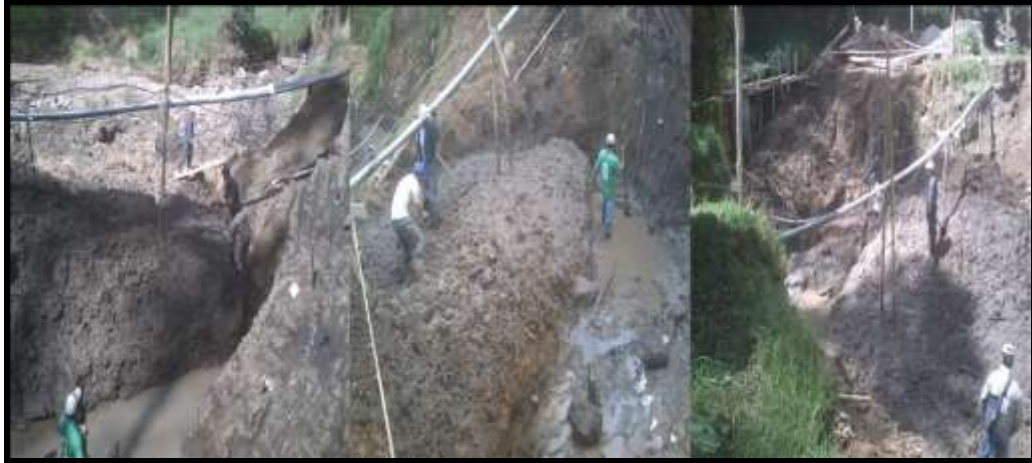
Figura 158 Excavación de zanjas de drenaje para muro de contención
