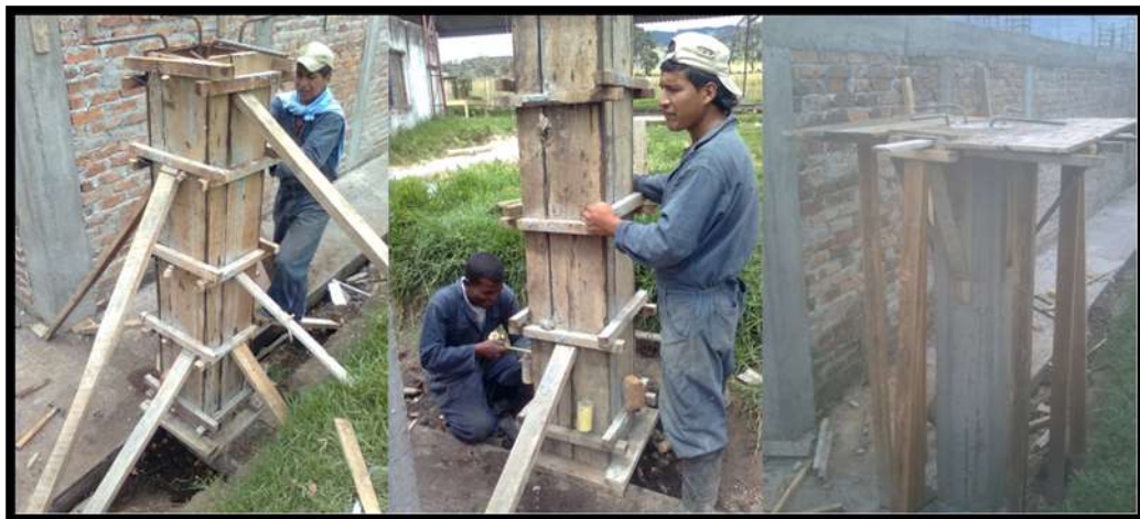
Figura 66 Encofrado de columna y losa para el soporte del tanque
