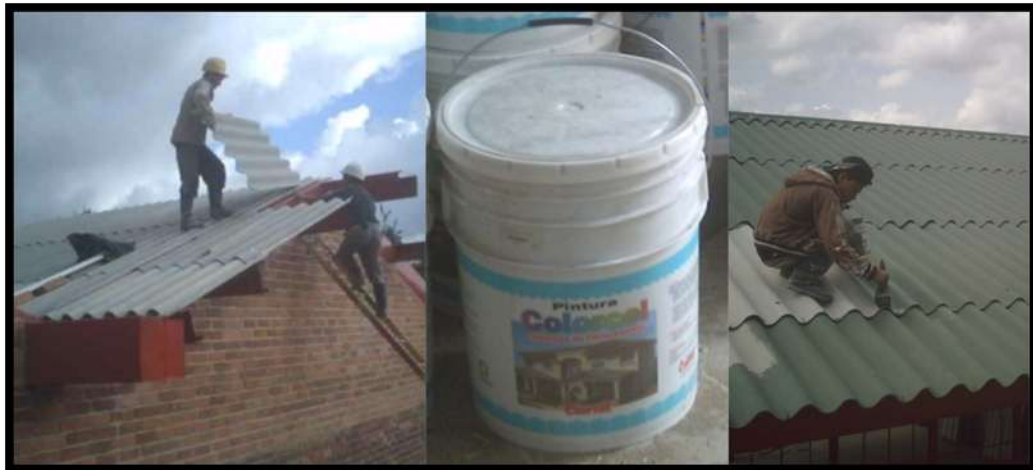
Figura 88 Instalación y pintura externa de la cubierta
