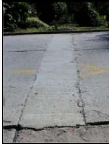
Figura 143 Placa de concreto
