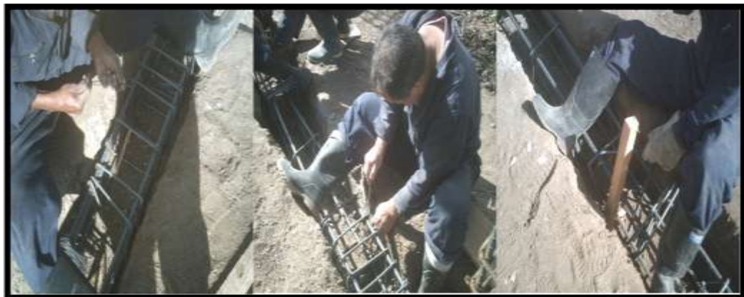
Figura 47 Armado de refuerzo de vigas de cimentación.
