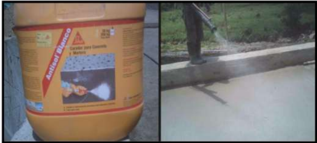
Figura 187 Curado del concreto con Antisol
