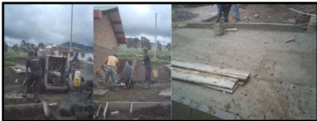
Figura 117 Construcción de andén en zona de acceso
