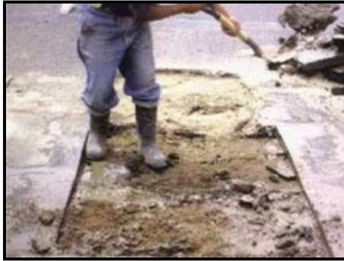
Figura 133 Demolición de concreto
