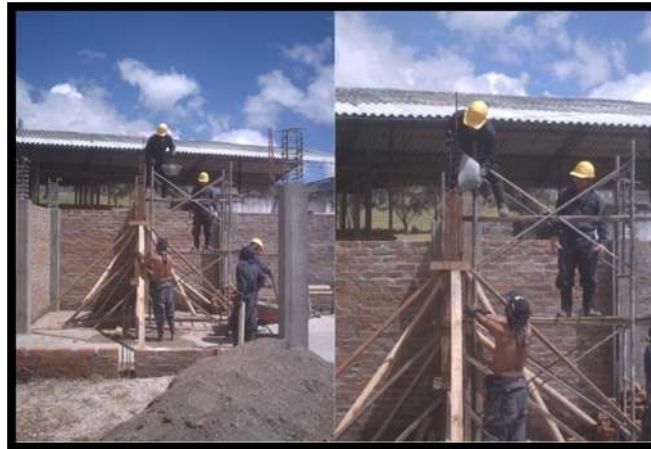
Figura 64 Fundición de columnetas.
