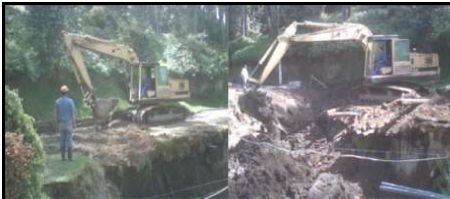
Figura 153 Excavación a máquina para retiro de la base granular y subrasante
