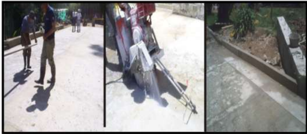
Figura 186 Corte de pavimento para juntas de dilatación
