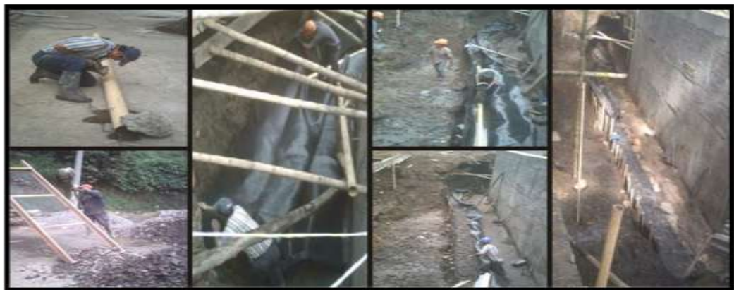
Figura 176 Construcción del filtro muro de contención
