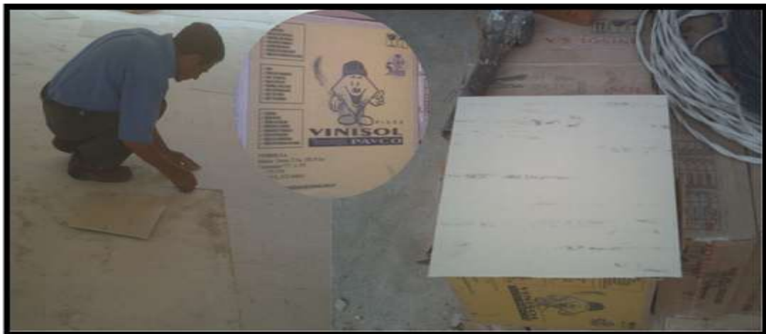
Figura 92 Instalación de vinisol
