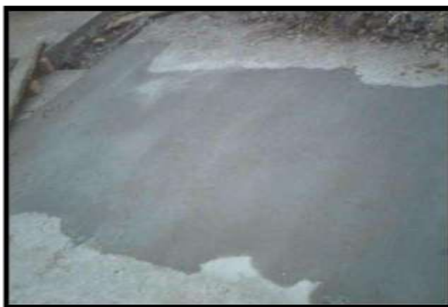
Figura 129 Reposición de pavimento
