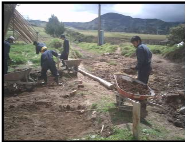
Figura 24 Limpieza y descapote inicial
