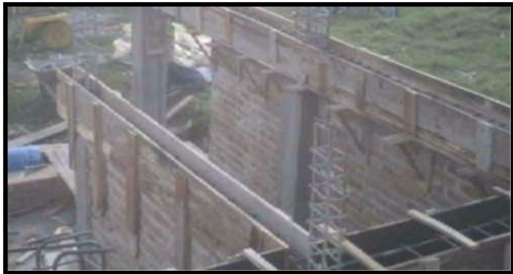
Figura 55 Encofrado vigueta corona
