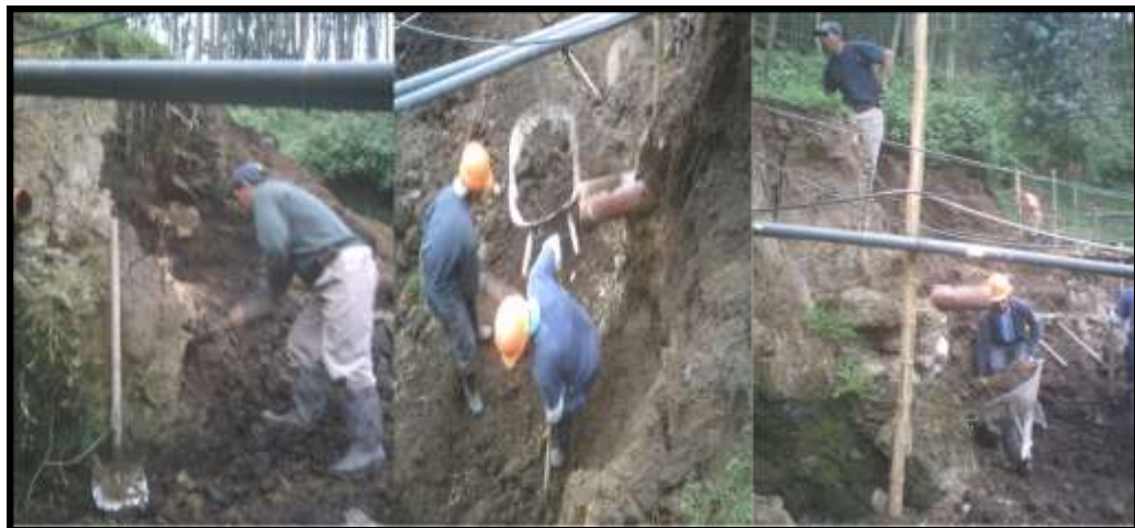
Figura 157 Excavación para muro de contención
