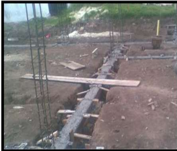
Figura 56 Fundición vigueta cimentación
