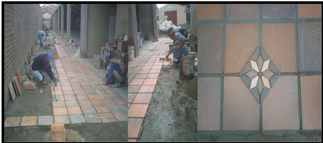
Figura 94 Instalación de tablón de gres
