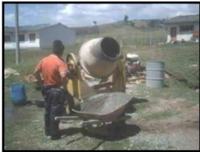
Figura 36 Producción de concreto en obra
