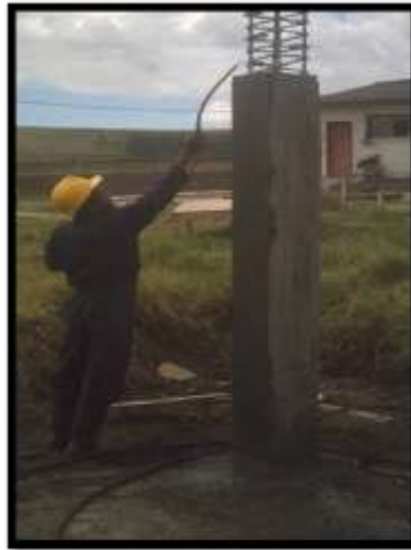
Figura 61 Curado de columnas
