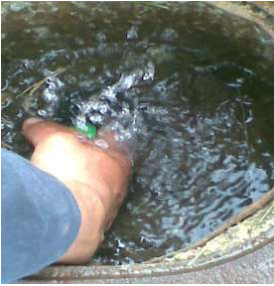
Fig. 6 (Prueba del hidrante)
