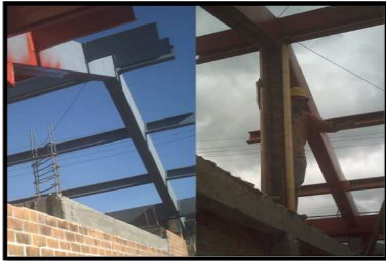
Figura 98 Columnas de amarre
