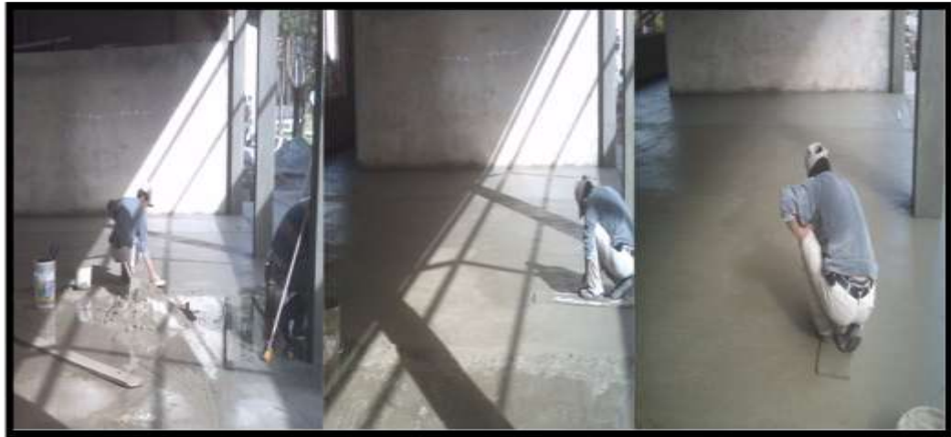
Figura 91 Repello del piso
