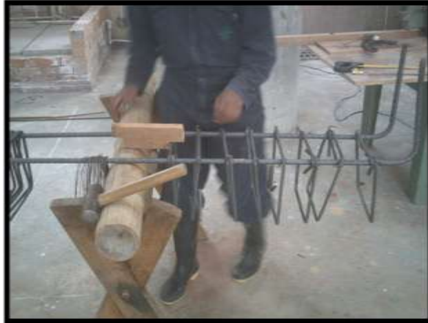
Figura 65 Armado de columna para el soporte del tanque
