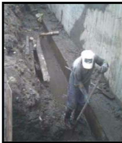
Figura 175 Excavación filtro muro de contención
