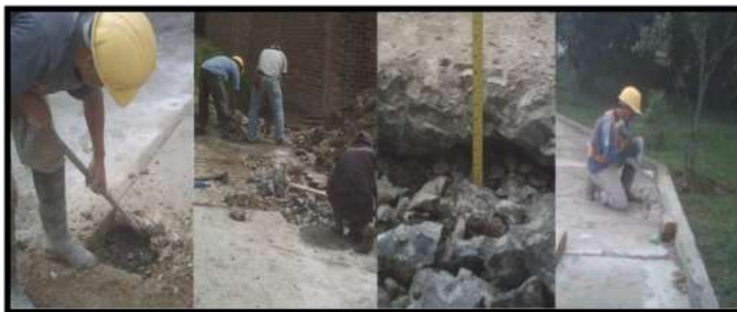
Figura 118 Demolición de pavimento
