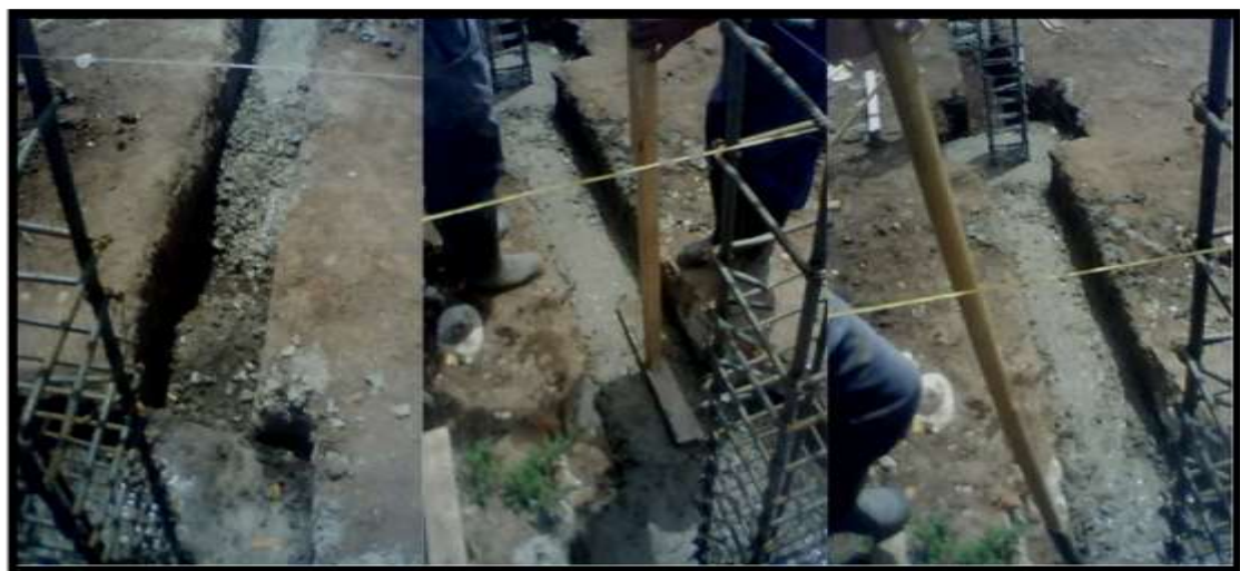
Figura 51 Fundición vigas de cimentación.
