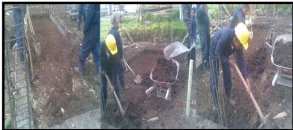
Figura 68 Excavación para contrapiso
