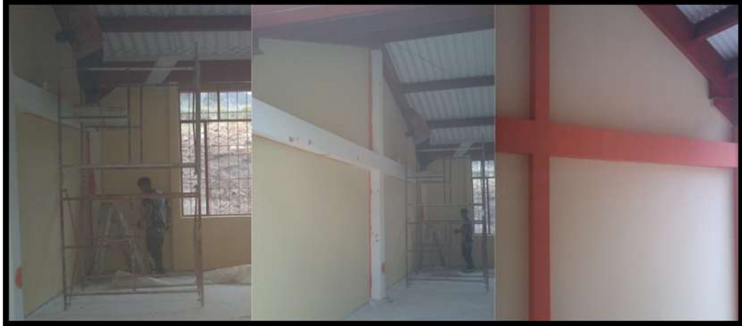
Figura 105 Pintura muros, vigas y columnas
