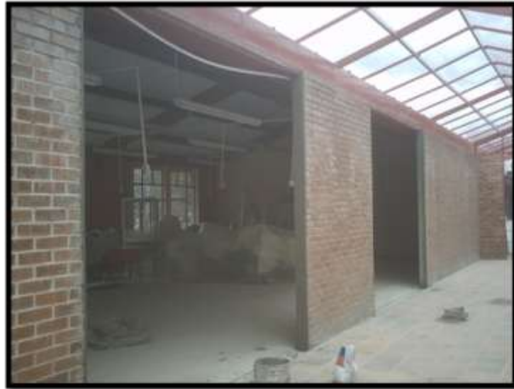
Figura 102 Culminación de la demolición de muros
