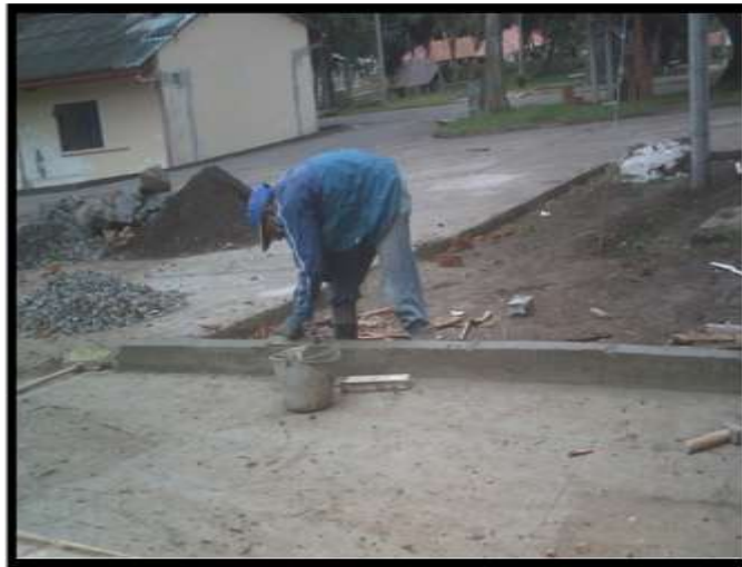
Figura 120 Construcción sardinel integrado a la placa de andén de la zona de acceso
