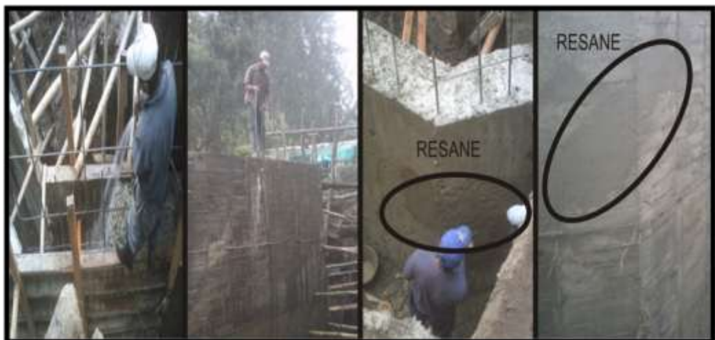
Figura 170 Curado y resane de muro contención
