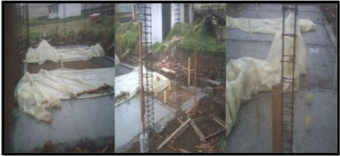
Figura 70 Fundición de contrapiso
