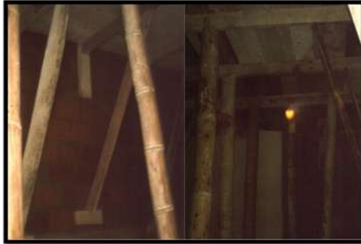
Figura 108 Puntales para losa maciza
