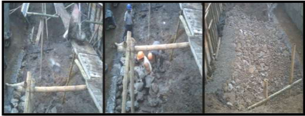
Figura 179 Adecuación excavación pedradren
