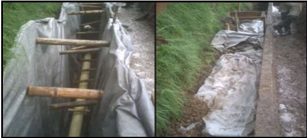
Figura 141 Utilización del geotextil en el filtro
