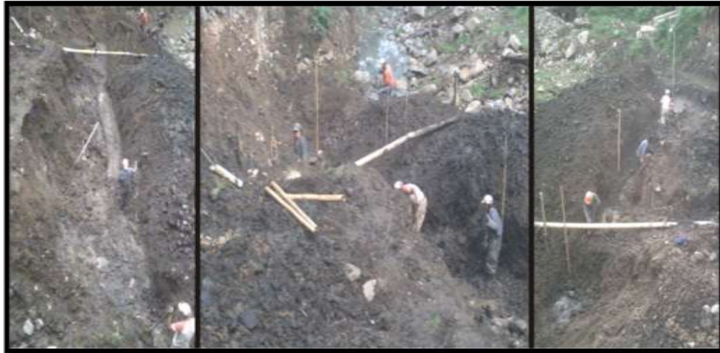
Figura 181 Excavación para muros de gaviones
