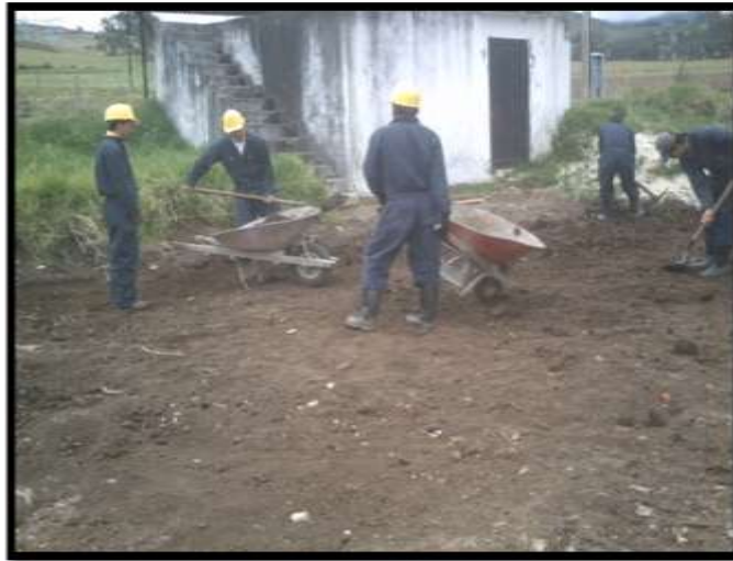
Figura 25 Limpieza y descapote final
