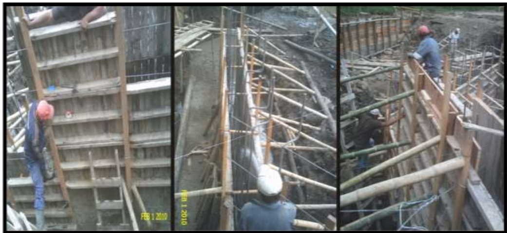
Figura 165 Encofrado muro de contención
