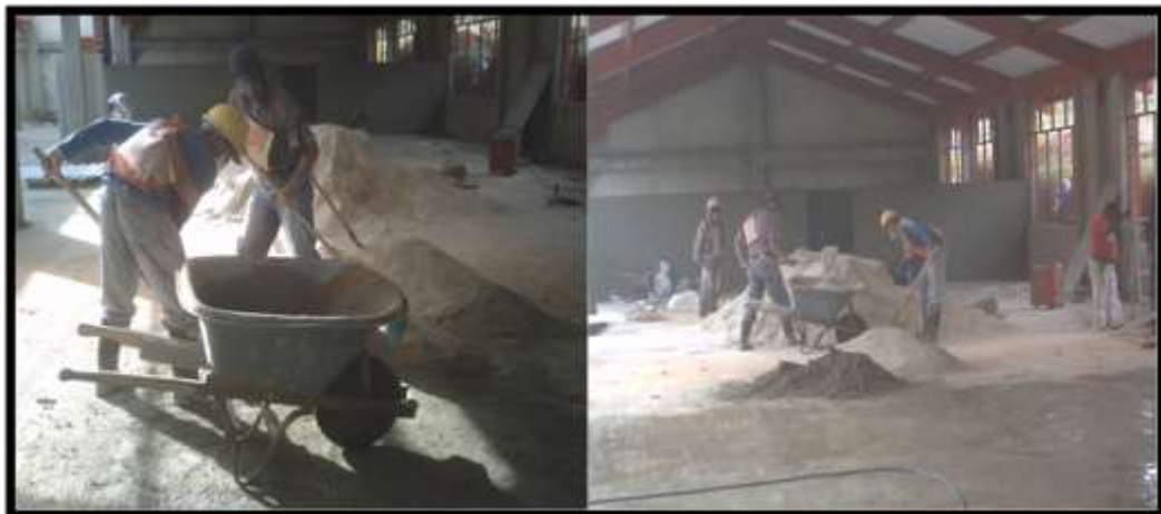
Figura 90 Elaboración de mortero 1:4 para el piso
