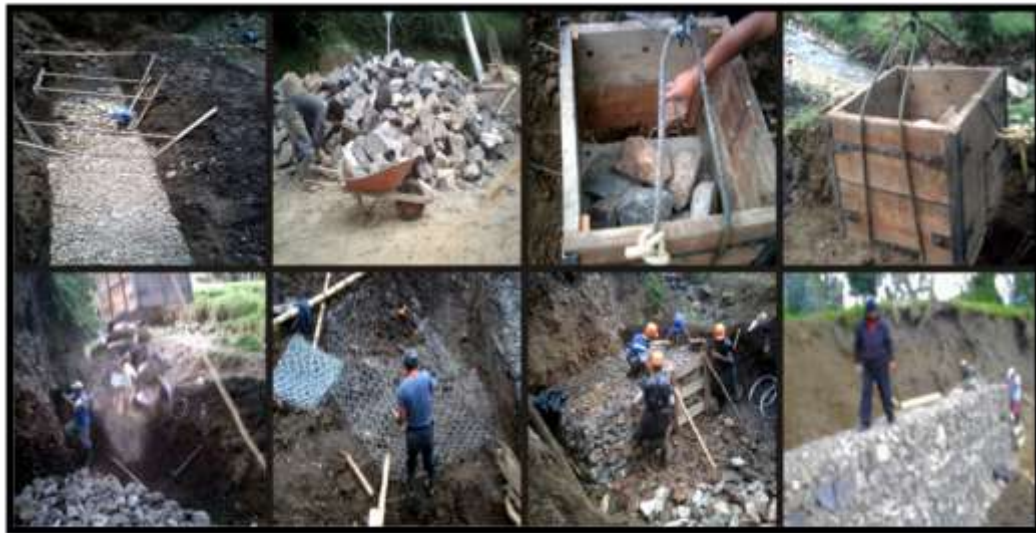
Figura 189 Proceso constructivo muro de gaviones
