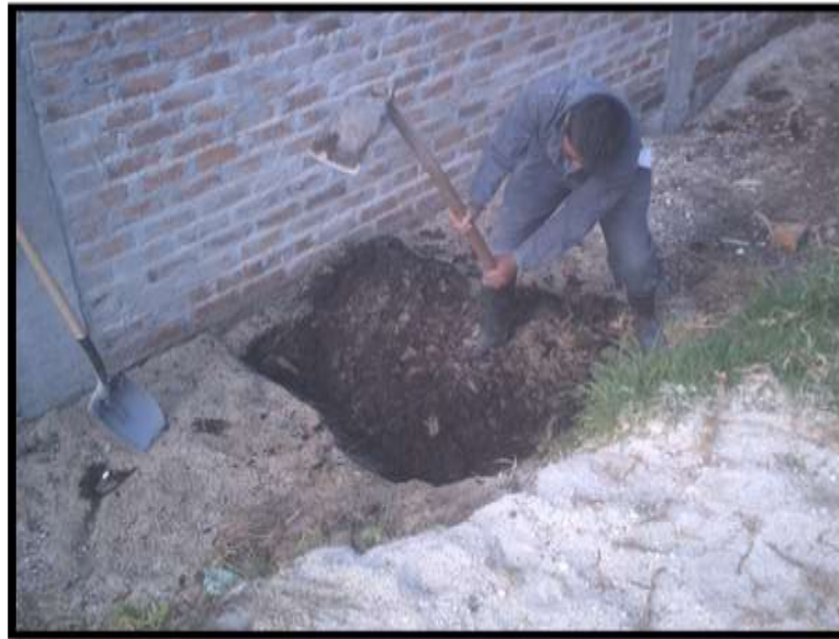
Figura 69 Excavación para andenes
