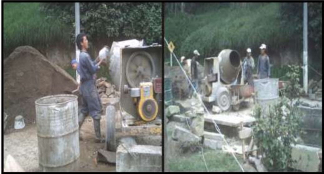
Figura 168 Mezcla de concreto muro de contención
