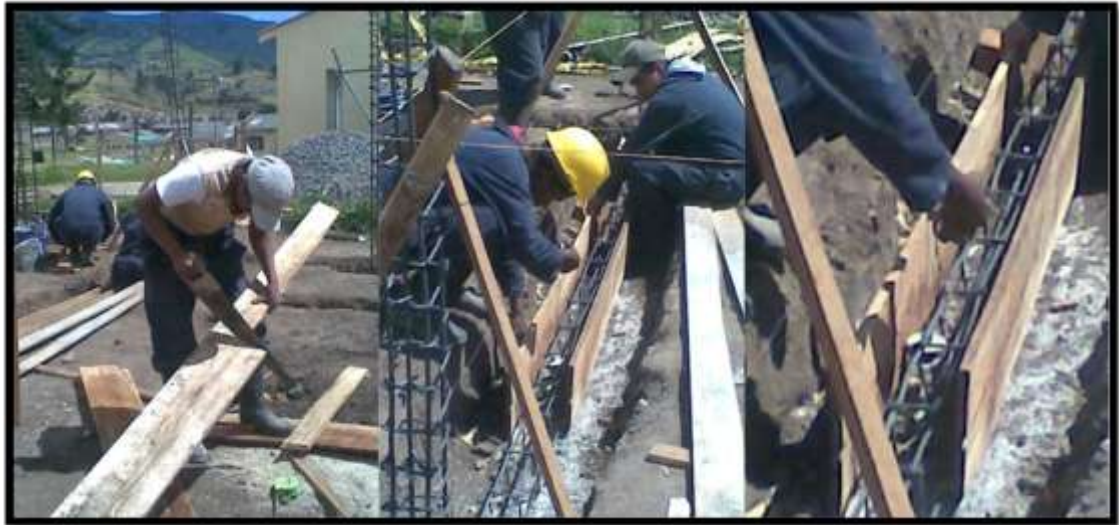
Figura 54 Encofrado viguetas de cimentación
