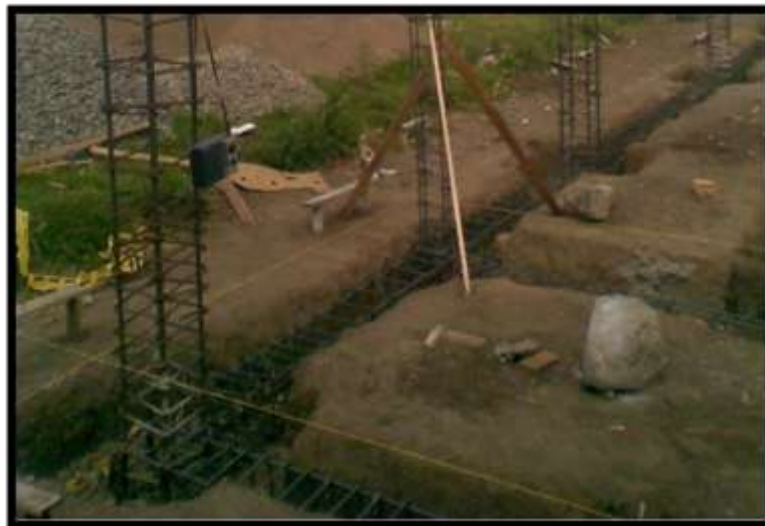
Figura 49 Encofrado de vigas de cimentación
