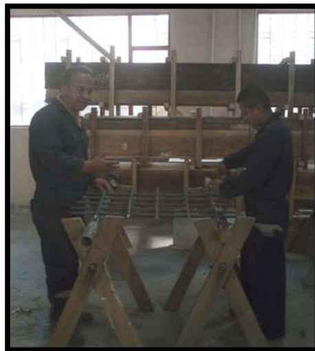
Figura 43 Construcción de estructura para zapata.
