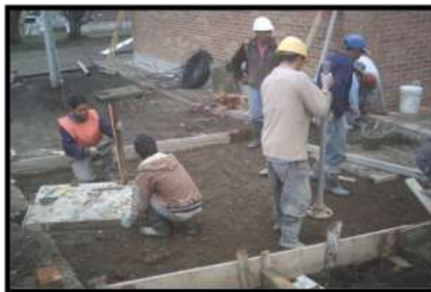
Figura 113 Relleno zona de acceso
