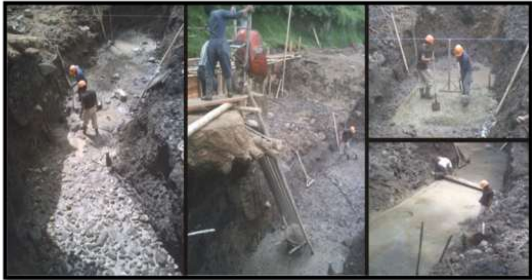
Figura 160 Elaboración de solado
