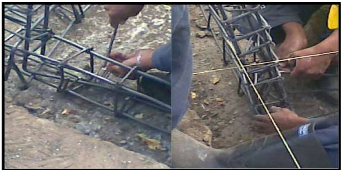
Figura 53 Armado viguetas de cimentación
