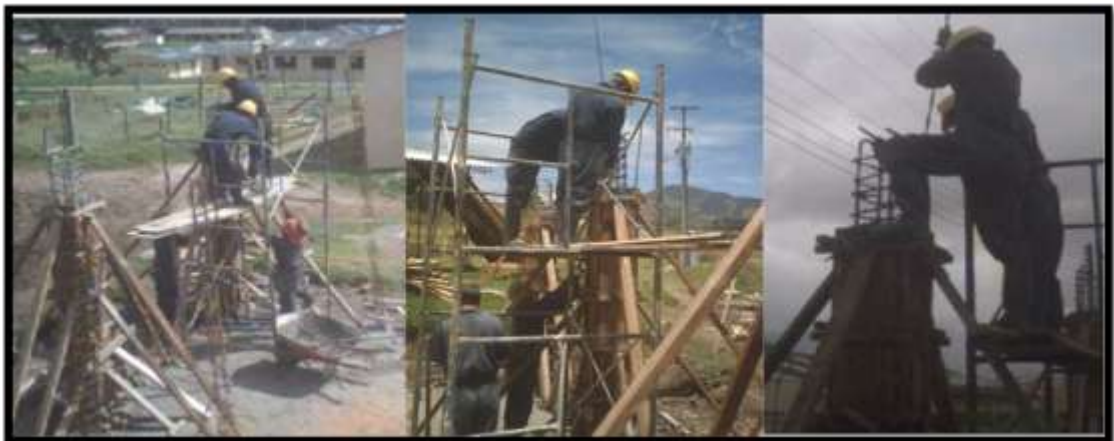
Figura 60 Fundición de columnas
