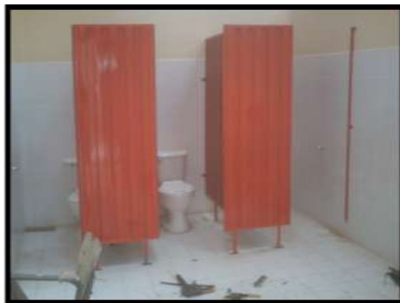
Figura 106 Divisiones metálica para baños
