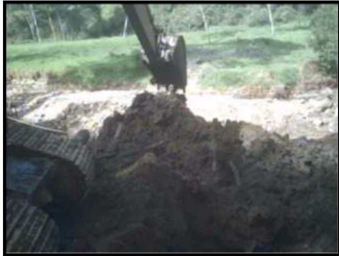
Figura 155 Retiro y disposición de material para terraplén
