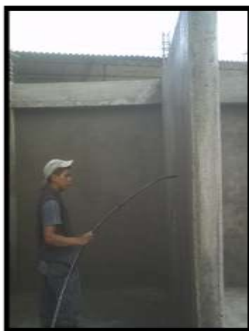
Figura 75 Curado revoque muro
