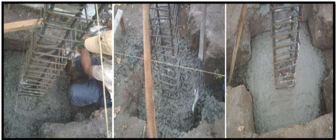
Figura 45 Fundición de zapata.
