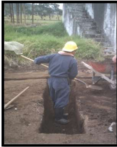
Figura 40 Excavación cimientos corridos.
