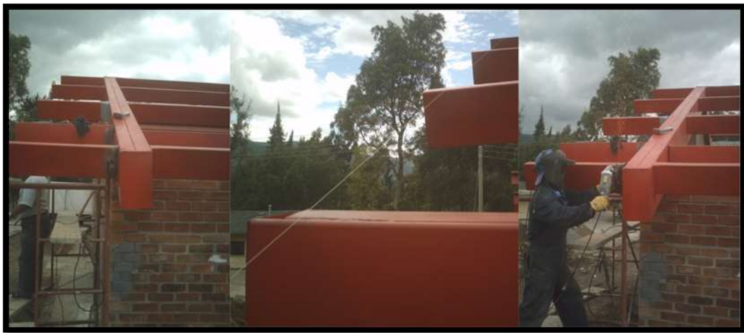
Figura 86 Adecuación de estructura metálica para cubierta
