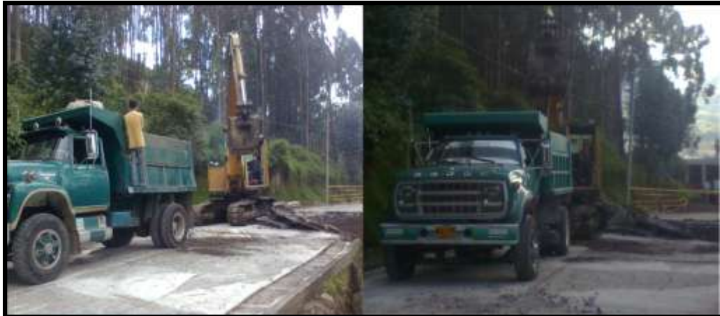
Figura 154 Retiro de pavimento
