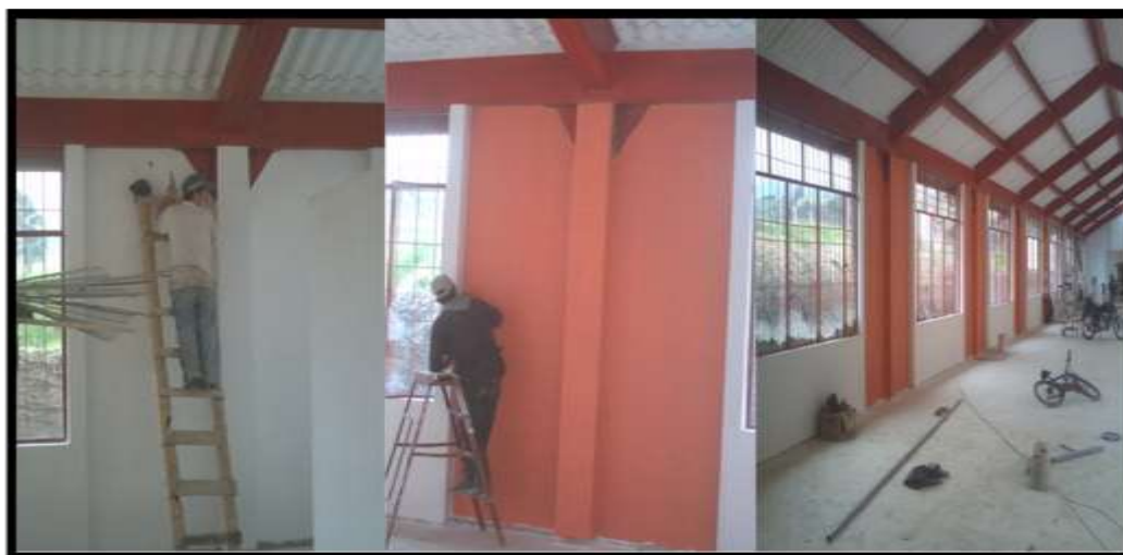
Figura 104 Pintura muros, y columnas
