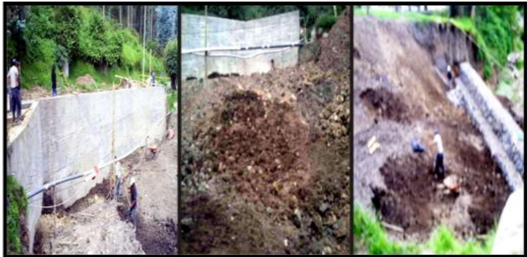
Figura 190 Construcción de terraplén
