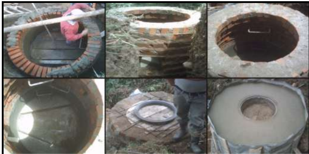
Figura 144 Cámara de inspección
