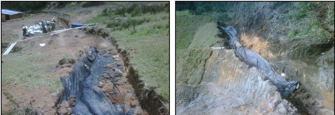
Figura 39. Canalización de quebrada adyacente a los taludes del Portal Norte.
