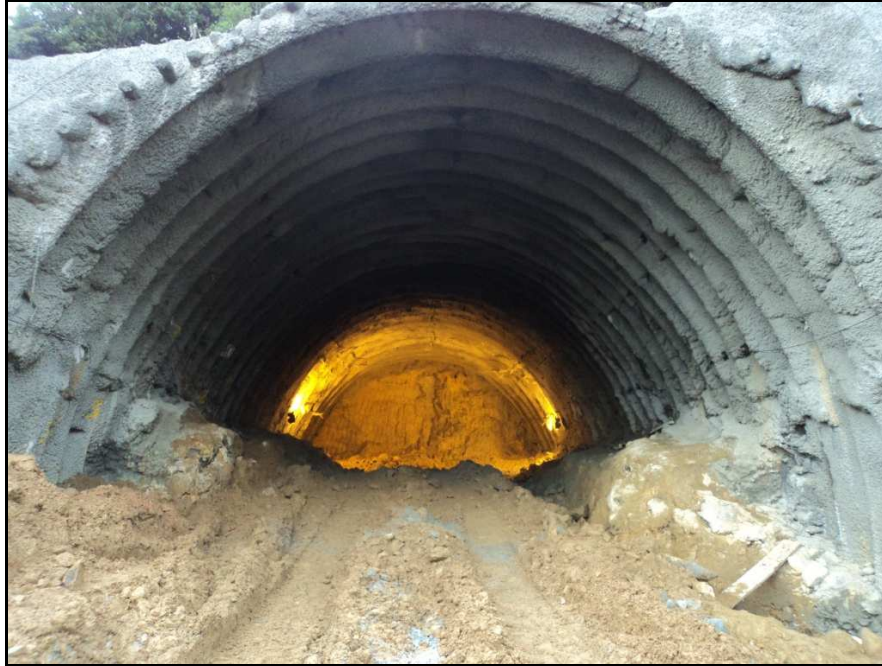
Figura 73. Fotografía de Excavación subterránea Portal Sur
