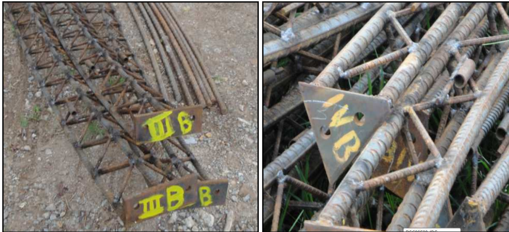
Figura 34. Elementos terminados e identificados del arco.
