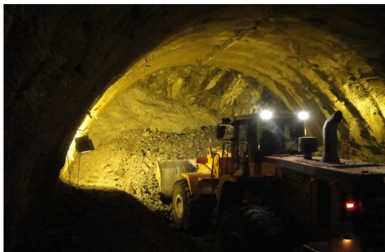
Figura 52. Remoción de roca fragmentada resultante de la voladura.
