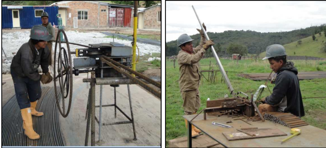
Figura 33. Proceso de flejado para el cordón superior e inferior del arco (izquierda) y para las diagonales (derecha).
