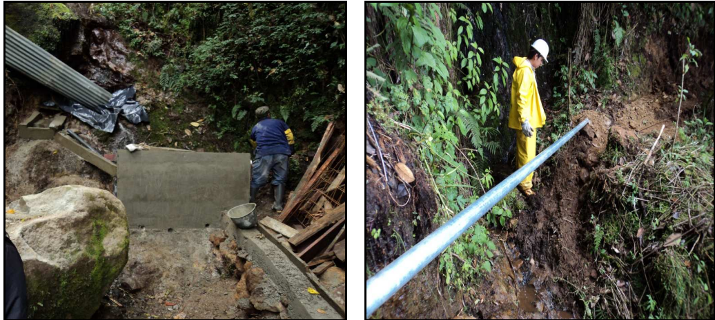
Figura 70. Fotografía construcción bocatoma, tanque de almacenamiento y conducción de acueducto Juanoy
