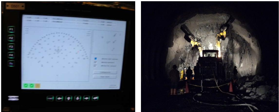
Figura 50. Proceso de perforación realizada por el Jumbo.
