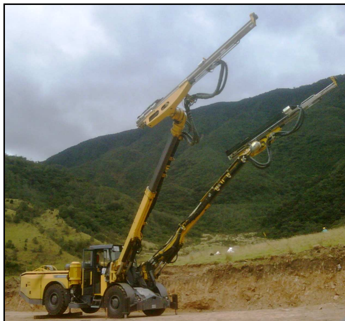
Figura 49. Jumbo empleado para la excavación por perforación y voladura.
