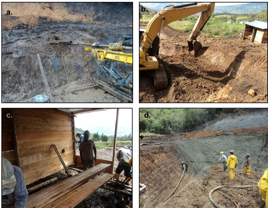
Figura 71. Fotografías de trabajos realizados en el Portal Sur.
