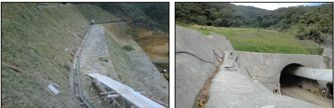
Figura 40. Talud del Portal Norte.
