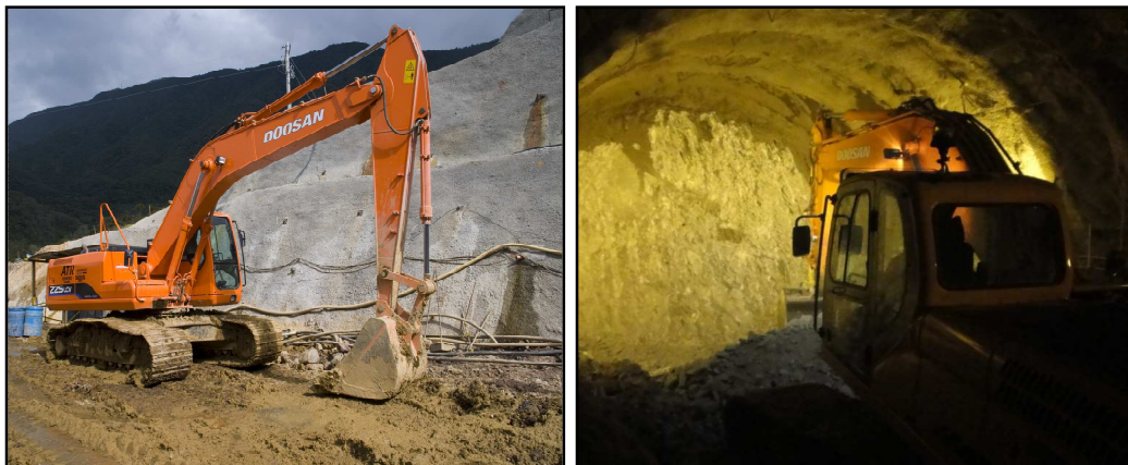
Figura 47. Excavadora hidráulica empleada en excavación mecánica.
