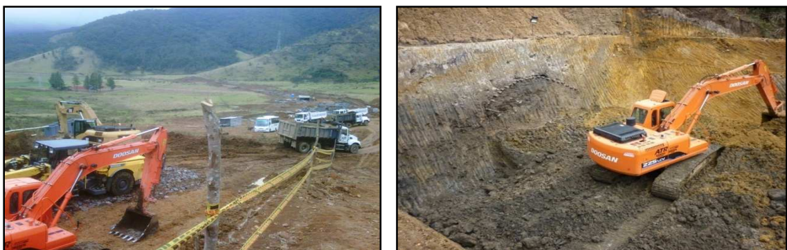
Figura 38. Excavaciones del Portal Norte (en la figura la excavadora DOOSAN S225LCV).
