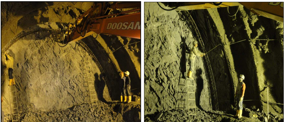
Figura 53. Instalación de arcos y separadores.
