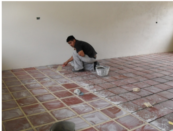
Figura 69. Emboquillado con granito.
