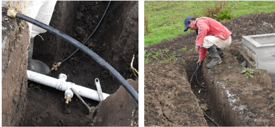
Figura 94. Instalación galápago y registro, dobles de la salida de la manguera.
