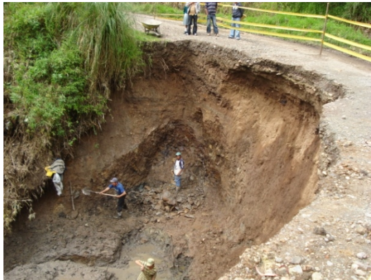
Figura 6. Realización de excavaciones.
