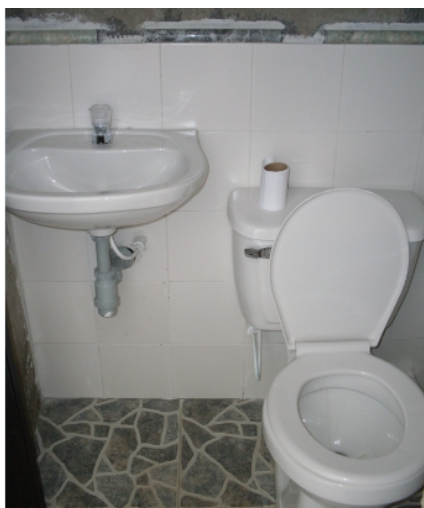
Figura 48. Sanitario y lavamanos instalados.
