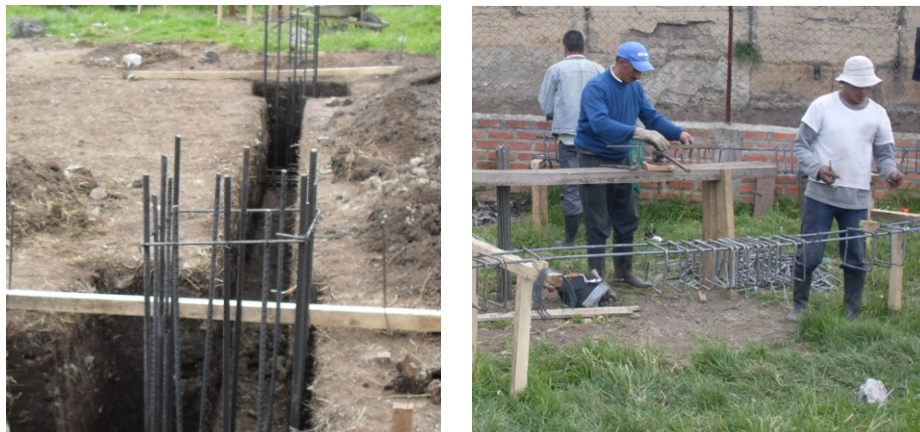
Figura 127. Viga de cimentación y armado de los herrajes de la cimentación.
