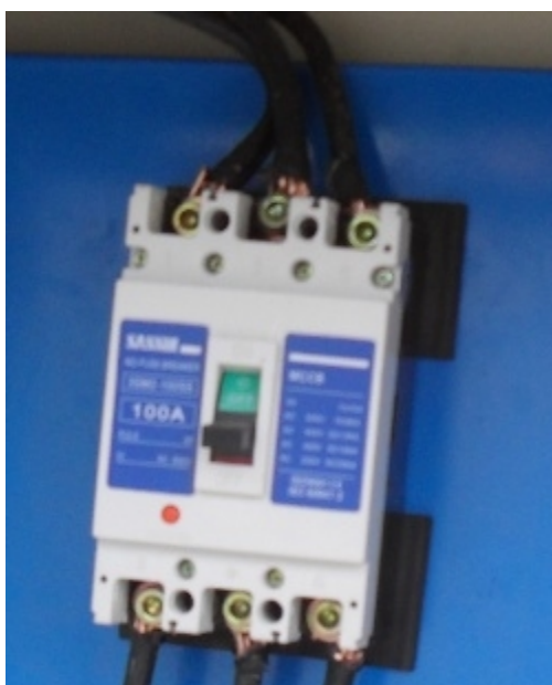
Figura 167. Instalación breaker general tripolar 100 A.
