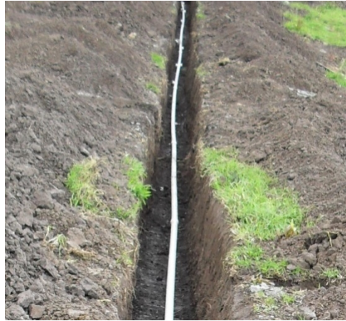
Figura 92. Extendido y acople de tubería de acueducto.
