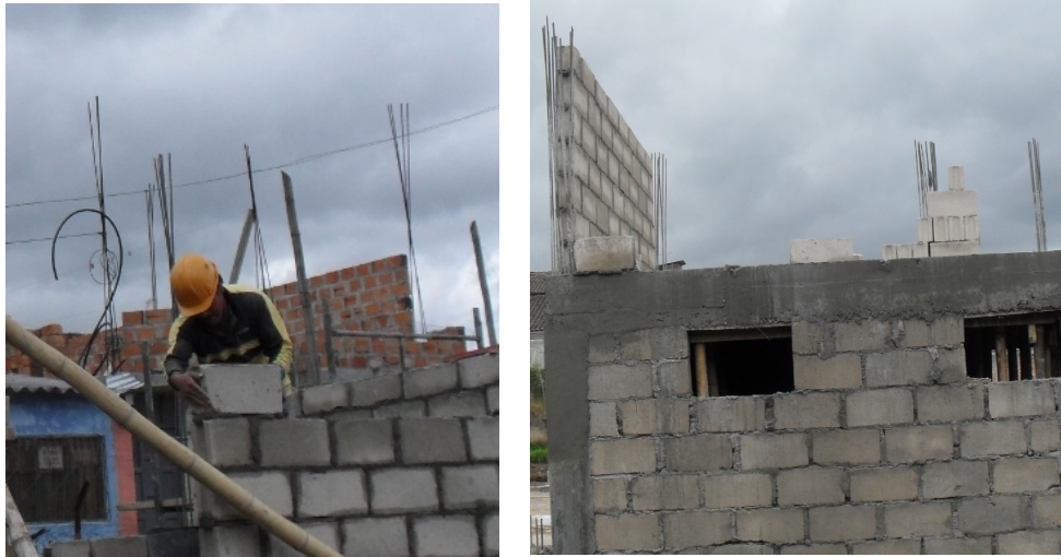
Figura 147. Construcción de muros de los cuartos.
