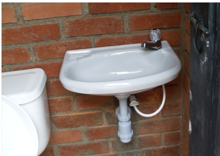
Figura 41. Instalación punto hidráulico \text{Ø} = 1/2'' .
