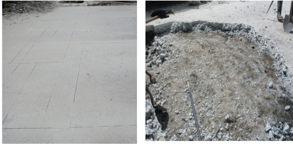
Figura 124. Demolición de placa.
