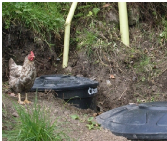
Figura 52. Tanque prefabricado que funciona como trampa de grasas.
