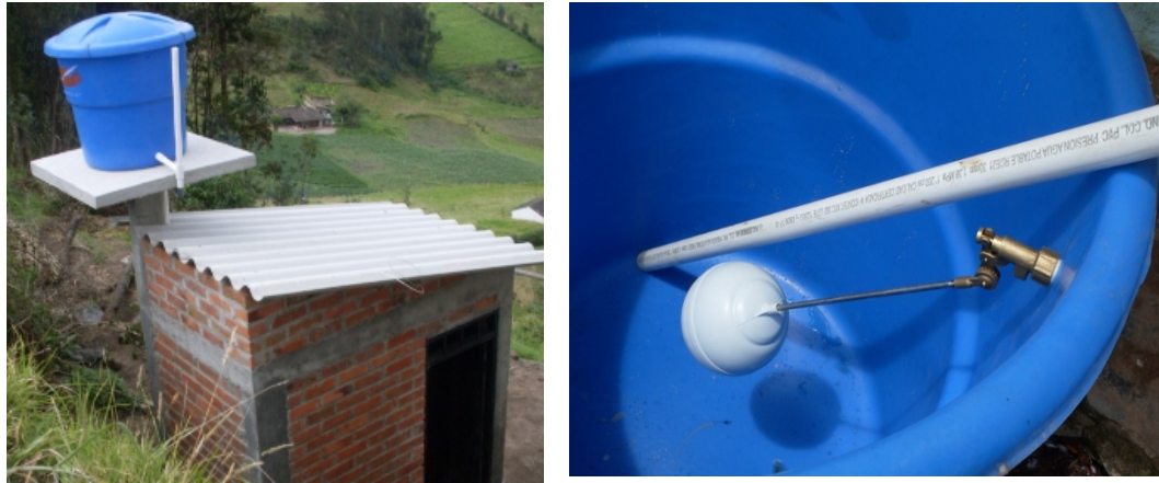
Figura 43. Instalación tanque de almacenamiento.
