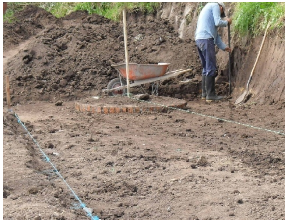
Figura 98. Excavación a mano.
