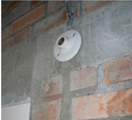
Figura 40. Instalación plafón cerámico para bombillo.
