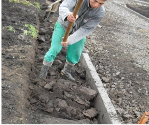
Figura 113. Excavaciones a mano para construcción de andenes.
