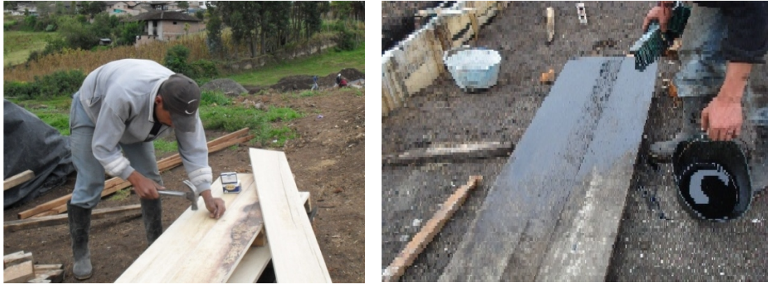
Figura 108. Elaboración y tratamiento de la formaleta.
