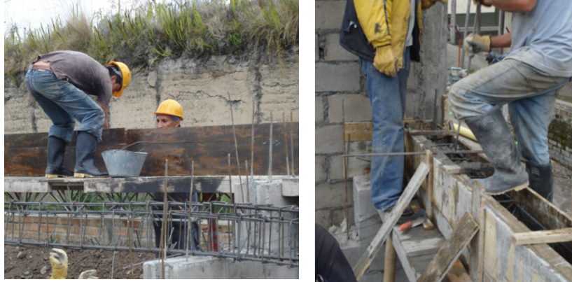
Figura 143. Instalación de los herrajes y fundición de vigas sector graderías.
