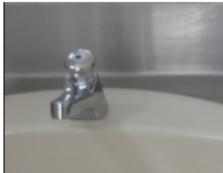
Figura 179. Instalación grifería lavamanos.
