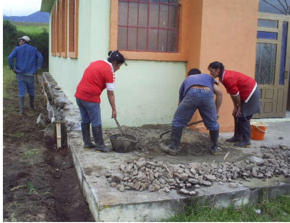
Figura 54. Arreglo de anden en la capilla de la vereda de loma redonda.
