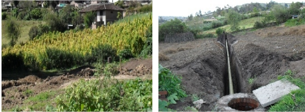
Figura 88. Sector de instalación del colector final de alcantarillado.
