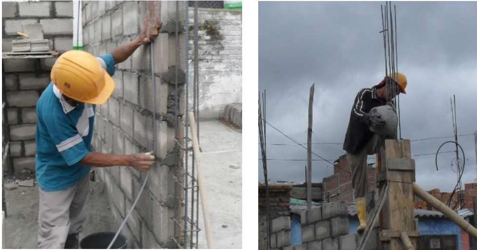
Figura 134. Construcción de columnetas en concreto reforzado.
