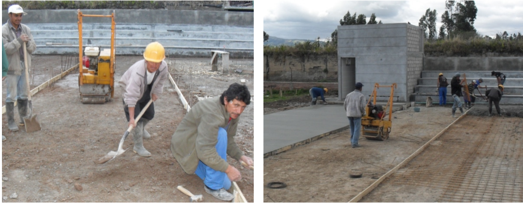
Figura 146. Construcción de los paños de la placa polideportiva.
