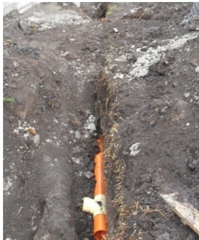
Figura 186. Instalación del colector de lluvias.
