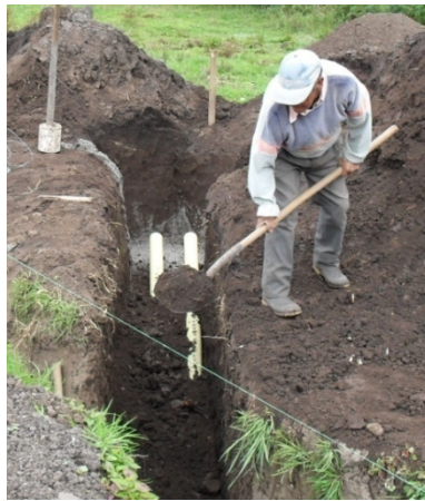
Figura 87. Relleno sobre tubería sanitaria, de instalación domiciliaria.
