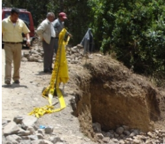
Figura 17. Excavación para muro.
