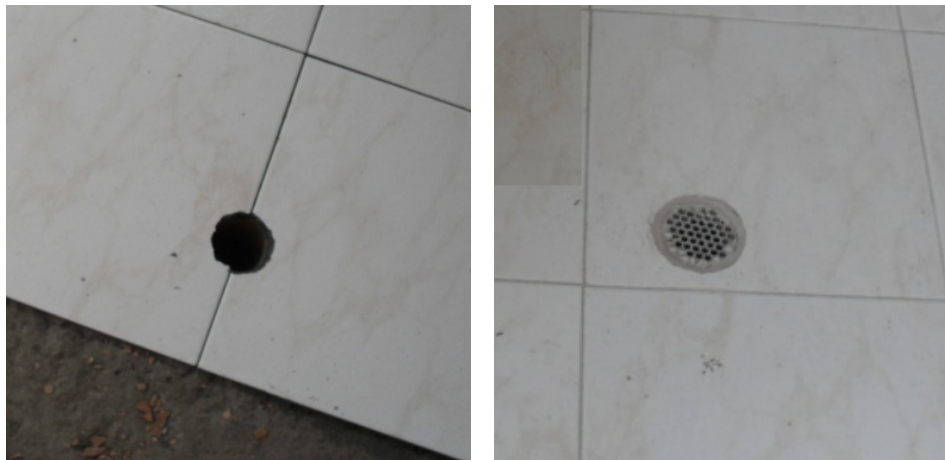
Figura 183. Instalación rejilla con sosco.
