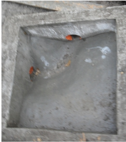
Figura 185. Construcción de caja de inspección de aguas lluvias.
