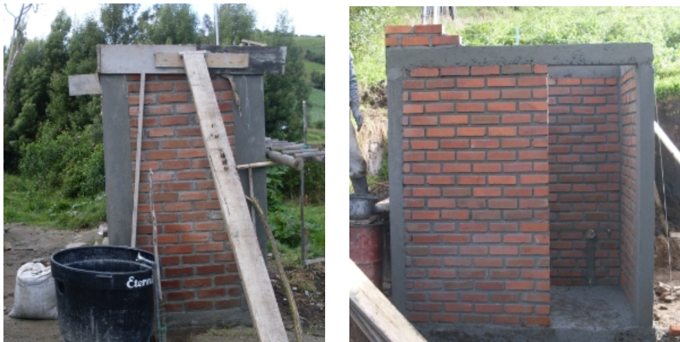
Figura 29. Vigas cintas en concreto reforzado.
