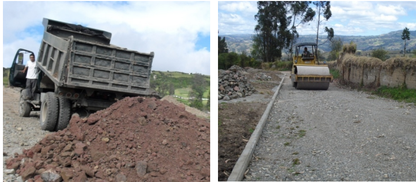
Figura 102. Vaciado del recebo sobre la calzada y compactación.
