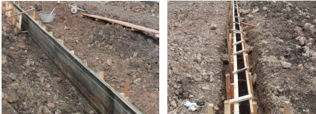
Figura 109. Instalación de la formaleta.
