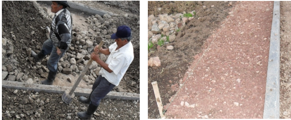
Figura 115. Base del andén en recebo compactado.
