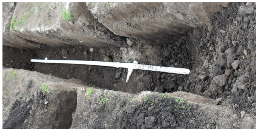
Figura 91. Relleno sobre excavación para instalación de tubería de acueducto.
