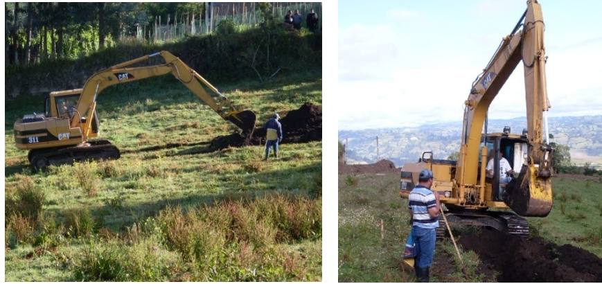
Figura 75. Excavación a máquina.
