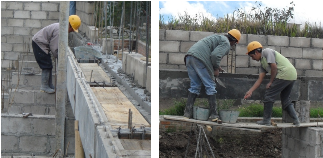
Figura 140. Instalación de las viguetas.
