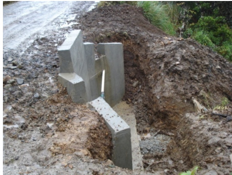
Figura 13. Alcantarilla terminada con su relleno instalado.
