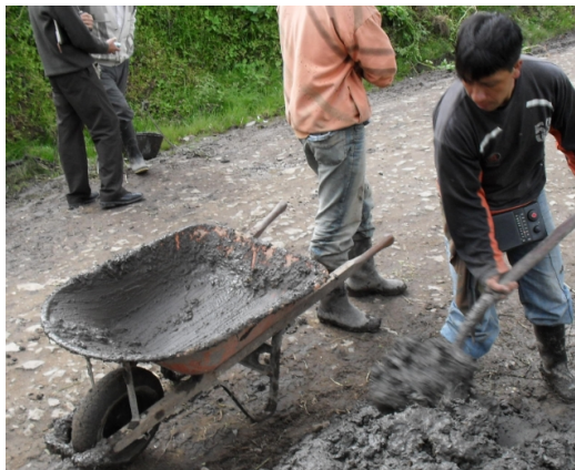
Figura 14. Retiro de sobrantes.
