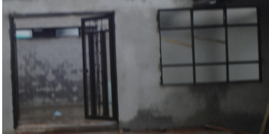
Figura 64. Instalación carpintería metálica.
