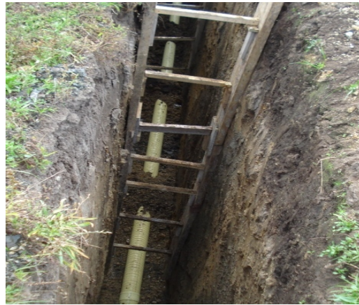
Figura 84. Instalación de tuberías de alcantarillado.
