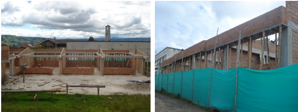
Figura 56. Estado de las obras al inicio de la 2ª etapa de construcción.
