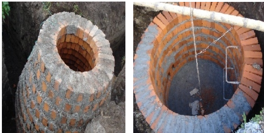
Figura 81. Construcción de cámaras.
