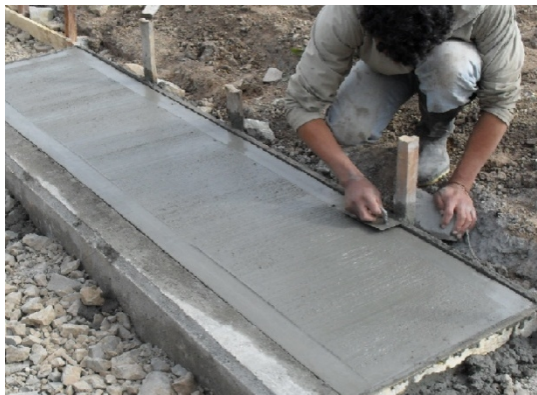
Figura 118. Terminación y embellecimiento de la placa de concreto.
