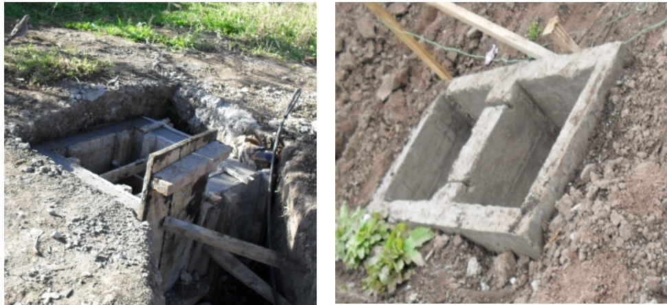
Figura 85. Construcción de cajilla de inspección.
