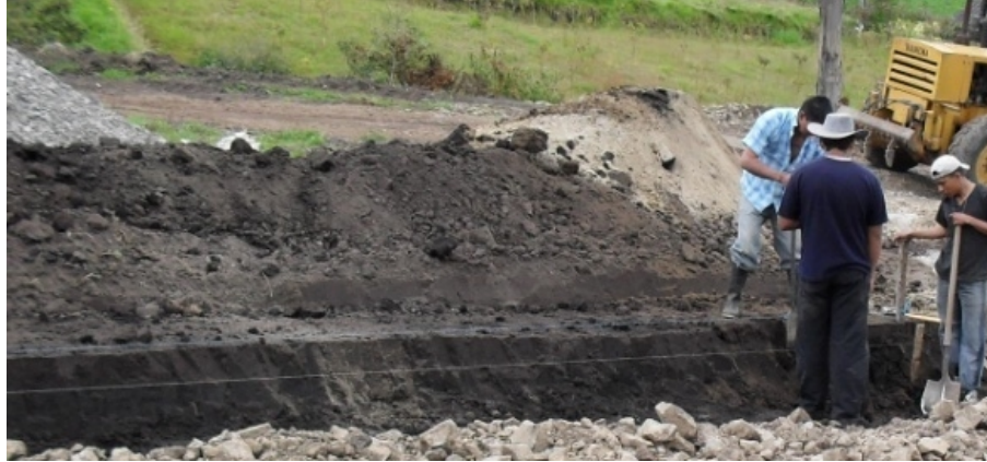
Figura 106. Desalojo de sobrantes a los costados de la vía.
