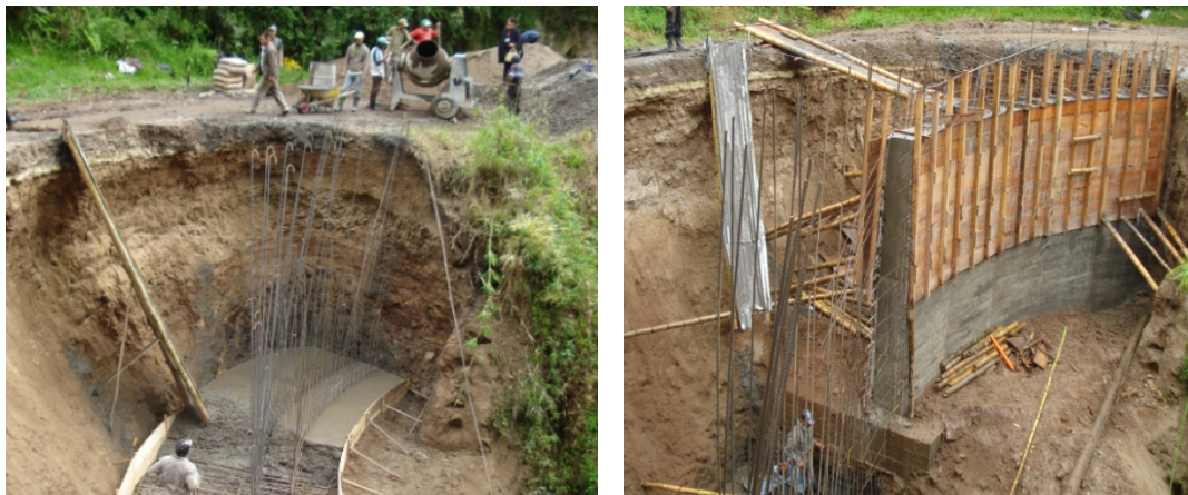
Figura 9. Fundición de las estructuras.
