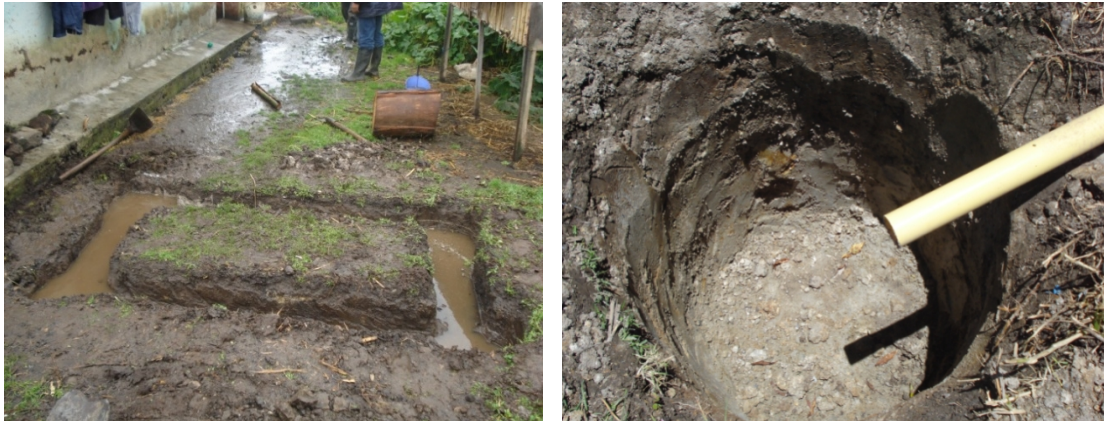
Figura 26. Excavación para cimentación y para instalación de tanques.
