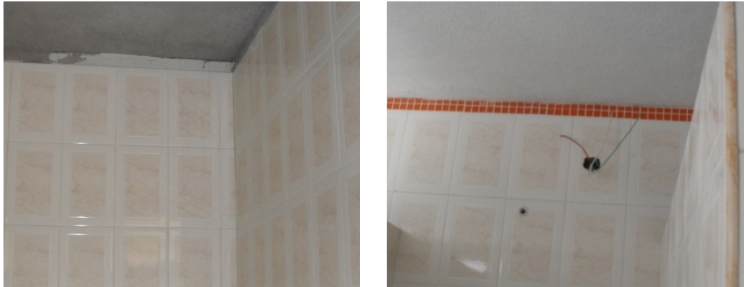
Figura 156. Enchape del sector interno de los cuartos.
