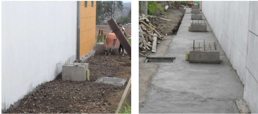
Figura 163. Relleno en recebo y construcción de andén en concreto.
