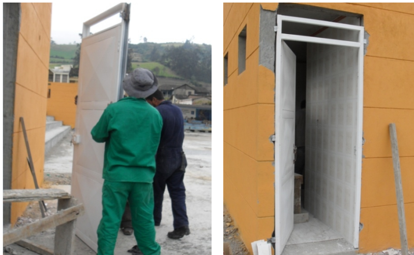
Figura 152. Instalación de puertas de acceso a los cuartos.
