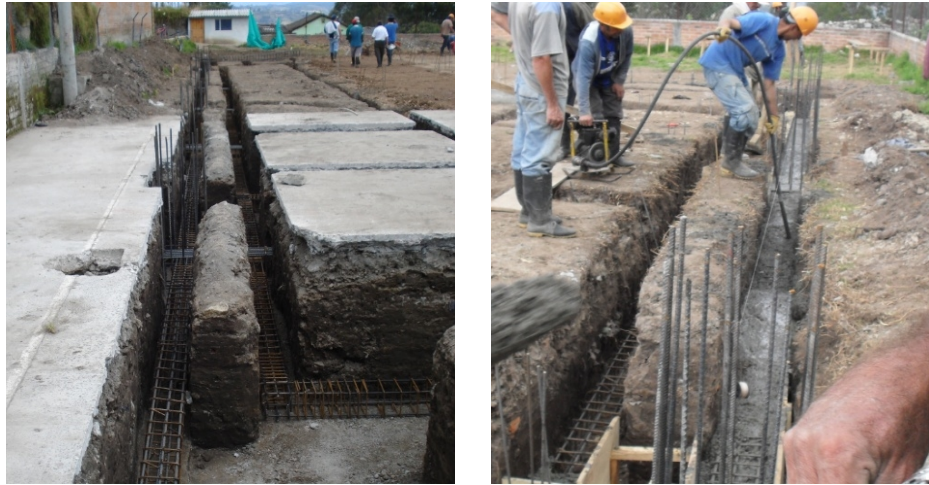
Figura 128. Instalación de castillos de las vigas y vibrado del concreto.
