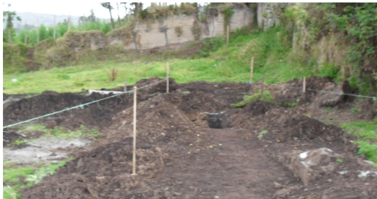
Figura 95. Localización para construcción de vías.
