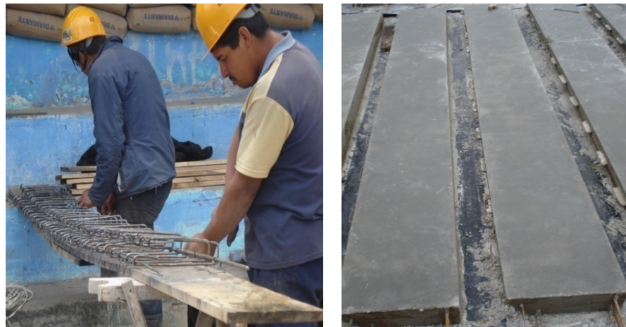
Figura 139. Fabricación de vigüetas.
