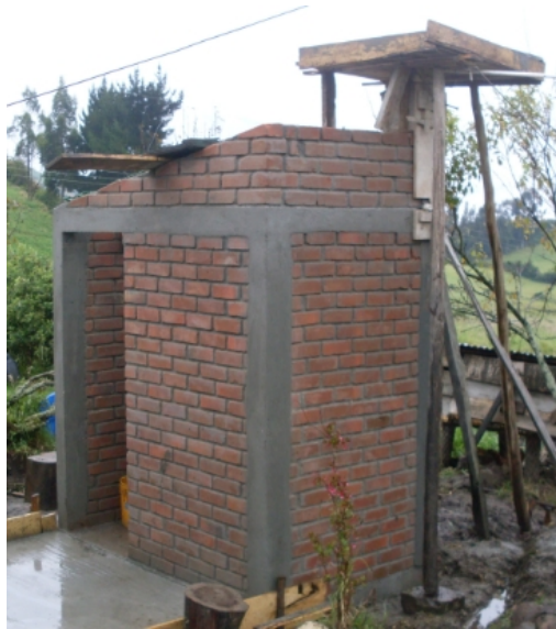
Figura 31. Formaleta para soporte tanque de reserva.
