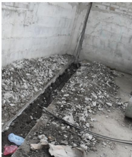
Figura 172. Instalación de acometida eléctrica.
