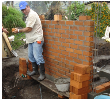
Figura 35. Construcción de muro de ladrillo.
