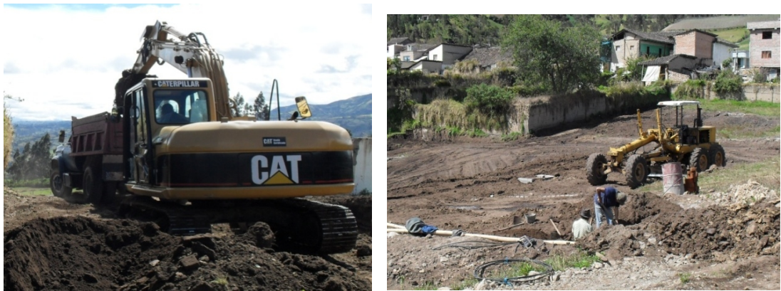
Figura 99. Relleno de calzadas de vías a construir.
