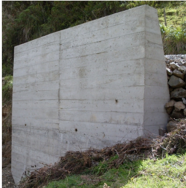
Figura 20. Estructura del muro en concreto.
