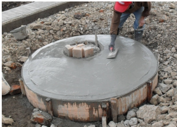
Figura 83. Fundición de la corona de cámara de inspección.
