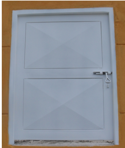
Figura 149. Puerta metálica de acceso a cuarto de tanques.
