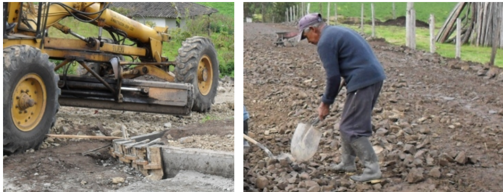
Figura 103. Extendido del material con máquina y a mano.
