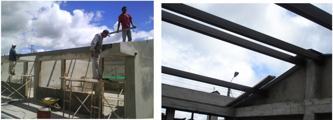
Figura 61. Instalación estructura metálica.
