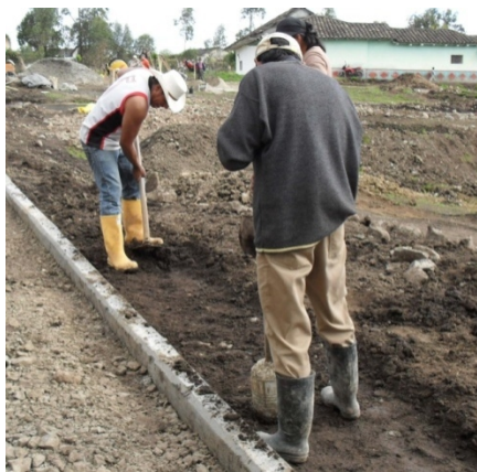
Figura 114. Relleno con material común.
