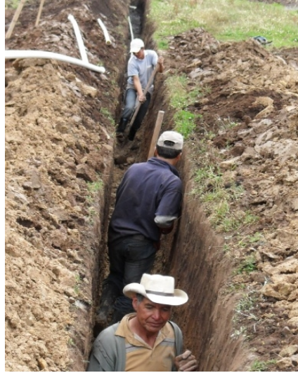
Figura 90. Excavación para instalación de tubería de acueducto.
