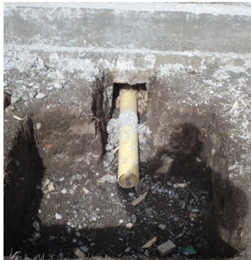
Figura 175. Instalación de tubería sanitaria.
