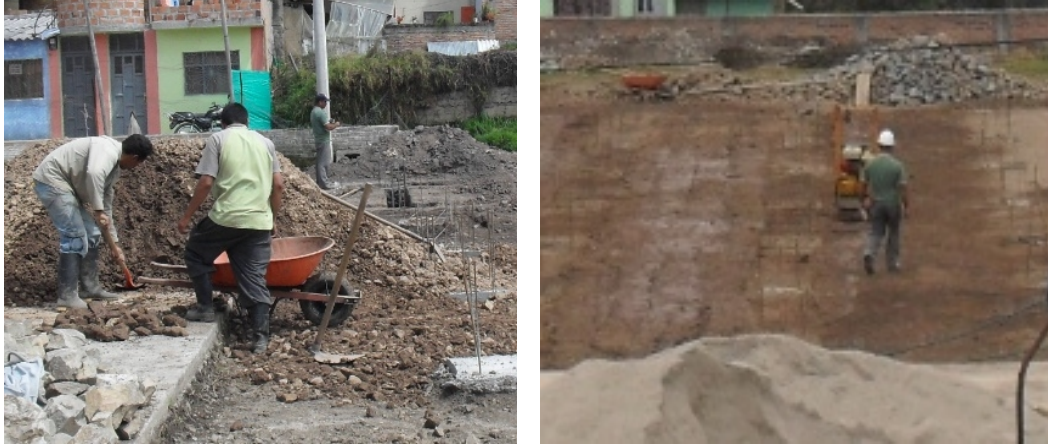
Figura 126. Selección del material y compactación del recebo.
