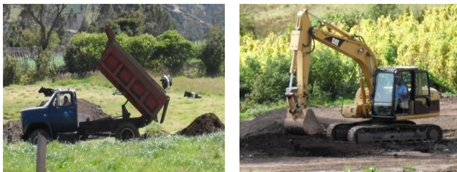
Figura 79. Retiro de sobrantes de las excavaciones.
