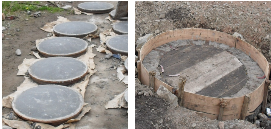
Figura 82. Construcción de tapas de las cámaras de inspección.
