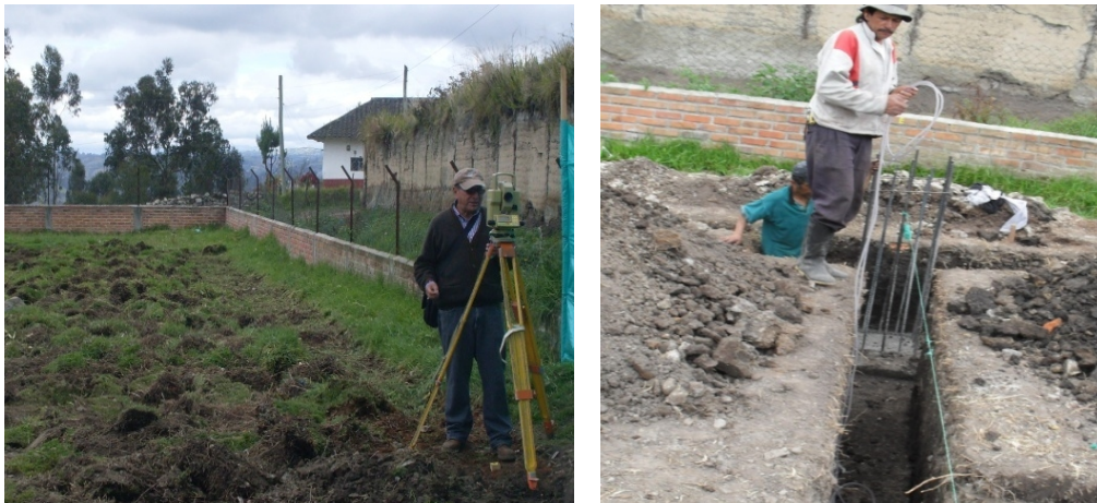
Figura 121. Localización y replanteo para ejecución de las obras.
