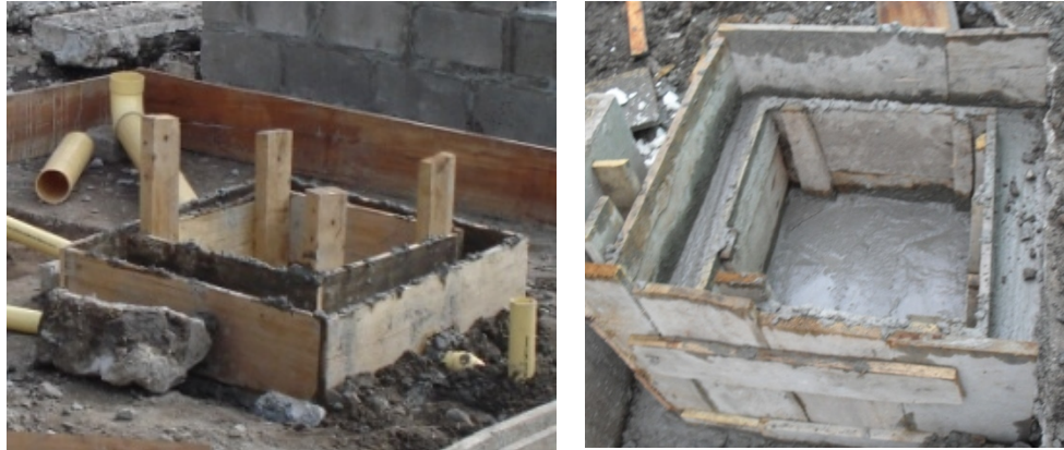
Figura 174. Construcción cajas de inspección sanitarias.
