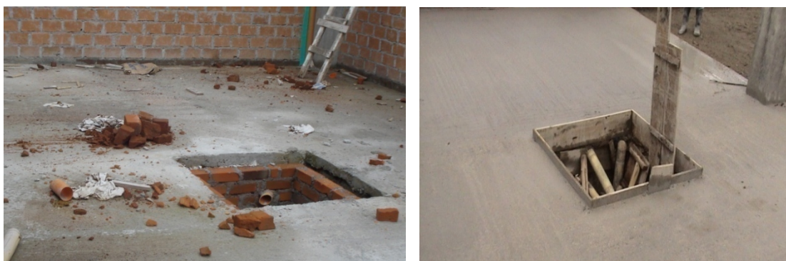
Figura 59. Afinado de piso y arreglo de cajilla.
