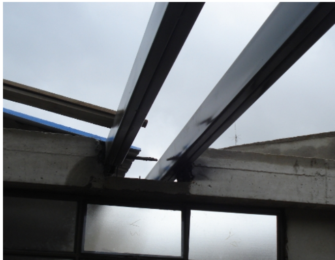
Figura 62. Correas en perfiles de lámina instalados y pintados.
