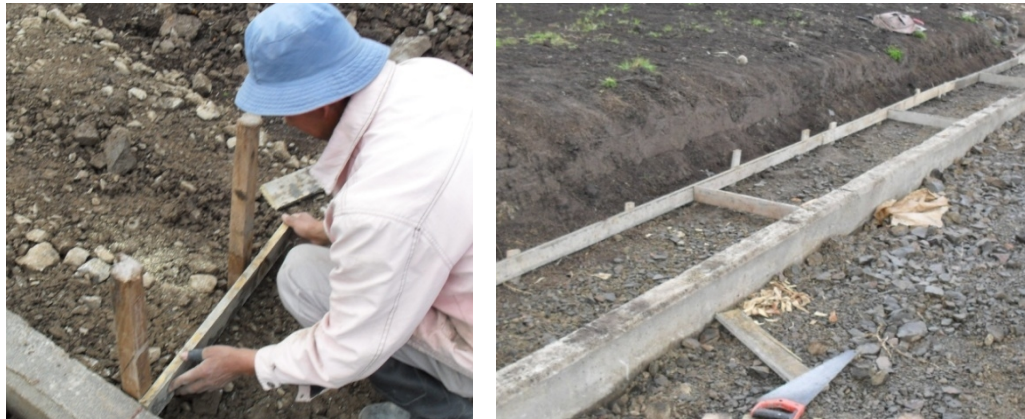
Figura 116. Instalación de la formaleta - Andenes.
