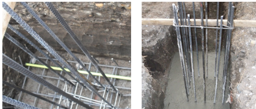
Figura 129. Instalación de castillos de las zapatas y pedestales.
