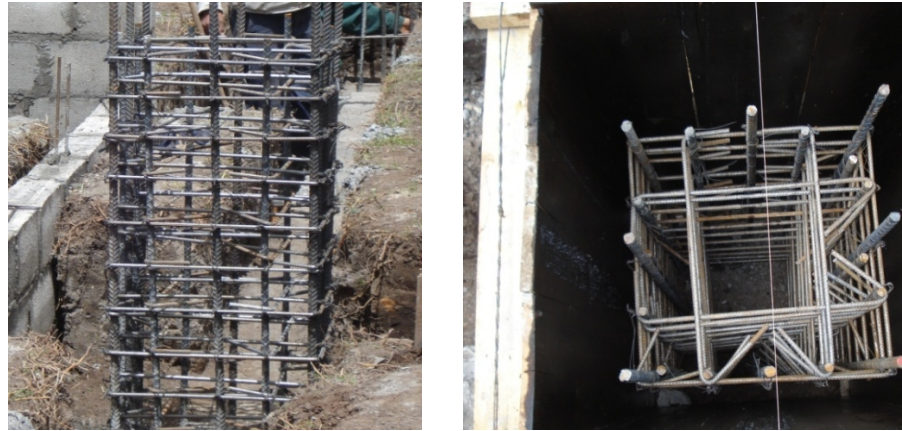
Figura 130. Herrajes de refuerzo e instalación de formaleta de pedestales.
