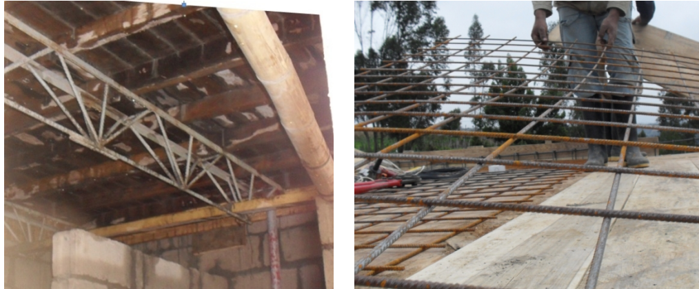
Figura 136. Formaleta y malla de acero de la placa aérea.
