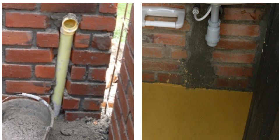
Figura 32. Instalación de punto sanitario de 2”.
