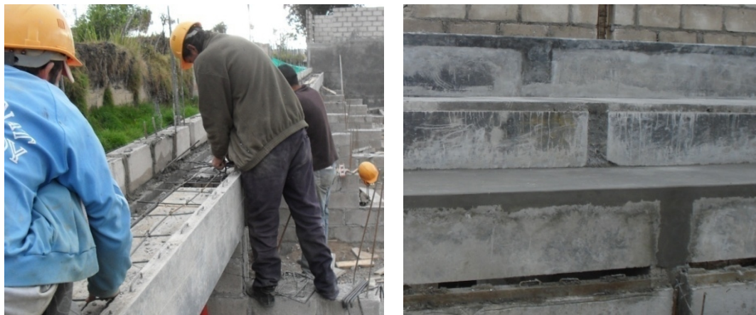
Figura 142. Armado de las estructuras y fundición de las huellas.
