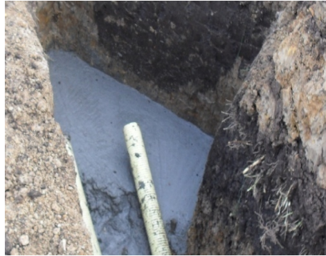
Figura 80. Cimentación en construcción de cajilla.
