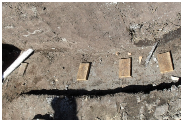
Figura 107. Cimiento del sardinel.
