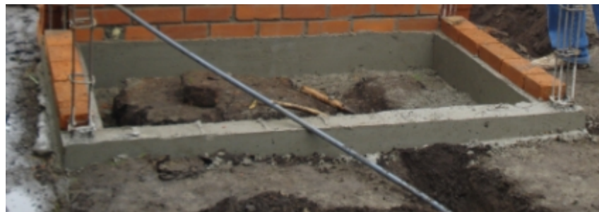
Figura 28. Viga de amarre de la cimentación.
