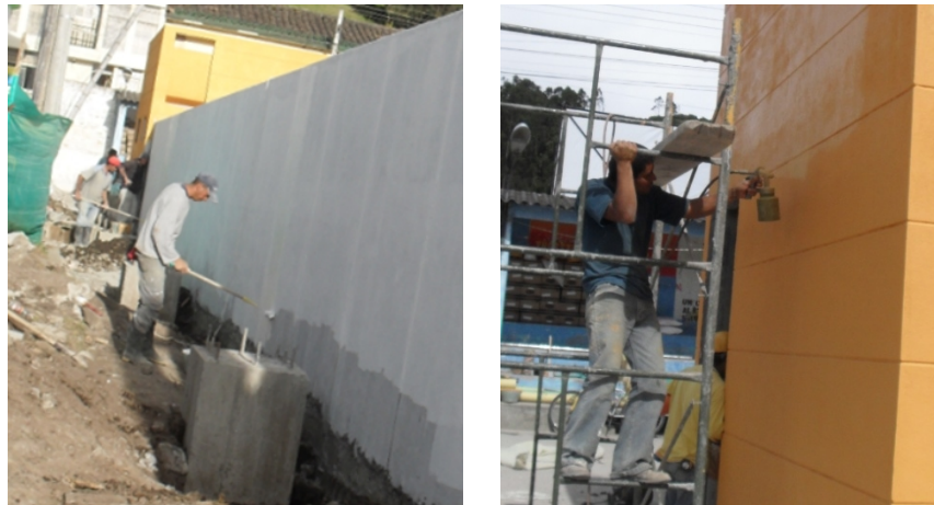
Figura 155. Aplicación de pintura sobre los muros.
