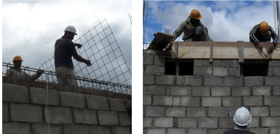
Figura 135. Construcción de vigas en concreto reforzado.
