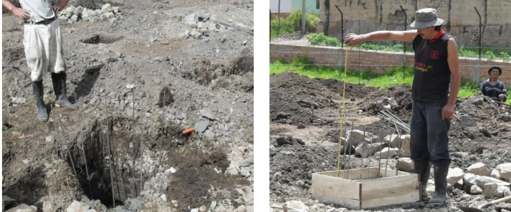
Figura 132. Construcción de bloques en concreto ciclópeo.
