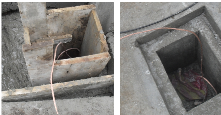
Figura 171. Instalación de puestas a tierra.
