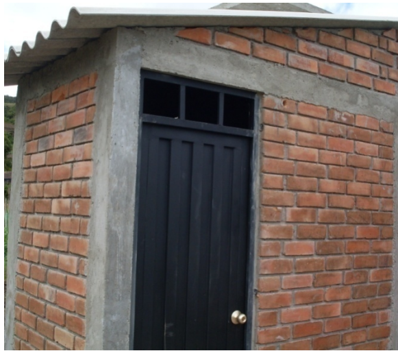
Figura 38. Puerta instalada en la edificación.
