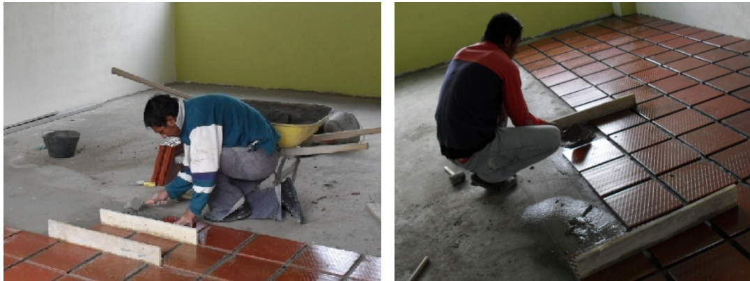
Figura 67. Instalación de piso en tableta de gres.
