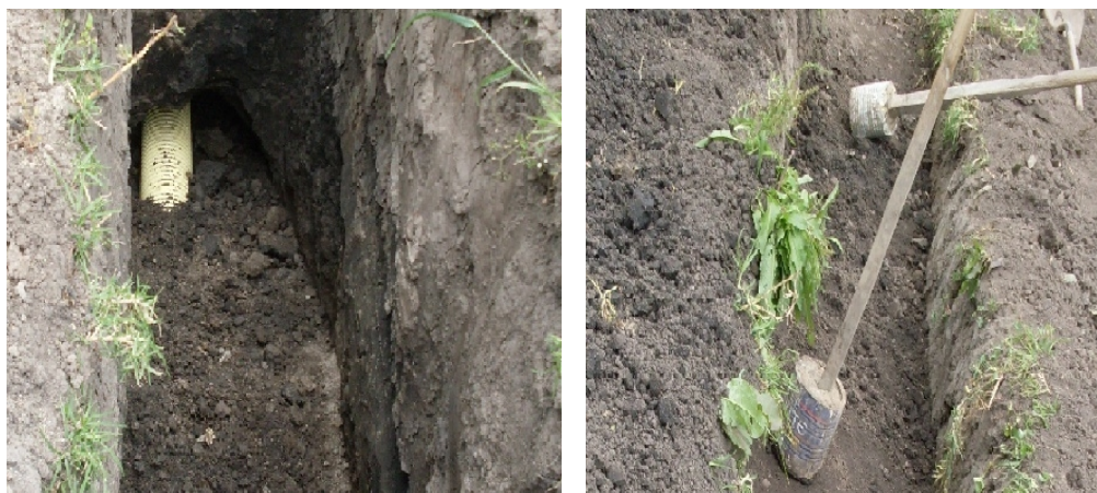
Figura 78. Relleno sobre las excavaciones.
