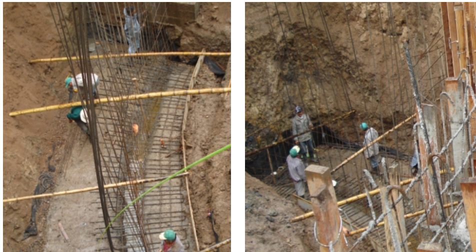
Figura 10. Armado de los herrajes de refuerzo.
