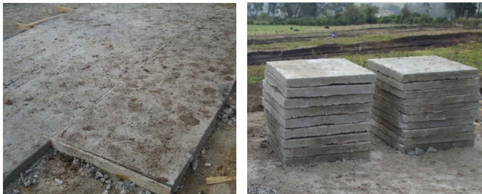
Figura 86. Construcción y almacenamiento de tapas de cajillas de inspección.
