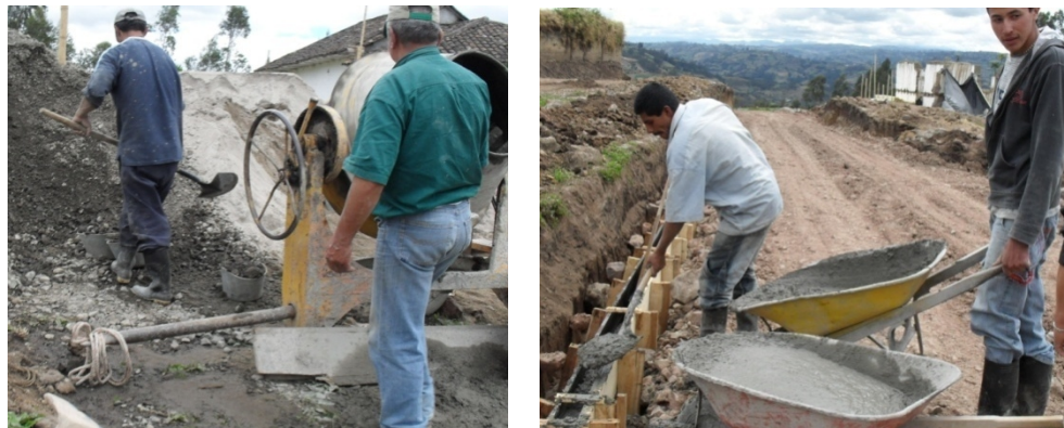
Figura 110. Elaboración y aplicación de la mezcla de concreto.
