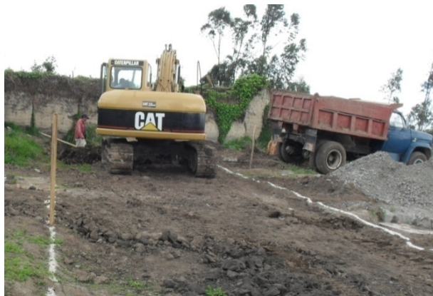
Figura 97. Excavación a máquina.
