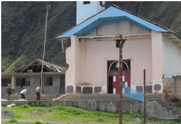
Figura 53. Arreglo de escalinata en la capilla del Corregimiento de San Mateo.
