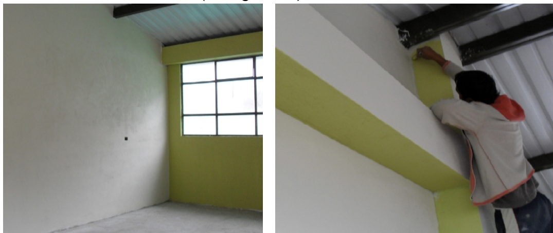
Figura 71. Aplicación de pintura.
