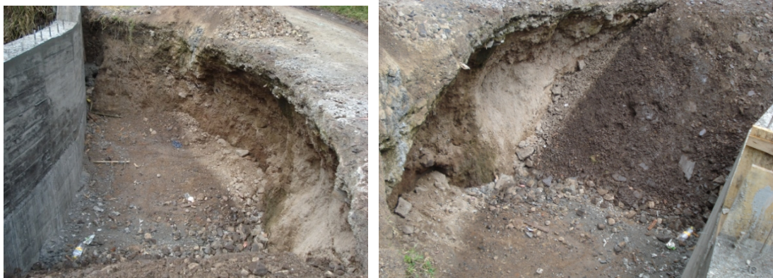
Figura 7. Realización de rellenos.
