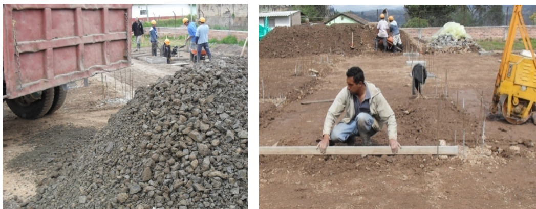
Figura 125. Acopio e instalación del recebo.
