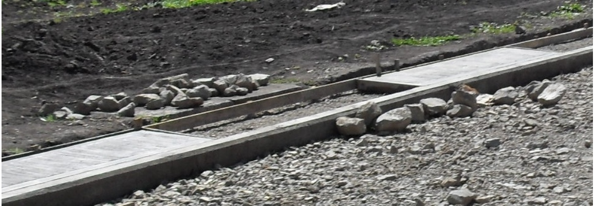
Figura 117. Placas de concreto.
