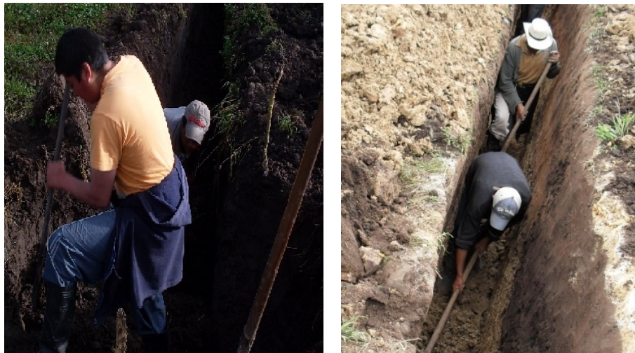
Figura 77. Excavaciones a mano.
