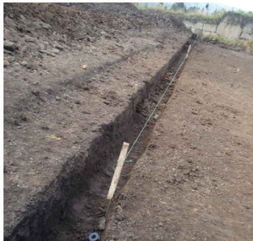
Figura 105. Excavación para sardineles.
