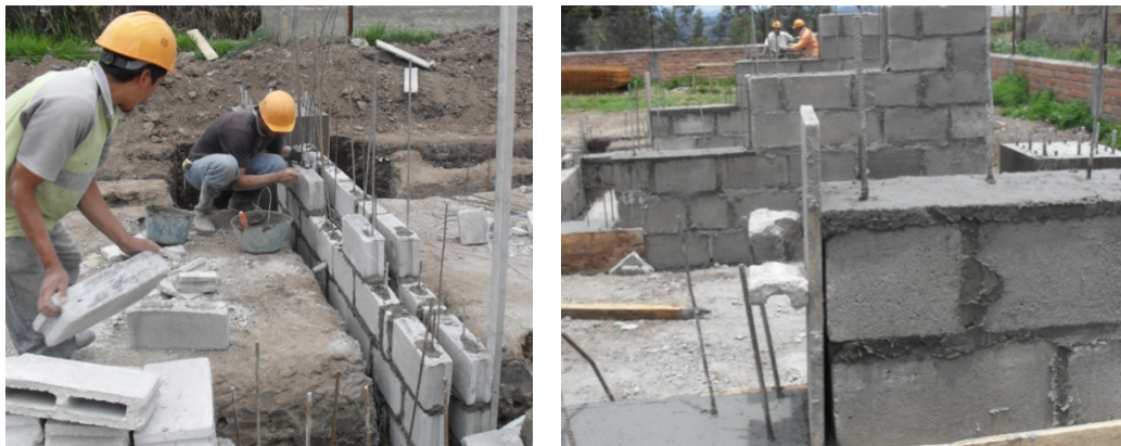
Figura 144. Construcción de muros cargueros.
