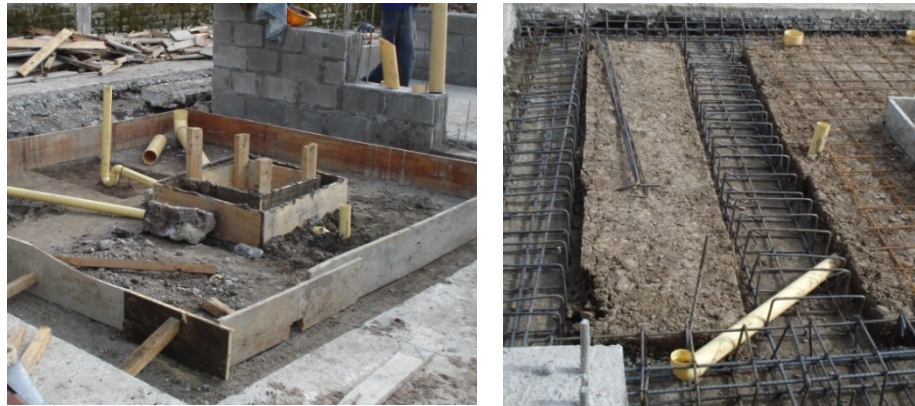
Figura 137. Formaleta, herrajes para estructura y relleno de la placa de contrapiso.
