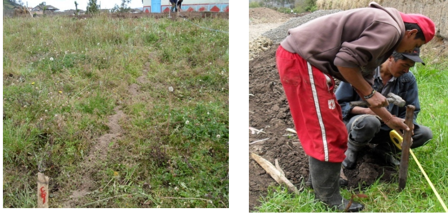
Figura 73. Localización y replanteo.
