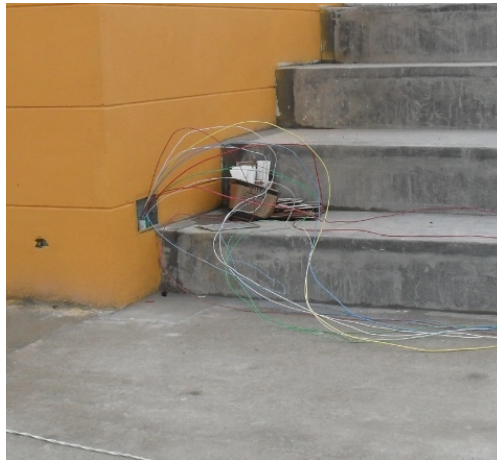
Figura 170. Instalación de cables para lámparas.
