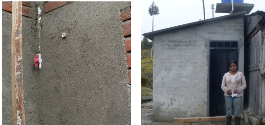
Figura 36. Pañete sobre muros.
