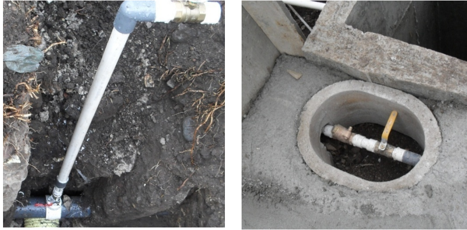
Figura 182. Instalación acometida de agua potable en tubería PVC \varnothing = 1'' .
