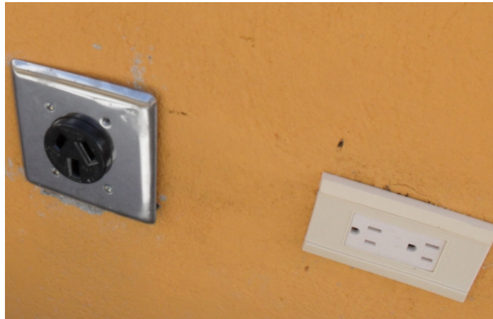
Figura 173. Instalación tomas de sonido.
