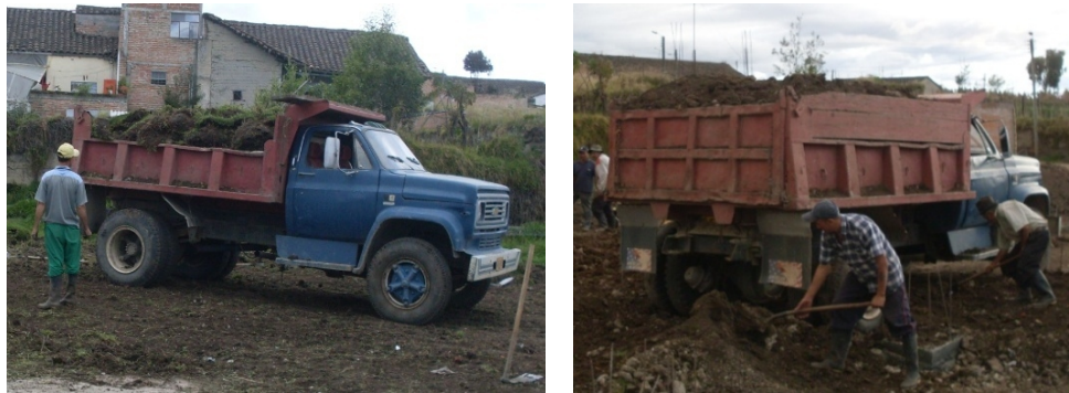
Figura 123. Cargue de materiales a retirar.
