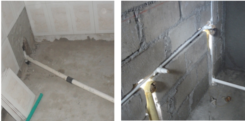
Figura 181. Instalación red de suministro.
