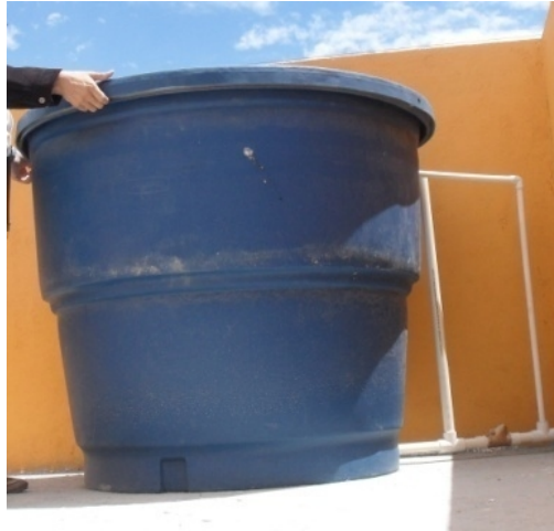
Figura 180. Instalación tanque de almacenamiento.
