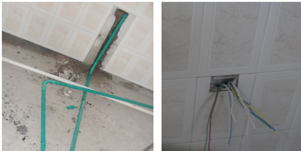
Figura 164. Instalación de ductos y cables eléctricos.
