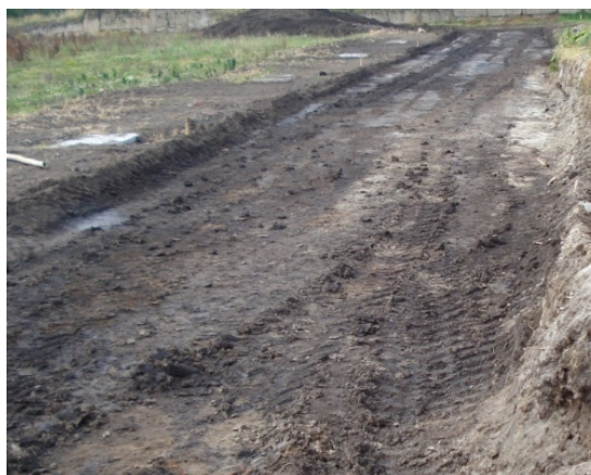
Figura 112. Desmonte y limpieza - andenes.
