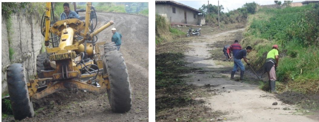
Figura 23. Limpieza de cunetas.
