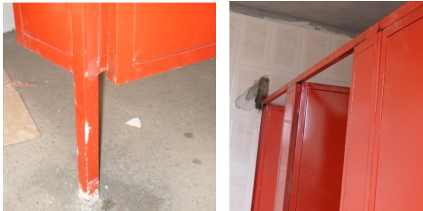
Figura 157. Instalación de las divisiones en lámina metálica.
