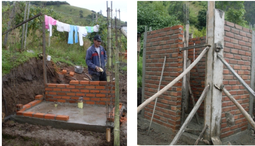
Figura 30. Columnetas en concreto reforzado.
