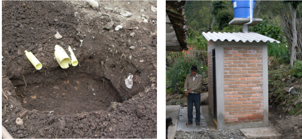
Figura 51. Construcción cajilla sanitaria.
