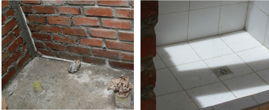
Figura 34. Instalación de rejilla de 3 X 2”.
