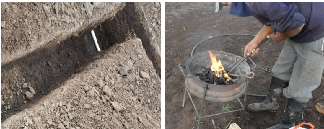
Figura 93. Excavación para instalación de acometida y parrilla para calentar la varilla perforadora.
