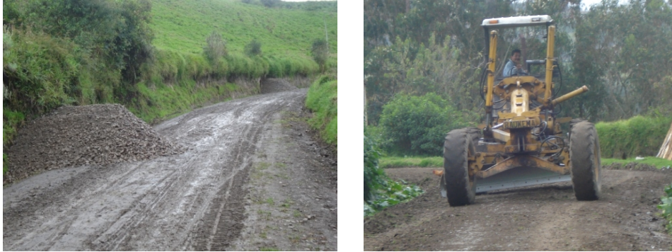
Figura 21. Acordonamiento y extendido del recebo.
