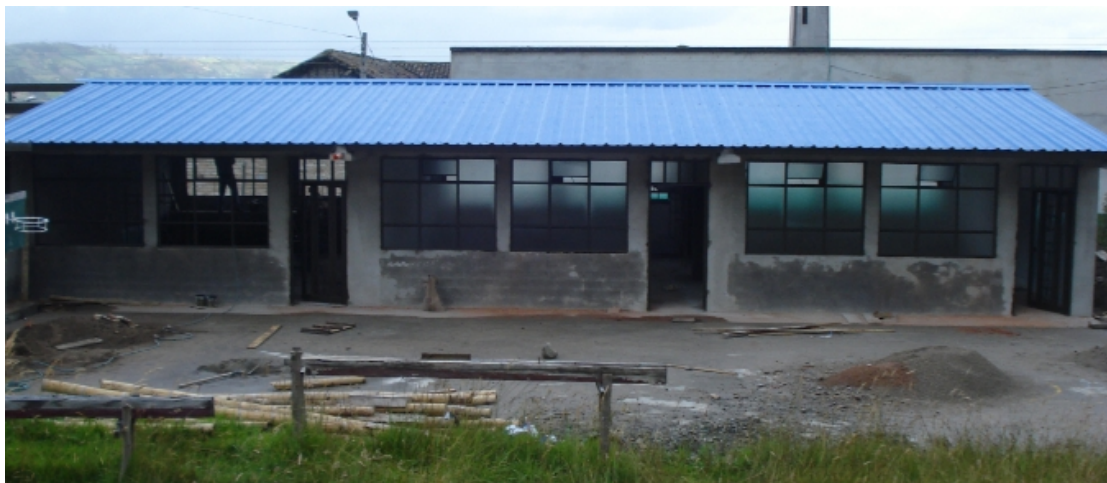
Figura 63. Instalación cubierta termoacústica.
