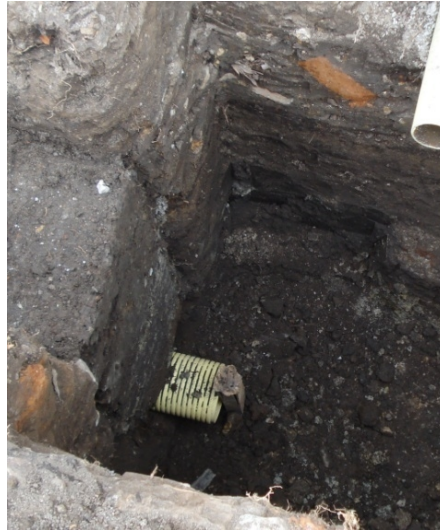
Figura 176. Instalación de tubería PVC novafort de \varnothing = 6'' .
