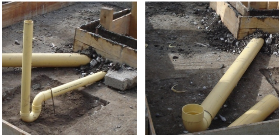
Figura 177. Instalación tubería y accesorios, puntos de desagüe de \varnothing = 2'' y \varnothing = 4'' .
