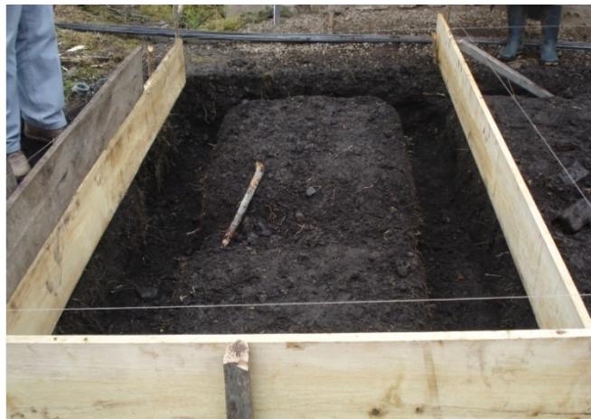
Figura 25. Localización e instalación de formaleta.
