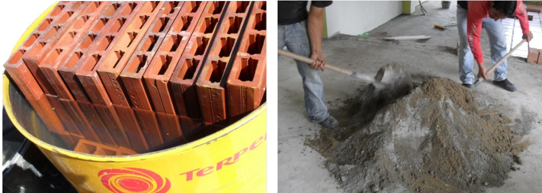
Figura 66. Tableta de gres y mezcla de mortero para instalación de piso.
