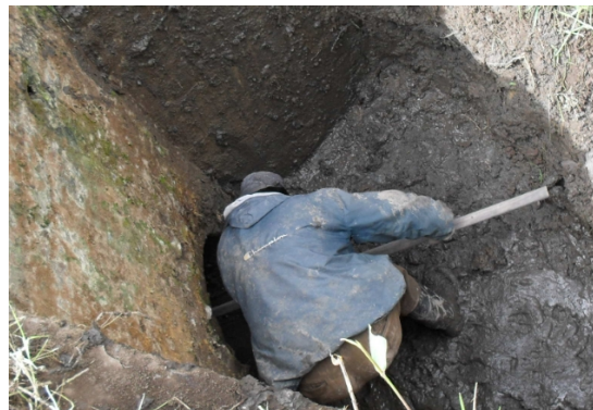
Figura 22. Trabajador limpiando la alcantarilla, con la utilización de un azadón.
