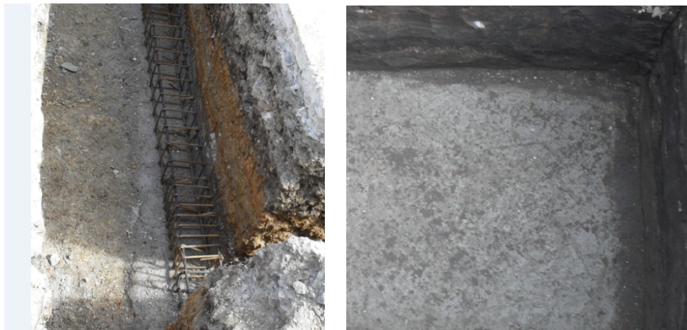
Figura 133. Solados en concreto pobre.
