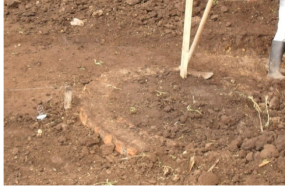
Figura 100. Cámara que se tapa para realizar los trabajos a máquina.
