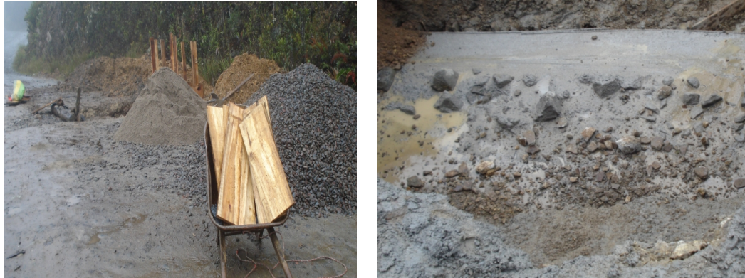
Figura 15. Acopio de materiales y fundición de la estructura de alcantarilla.
