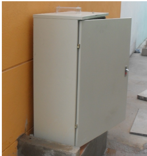
Figura 165. Instalación de gabinete donde se instalan los controles eléctricos.
