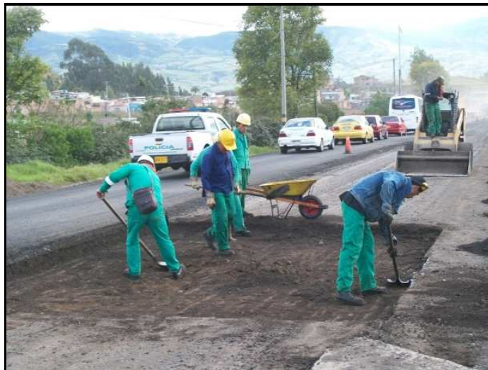
Figura 16. TRAYECTO 3 MEJORAMIENTO SUBRASANTE K78+300
