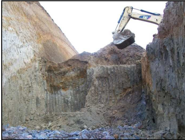
Figura 28. TERYECTO 5A. EXCAVACION K4+480
