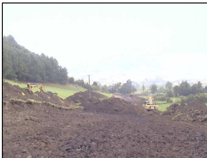
Figura 27. TRAYECTO 5A. DESMONTE Y LIMPIEZA K4+200
