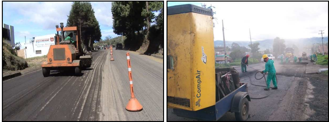
Figura 19. TRAYECTO 3 LIMPIEZA VÍA K76+000
