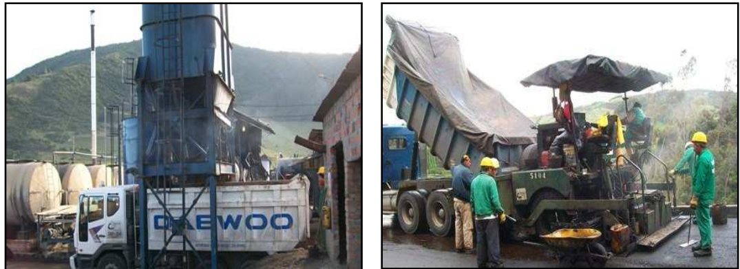
Figura 61. DESCARGUE E INSTALACION DE MEZCLA.
