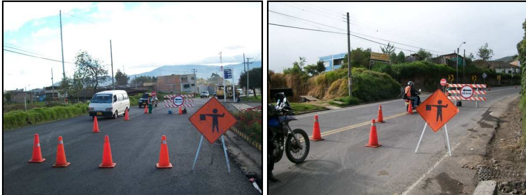
Figura 14. TRAYECTO 3 SEÑALIZACION ZONA DE TRABAJO K78+020
