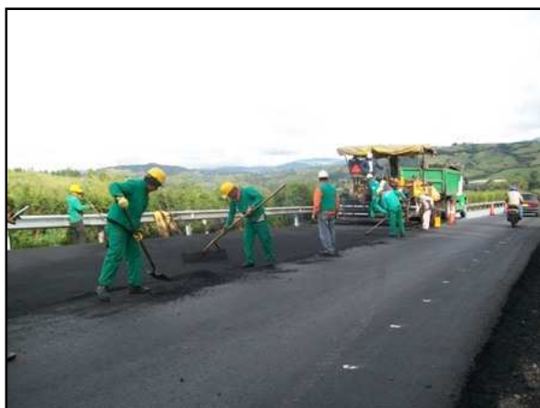
Figura 13. TRAYECTO 3 CUADRILLA PAVIMENTO K72+020
