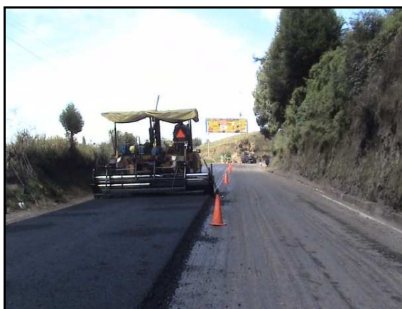
Figura 12. TRAYECTO 3 INSTALACION CARPETA ASFALTICA K74+370
