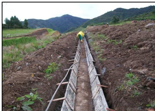
Figura 30. TERYECTO 5A. OBRAS DE DRENAJE K4+320
