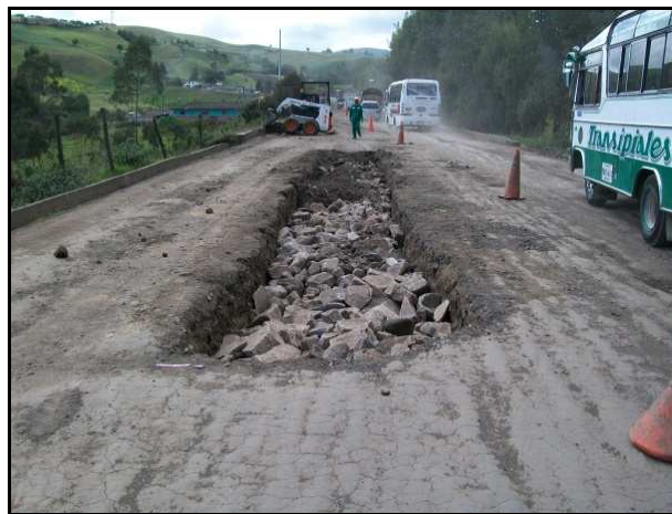
Figura 17. TRAYECTO 3 MEJORAMIENTO SUBRASANTE K73+100
