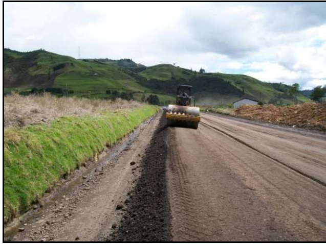
Figura 36. TRAYECTO 5A. COMPACTACION K3+160
