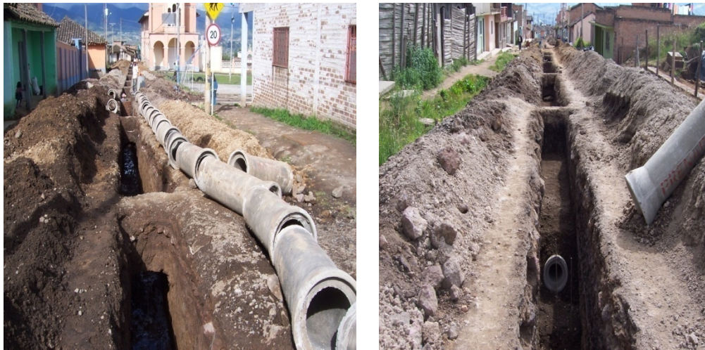
Figura 57. Instalación de tubería de = 10" sector Jongovito
