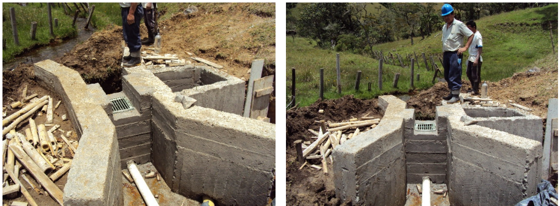
Figura 16. Vista general acabado bocatoma.
