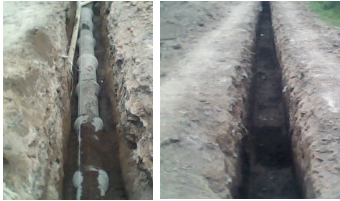
Figura 51. Relleno de la tubería alcantarillado Sanitario.
