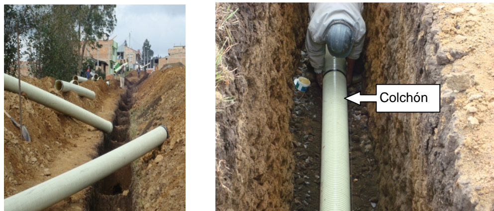
Figura 41. Instalación de tubería alcantarillado - sector San Martin
