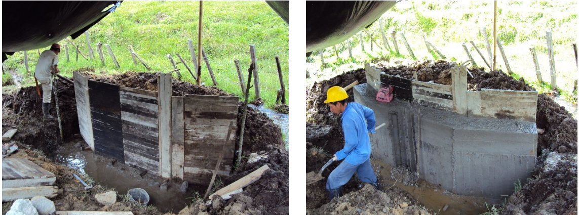
Figura 15. Formateo y acabado de muros laterales en bocatoma.
