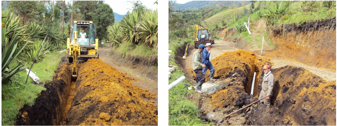
Figura 10. Excavación a maquina para tubería en vías.
