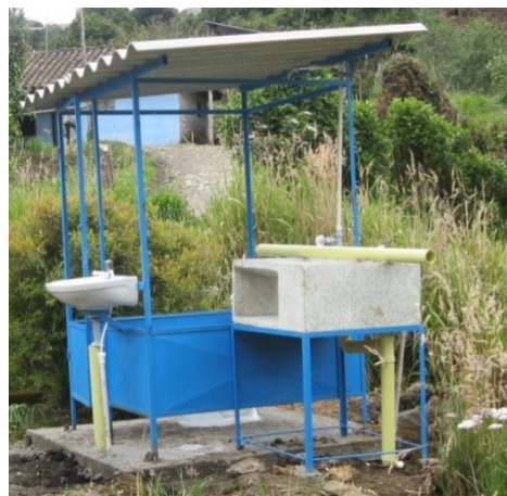
Figura 37. Caseta sanitaria instalada.
