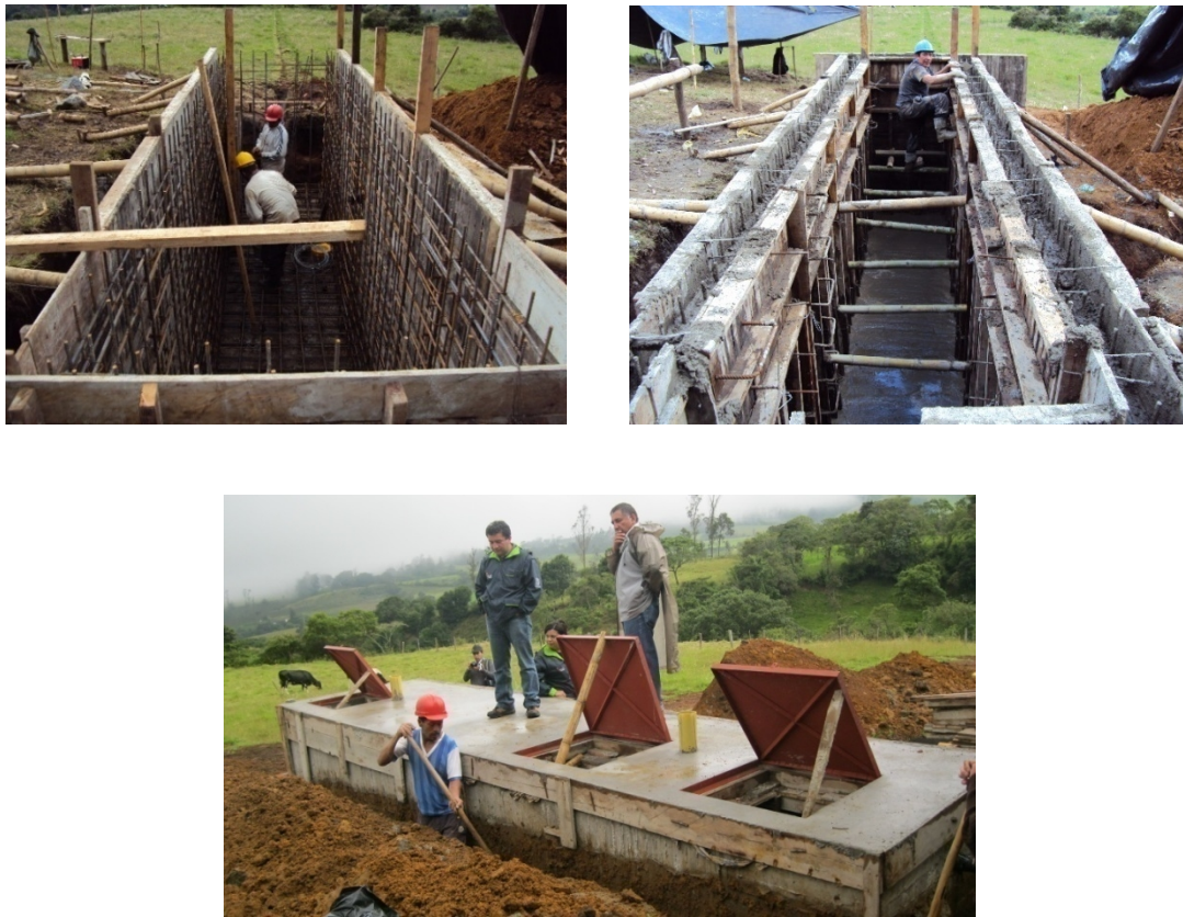
Figura 14. Armado, formateo lateral y terminado del desarenador
