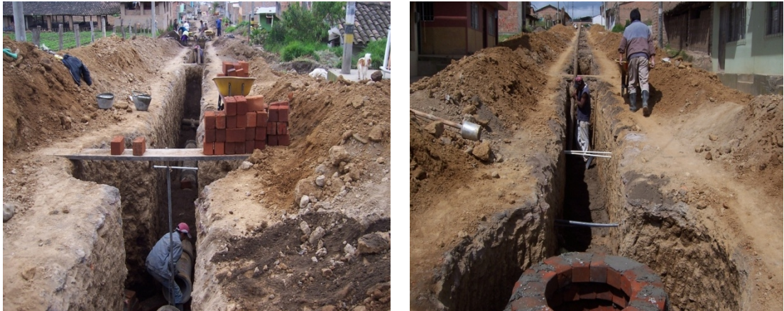
Figura 58. Construcción de cámaras de inspección
