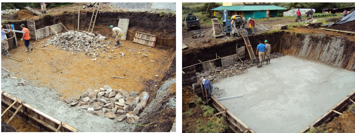
Figura 4. Fundición solado del tanque
