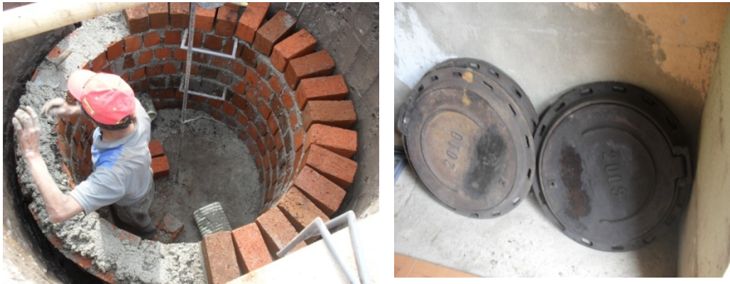
Figura 44. Construcción de cámaras del alcantarillado
