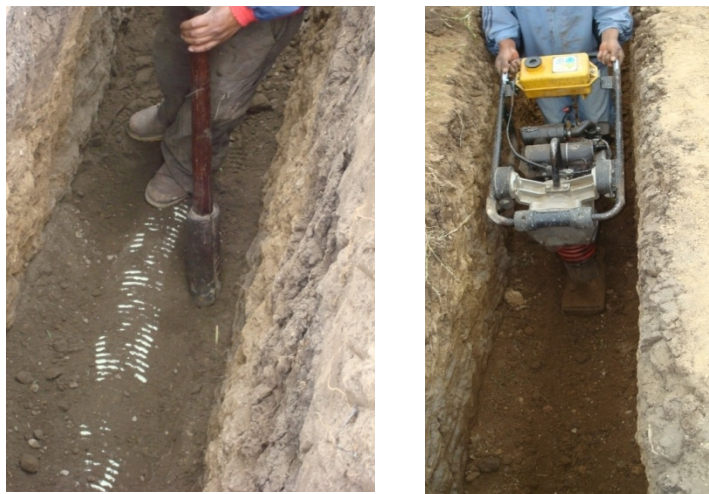
Figura 43. Compactación de rellenos.
