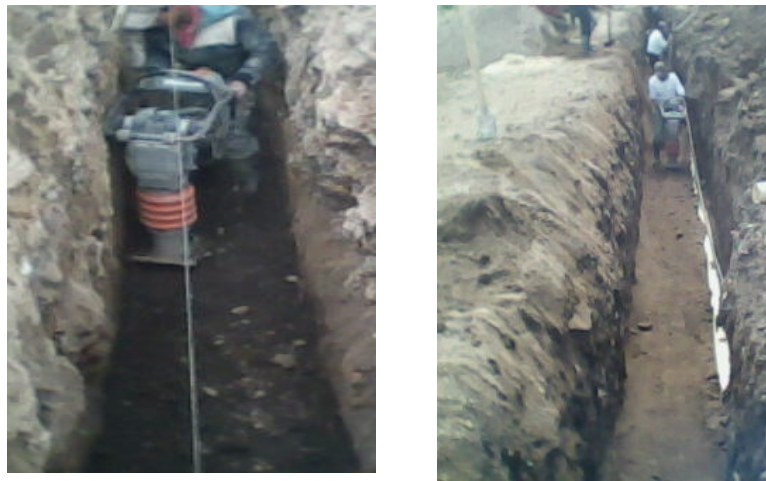
Figura 48. Compactación del colchón
