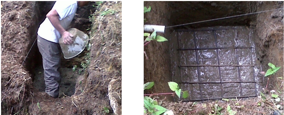
Figura 21. Solado y parrilla de la zapata de viaductos en concreto.
