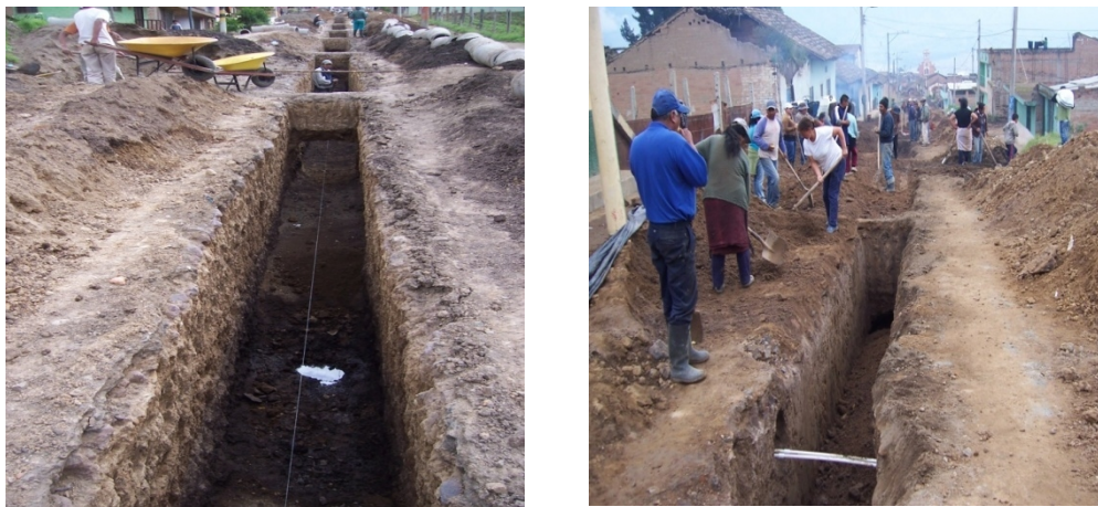
Figura 56. Excavaciones alcantarillado pluvial sector Jongovito
