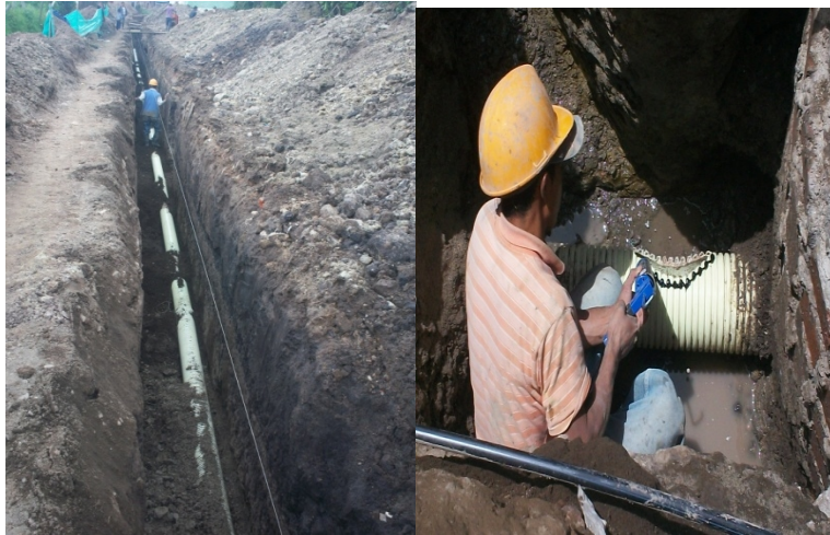
Figura 50. Instalación de tubería PVC (k0+238.86 hasta la k0+97.26)
