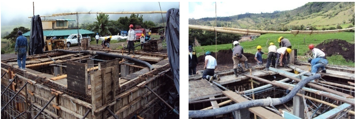
Figura 9. Fundición placa superior del tanque de almacenamiento
