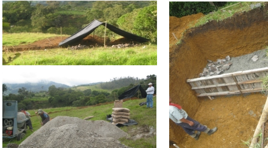
Figura 13. Concreto ciclópeo desarenador
