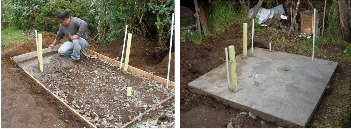
Figura 33. Losa de base para la caseta sanitaria.
