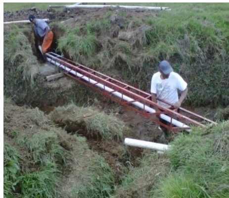
Figura 26. Instalación en sitio de estructura en celosía (6 y 7m)
