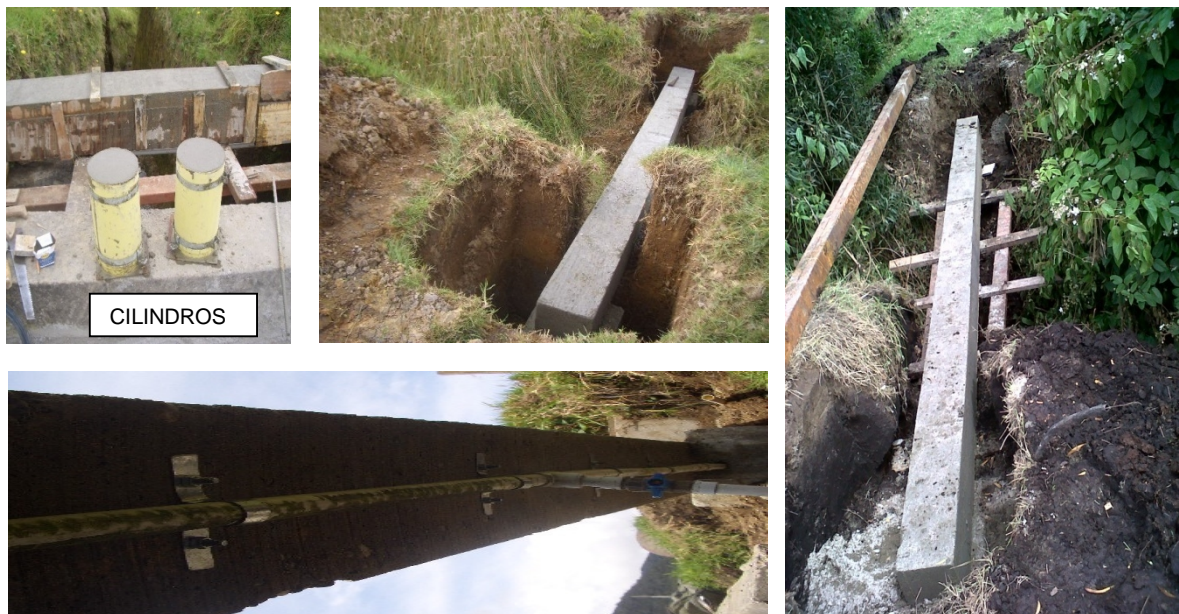
Figura 24. Terminados de los viaductos en concreto
