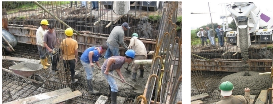
Figura 7. Fundición con mixer placa de piso y muros laterales.
