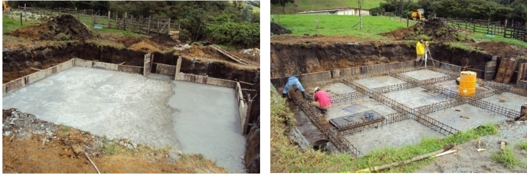
Figura 5. Acabado del solado y armado de las vigas de cimentacion
