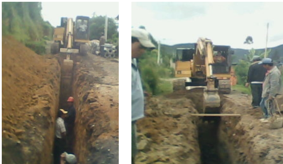
Figura 47. Excavación a maquina alcantarillado sector Pejendino Reyes
