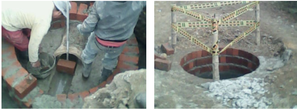
Figura 52. Construcción de cámaras y señalización de seguridad
