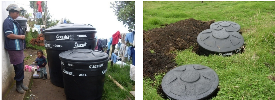
Figura 35. Instalación de tanques.
