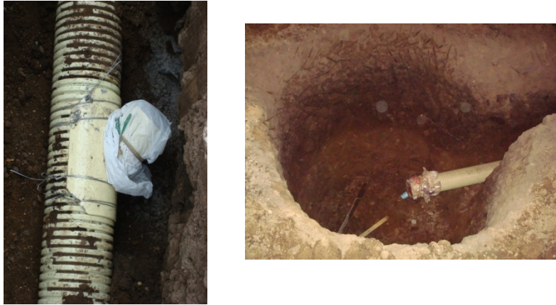
Figura 42. Caballete (con reducción de 8" a 6") y protección de la tubería.
