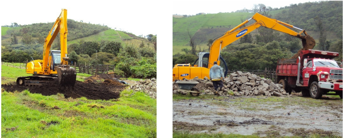
Figura 3. Excavación con retroexcavadora para tanque de almacenamiento
