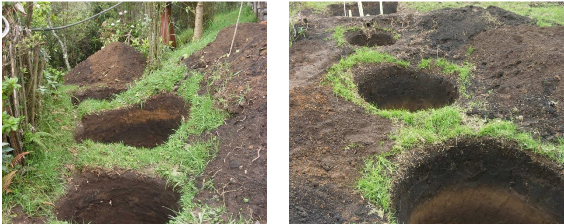
Figura 34. Excavación para instalación de tanques plásticos
