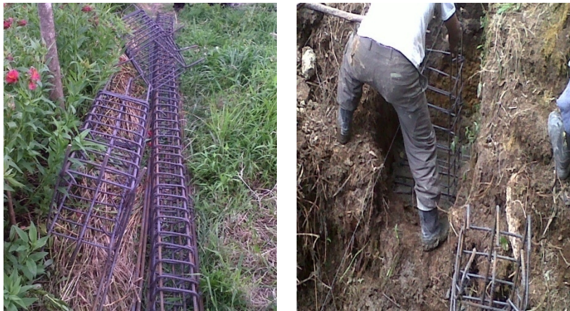
Figura 22. Armado de columnas en viaductos de concreto.
