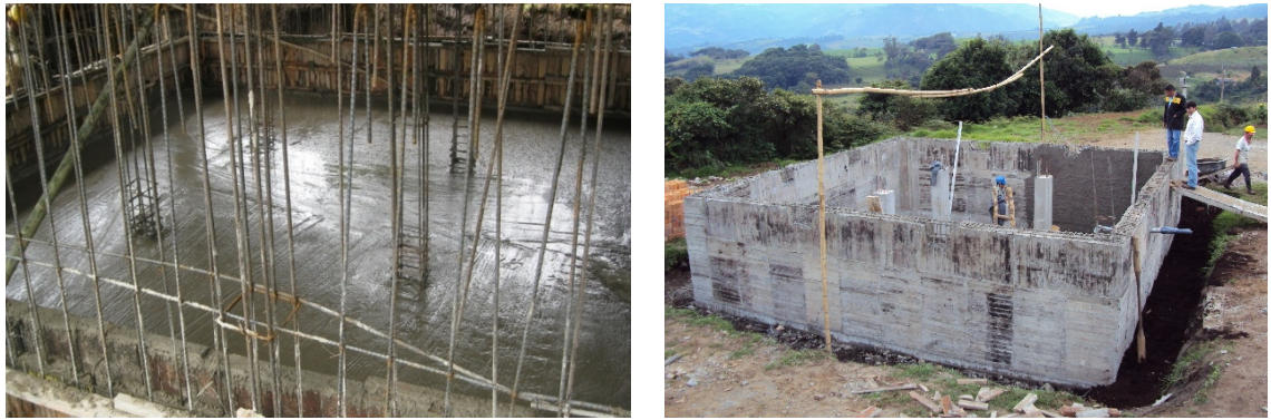
Figura 8. Terminados tanto del piso, de los muros laterales y columnas internas.
