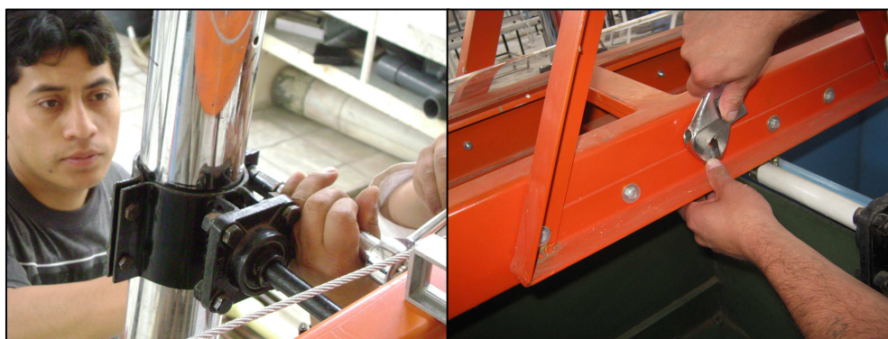
Figura 10. Aseguramiento de partes del montaje.
