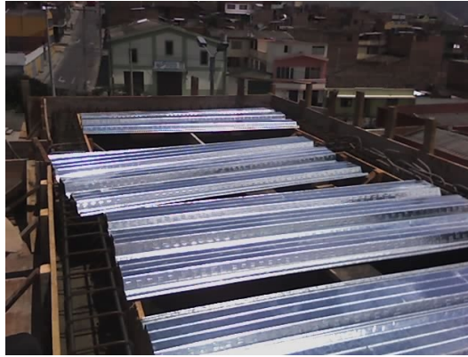
Ilustración 60. Instalación de metaldeck sobre los tableros
