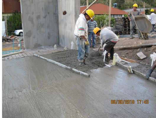
Ilustración 30. Fundición de losa de contrapiso.
