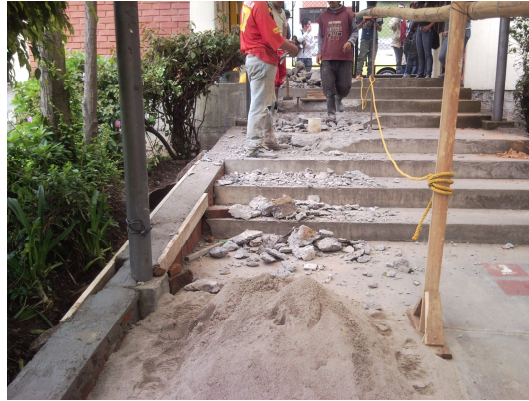
Ilustración 67. Demolición de peldaños y colocación de bordillos en ladrillo común
