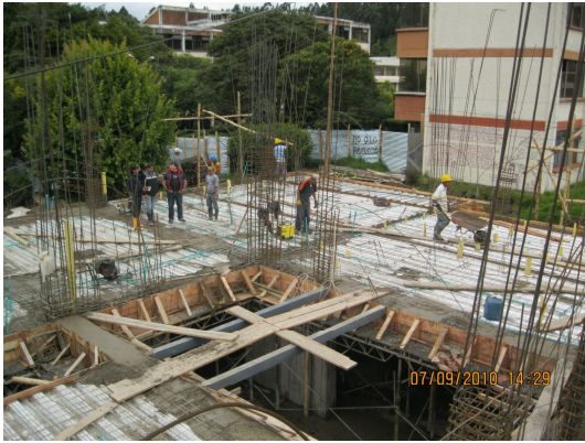
Ilustración 48. Fundición de vigas Aéreas en la placa N+6.00.
