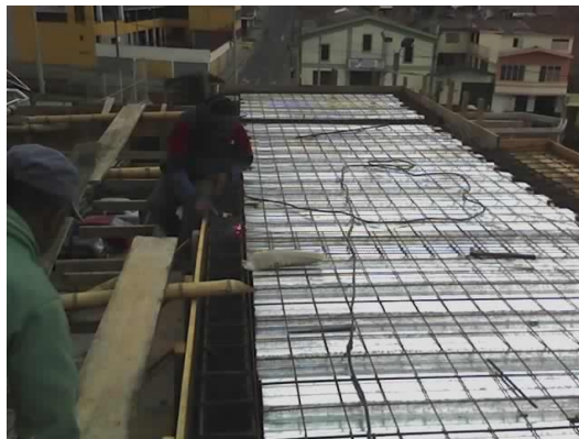
Ilustración 61. Instalación de la malla electrosoldada sobre el metaldeck.
