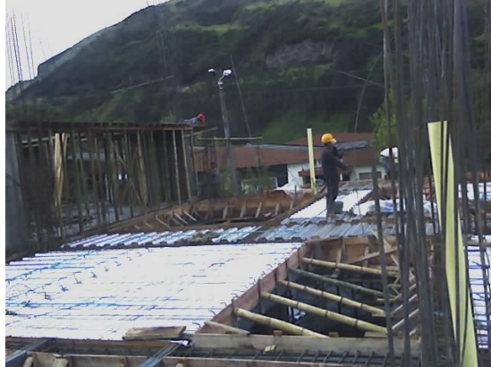
Ilustración 34. Instalación del metaldeck en la losa N+3.00
