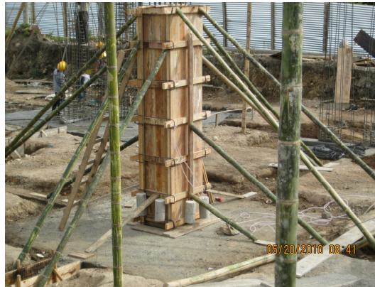
Ilustración 25. Encofrado de columna L-2.
