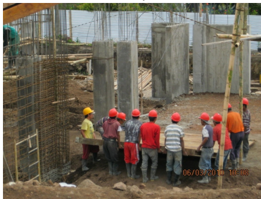
Ilustración 23. Movilización de tableros para encofrado de pantallas.
