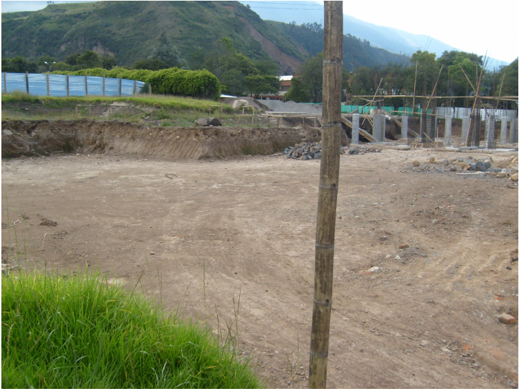
Ilustración 2. Estado inicial de la obra
