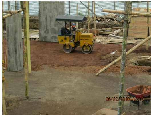
Ilustración 28. Relleno y compactación hasta el nivel N+0.0 con recebo e=20 cm
