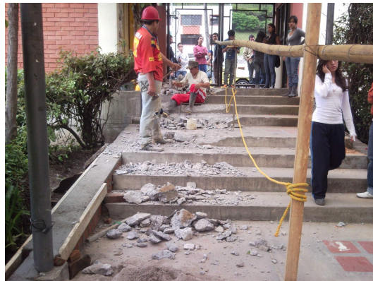
Ilustración 66. Demolición de peldaños
