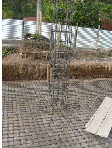
Ilustración 19. Columna K-1 enganchada e izada sobre es refuerzo de la zapata
