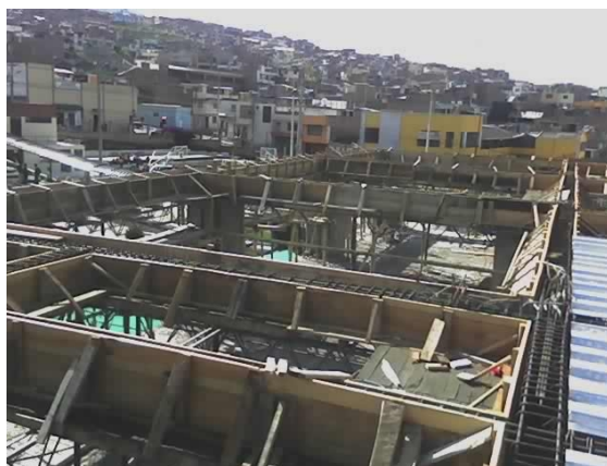
Ilustración 59. Armado de refuerzo de vigas Aéreas.
