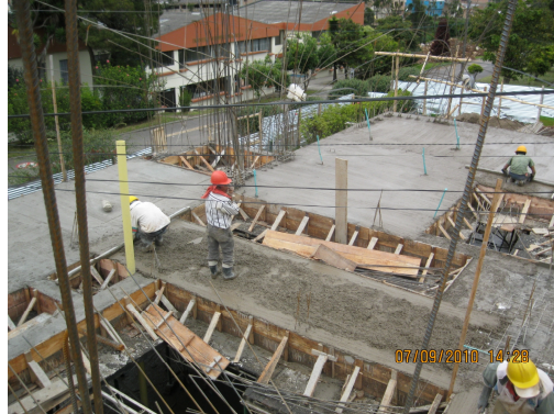
Ilustración 49. Fundición de loseta superior del nivel N+6.00.
