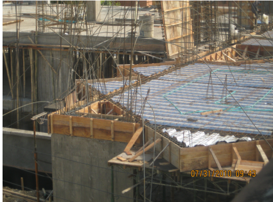
Ilustración 46. Instalación de metaldeck y tubería eléctrica.
