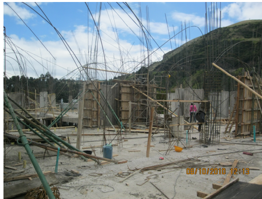
Ilustración 52. Columnas y pantallas encofradas y fundidas
