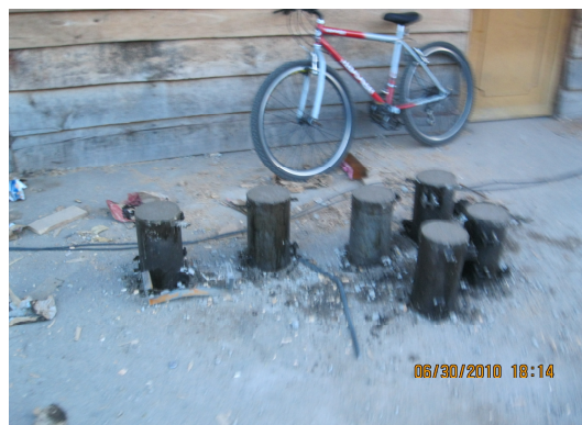
Ilustración 17. Cilindros de concreto para pruebas de resistencia
