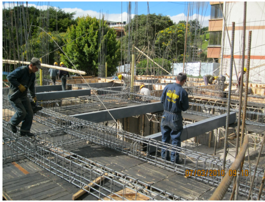
Ilustración 45. Armado de refuerzo de vigas aéreas e instalación de perfiles sobre los tableros.
