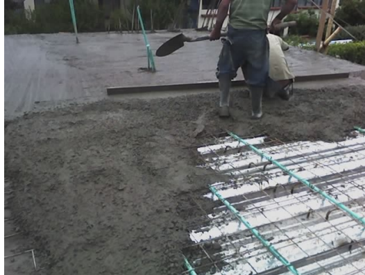
Ilustración 39. Fundición de loseta.
