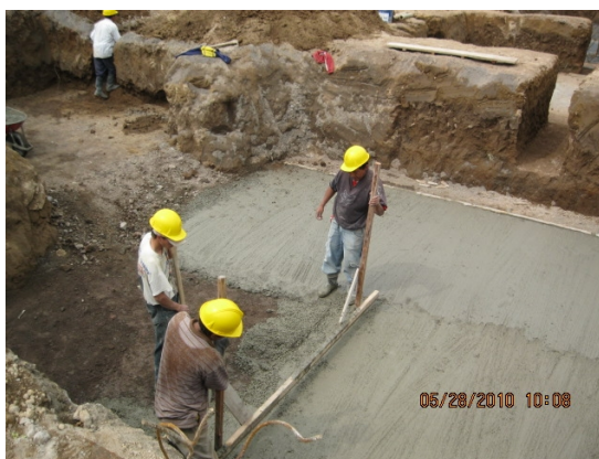
Ilustración 11. Fundición de solado de zapata del eje K
