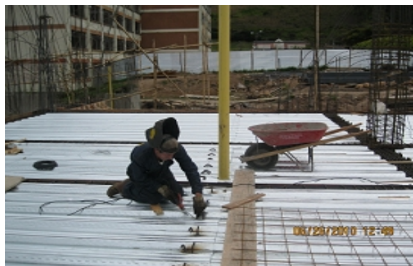
Ilustración 35. Soldadura de conectores de cortante sobre perfiles y metaldeck.
