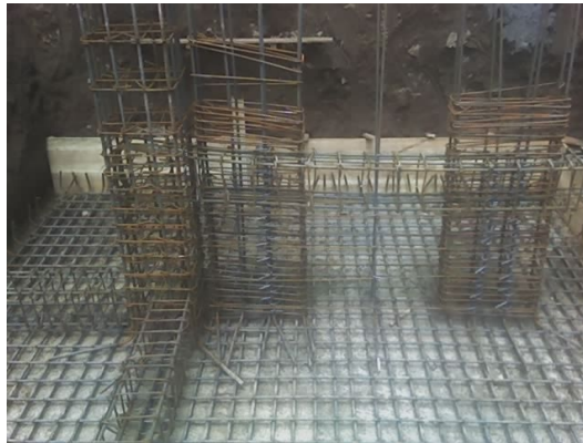
Ilustración 21. Armado de refuerzo de pantalla 1-K
