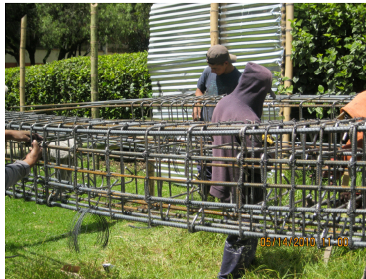
Ilustración 18. Armado de refuerzo de columnas
