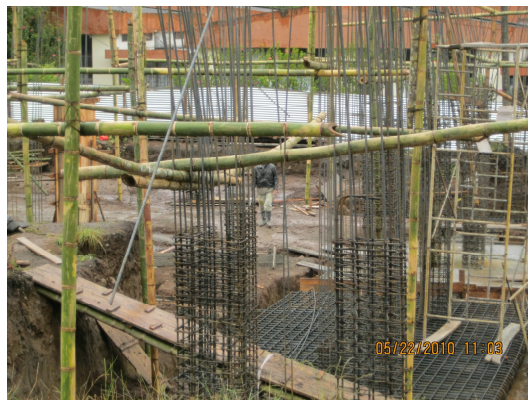
Ilustración 20. Izado de columnas de columnas del eje K.
