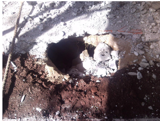
Ilustración 68. Excavación de material común.
