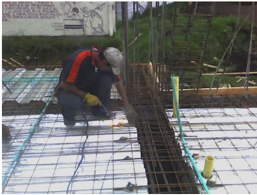
Ilustración 47. Instalación de malla electrosoldada y conectores sobre el metaldeck.
