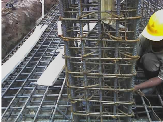
Ilustración 22. Armado de estribos de pantalla
