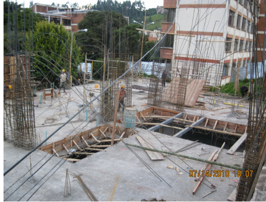
Ilustración 51. Armado de refuerzo de columnas y pantallas del nivel N+9.00.
