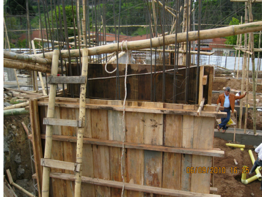
Ilustración 24. Encofrado de pantalla 1-K
