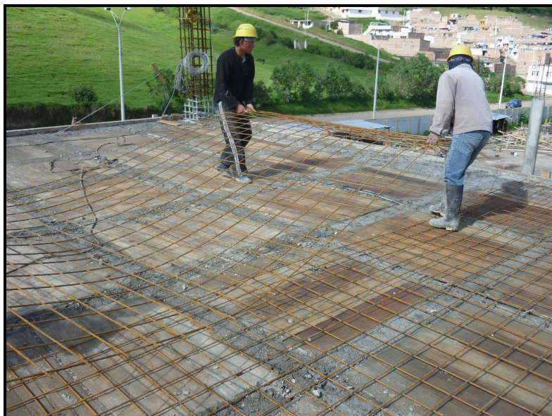
Fotografía No 88: Instalación de malla electrosoldada
