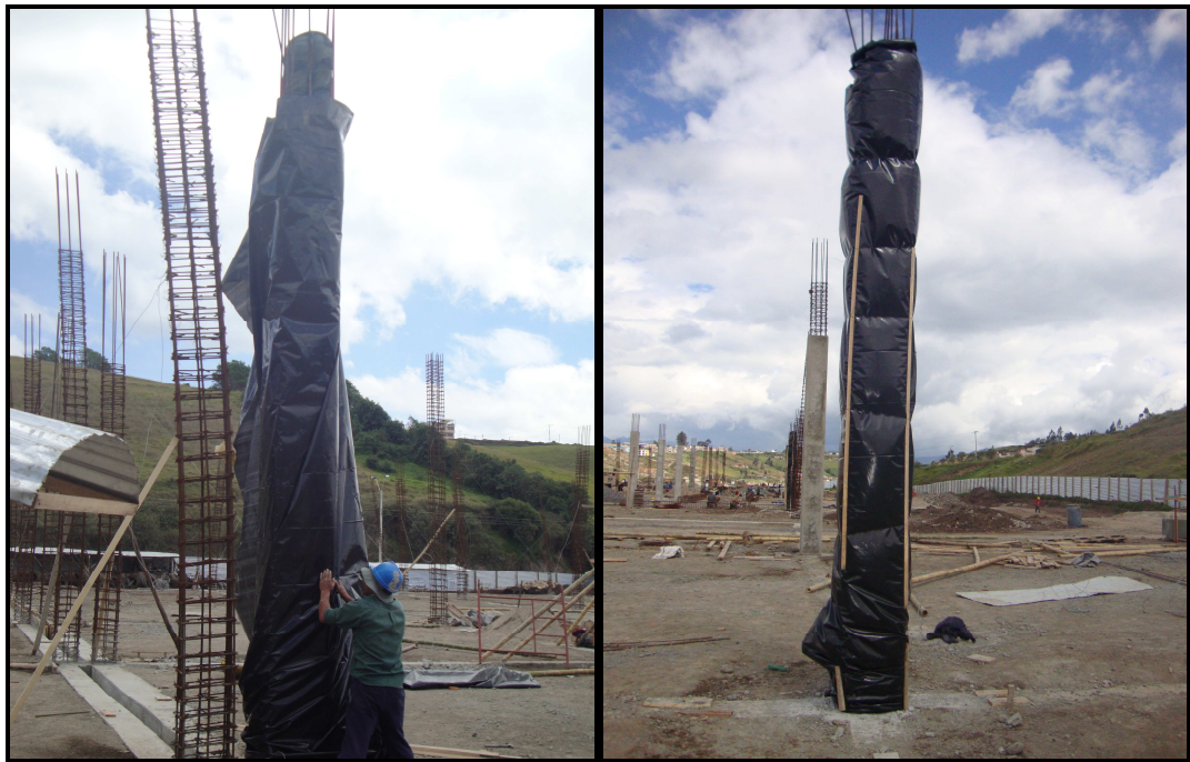
Fotografía No 73: Curado de columnas
