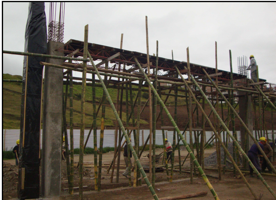
Fotografía No 74: Instalación de formaleta para vigas aéreas
