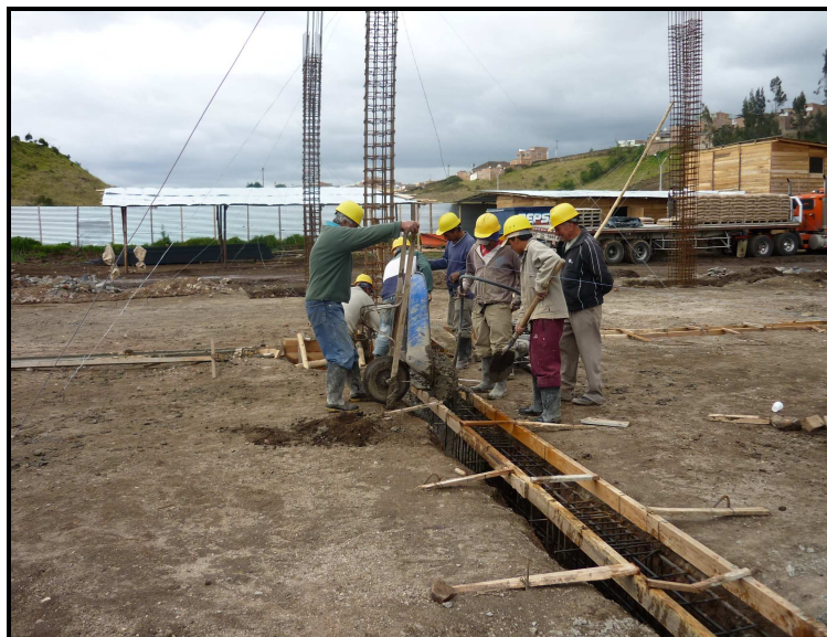
Fotografía No 62: Colocación de listones laterales
