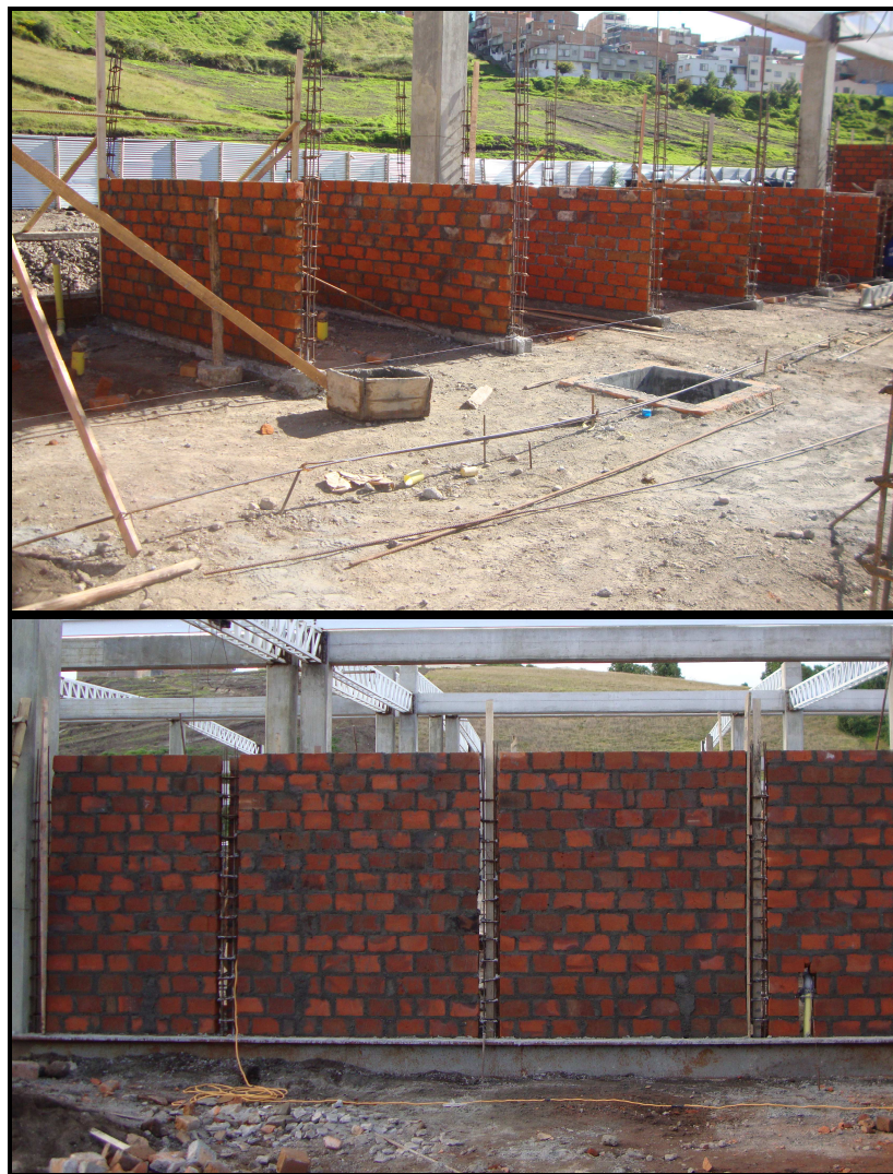
Fotografía No 105: Construcción de muros para locales
