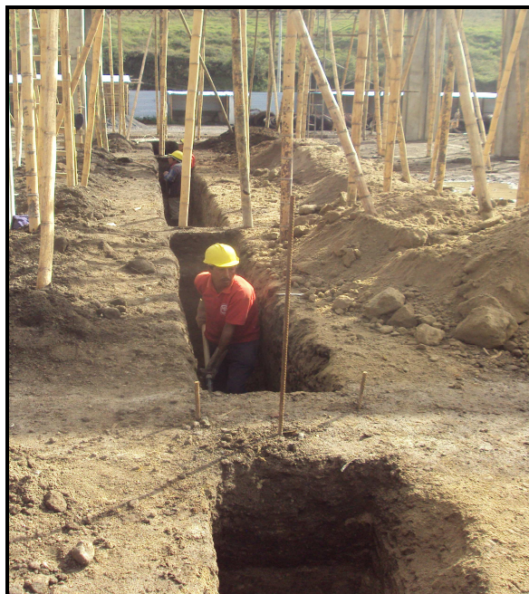
Fotografía No 99: Excavación para tubería de 6”
