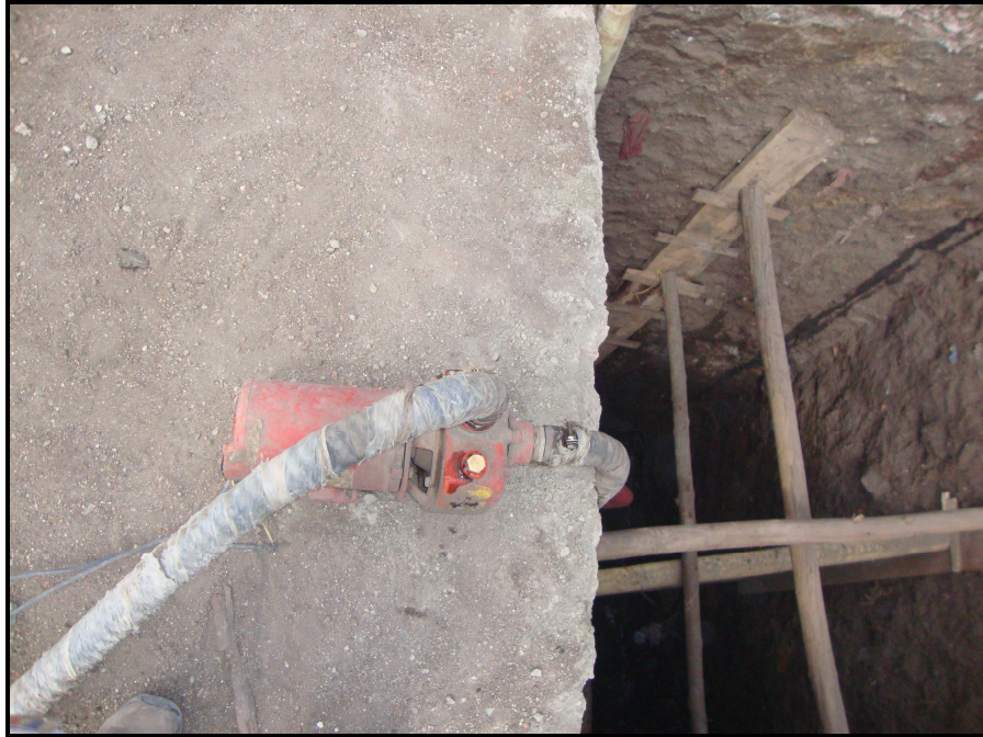
Fotografía No 40: Motobomba para extracción de agua
