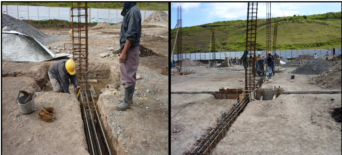
Fotografía No 60: Instalación de refuerzo para vigas de cimentación
