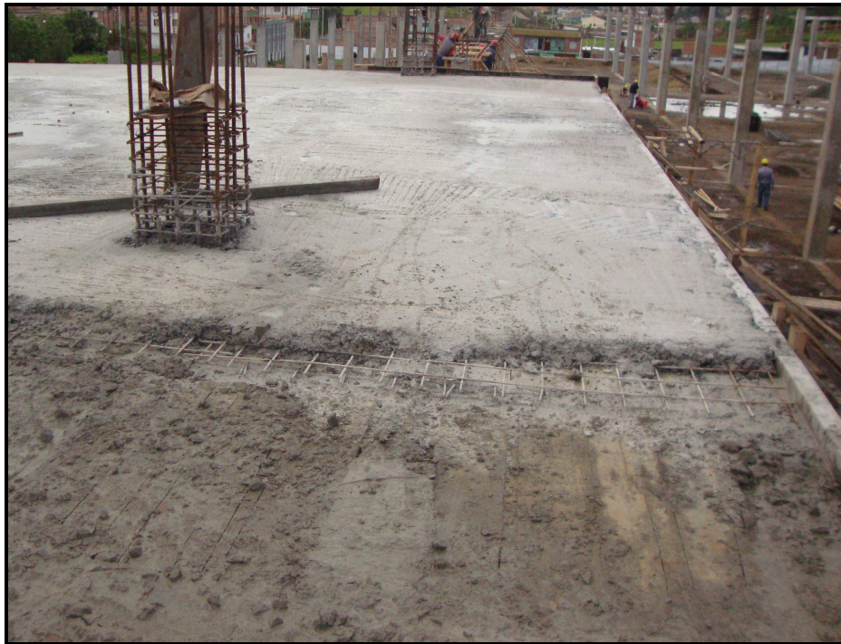
Fotografía No 90: Junta en la losa
