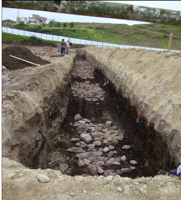
Fotografía No 11: Mejoramiento de suelo
