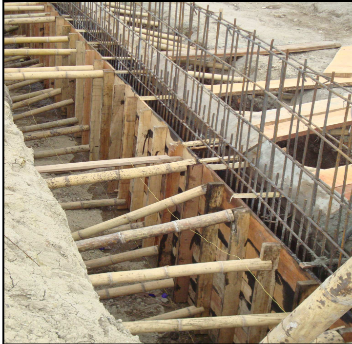
Fotografía No 16: Encofrado del cuerpo del muro
