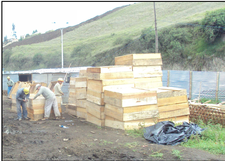
Fotografía No 82: Armado de casetones en madera
