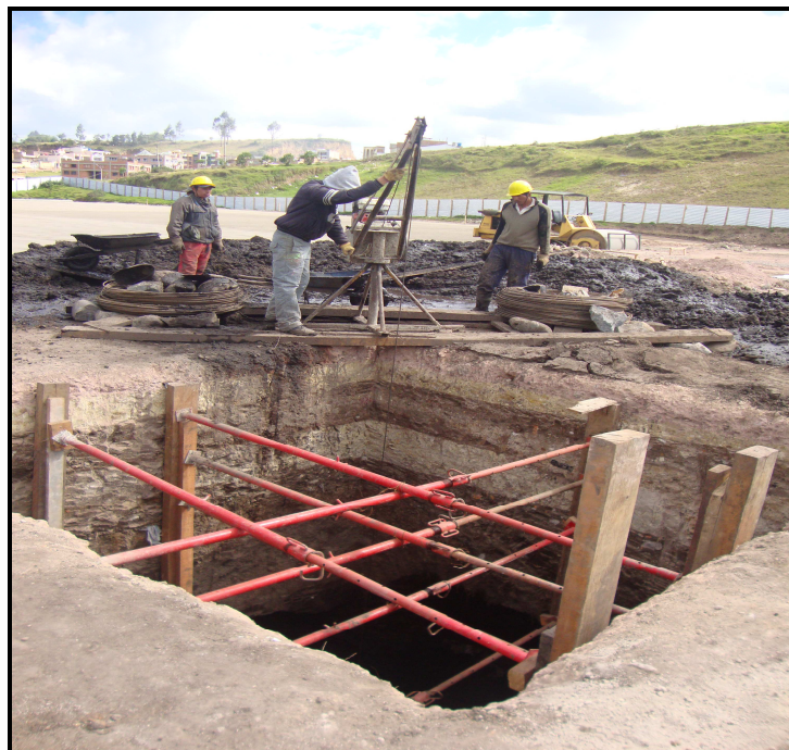
Fotografía No 37: Extracción de material por medio de grúa
