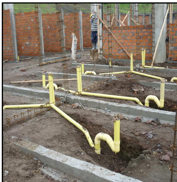
Fotografía No 97: Instalación de sifones y desagües para lavaplatos
