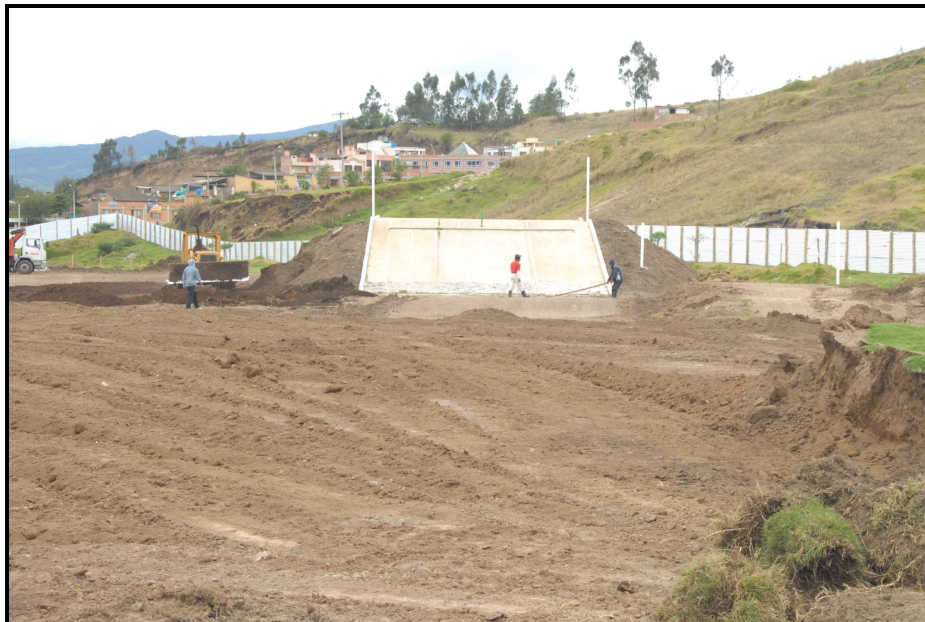
Fotografía No 6: Movimiento de tierra de rampas
