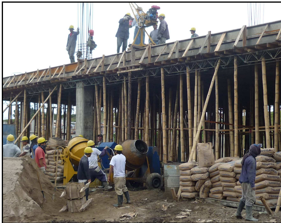
Fotografía No 86: Personal, equipo y materiales
