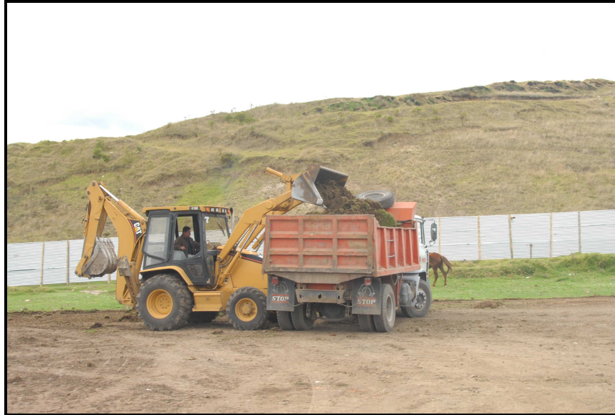
Fotografía No 5: Cargue de material sobrante
