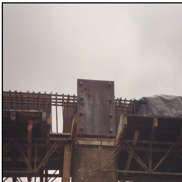
Fotografía No 76: Instalación de platinas en vigas aéreas
