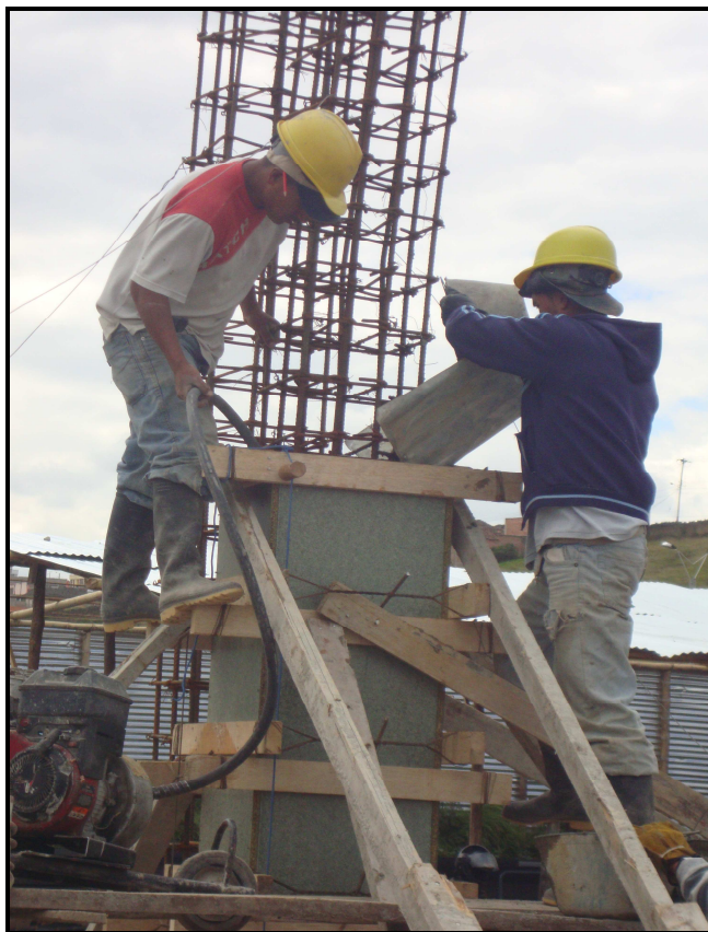
Fotografía No 68: Vaciado y vibrado del concreto
