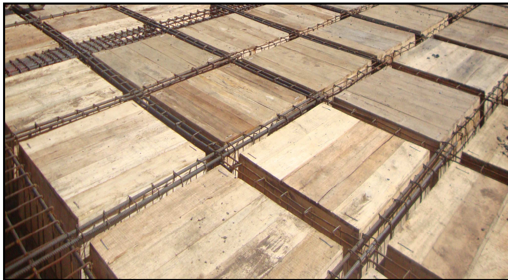
Fotografía No 85: Instalación de casetones
