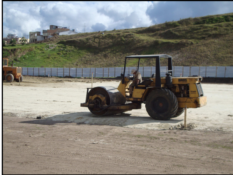
Fotografía No 25: Compactación del material con vibrocompactador
