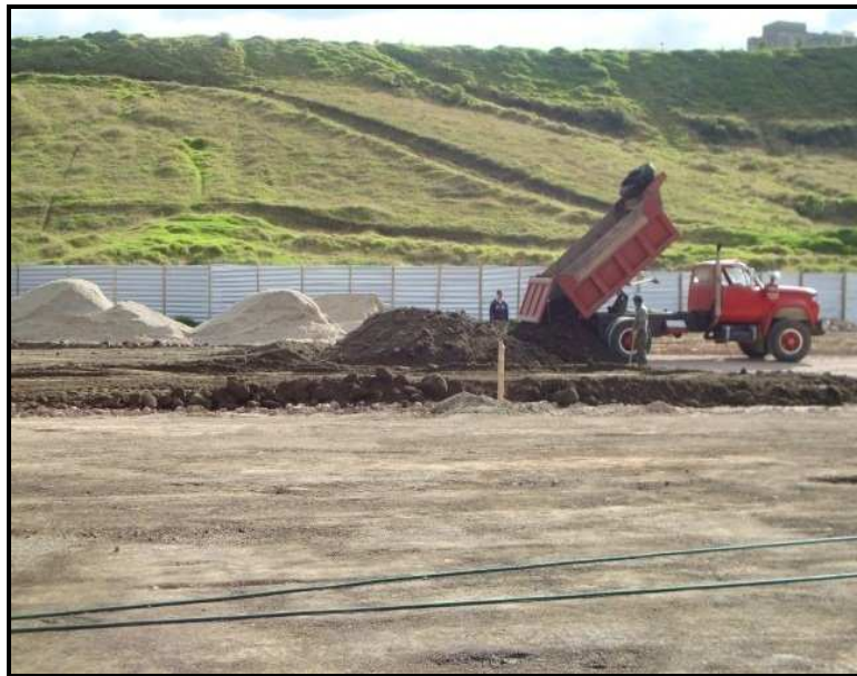
Fotografía No 23: Disposición de material de préstamo
