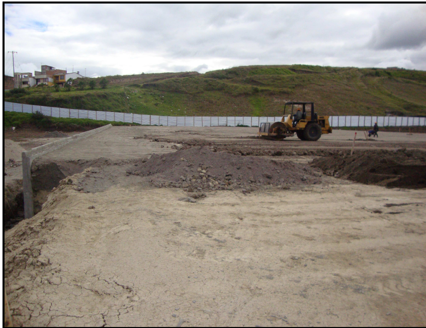
Fotografía No 20: Relleno y nivelación
