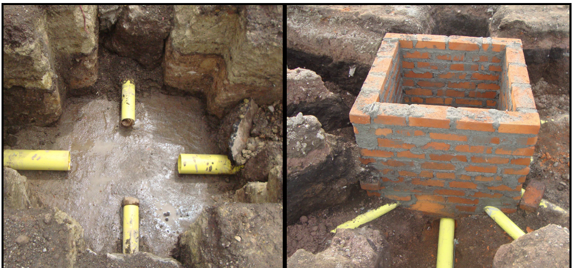
Fotografía No 95: Construcción de cajas de inspección
