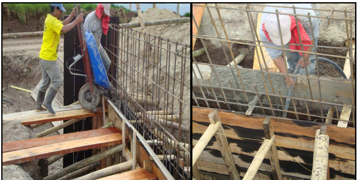
Fotografía No 17: Vaciado y vibrado del concreto: Cuerpo del muro
