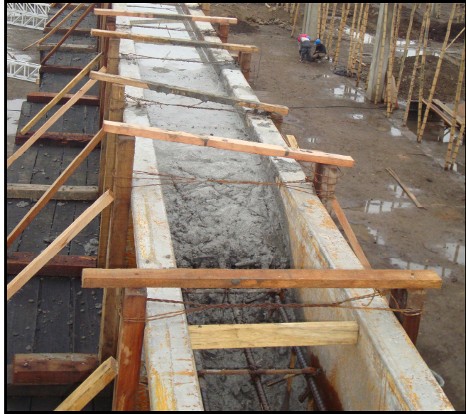
Fotografía No 79: Junta de construcción
