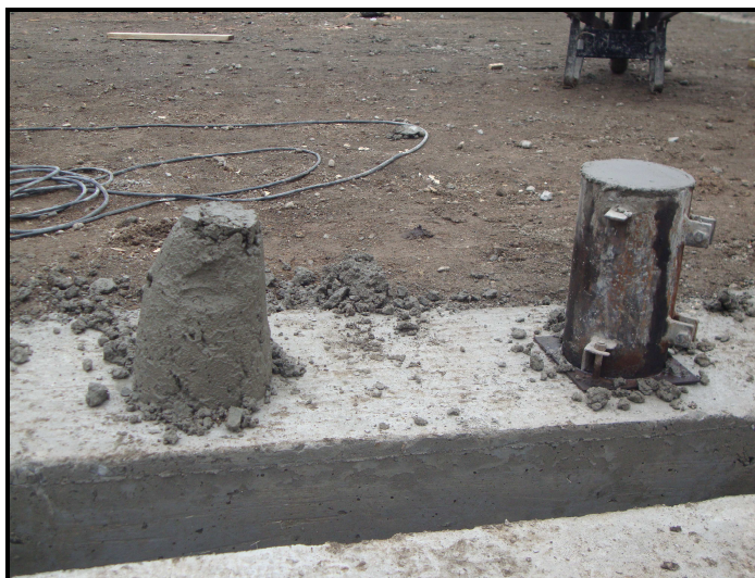
Fotografía No 70: Ensayo de asentamiento
