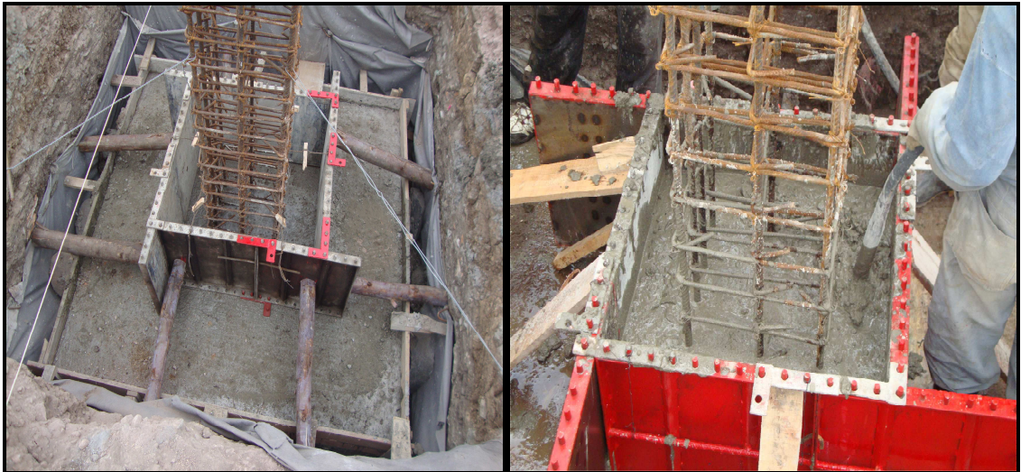
Fotografía No 56: Formaleta pedestal, vaciado y vibrado del concreto
