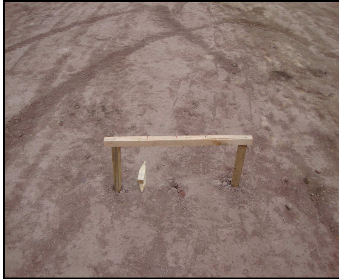
Fotografía No 29: Localización de puentes
