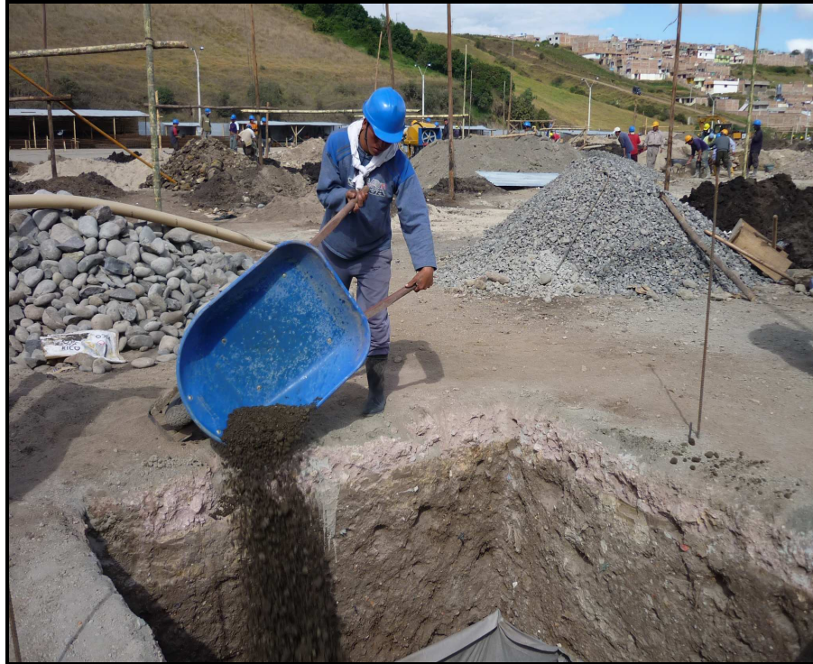
Fotografía No 48: Vaciado de recebo-cemento
