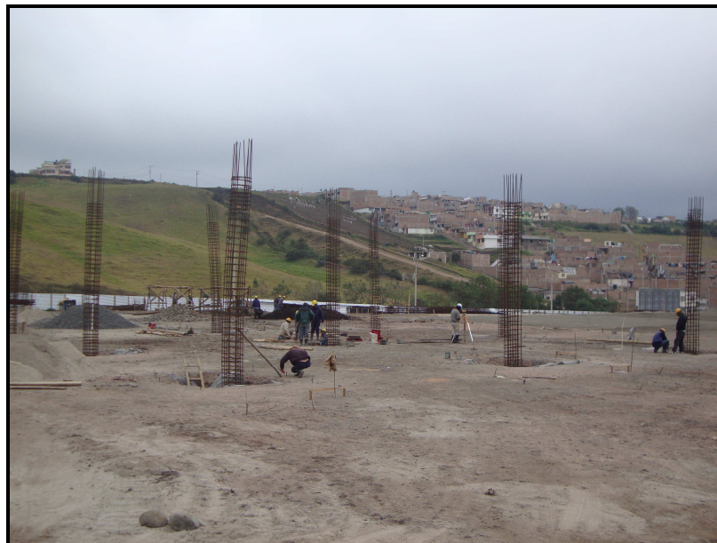
Fotografía No 55: Vista general de castillos instalados
