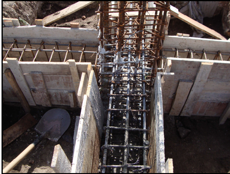
Fotografía No 61: Colocación de formaleta en los nudos
