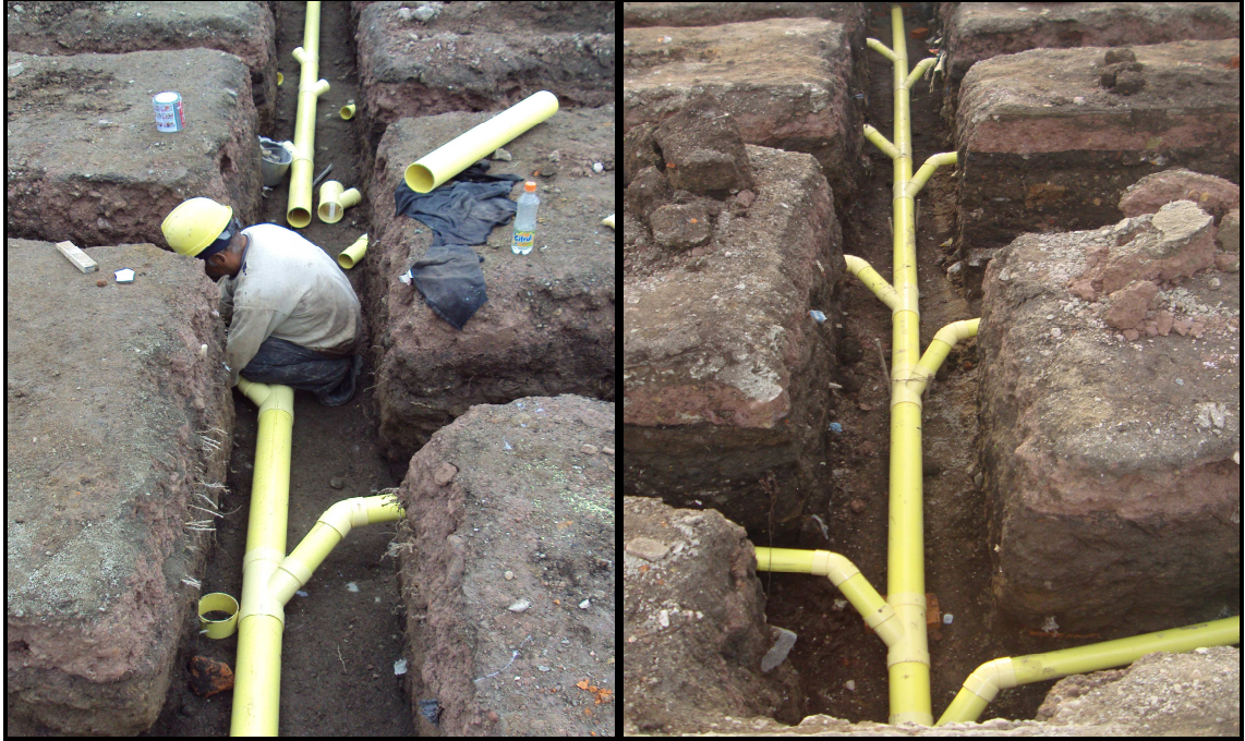
Fotografía No 94: Instalación de tubería
