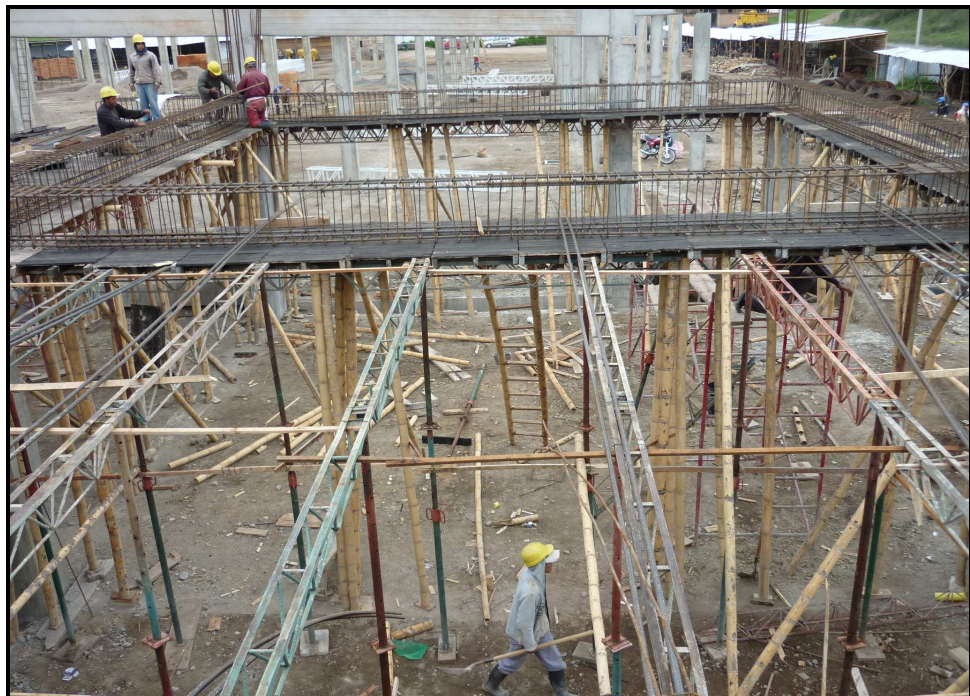
Fotografía No 83: Armado de formaleta para losa
