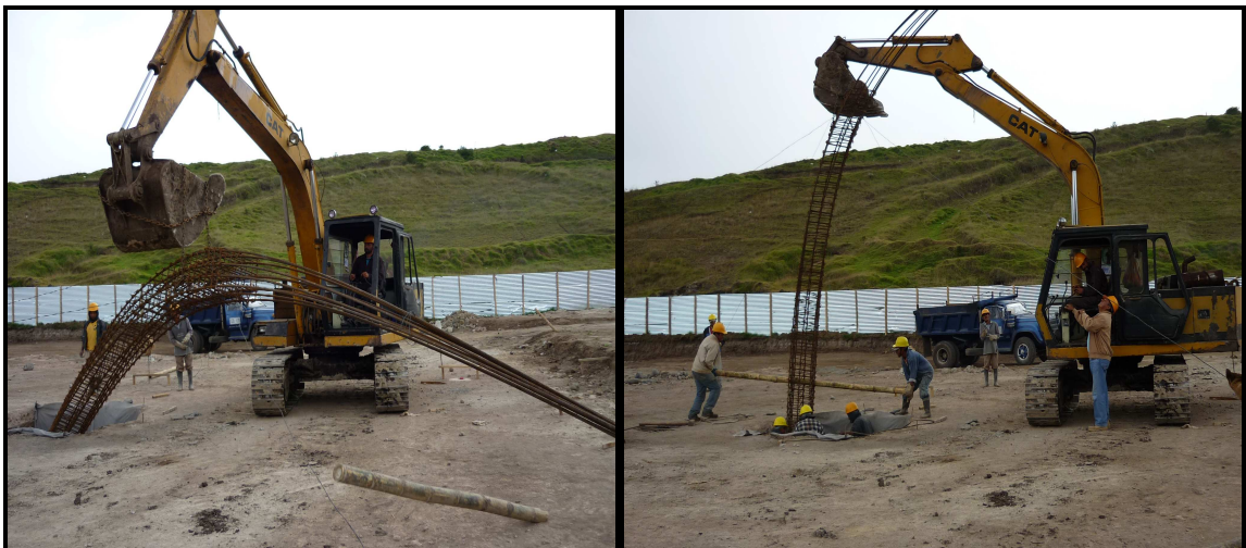
Fotografía No 52: Colocación castillos columnas
