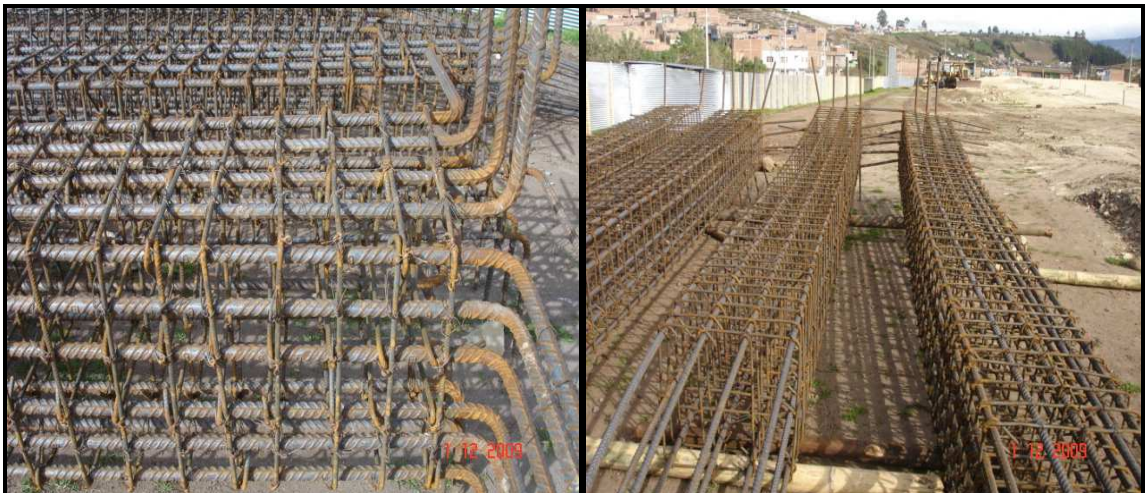
Fotografía No 66: Armado de refuerzo para columnas
