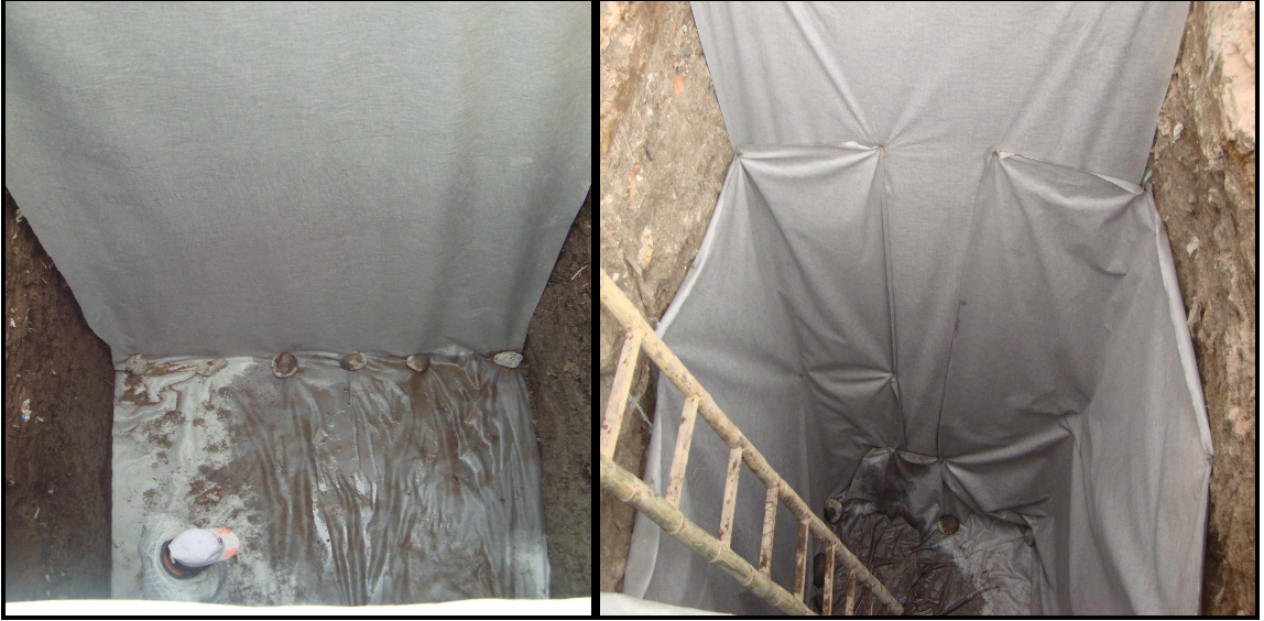
Fotografía No 46: Instalación de geotextil
