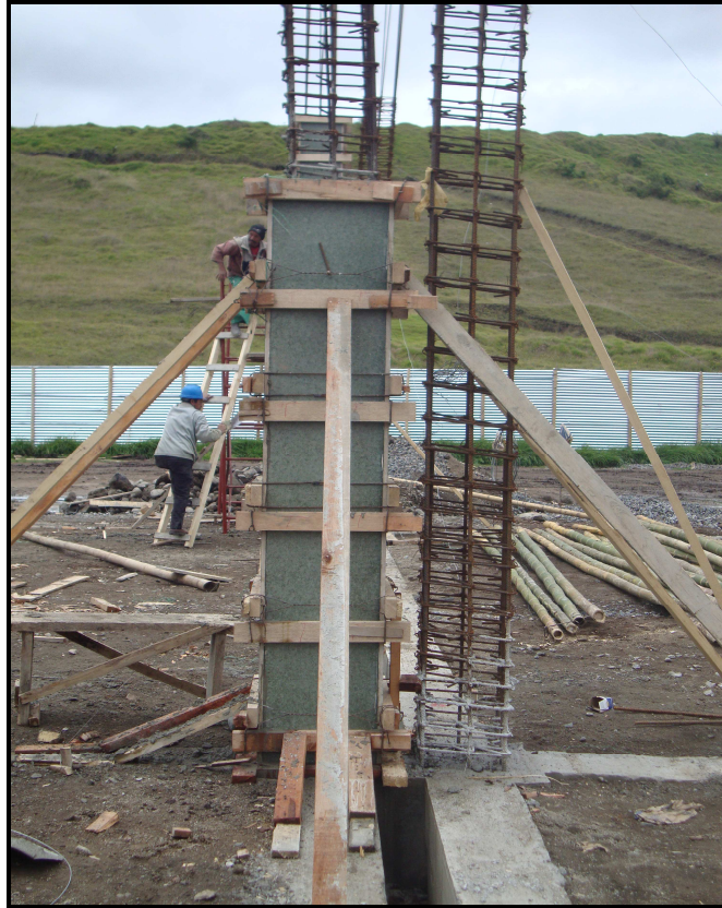
Fotografía No 67: Encofrado de columnas
