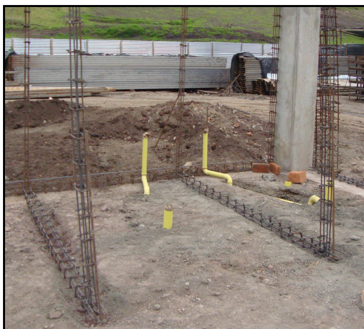
Fotografía No 102: Armado de columnetas y viguetas de confinamiento
