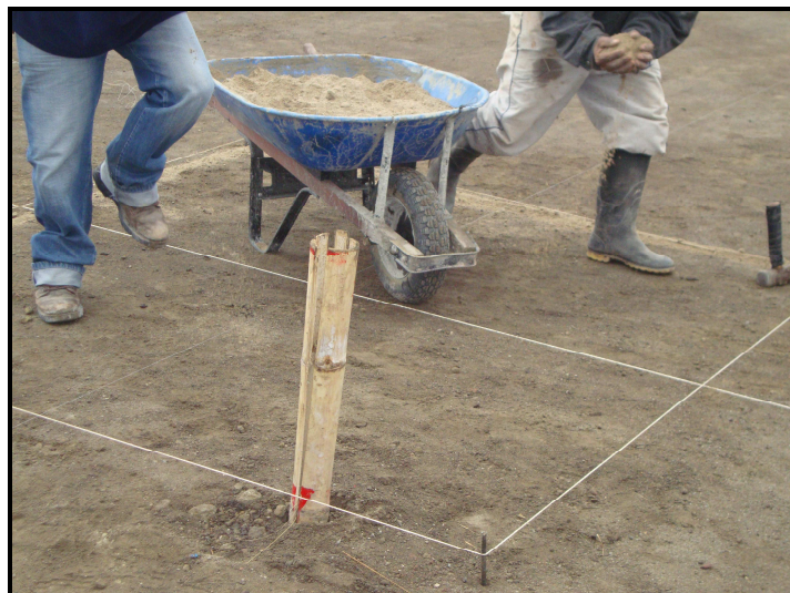
Fotografía No 30: Demarcación sección de zapatas
