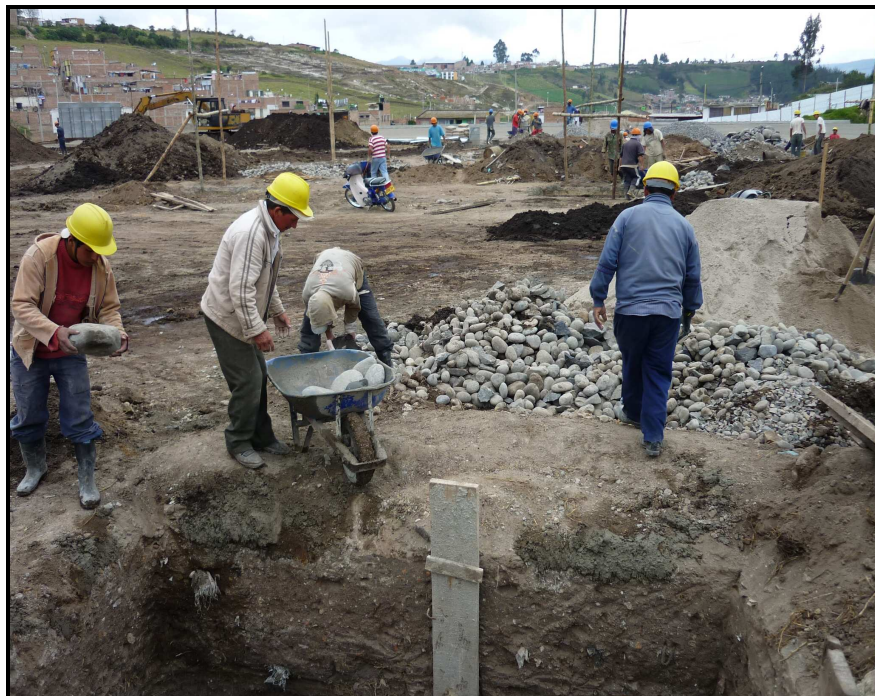
Fotografía No 42: Colocación de piedras
