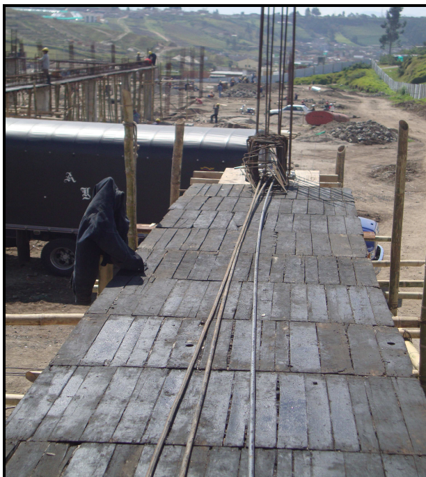
Fotografía No 75: Instalación de refuerzo en vigas aéreas
