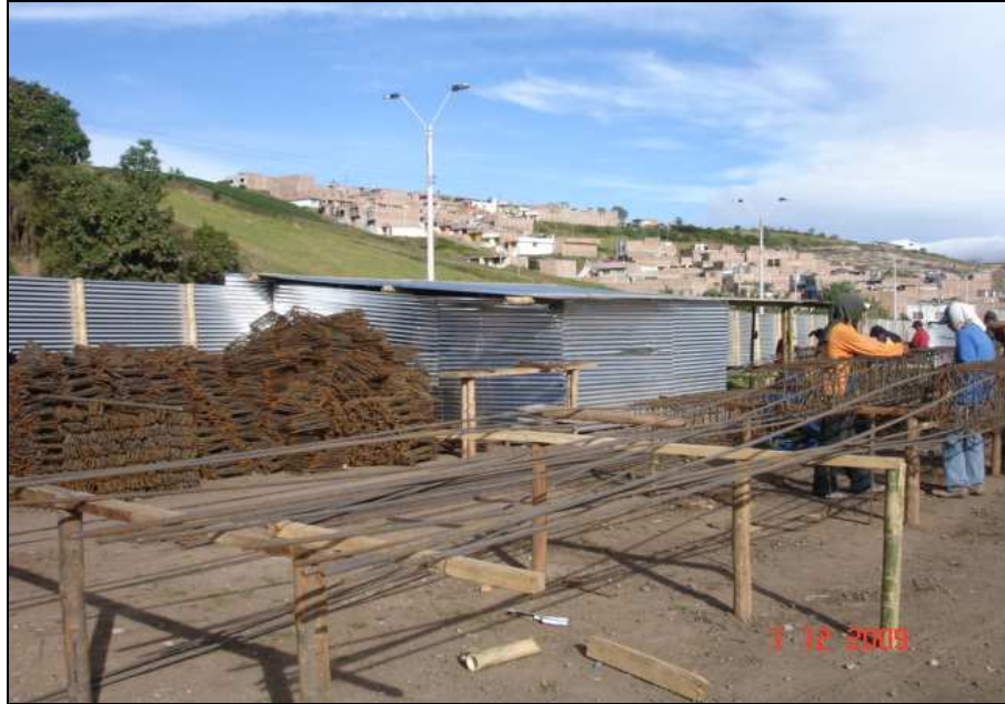
Fotografía No 10: Zona de figurado de hierro
