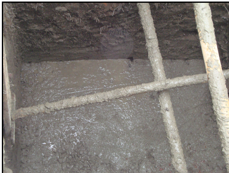
Fotografía No 44: Concreto ciclópeo terminado
