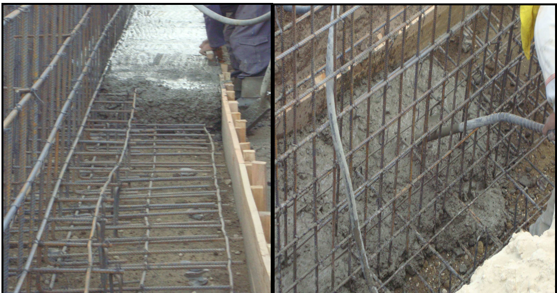
Fotografía No 14: Vaciado y vibrado del concreto
