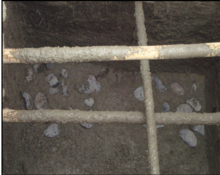
Fotografía No 43: Colocación de concreto y piedras
