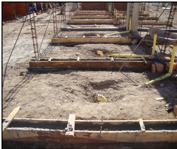
Fotografía No 103: Formaleta para viguetas
