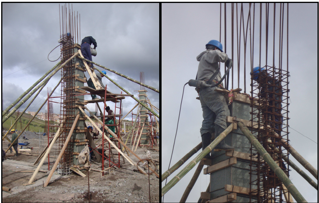
Fotografía No 71: Vaciado y vibrado del concreto, segunda sección de columnas
