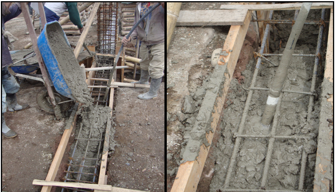
Fotografía No 63: Vaciado del concreto y su respectivo vibrado
