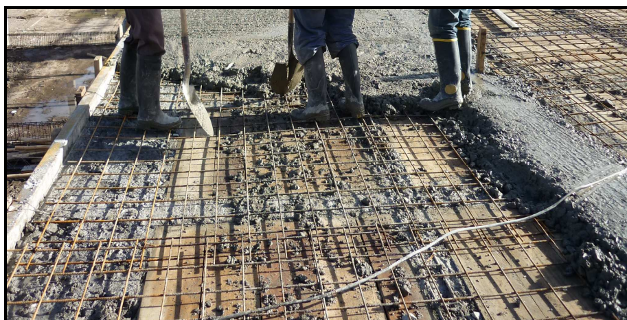
Fotografía No 89: Vaciado de la losa
