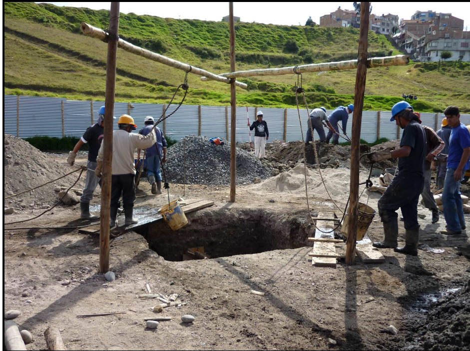
Fotografía No 35: Carretes sujetos a andamio
