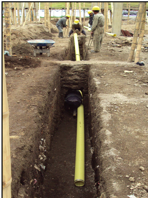
Fotografía No 101: instalación en sitio de tubería
