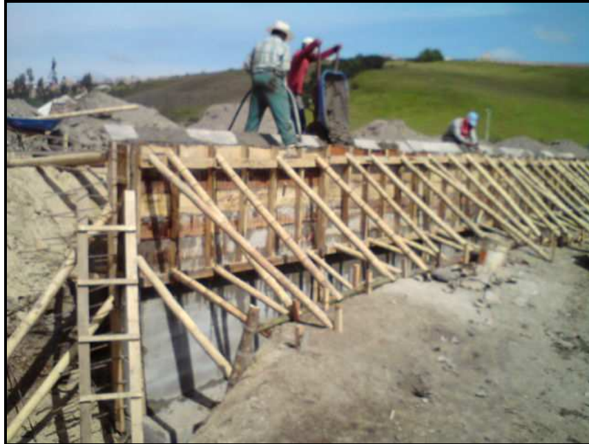
Fotografía No 18: Fundición segunda parte del cuerpo del muro
