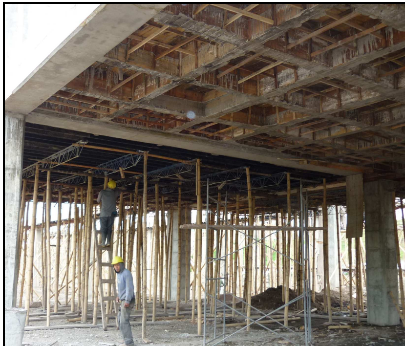
Fotografía No 91: Retiro de formaleta y casetones
