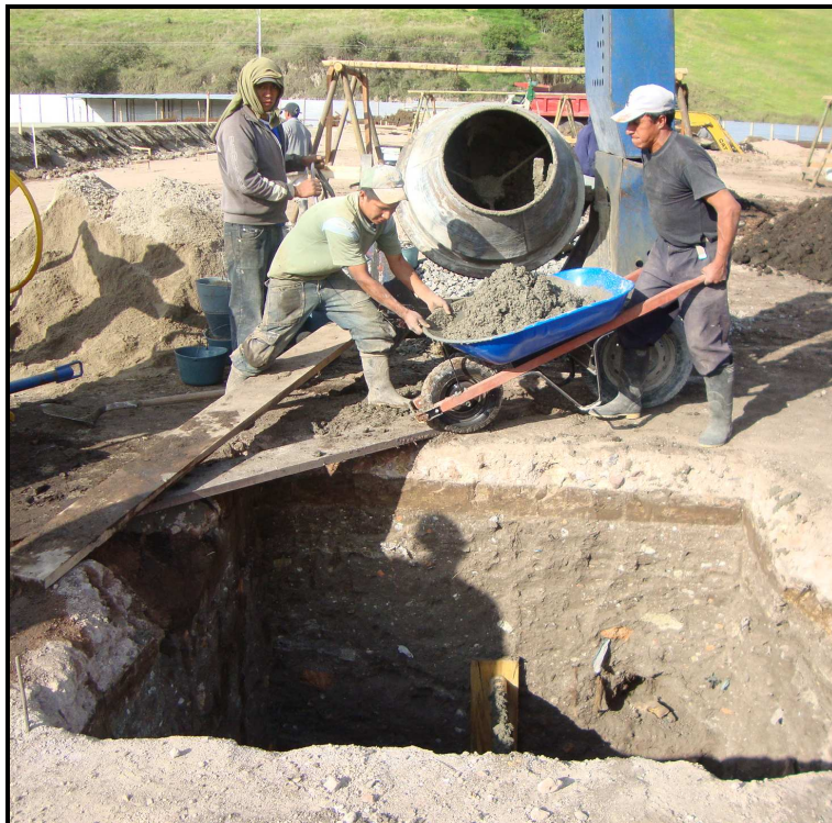
Fotografía No 41: Mezcla para concreto ciclópeo
