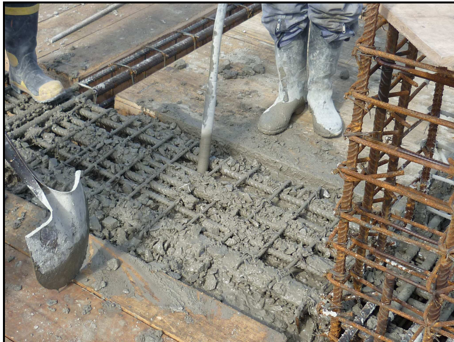
Fotografía No 87: Vaciado y vibrado del concreto
