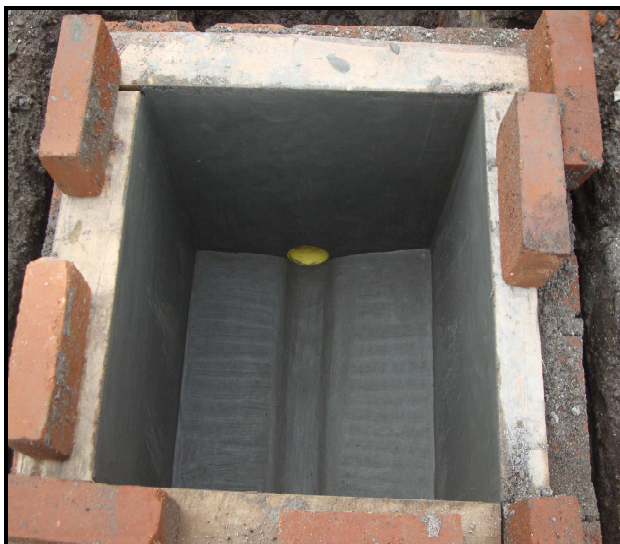
Fotografía No 96: Cañuelas en cajas de inspección
