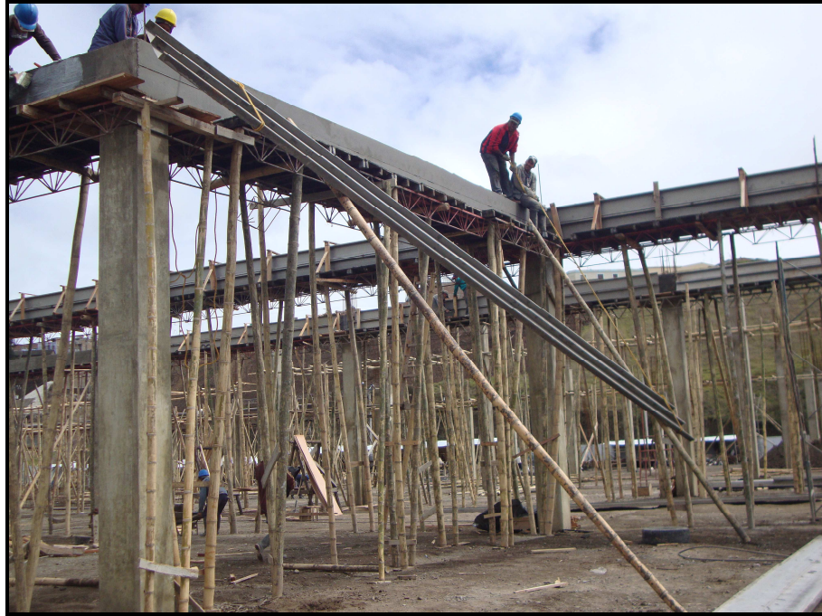
Fotografía No 81: Retiro de formaleta lateral
