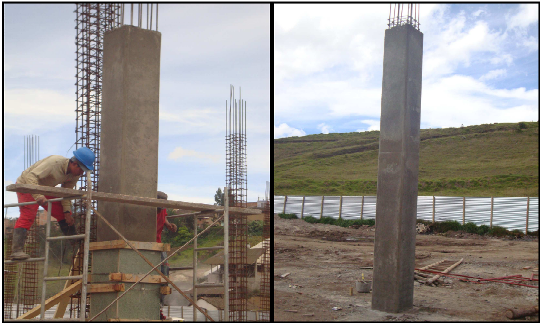
Fotografía No 72: Desencofrado de columnas
