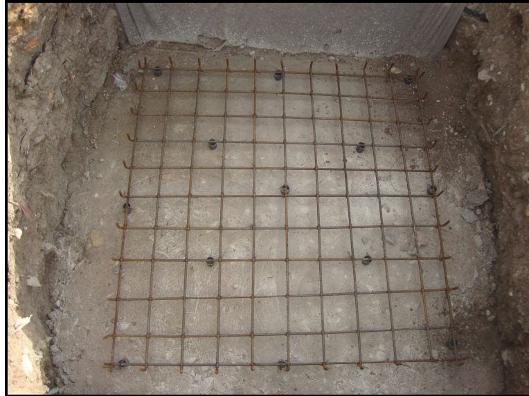
Fotografía No 51: Colocación parrilla para zapatas
