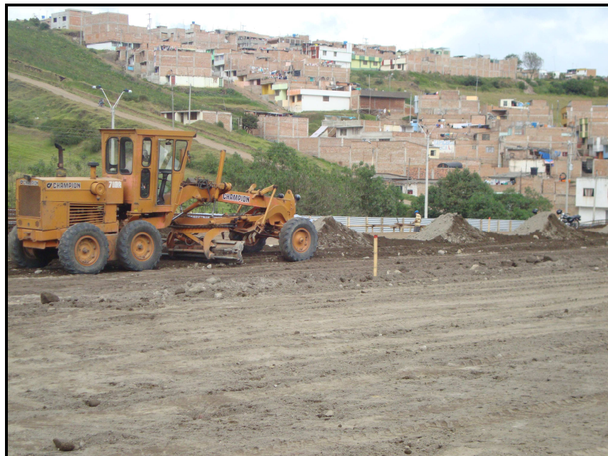
Fotografía No 24: Material extendido con motoniveladora
