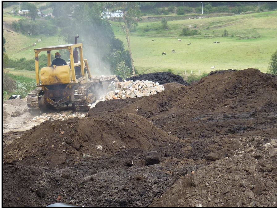
Fotografía No 8: Acondicionamiento del botadero
