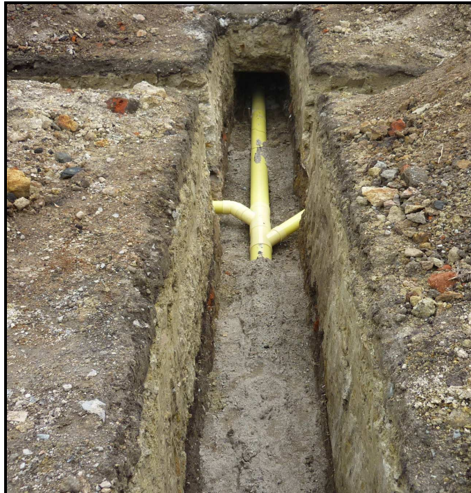
Fotografía No 98: Colocación de material de relleno
