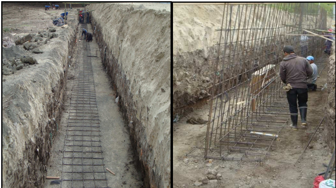
Fotografía No 12: Armado de hierro zarpa y cuerpo del muro
