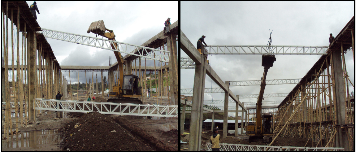
Fotografía No 107: Ubicación de cerchas
