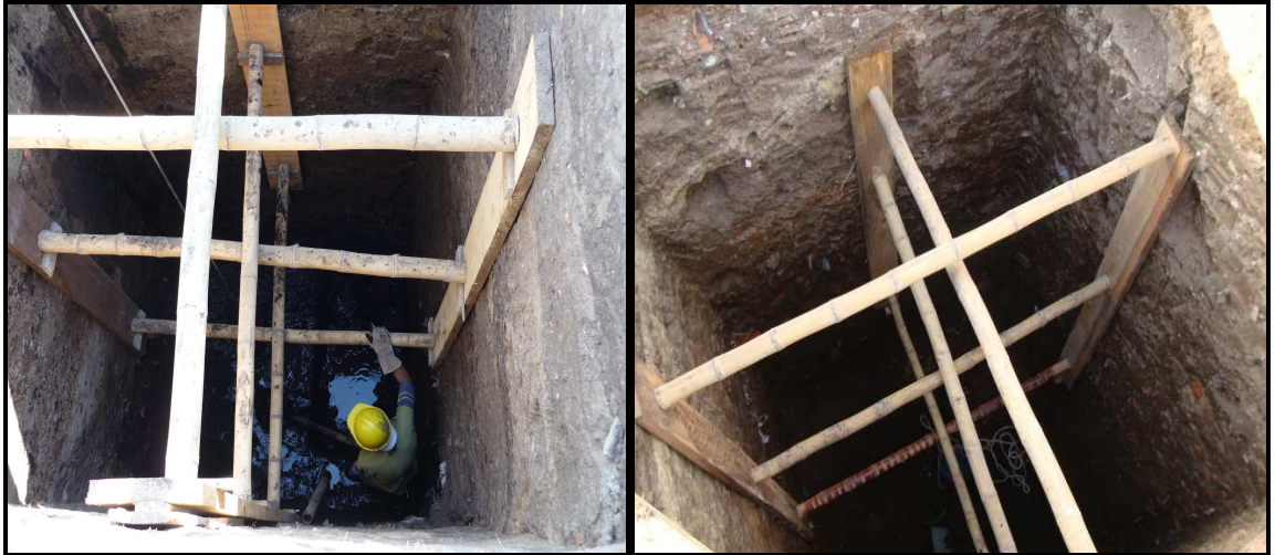
Fotografía No 36: Entibado de las excavaciones
