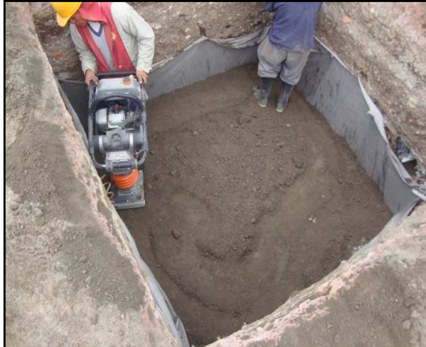
Fotografía No 49: Compactación del material
