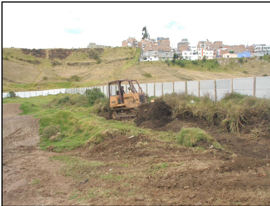
Fotografía No 4: Retiro de capa vegetal
