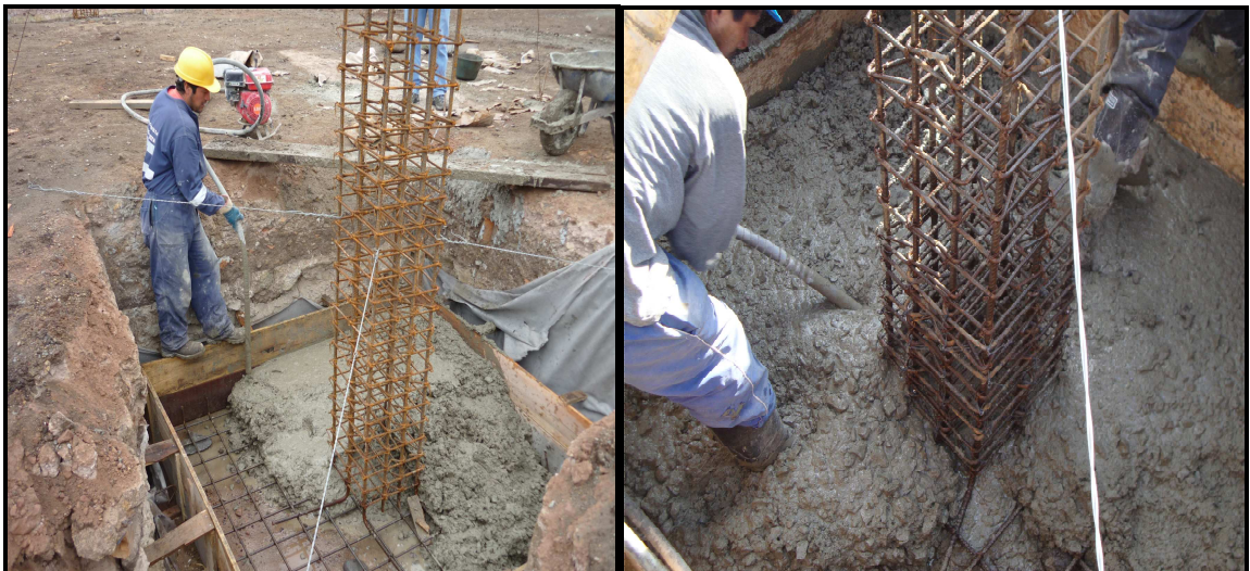
Fotografía No 53: Vaciado y vibrado de concreto para zapatas
