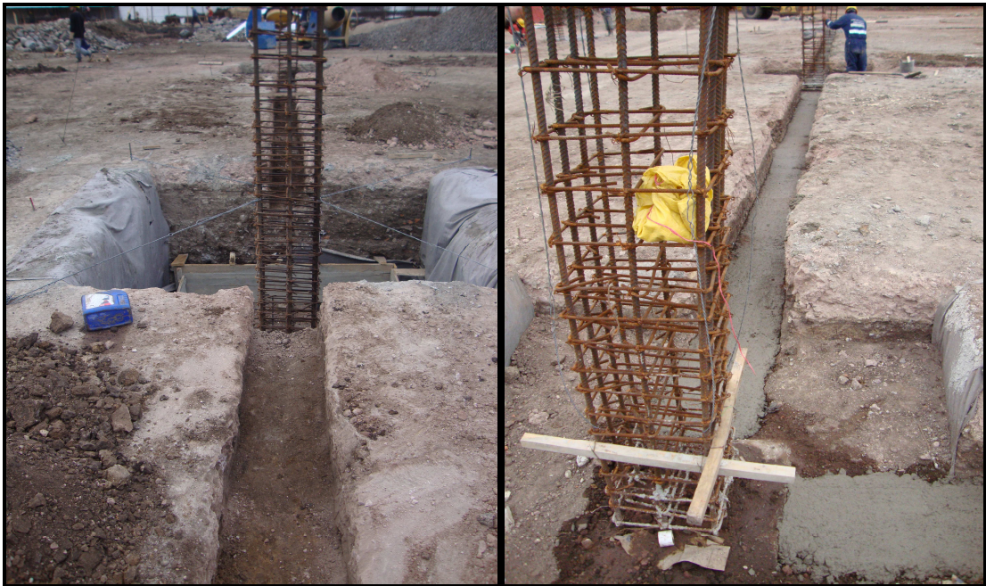
Fotografía No 59: Excavación para vigas de cimentación
