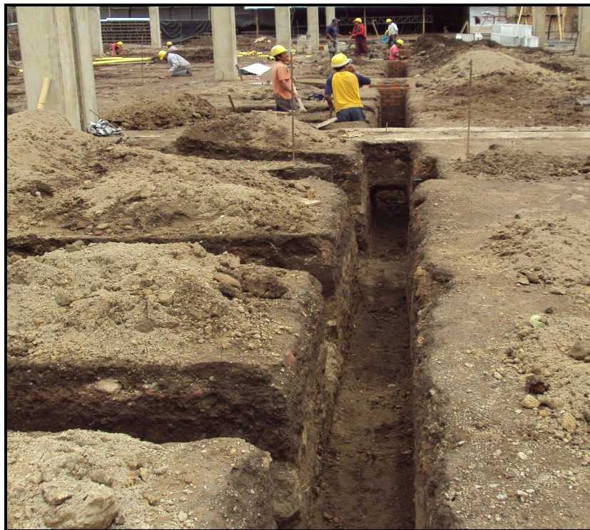
Fotografía No 92: Excavación para instalaciones sanitarias
