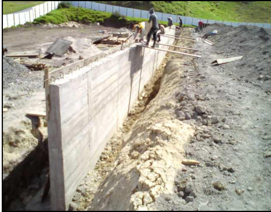
Fotografía No 19: Desencofrado del cuerpo del muro
