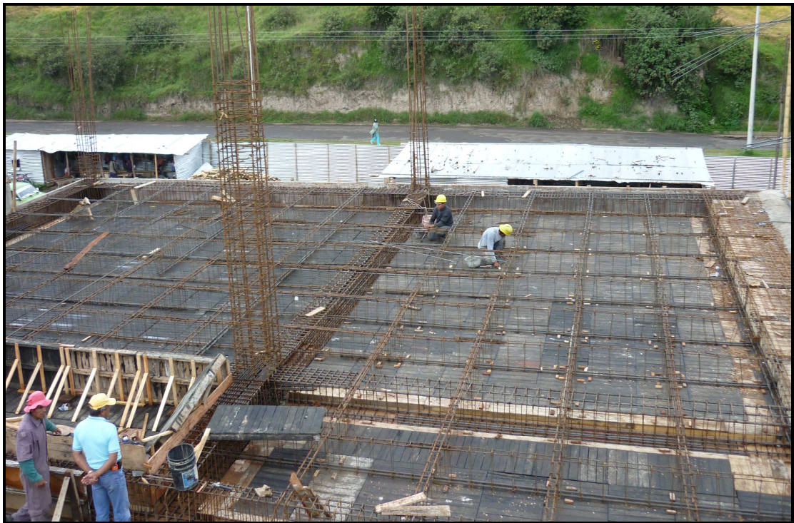
Fotografía No 84: Armado de refuerzo
