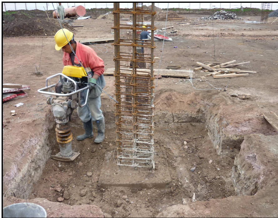
Fotografía No 58: Relleno sobre los cimientos
