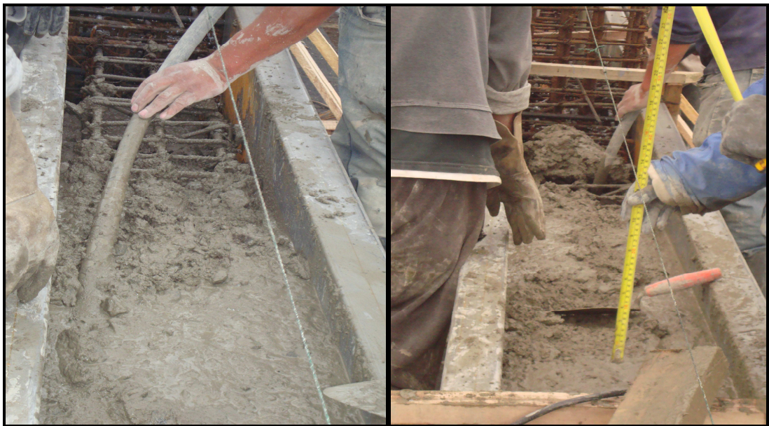
Fotografía No 77: Vaciado y vibrado del concreto, chequeo de niveles
