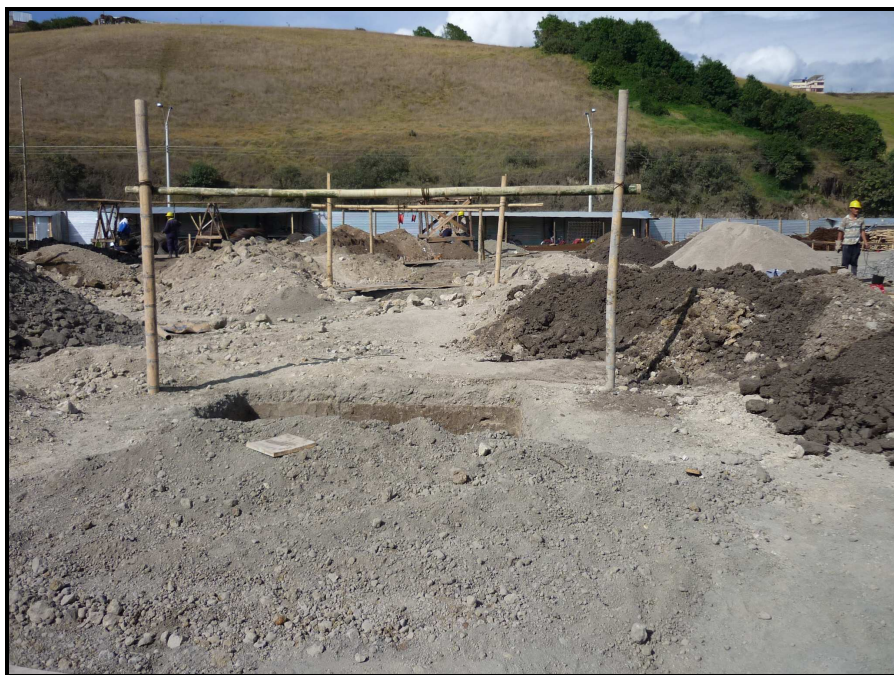
Fotografía No 33: Material extraído de las excavaciones
