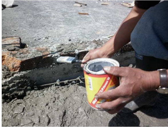
Figura 97. Aplicación del aditivo Sikadur 32 Premier
