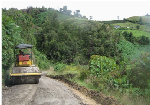
Figuras 112 y 113. Compactación del material dispuesto para el mejoramiento de la rasante
