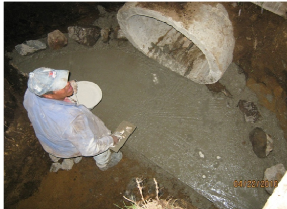
Figura 116. Fundición de solado para la construcción de los cabezales de las alcantarillas
