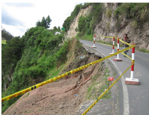
Figura 122 Estado inicial de la Banca
