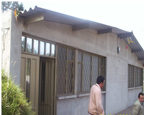
Figura 34. Estado actual del salón comunal Lourdes
