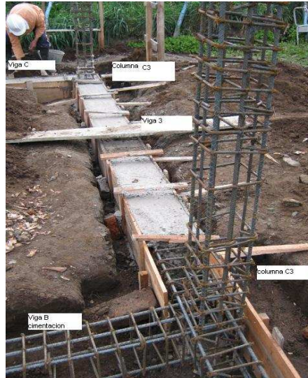
Figura 51. Fundición de viga de cimentación
