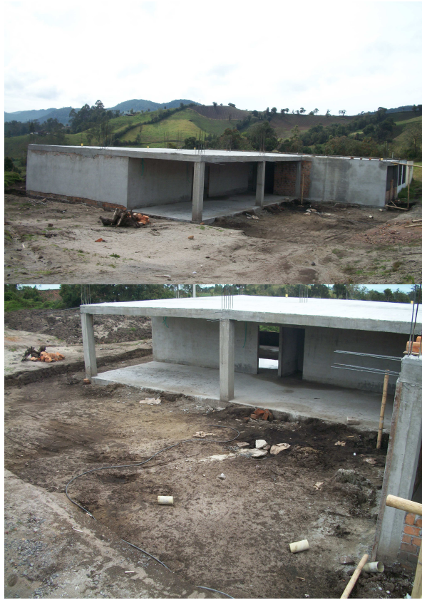
Figura 105 y 106. Estado actual de la obra
