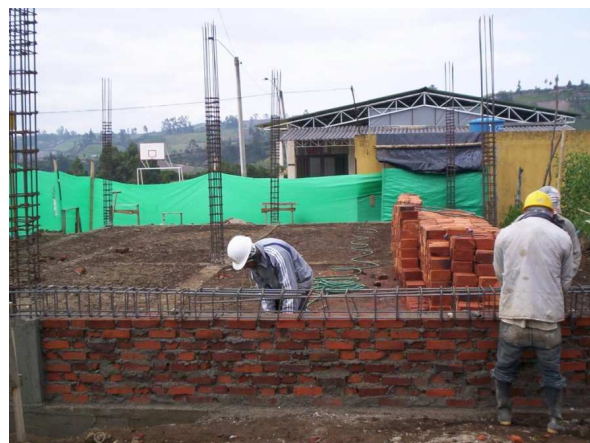
Figura 54. Localización y armado de vigas de amarre
