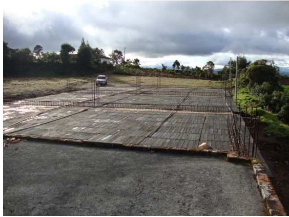
Figura 92. Disposición de la formaleta para la fundición de losa
