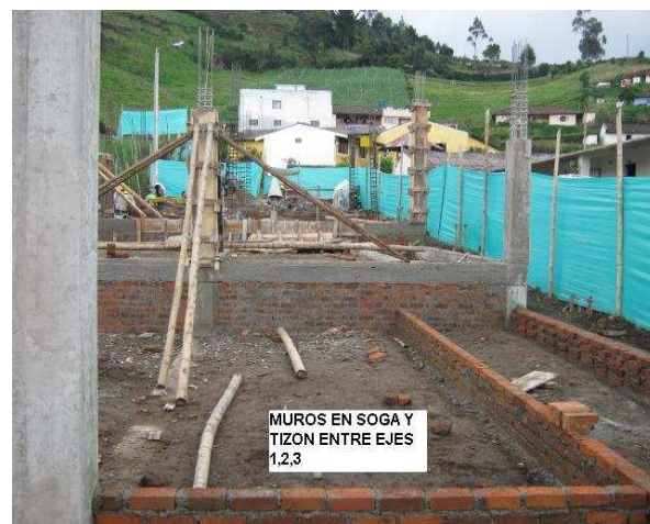
Figura 56. Fundición de columnas
