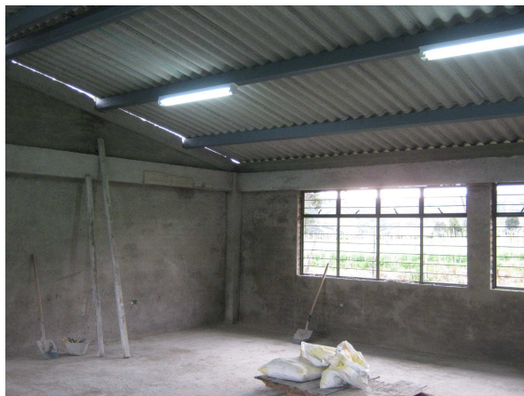
Figura 67. Piso fundido y nivelado
