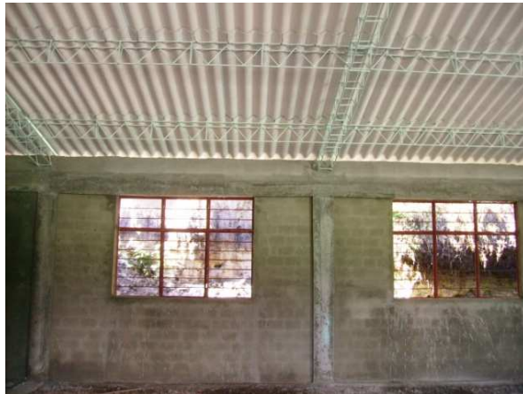
Figura 37. Estado actual del interior del salón comunal Cuaspud Cuatro Esquinas
