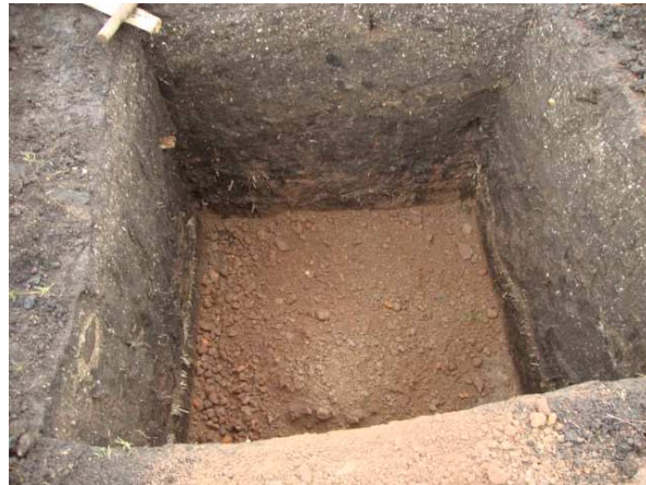
Figura 80. Disposición y compactación del recebo en la cimentación.
