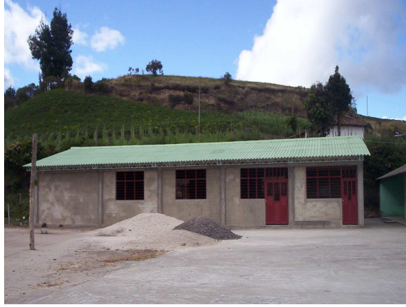
Figura 36. Salón comunal Cuaspud Cuatro Esquinas
