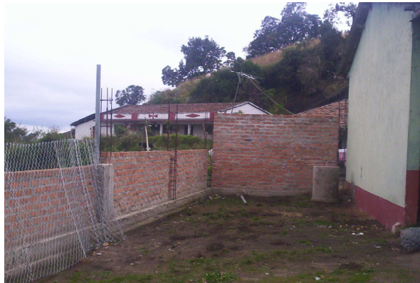
Figura 13. Estructura existente para la construcción del restaurante escolar del Centro Educativo Antonio Nariño
