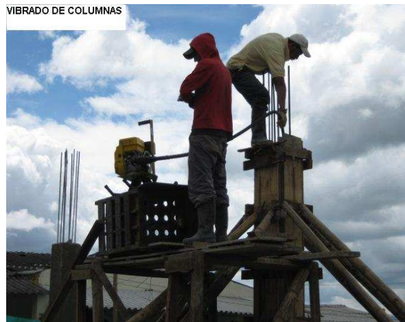
Figura 57. Fundición y vibrado de columnas
