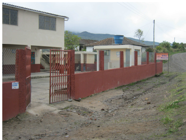
Figura 23. Localización del Restaurante escolar del Centro Educativo Villa Nueva en el segundo piso del plantel, estado actual.
