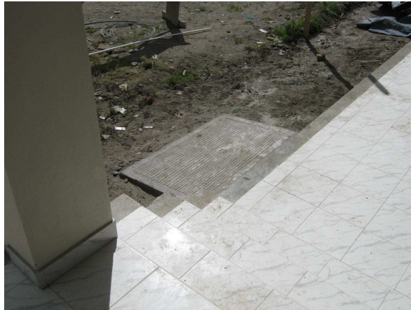
Figura 68. Rampa en concreto
