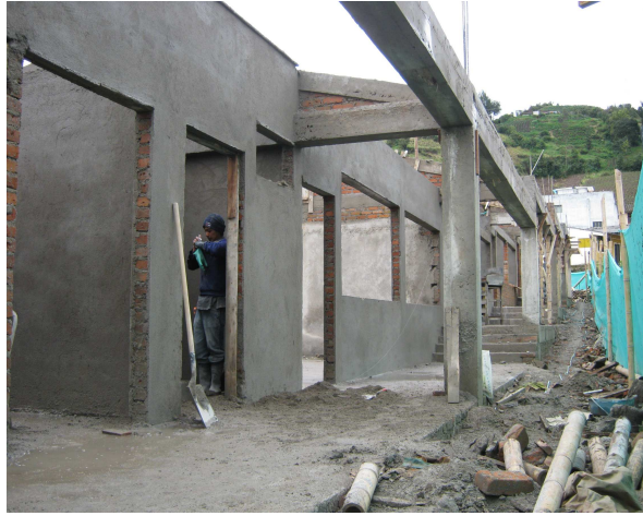
Figura 66. Pañete de muros
