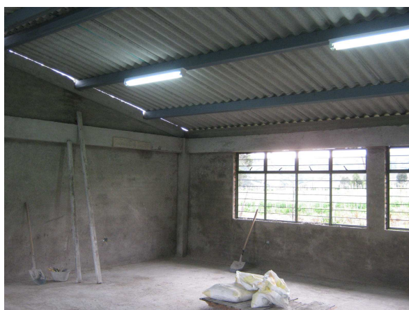
Figura 61. Cubierta en teja de A.C para aulas
