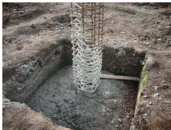
Figura 83. Proceso vaciado de concreto en zapatas
