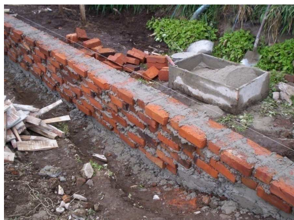
Figura 58. Construcción de mampostería en tizón
