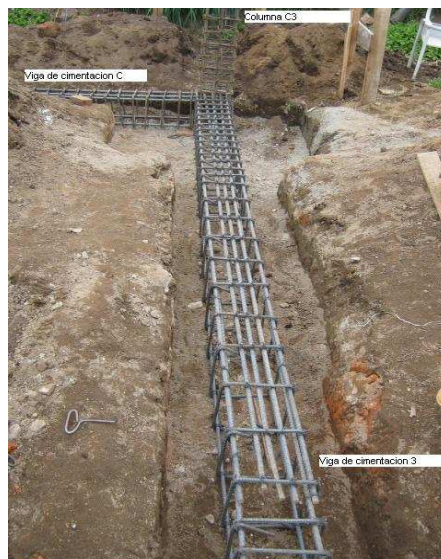
Figura 50. Localización y armado de viga de cimentación
