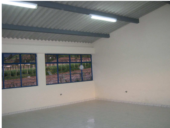
Figura 65. Instalación eléctrica en funcionamiento
