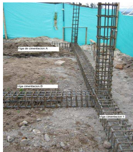
Figura 55. Localización y armado de columnas
