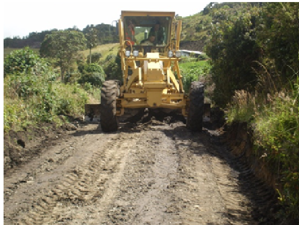
Figura 110. Extendida de material en obra mediante la utilización de la Moto niveladora
