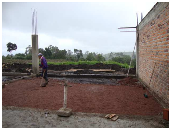
Figura 86. Nivelación de piso, disposición de recebo para proceder a fundir el piso
