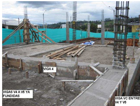
Figura 53. Conformación de niveles vigas de cimentación
