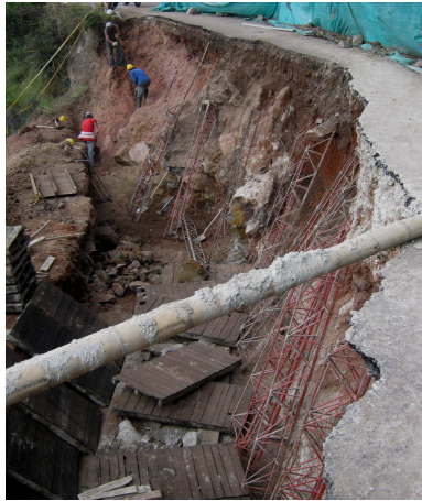
Figura 124 Etapa de demolición e inicio de la disposición de la formaleta para la etapa constructiva
