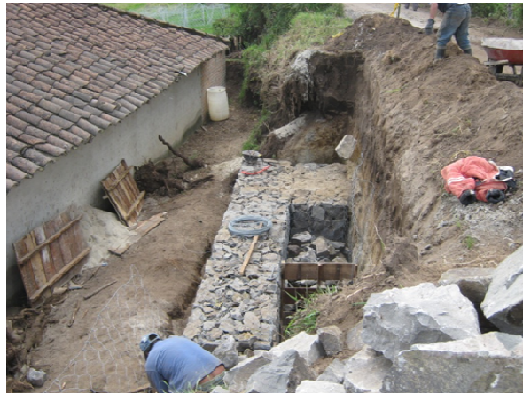
Figura 118. Etapa constructiva del muro de contención en gaviones
