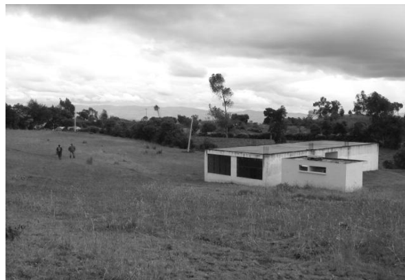
Figura 76. Estado Inicial, localización del lugar donde se proyecta la obra y estructura existente
