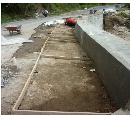
Figura 130 Proceso de construcción de las cunetas
