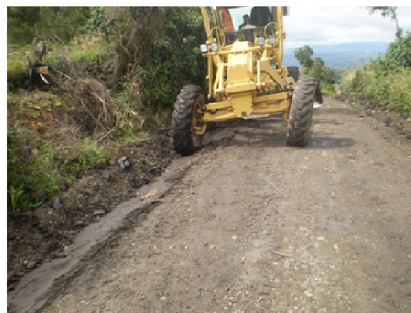
Figura 111. Conformación de cunetas con utilización de la moto niveladora
