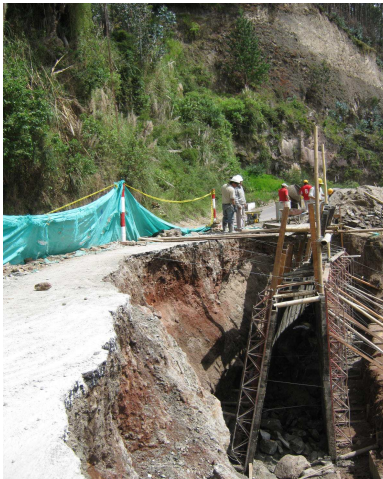
Figura 125 Etapa de construcción del muro de contención
