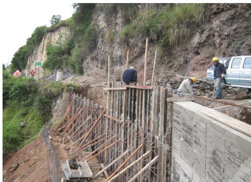
Figura 126 Proceso de construcción del muro (encofrado)
