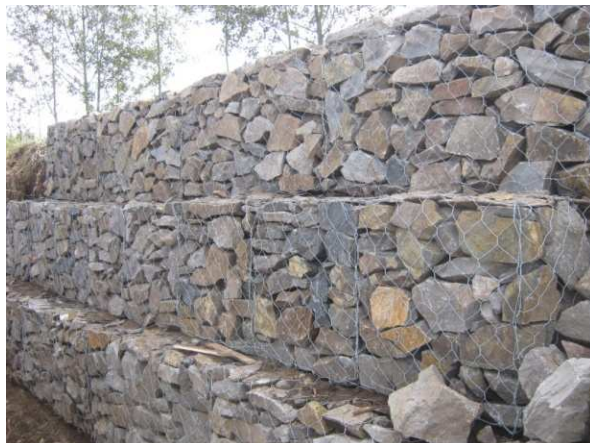
Figura 119. Muro de contención en gaviones construido en su totalidad
