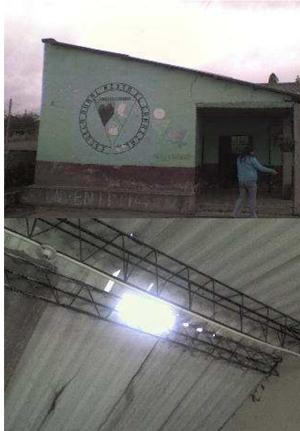
Figuras 8 y 9. Evidencia del estado actual del Centro Educativo Carrizal
