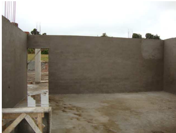
Figura 91. Aspecto general del repello de muros
