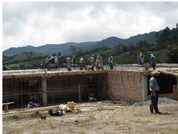
Figura 98. Ejecución de los trabajos con colaboración de los habitantes de la zona
