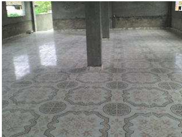
Figura 22. Enchape del piso del restaurante escolar
