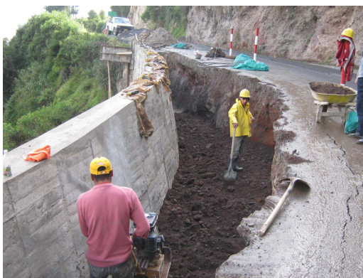
Figura 127 Disposición y compactación de material de afirmado
