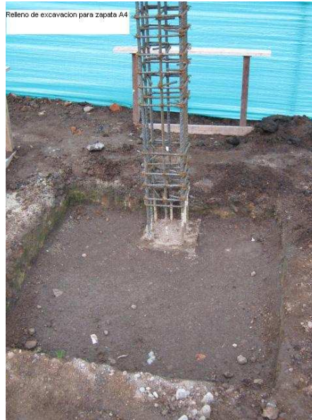
Figura 49. Relleno de excavación para zapatas
