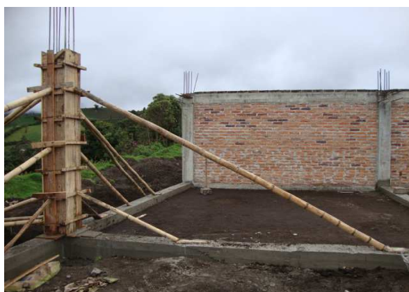
Figura 87. Encofrado de Columna
