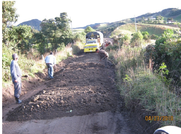
Figura 109. Extendida de material en obra, mediante mano de obra
