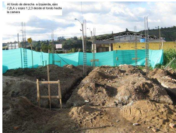
Figura 45. Localización de la cimentación y montaje de estructuras
