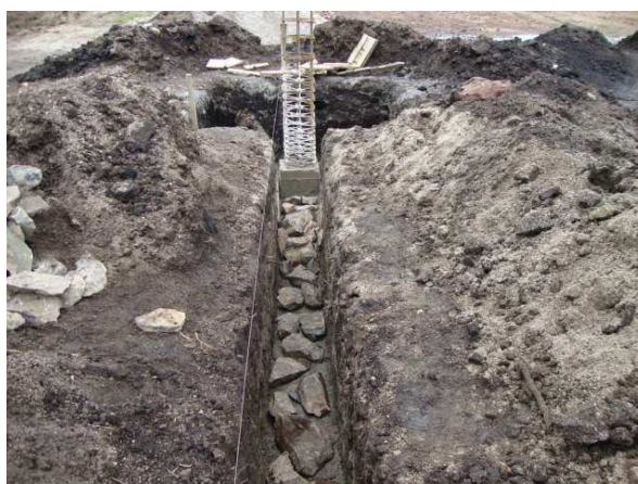
Figura 85. Proceso constructivo de vigas de cimentación
