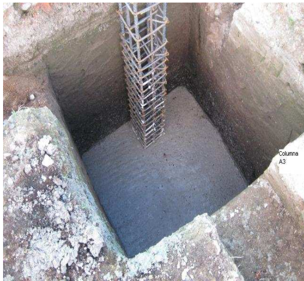
Figura 48. Fundición de zapatas
