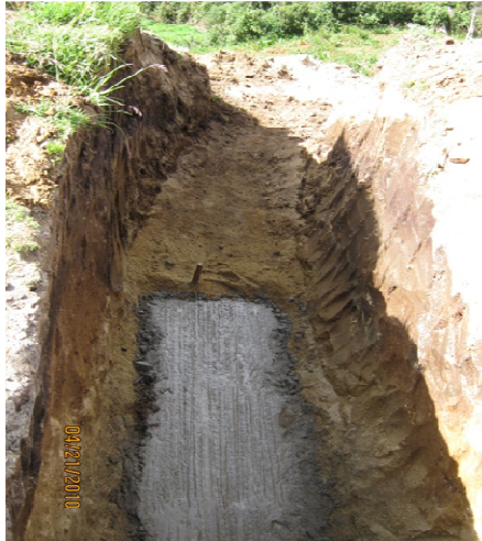
Figura 115. Fundición de solados para la colocación de tubería
