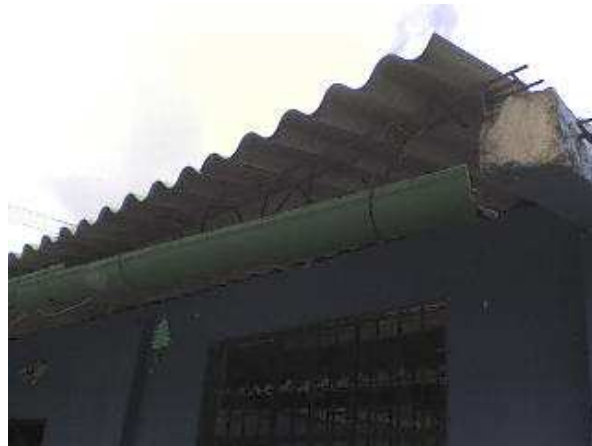
Figura 15. Estructura actual de la cubierta
