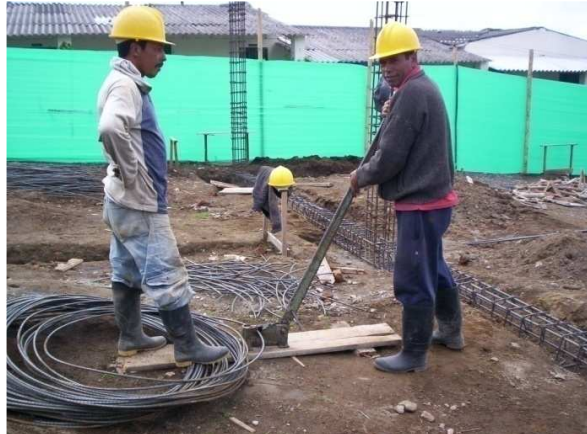
Figura 46. Corte de acero de refuerzo
