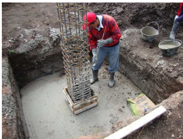
Figura 84. Proceso constructivo de zapatas
