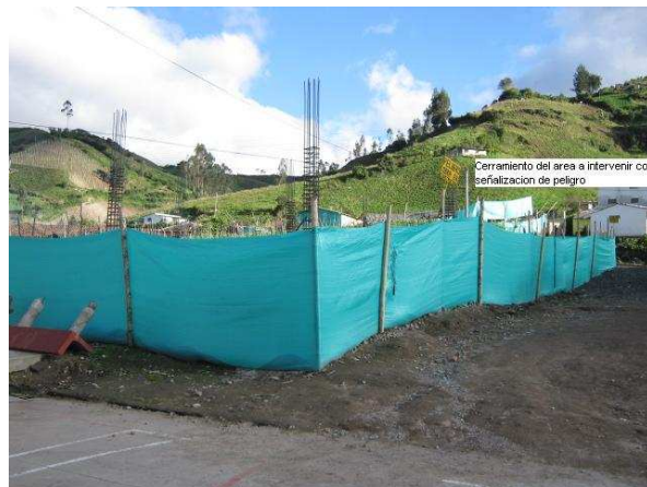
Figura 43. Cerramiento del área de construcción
