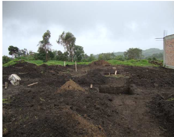
Figura 78. Excavaciones para construcción de cimentación
