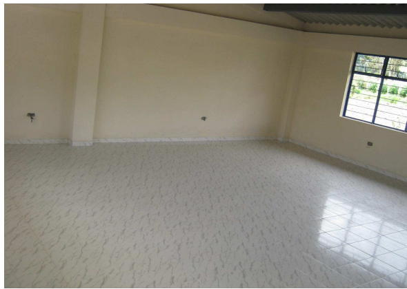
Figura 69. Piso de aulas con terminación en cerámica
