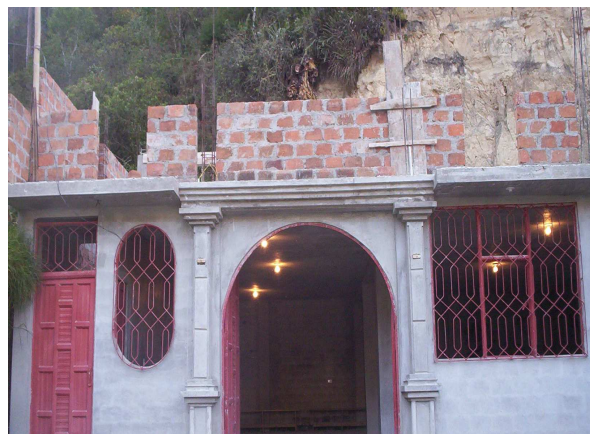
Figura 32. Estado actual del salón comunal Frontales
