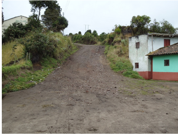
Figura 107. Estado Inicial Vía Santa Rosa San Antonio
