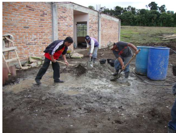
Figura 82. Proceso de mezclado manual de concreto
