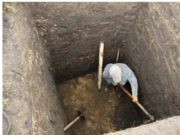
Figura 79. Profundidad de la excavación
