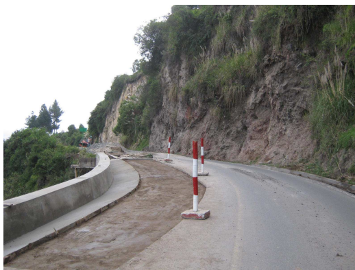
Figura 131 Muro, base y cunetas terminadas
