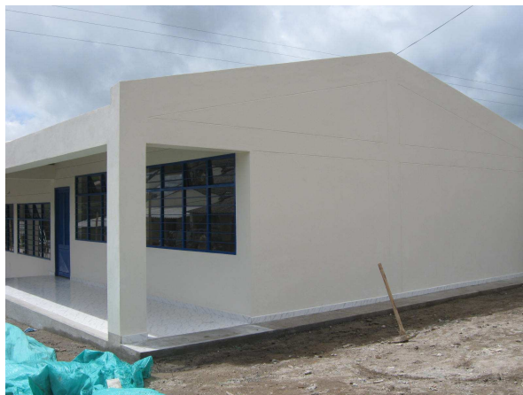
Figura 71. Pintura exterior de las aulas
