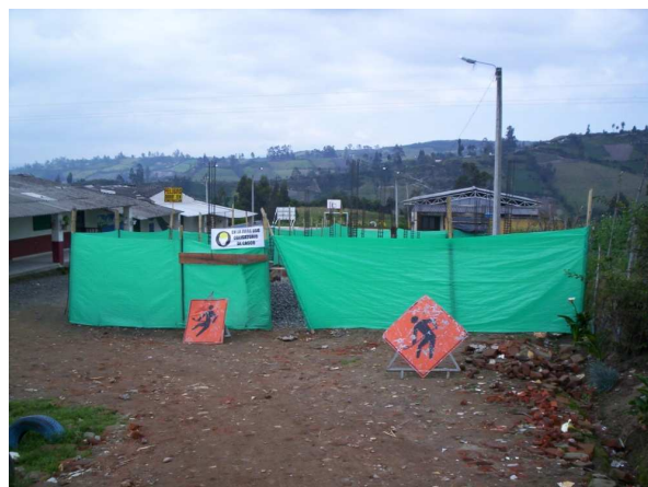
Figura 44. Señalización preventiva en los alrededores del área construir
