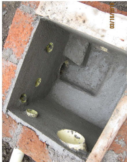
Figura 63. Terminado interno de la caja de inspección
