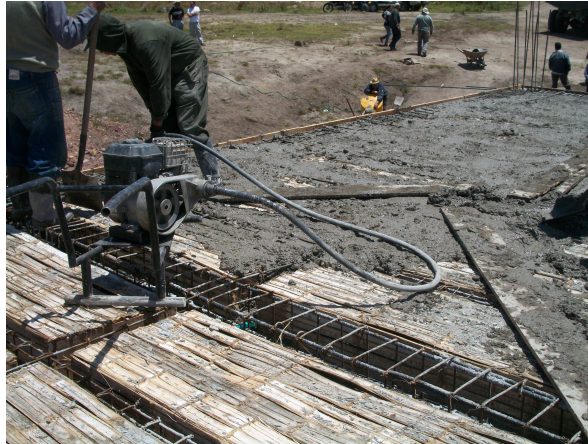
Figura 99. Utilización de vibrador en la fundición de la losa
