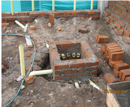
Figura 62. Construcción de cajas de inspección
