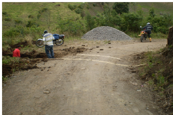
Figura 114. Inicio de los trabajos de excavación para la construcción de alcantarillas
