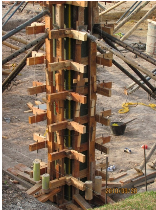
Figura 2 – Columna con formaleta en tablemac
