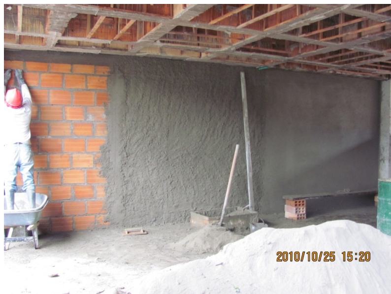
Figura 28 – Repello de muro interno.
