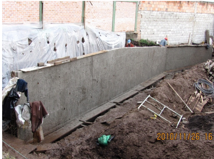
Figura 38 – Fundición de muro de contención preescolar.
