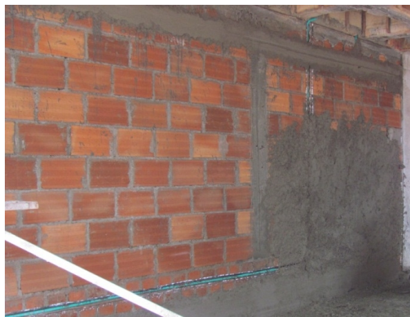
Figura 27 – Confinamiento de muros con columnetas y viguetas.
