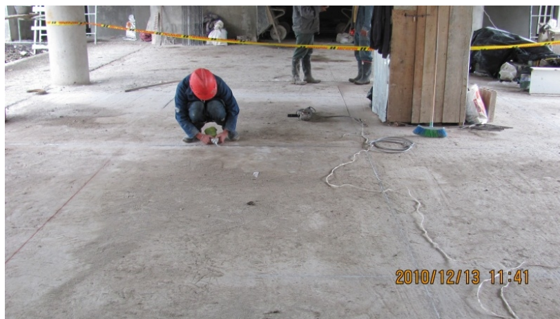
Figura 45 – Aplicación del sellador de la junta.
