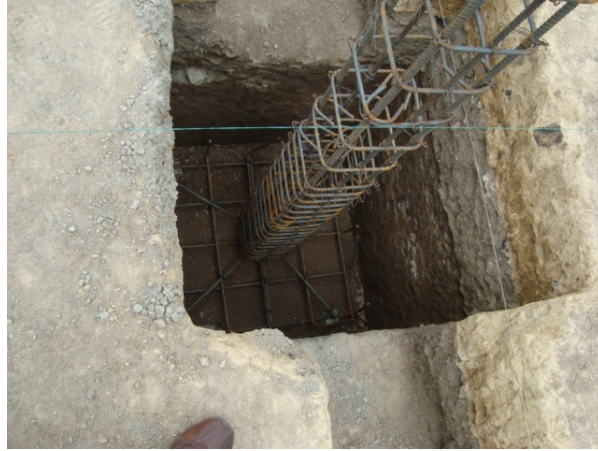
Figura 9 – Zapata lista para su fundición.
