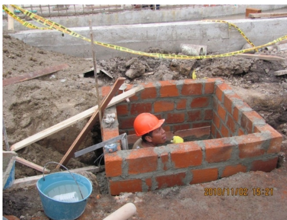
Figura 36 – Construcción de caja de inspección para alcantarillado.
