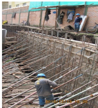
Figura 37 – Encofrado muro contención preescolar.
