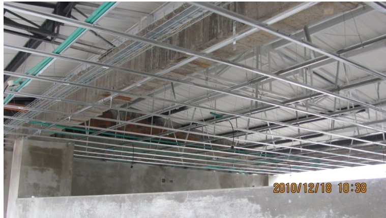
Figura 46 – Instalación de ángulo y perfiles del cielo falso.
