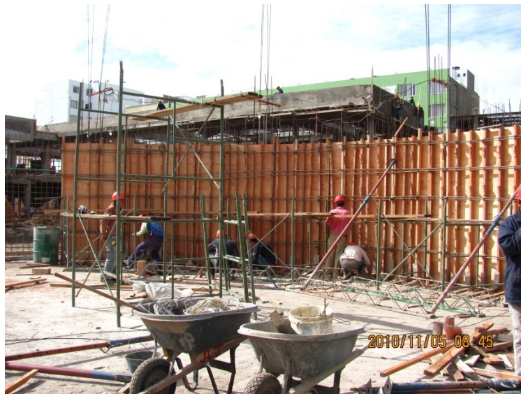
Figura 21 – Formaleta circular de muros de capilla
