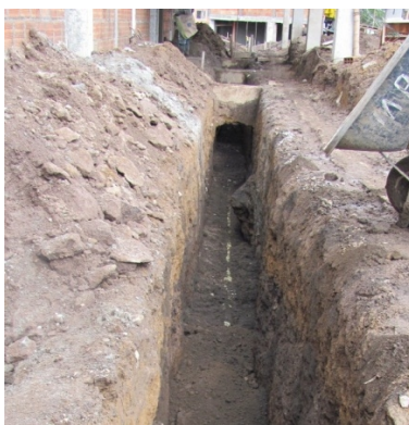
Figura 35 – Relleno de la zanja sobre la cota clave del tubo.
