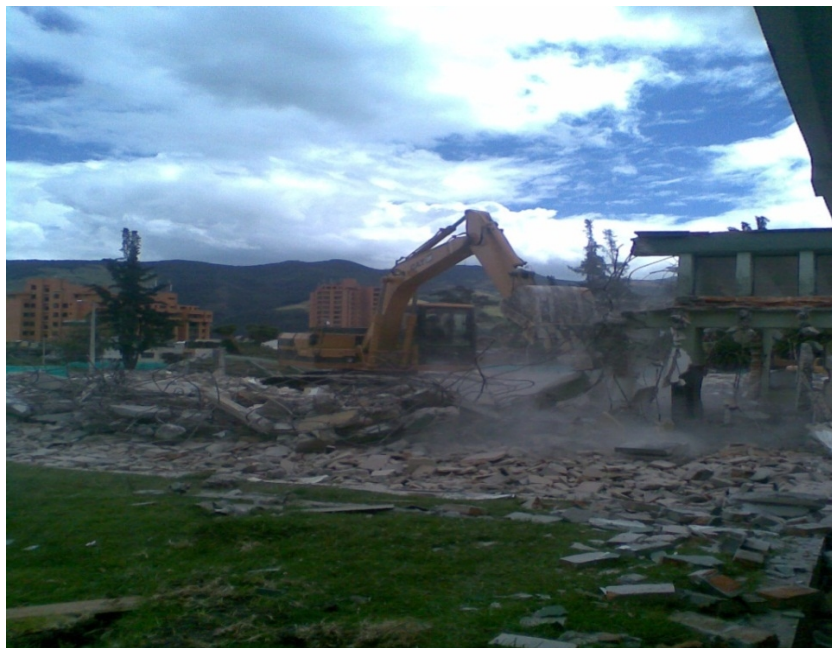
Figura 5 – Demolición de instalaciones existentes antiguo colegio
