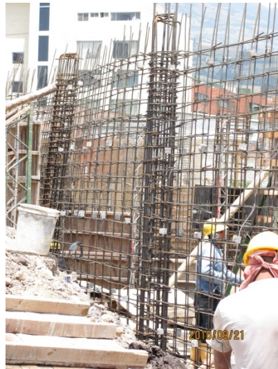
Figura 17 – Conformación del hierro bloque muro de contención central 3.
