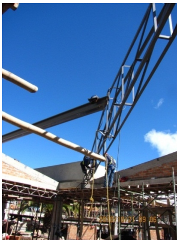
Figura 19 – Instalación de cercha metálica
