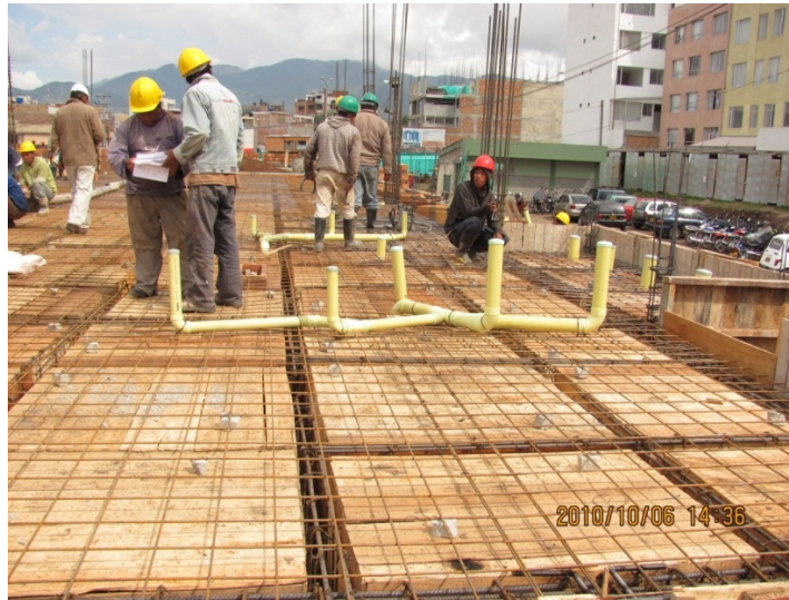
Figura 30 – Instalaciones hidrosanitarias dentro de las losas aligeradas.
