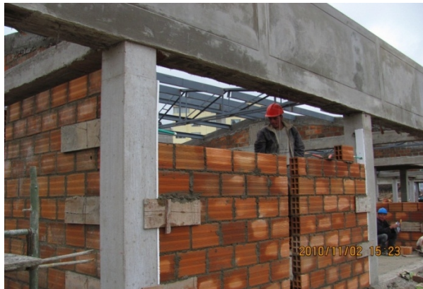
Figura 23 – Pega de mampostería
