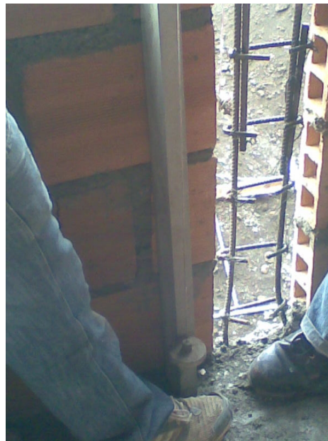
Figura 24 – Revisión de verticalidad del muro
