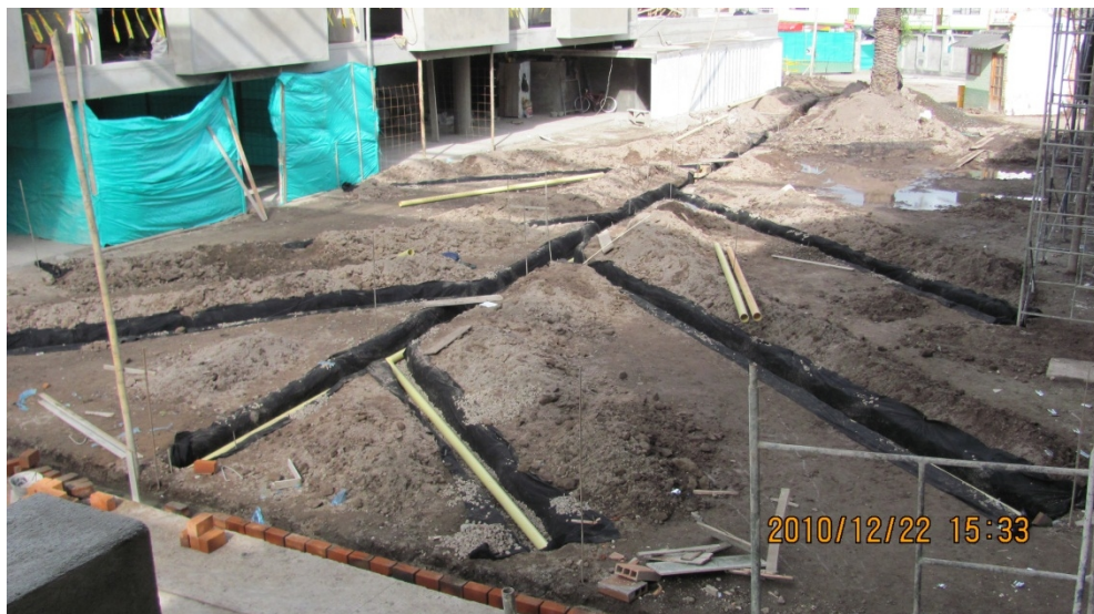
Figura 33 – Instalación de filtro 4"
