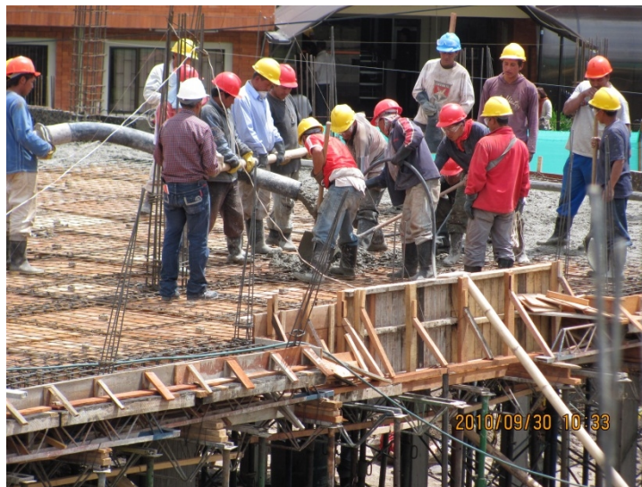
Figura 16 – Fundición de losa aligerada
