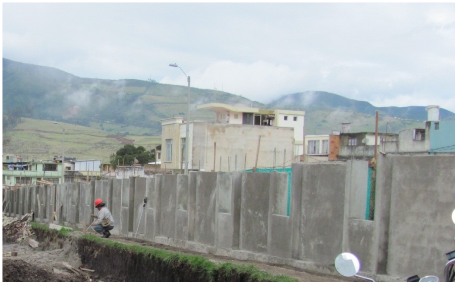
Figura 39 – Muro de cierre principal.
