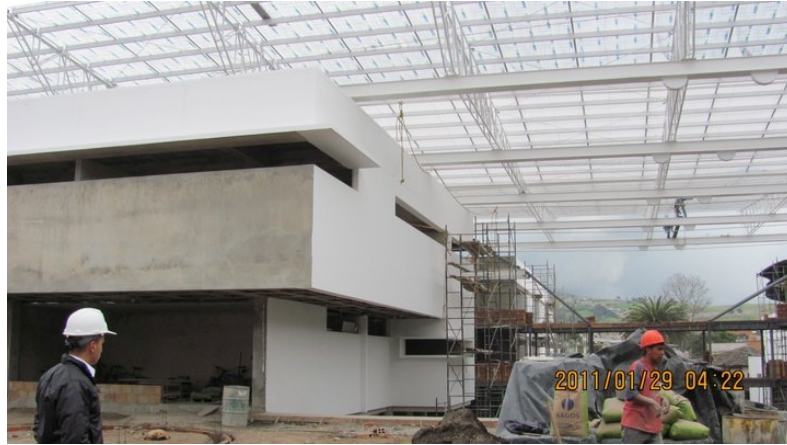
Figura 41 – Cubierta principal en policarbonato.
