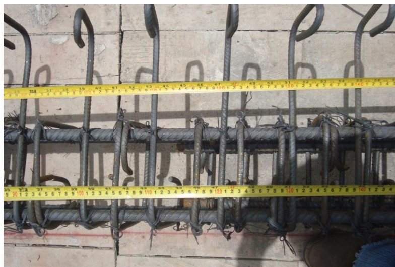
Figura 11 – Verificación de distanciamiento de flejes viga canal.
