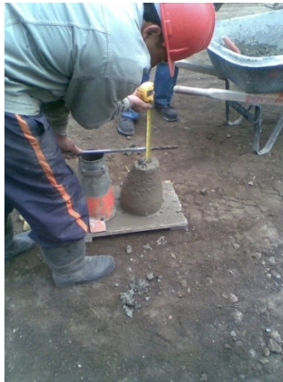
Figura 18 – Ensayo de consistencia del concreto (slump).
