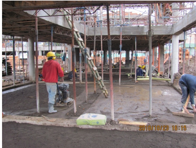
Figura 31 – Compactación de suelo con recebo para fundición de placa de contrapiso.
