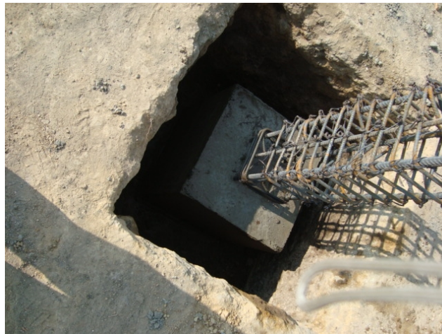
Figura 10 – Fundición de zapata y pedestal.
