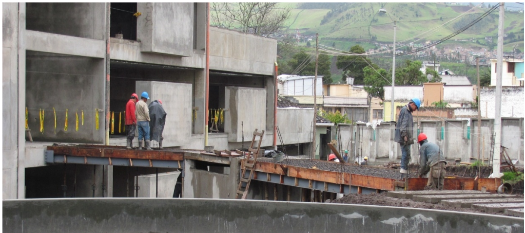
Figura 40 – Rampa de acceso a bloque central 1.
