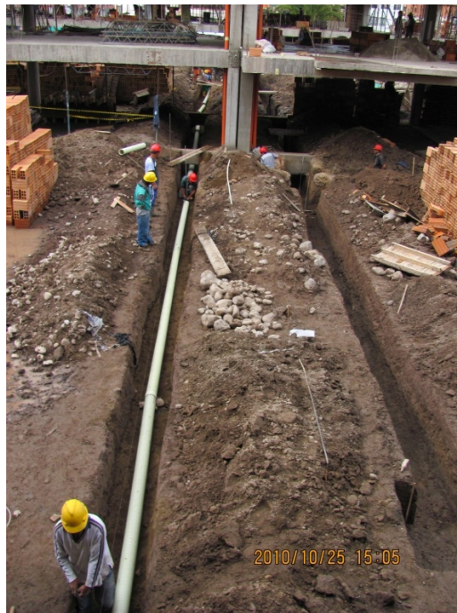
Figura 34 – Instalación de tubería novafort 8"
