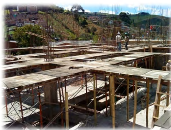
Ilustración 23. Instalación de formaleta y apuntalamiento de la Losa
