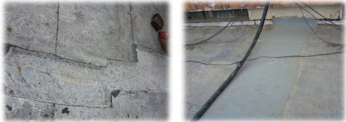
Ilustración 15. Arreglo junta de dilatación
