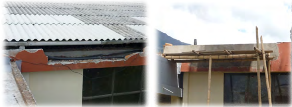
Ilustración 6. Reparación muro en ladrillo
