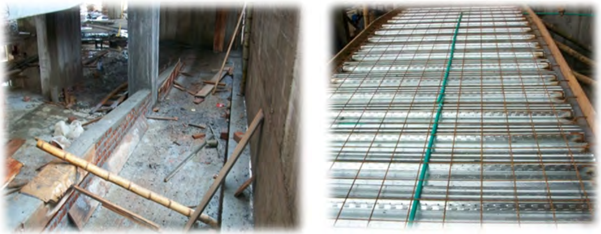
Ilustración 43. Armado y construcción de la rampa en los primeros tramos
