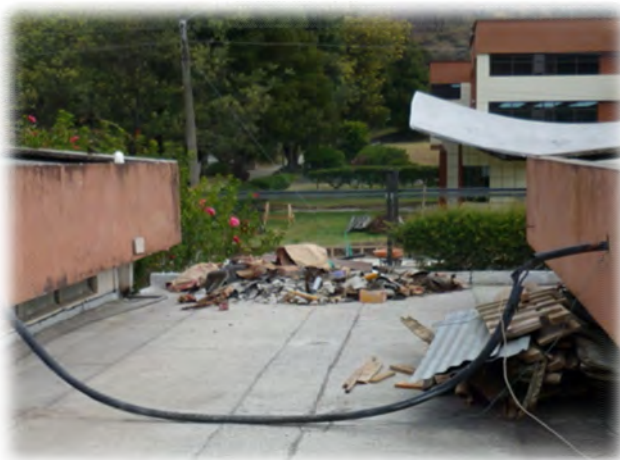
Ilustración 14. Aseo de la losa
