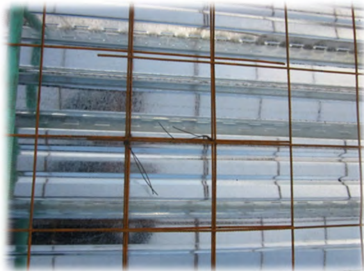
Ilustración 26. Instalación de malla electrosoldada, separación del metaldeck mediante panelas de mortero
