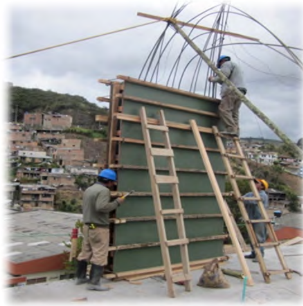
Ilustración 20. Encofrado de pantallas
