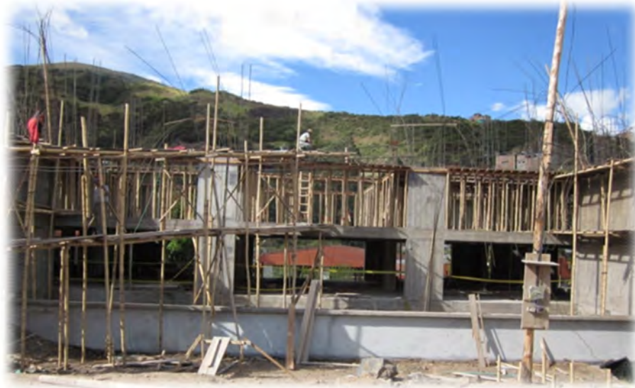
Ilustración 17. Estado Inicial de la zona de Intervención
