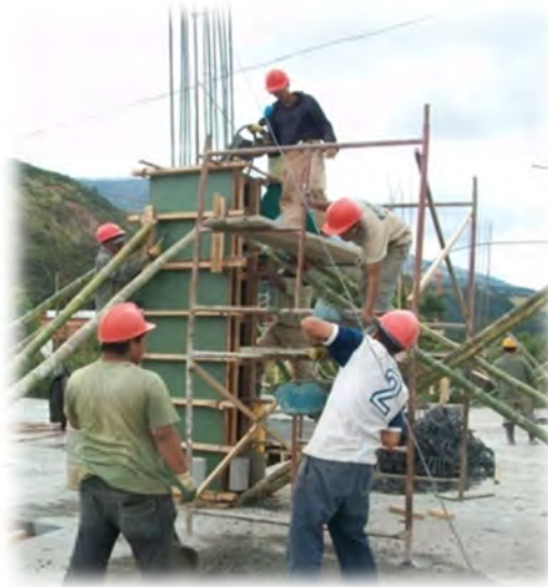
Ilustración 19. Encofrado de columnas
