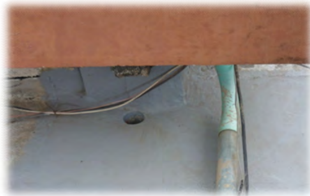
Ilustración 16. Impermeabilización entrada de bajantes
