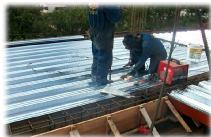
Ilustración 24. Soldadura de conectores de cortante d = \frac{1}{2} " sobre los perfiles metálicos
