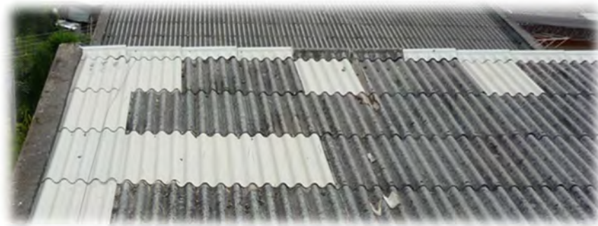
Ilustración 8. Reposición de caballetes en fibrocemento
