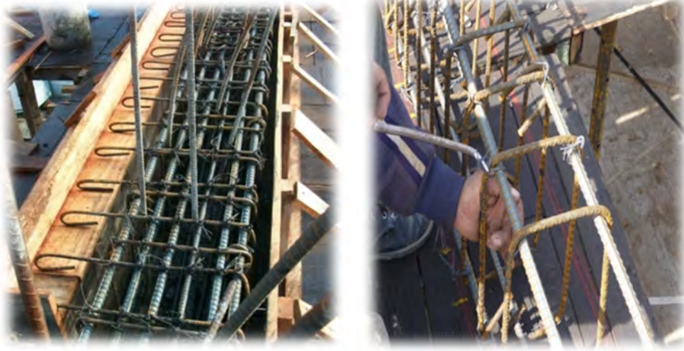
Ilustración 22. Armado de refuerzo volados fachada
