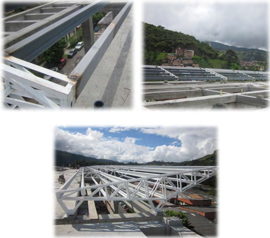
Ilustración 57. Instalación de correas 220X80
