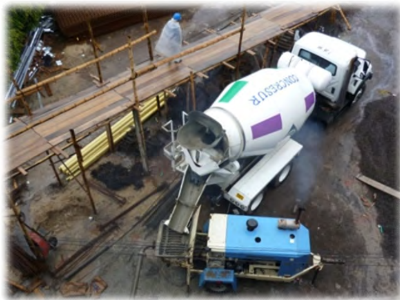
Ilustración 35. Concreto premezclado bombeado
