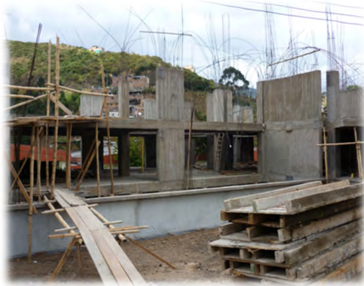
Ilustración 2. Estado actual de bloque aulas y tecnología zona centro
