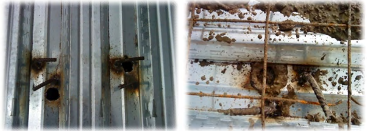
Ilustración 27. Agujeros dentro del perfil metálico para el llenado de concreto
