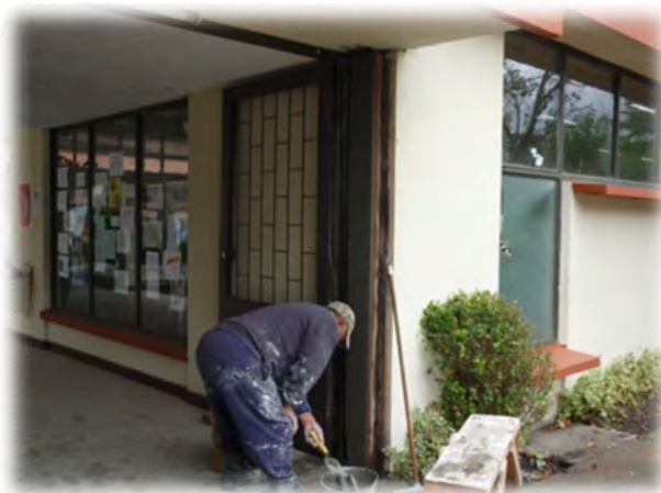
Ilustración 5. Reemplazo de bajante
