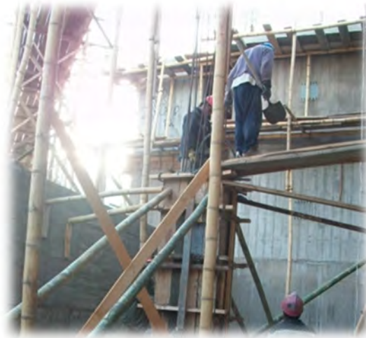
Ilustración 45. Fundición de viga rampa
