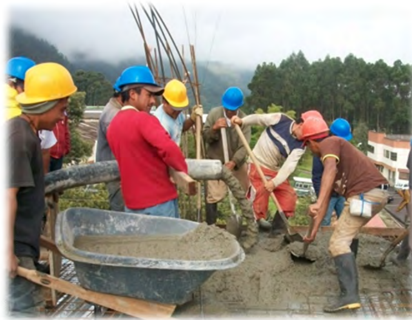
Ilustración 37. Fundición de placa maciza con concreto premezclado
