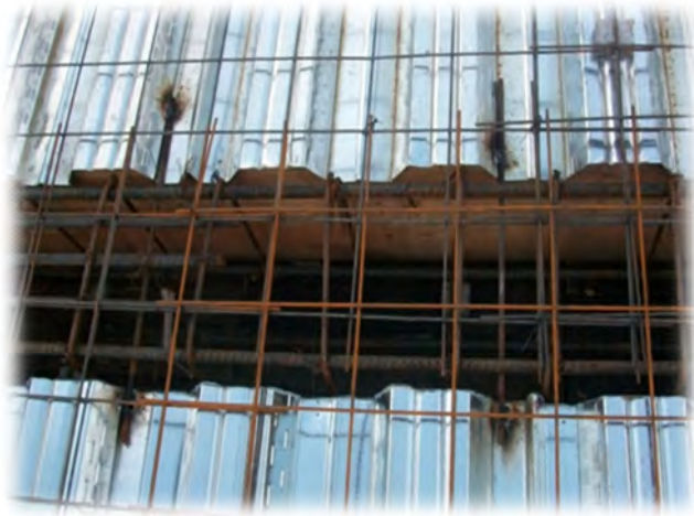
Ilustración 25. Instalación de varillas de diámetro d=3/8'' sobre las vigas de concreto.
