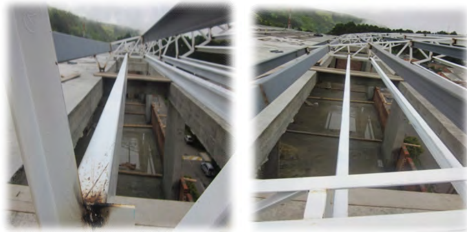
Ilustración 58. Instalación de correas 120X60
