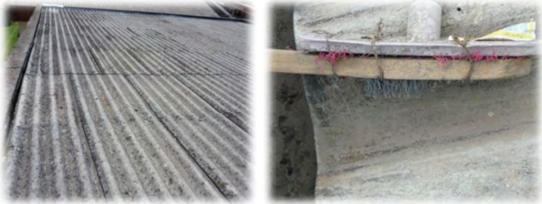
Ilustración 4. Limpieza de tejas fibrocemento con cepillo e acero
