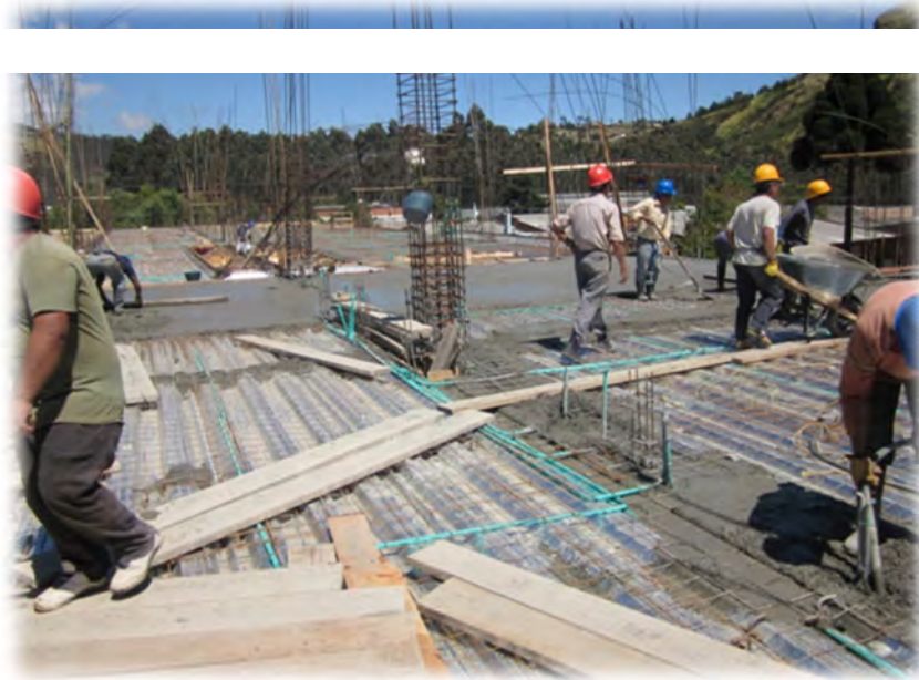
Ilustración 29 Caminos en tabla para proteger el metaldeck en fundición
