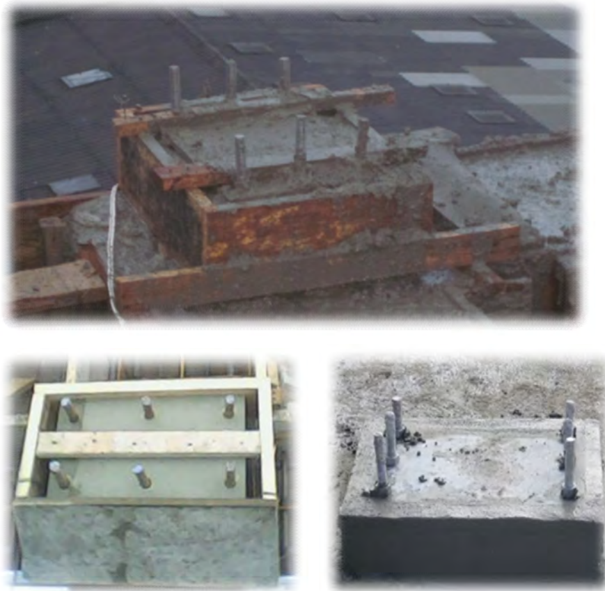
Ilustración 40. Instalación de platinas de cubierta
