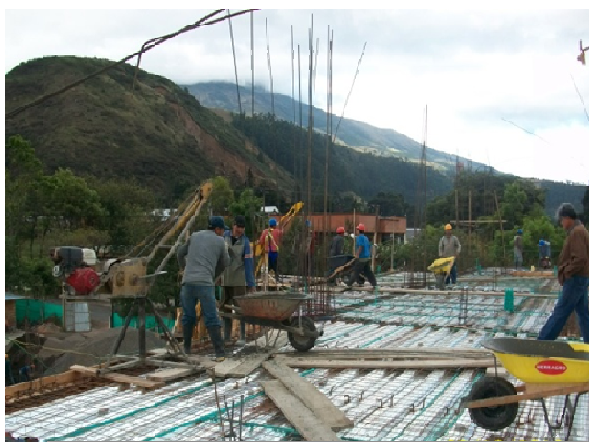
Ilustración 14. Caminos en tabla para proteger el metaldeck en fundición
