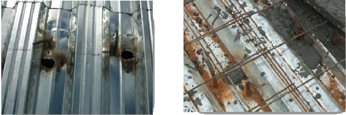
Ilustración 13. Agujeros dentro del perfil metálico para facilitar llenado de concreto
