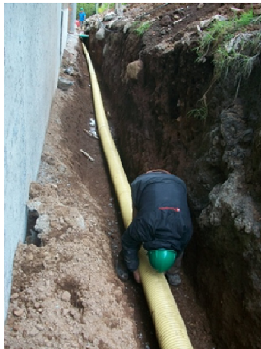
Ilustración 40. Instalación tubería estructurada de 8"
