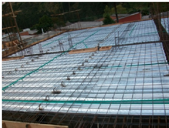
Ilustración 12. Instalación de malla electro soldada, separación del metaldeck mediante panelas de mortero
