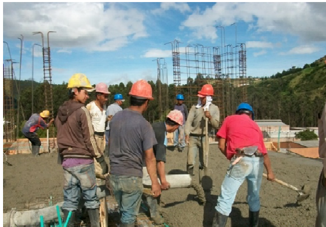
Ilustración 24. Fundición de placa maciza con concreto premezclado
