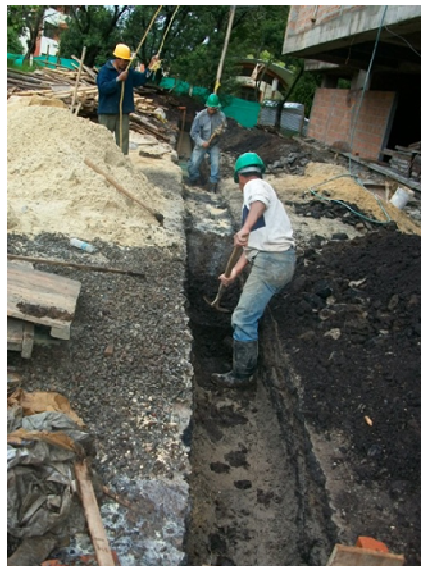
Ilustración 46. Desalojo de placa de asfalto
