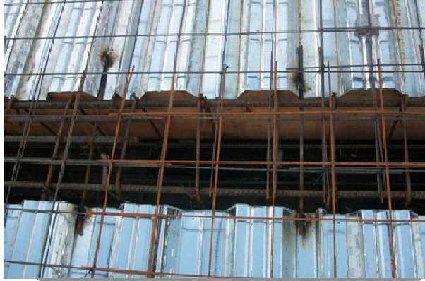
Ilustración 11. Instalación de varillas de diámetro d=3/8 " sobre las vigas de concreto.
