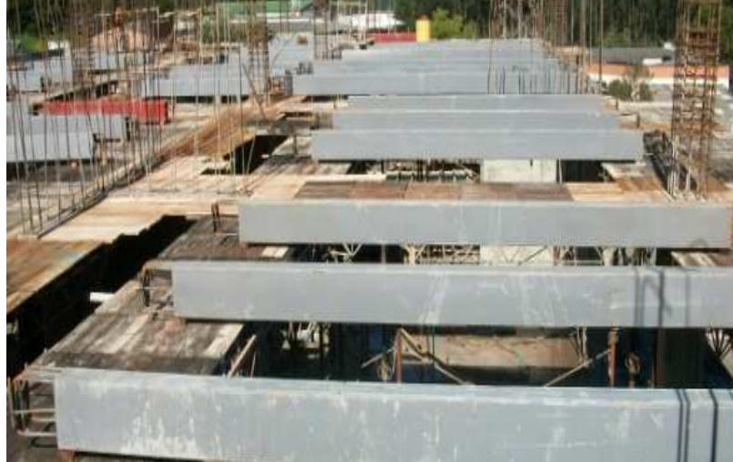
Ilustración 21. Perfiles en cajón y pintados con anticorrosivo
