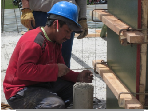
Ilustración 5. Encofrado de columnas y pantallas
