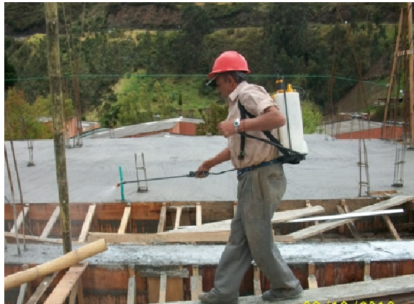
Ilustración 25. Curado de concreto con aditivo Antisol
