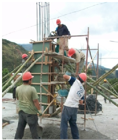
Ilustración 6. Fundición de columnas y pantallas
