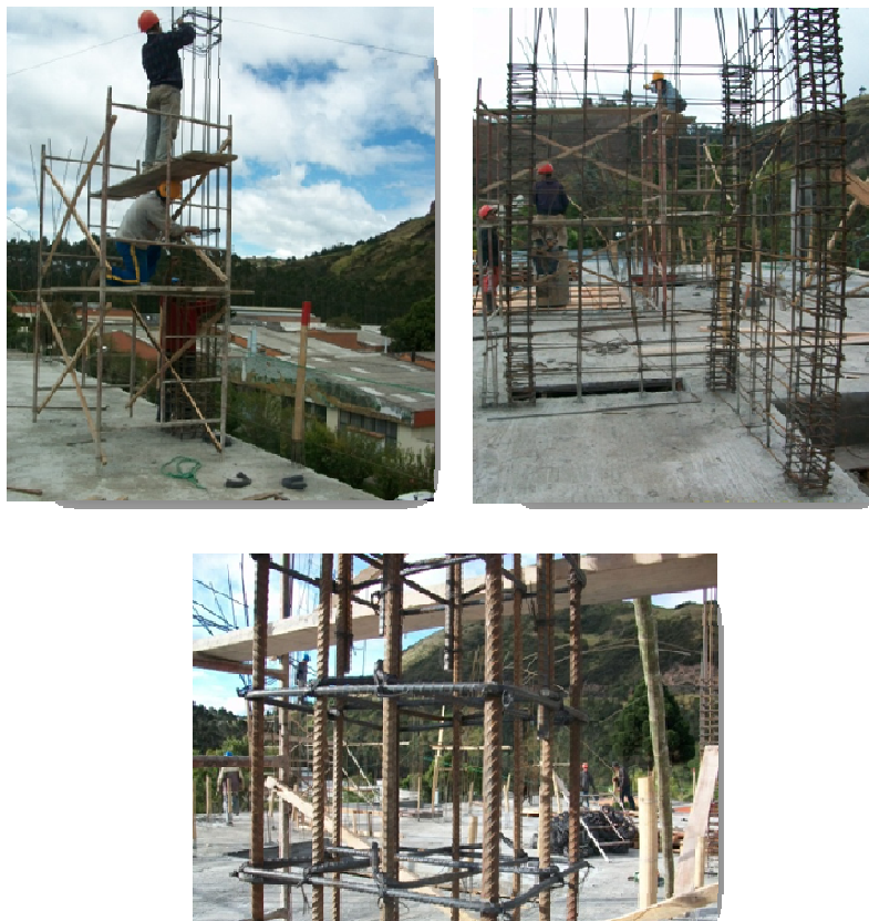
Ilustración 3. Armado de refuerzo columnas y pantallas
