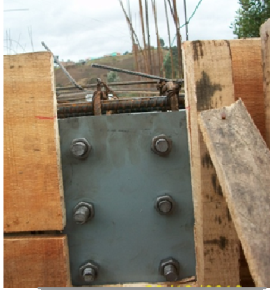
Ilustración 27. Instalación de platinas de escalera
