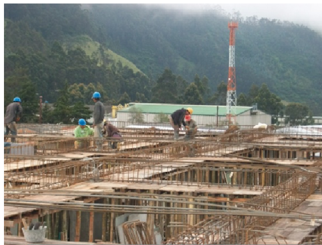
Ilustración 7. Armado refuerzo vigas aéreas
