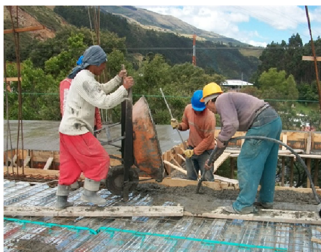
Ilustración 17. Uso del vibrador en la fundición de losa de concreto monolítica: vigas, losa y perfiles
