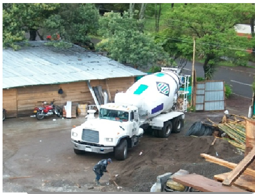
Ilustración 22. Concreto premezclado bombeado
