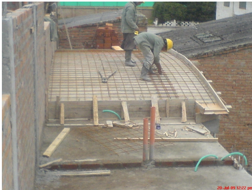
Figura 52. Armado de refuerzo de cúpula.
