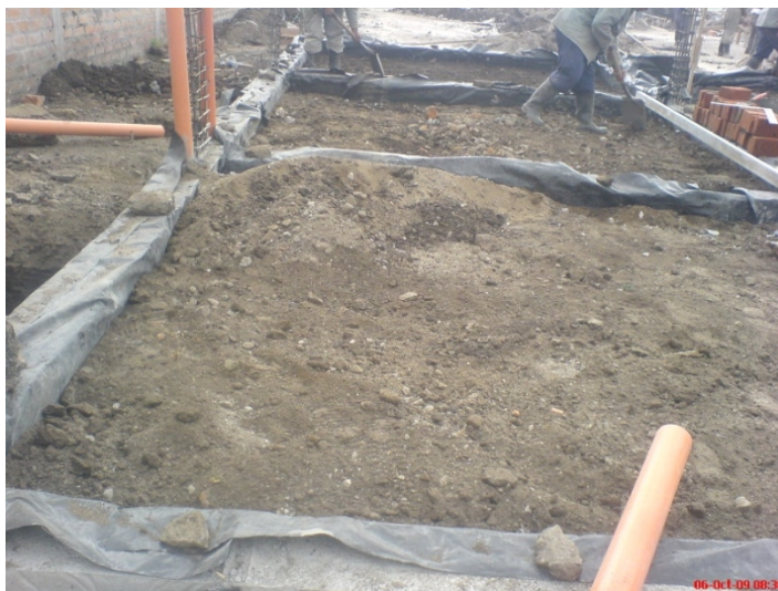
Figura 31. Relleno con recebo
