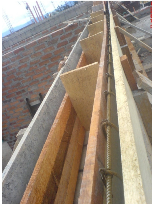
Figura 57. Tablero de viga canal
