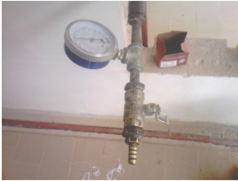
Figura 65. Manómetro para prueba de la tubería para gas.
