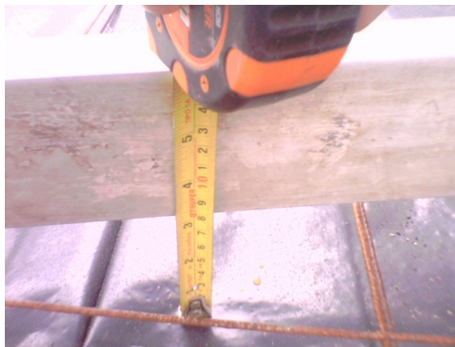
Figura 37. Nivel de losa de contrapiso
