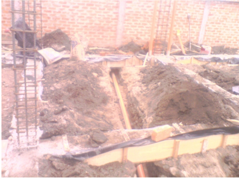
Figura 29. Tubería aguas lluvias
