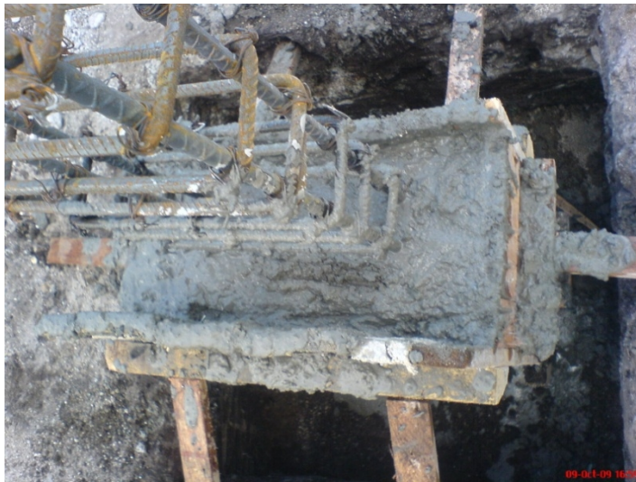
Figura 16. Fundición de pedestales
