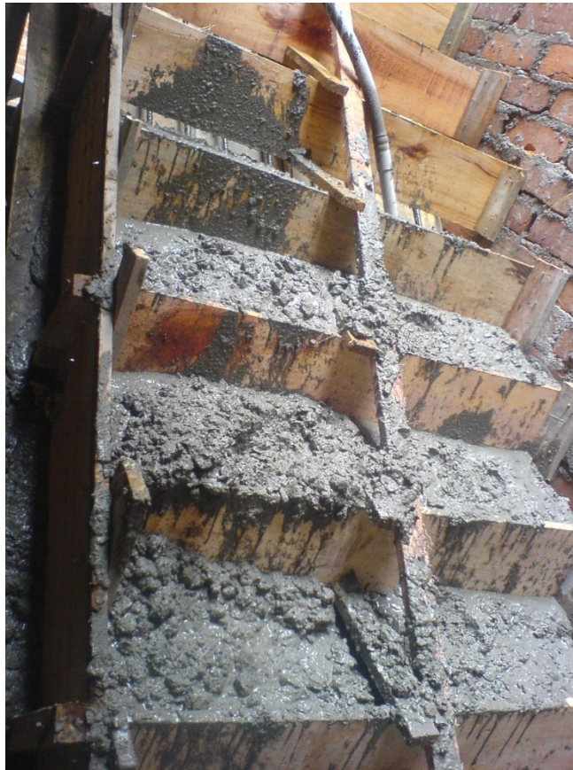
Figura 50. Fundición de escaleras
