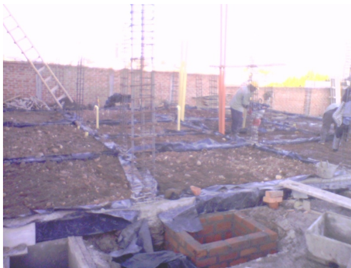
Figura 32. Nivelación y compactación
