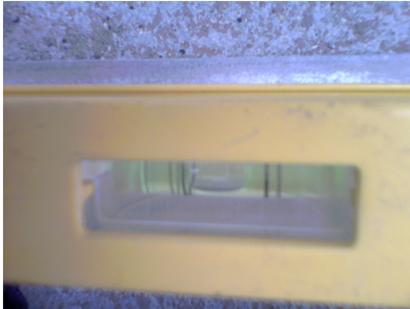
Figura 59. Medición de pendiente en repellos.
