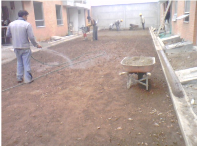
Figura 67. Cañuelas ya fundidas
