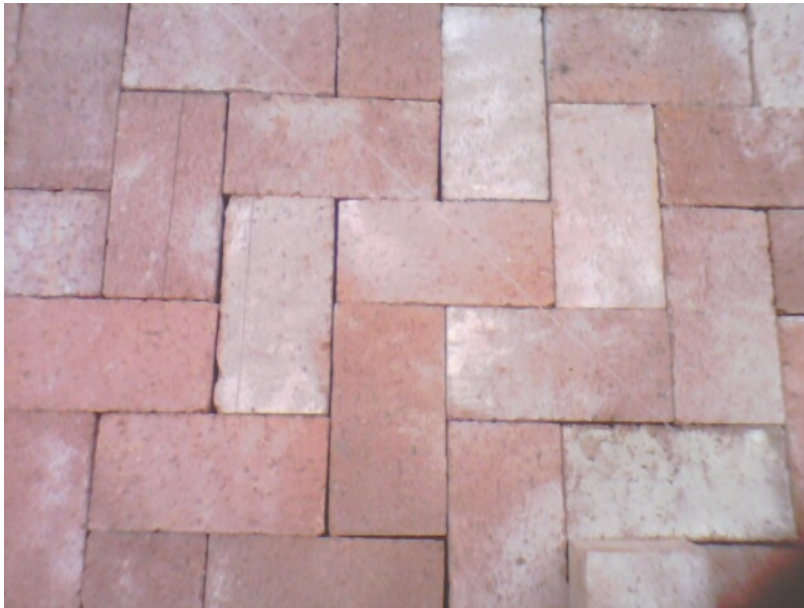
Figura 71. Adoquín ya colocado
