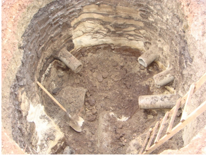
Figura 24. Tubería de alcantarillado de 10” Tubería en mortero de 6” para entrega de la casa al colector.
