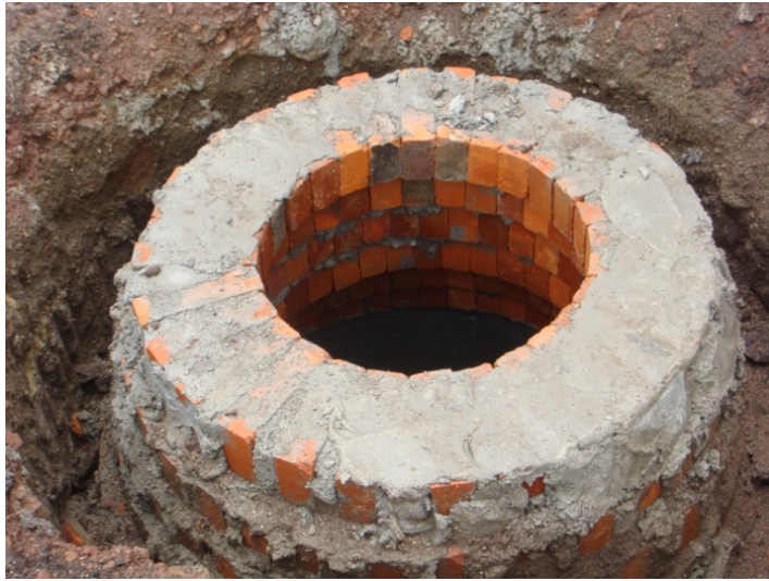
Figura 26. Pega de ladrillo pozos de inspección
