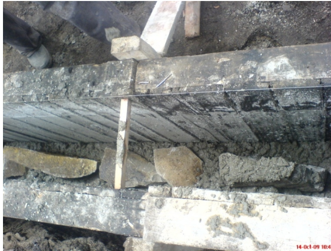
Figura 17. Fundición de muros de contención
