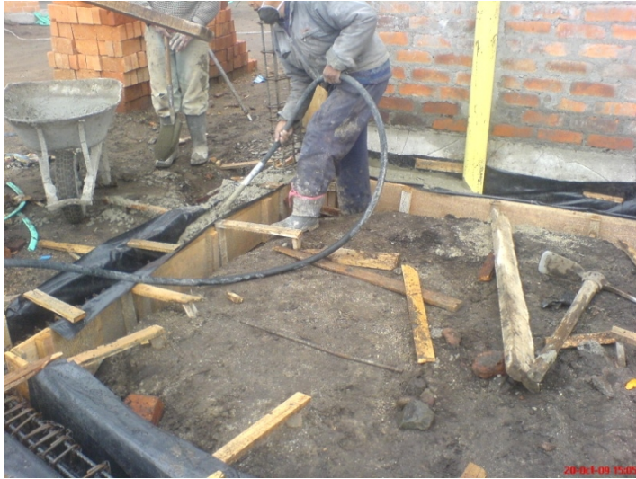
Figura 22. Fundición de vigas de cimentación
