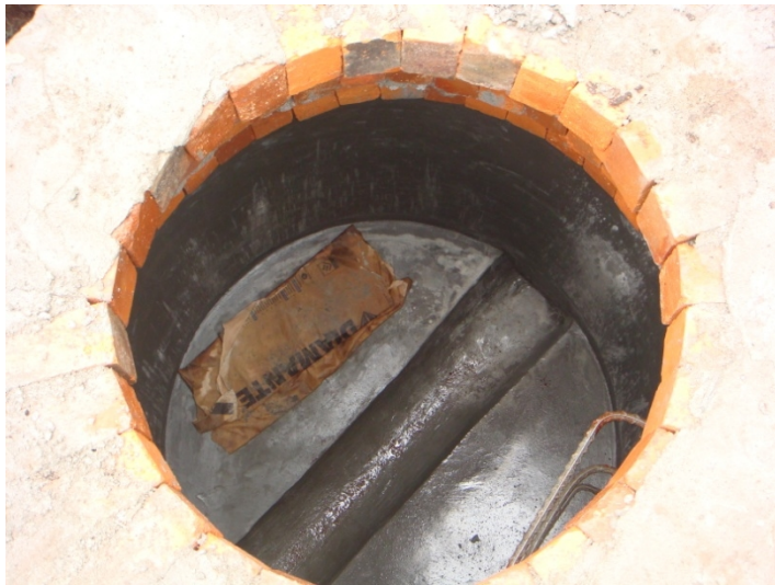
Figura 27. Pozo de inspección terminado (cañuela)
