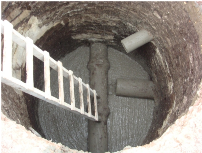
Figura 25. Solado de pozo de inspección
