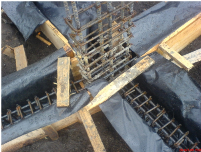
Figura 21. Plástico en vigas de cimentación
