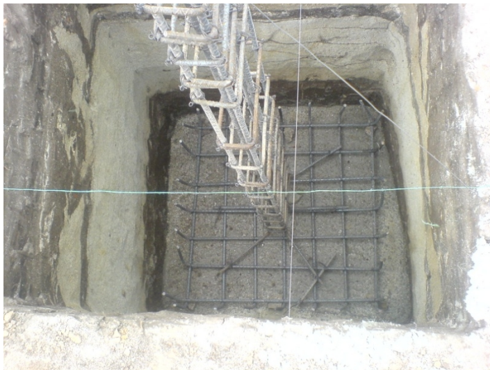
Figura 13. Amarre de parrillas y refuerzo de columnas
