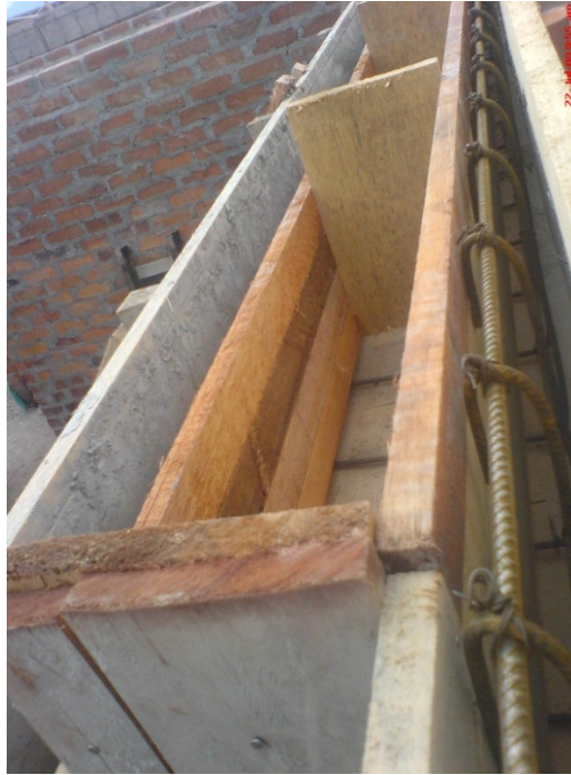
Figura 56. Refuerzo de viga canal.
