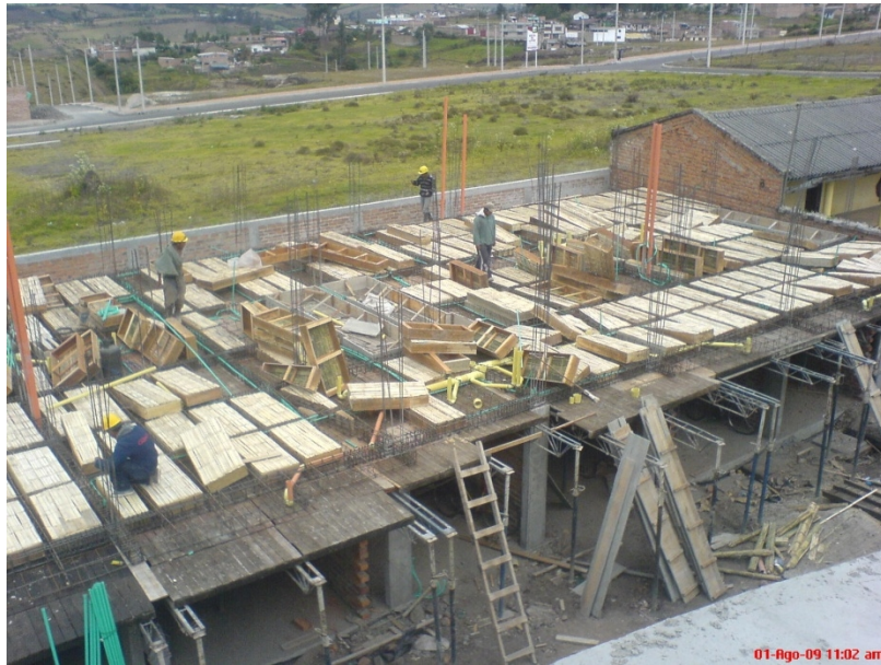
Figura 49. Colocación de casetones
