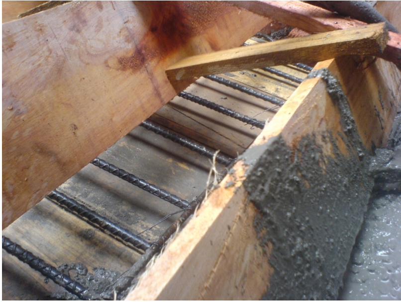
Figura 51. Refuerzo de escaleras y tablero
