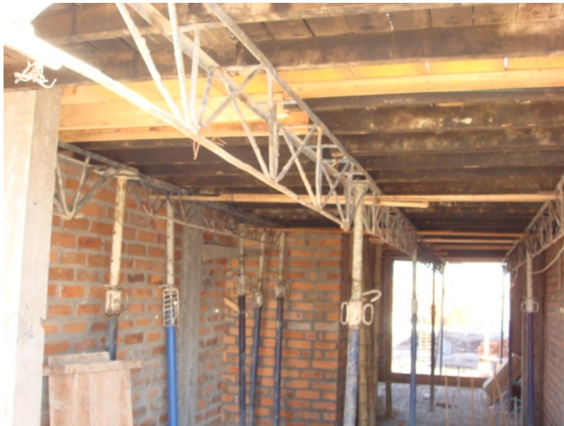
Figura 44. Formaletas, cerchas y gatos metálicos.
