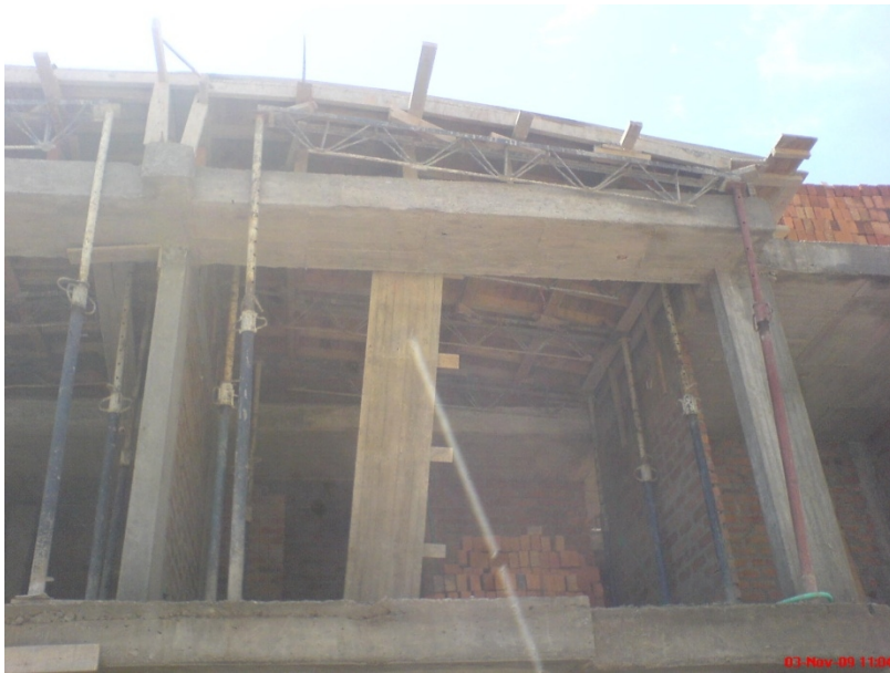
Figura 54. Cerchas y gatos metálicos
