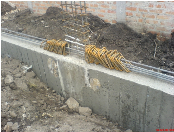
Figura 19. Muros de contención
