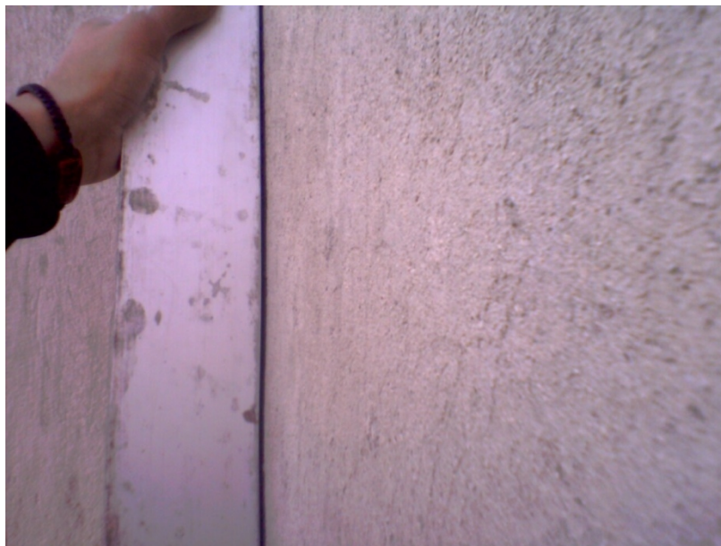
Figura 60. Comprobación de calidad de repello de muros
