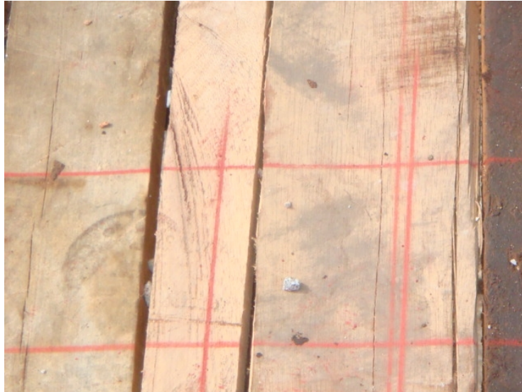
Figura 45. Cimbrado de vigas.
