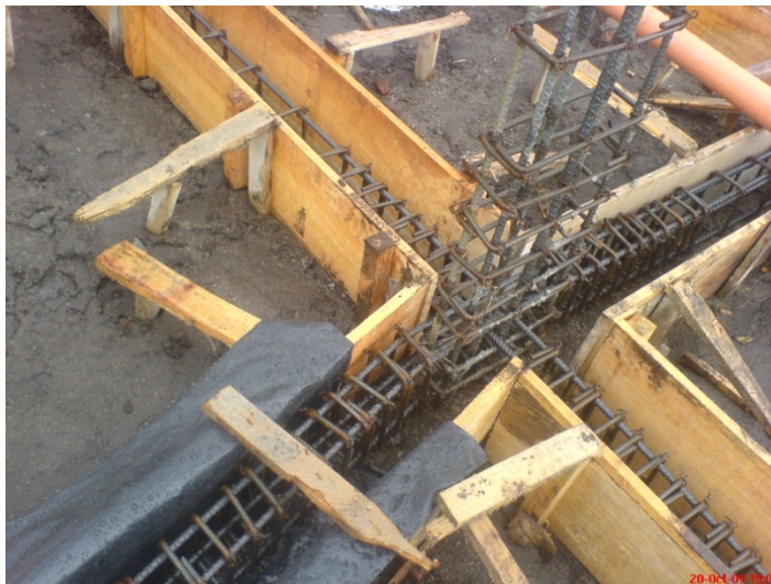
Figura 20. Tablero viga de cimentación
