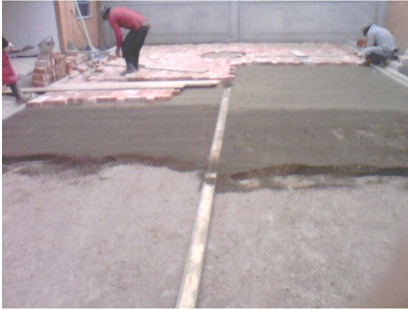
Figura 70. Colocación del adoquín sobre arena de río
