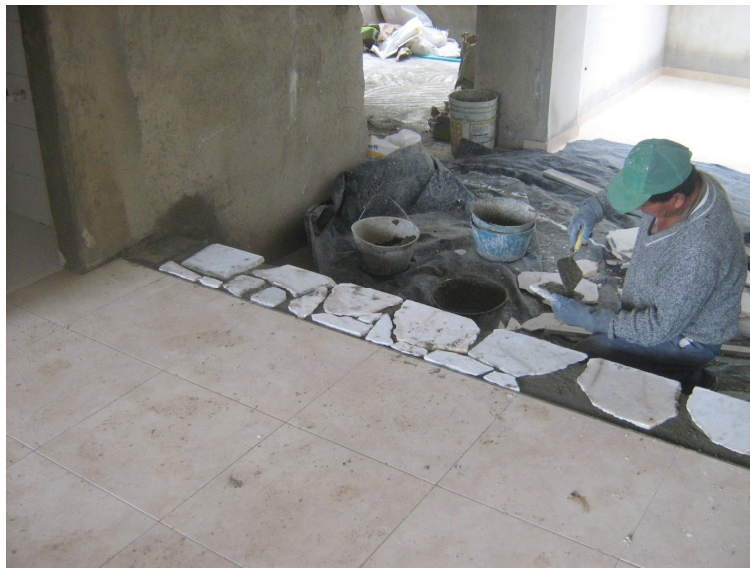
Figura 46. Preparación de mármol para gradas.
