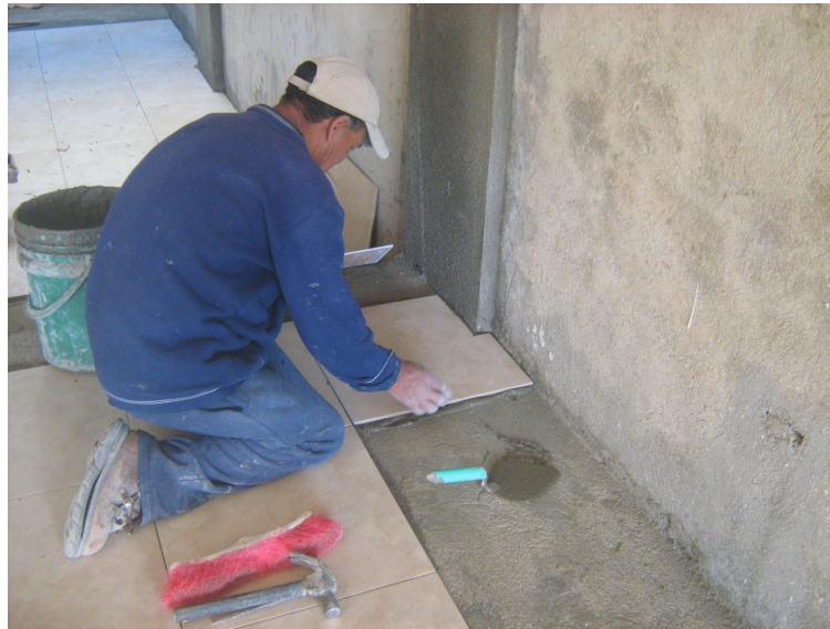
Figura 42. Selección e instalación de enchape en cerámica.
