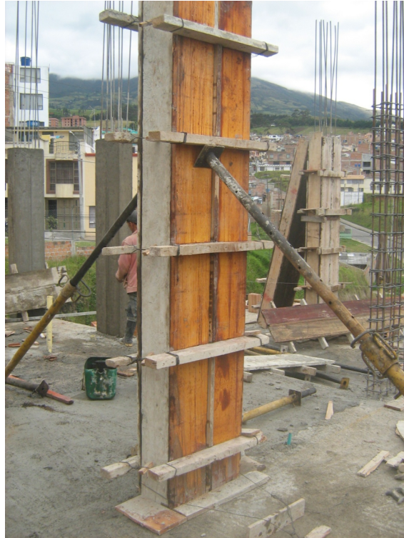
Figura 23. Formaleta en madera común de columnas.
