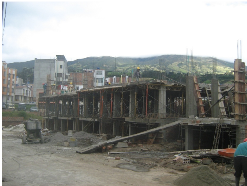
Figura 28. Armado de formaleta para fundición losa de entrepiso.
