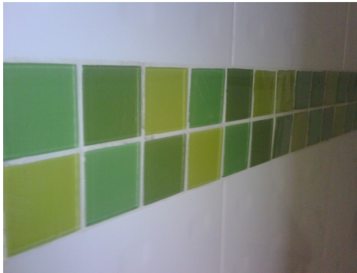
Figura 43. Selección e instalación de cenefa en vidrio.
