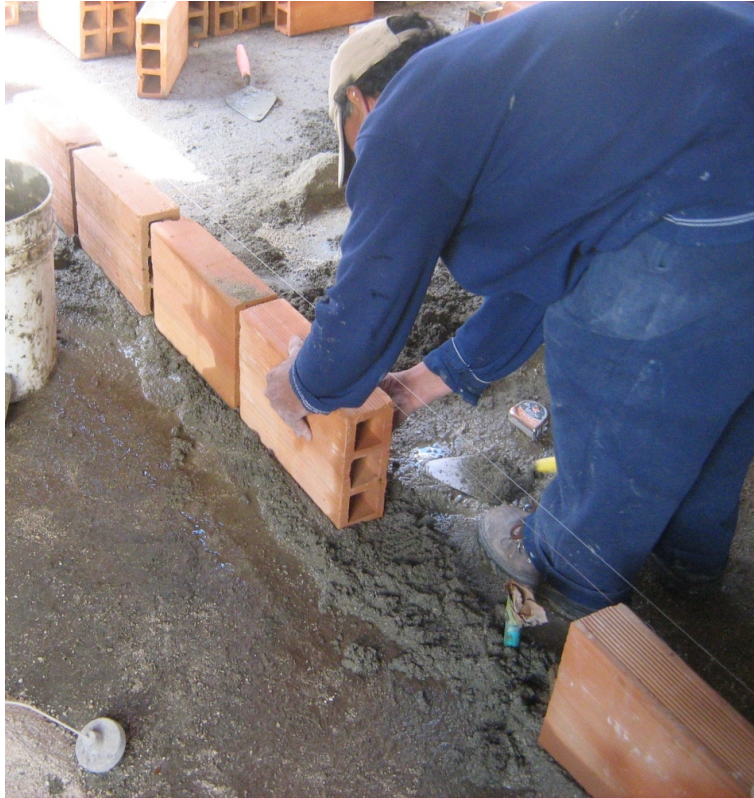
Figura 34. Supervisión en actividades de mampostería en ladrillo farol N°4.
