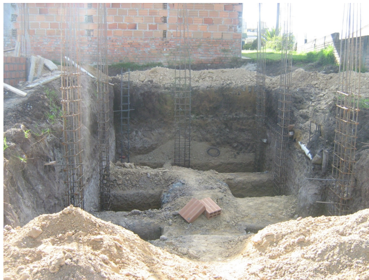
Figura 19. Excavación manual para las zapatas en semisótano de viviendas.
