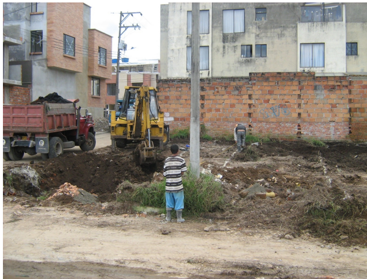
Figura 17. Actividades de localización de los lotes para iniciar los trabajos de excavación.
