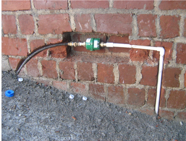
Figura 41. Instalación de medidores de agua de ½ pulgada en la vivienda tipo.
