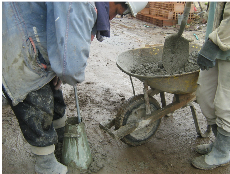
Figura 20. Supervisión en la preparación del ensayo de consistencia.
