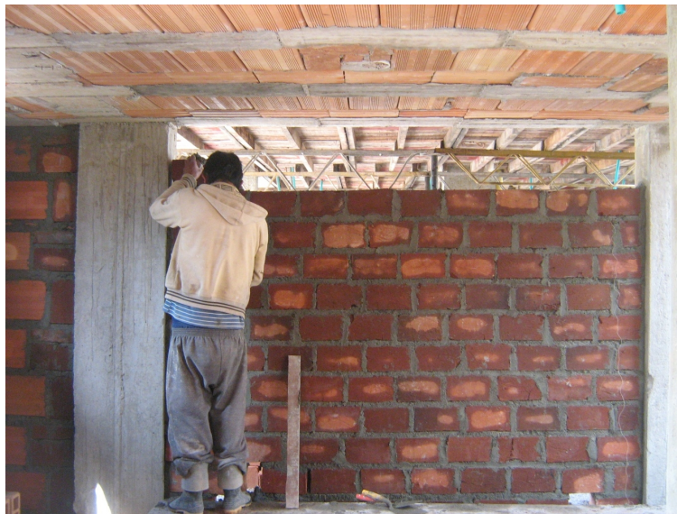
Figura 33. Revisión de verticalidad (plomo) de mampostería en ladrillo macizo doble.
