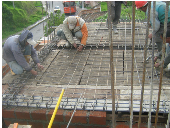
Figura 51. Supervisión en el armado del acero de refuerzo en losa maciza de vivienda tipo en manzana E.
