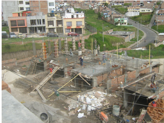
Figura 52. Vista panorámica de manzana E durante el proceso de fundición de losas de entrepiso correspondientes al primer piso.
