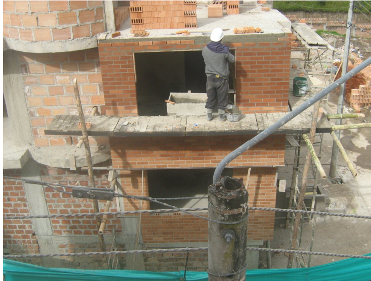
Figura 35. Mampostería en ladrillo rejilla a manera de ladrillo visto sobre fachada.
