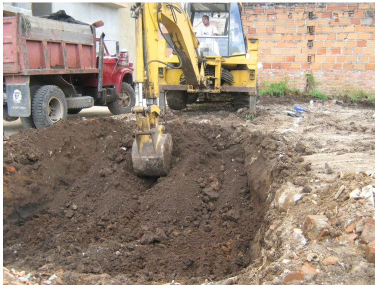
Figura 18. Excavación de semisótanos de las viviendas.
