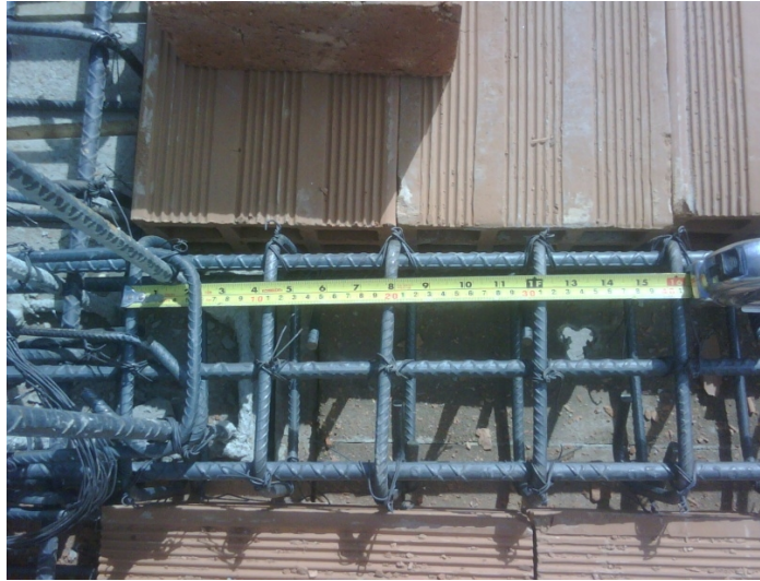
Figura 25. Revisión de separación de flejes en vigas de entrepiso.
