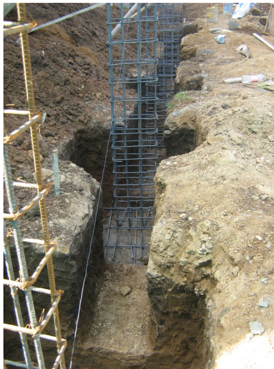
Figura 22. Excavación manual para armado y fundición de vigas de cimentación.
