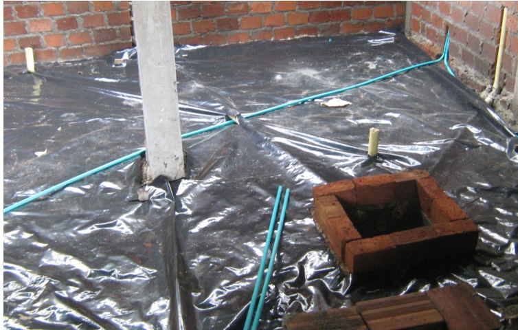
Figura 39. Instalación de tubería conduit sobre base de piso antes de fundición.
