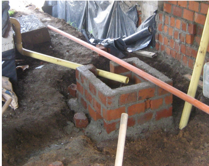
Figura 36. Supervisión en la construcción de cajas de inspección con ladrillo macizo doble.
