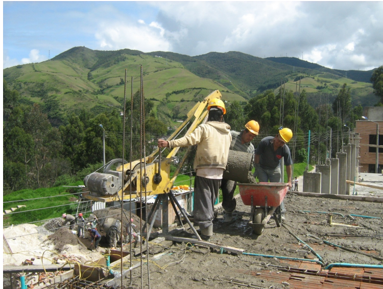
Figura 29. Transporte de mezcla con pluma grúa para fundición de losa de entrepiso.
