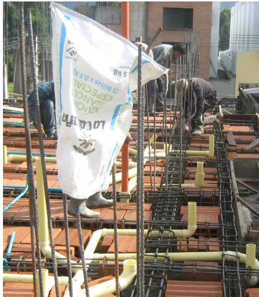
Figura 38. Supervisión de instalación sanitaria en losas de entrepiso.
