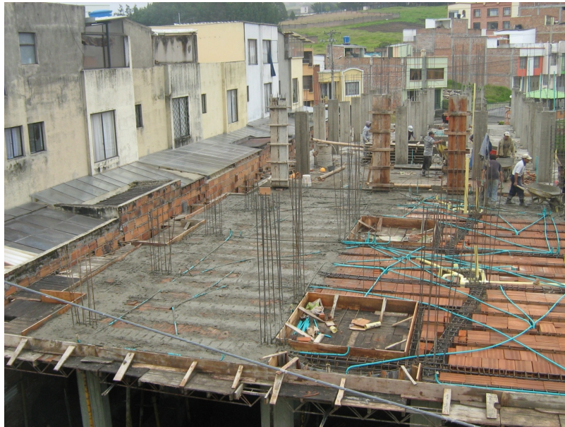
Figura 30. Vista panorámica de manzana D durante la fundición de losas de entrepiso de segundo piso.
