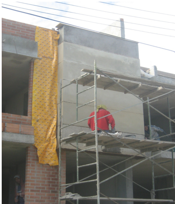
Figura 45. Supervisión en los trabajos de fachada con grano.
