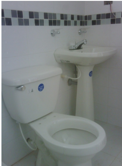
Figura 44. Supervisión durante la instalación de combos sanitarios.
