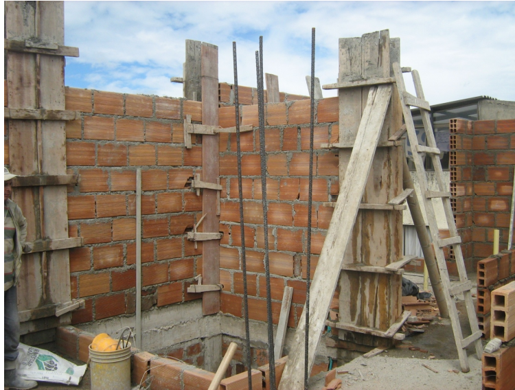
Figura 24. Fundición de columnas de confinamiento con muros en ladrillo farol.
