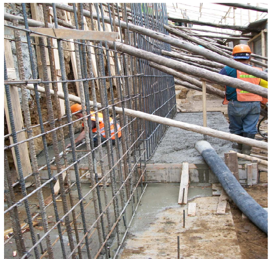
Fotografía N° 56 Terminado de zapata C3
