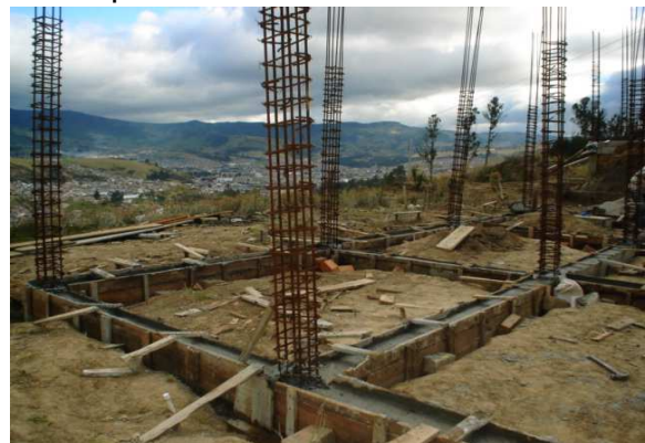
Fotografía N° 118 Encofrado durante el tiempo de curación del concreto
