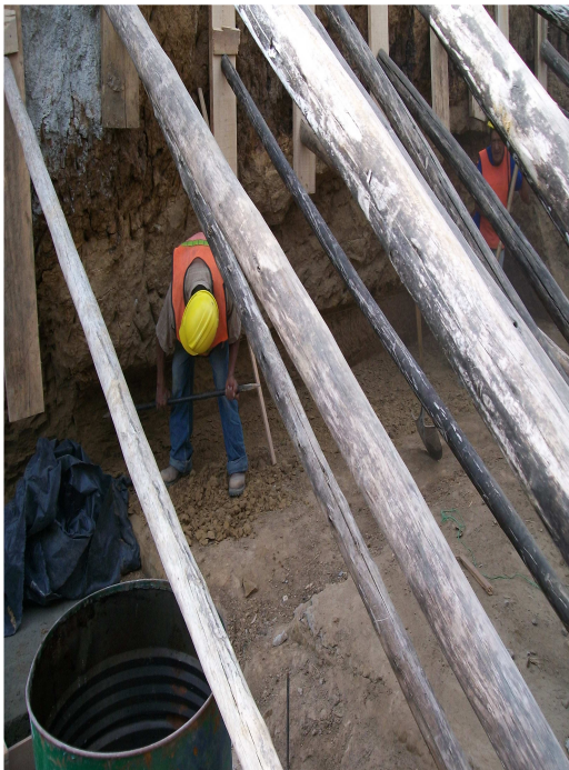
Fotografía N° 35 Apuntalamiento del talud en la manzana C.
