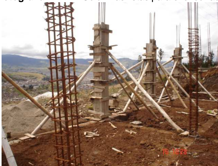
Fotografía N° 122. Columnas listas para el encofrado
