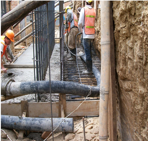
Fotografía N° 67 Fundición zapata C5
