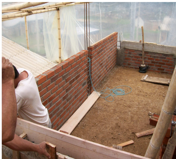
Fotografía N° 108. Muro de cierre en patio
