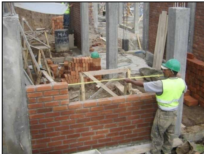
Fotografía N° 132. Verificación de dimensiones para vano de ventana
