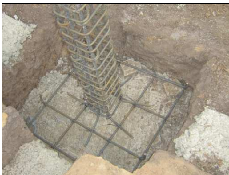
Fotografía N° 112. Armadura de refuerzo para zapata
