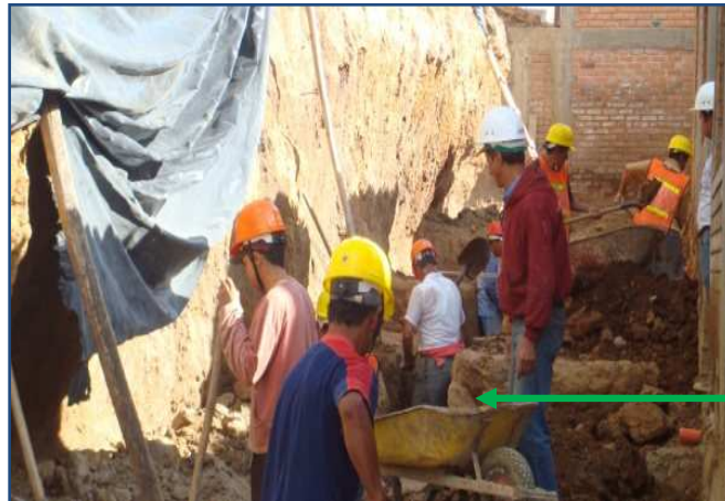
Fotografía N° 4 Desalojo de material
