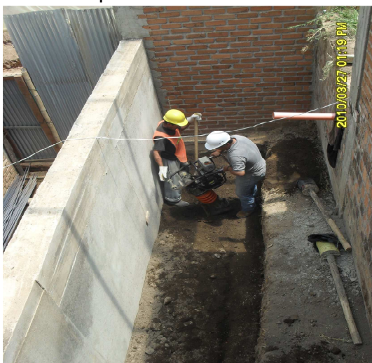
Fotografía N° 104 Compactación con saltarín
