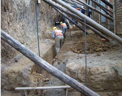
Fotografía N° 65 Excavación de Espolones que van desde D3 a D9
