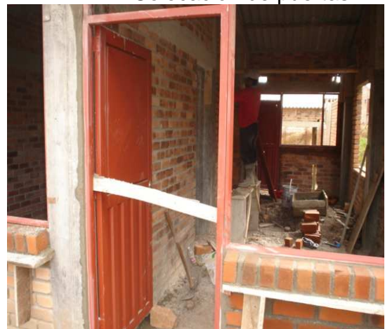
Fotografía N° 141 Colocación de puertas
