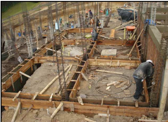
Fotografía N° 117 Encofrado antes de colocar el concreto
