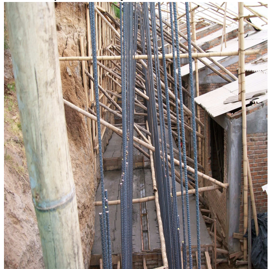
Fotografía N° 88 Zapatas D2 y D3 terminadas
