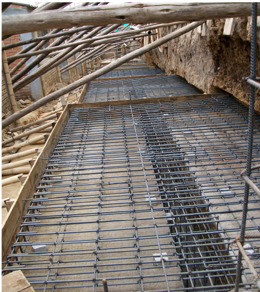
Fotografía N° 90 Parrillas de zapatas D8, D7 y D6 terminadas de armar.
