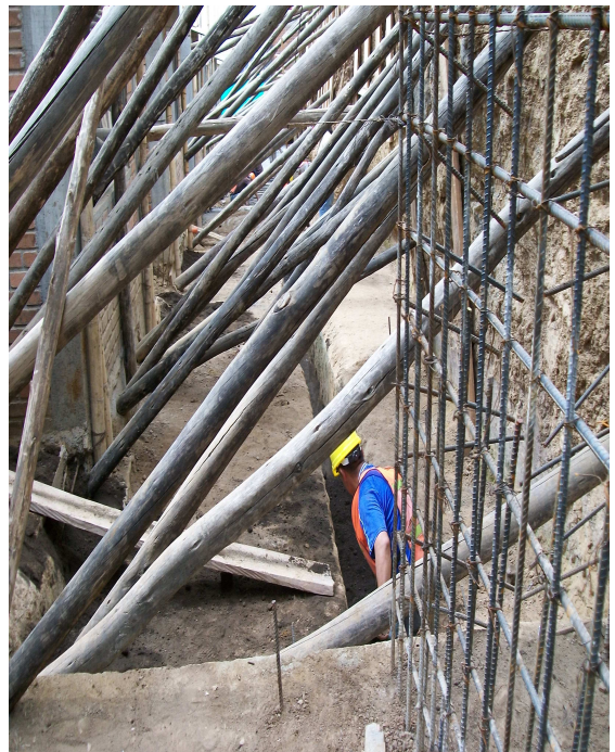
Fotografía N° 36 Apuntalamiento del talud en la manzana C.
