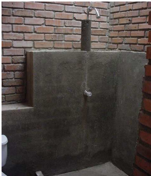
Fotografía N° 146. Repello de baño
