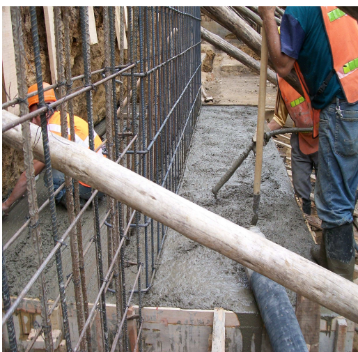
Fotografía N° 55 Fundición de zapata C3
