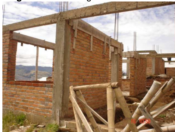
Fotografía N° 129. Vigas aéreas terminadas.
