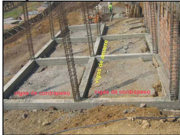
Fotografía N° 113. Vigas de cimentación
