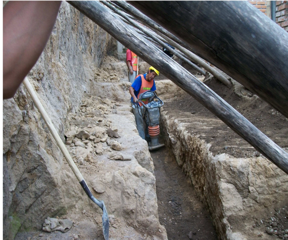
Fotografía N° 40 Compactación del material de relleno en el espolón de la Manzana D
