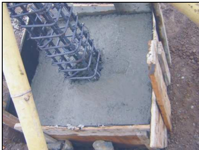
Fotografía N° 110. Zapata aislada central
