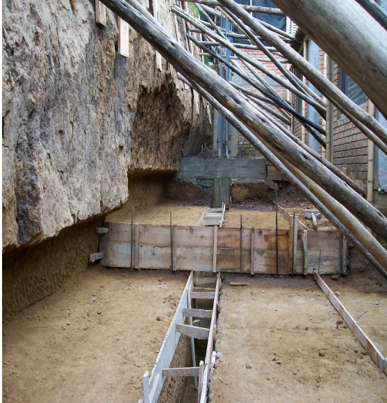
Fotografía N° 79 antes del solado
