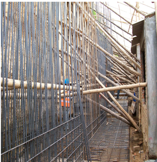
Fotografía N° 81. Zapata D2 y D3
