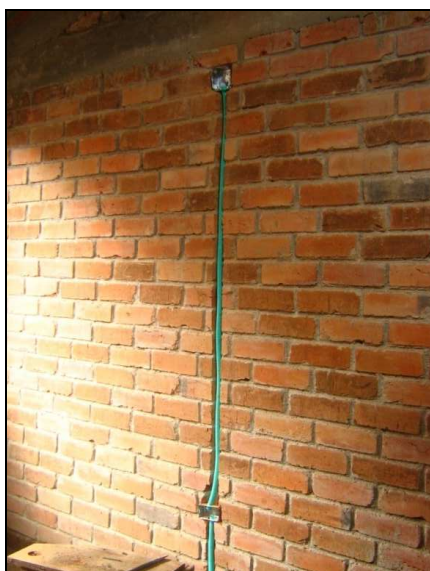
Fotografía N° 136. Tubería conduflex y cajas galvanizadas instaladas
