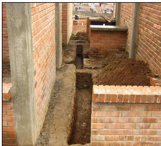
Fotografía N° 109. Excavaciones para instalación sanitaria
