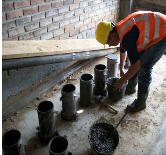
Fotografía N° 89 Toma de cilindros del concreto usado en D2 y D3
