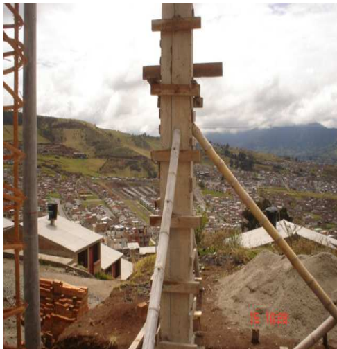
Fotografía N° 123 Encofrado de columna
