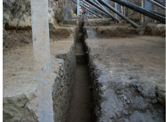
Fotografía N° 66 Excavación de los espolones terminada en la manzana D
