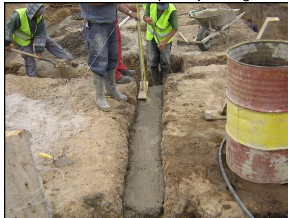
Fotografía N° 114 Solado de limpieza para viga de cimentación
