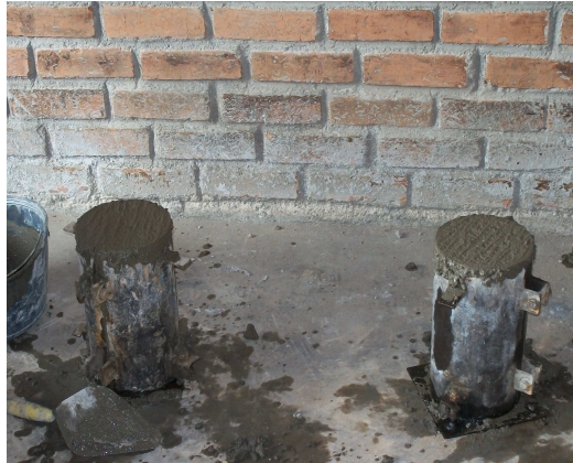
Fotografía N° 69 Toma de cilindros del concreto utilizado en C5
