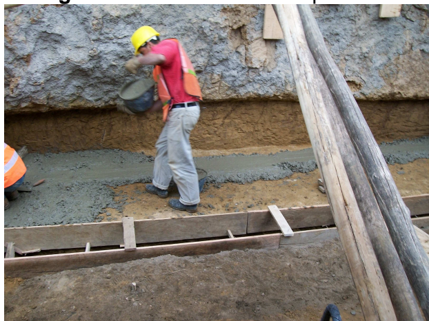
Fotografía N° 41 Solado de limpieza
