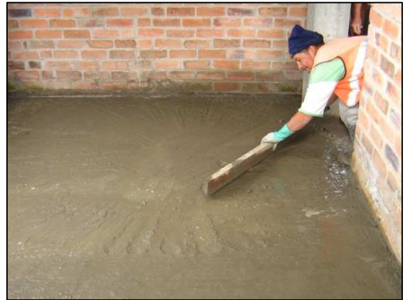
Fotografía N° 138. Refine de pisos
