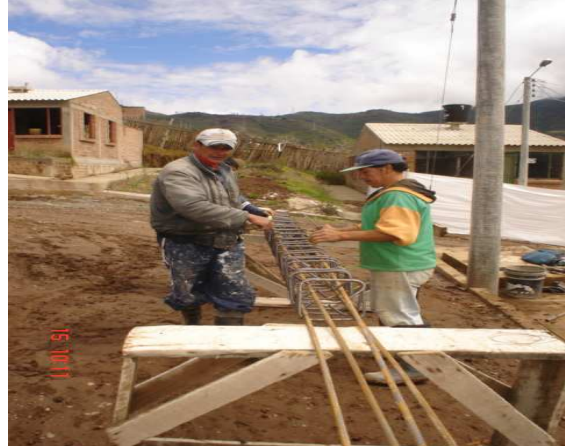
Fotografía N° 116 Amarrado de refuerzo para vigas de cimentación
