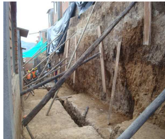
Fotografía N° 15 Estabilización del talud con entibado Manzana D
