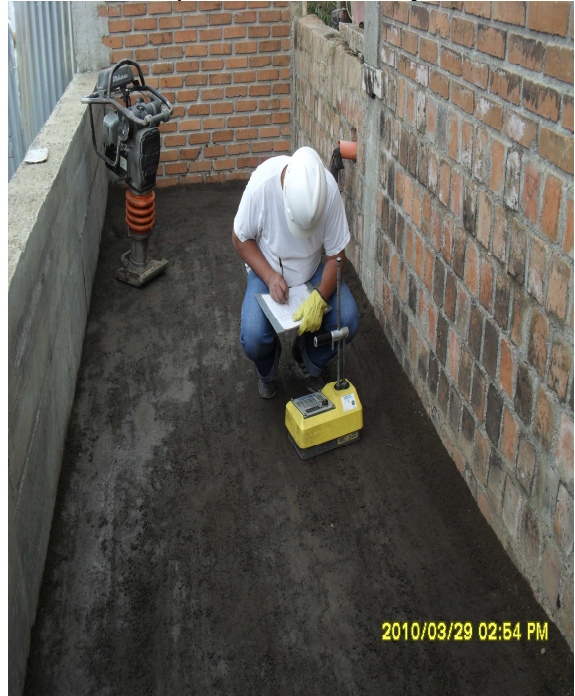
Fotografía N° 107 Toma de densidad En la compactación de C1 y C2
