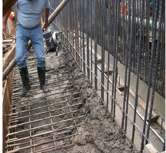
Fotografía N° 86 fundición de zapata D3
