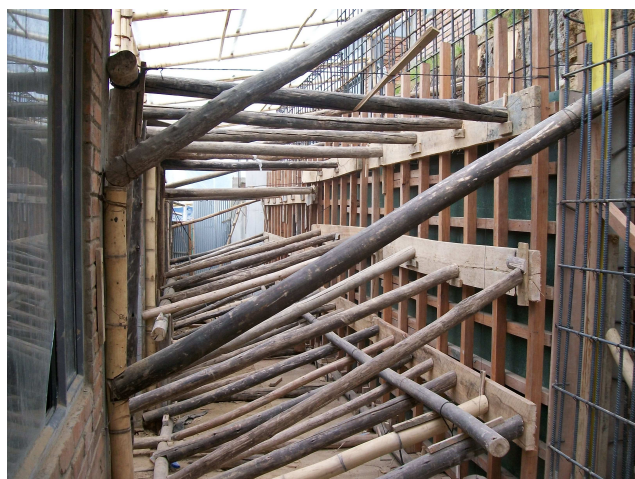
Fotografía N° 98. Apuntalamiento de la formaleta.
