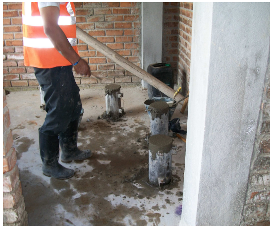
Fotografía N° 94 Toma de cilindros del concreto usado en C6 y C8
