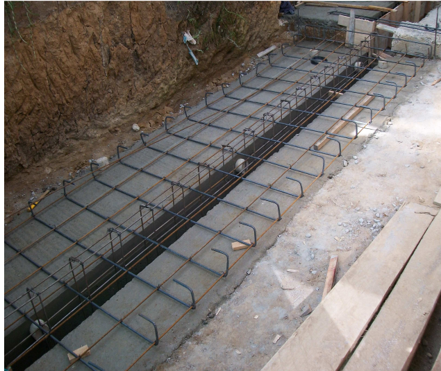
Fotografía N° 44. Armado de parrilla C1
