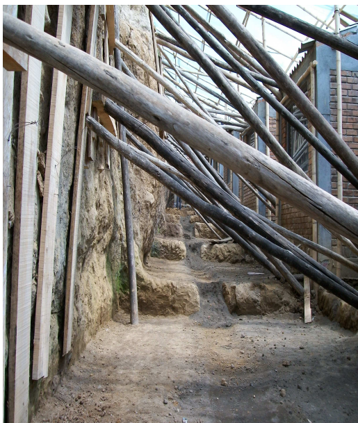
Fotografía N° 37 Apuntalamiento del talud en la manzana D.
