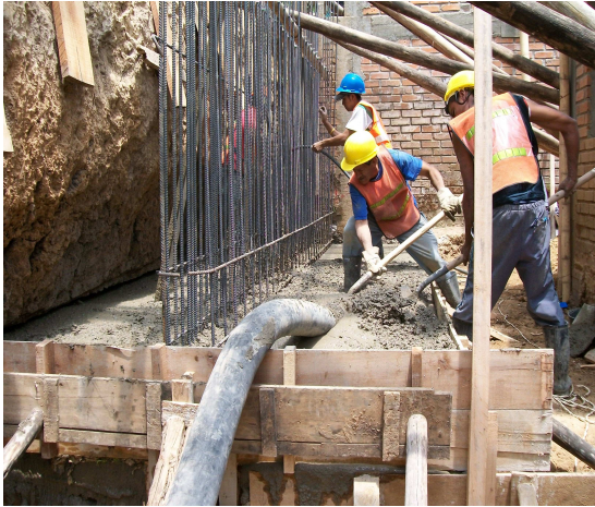
Fotografía N° 75 Fundición de zapata (frontal) D9
