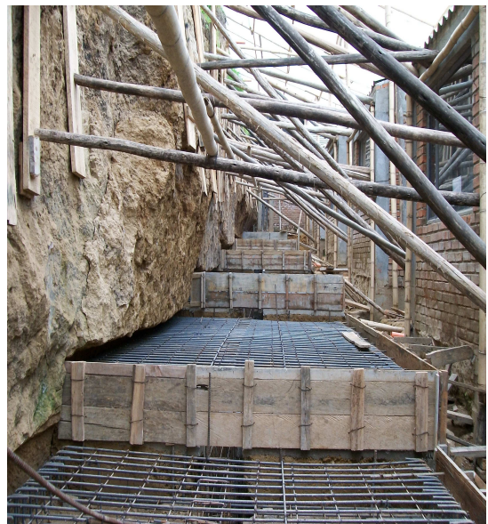
Fotografía N° 91 Parrillas de zapatas D4, D5 y D6 terminadas de armar.
