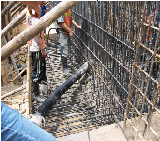
Fotografía N° 92 Fundición de zapatas C6
