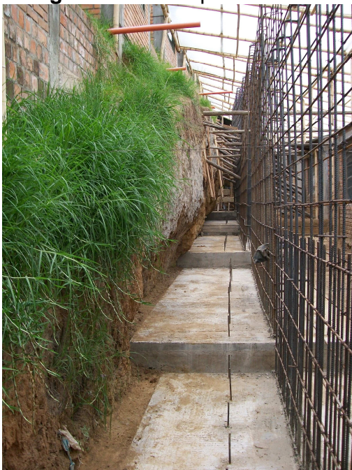
Fotografía N° 95 Zapatas manzana C
