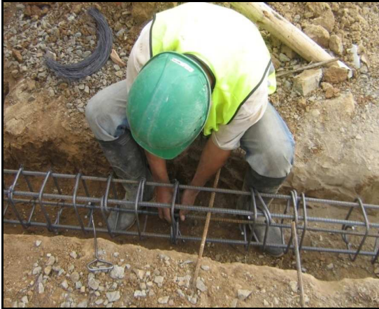
Fotografía N° 115 Amarrado de Refuerzo para vigas de cimentación
