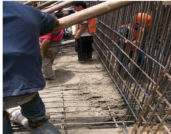
Fotografía N° 93 Fundición de zapatas C8
