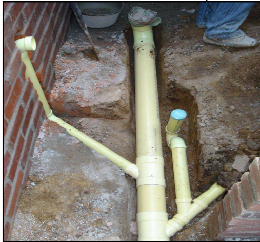
Fotografía N° 133. Colocación de tubería y accesorios instalados
