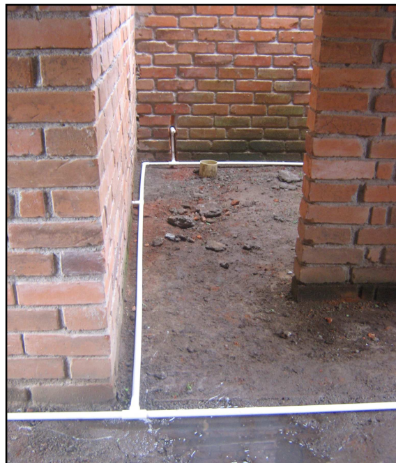
Fotografía N° 135. Tendido de tubería hidráulica
