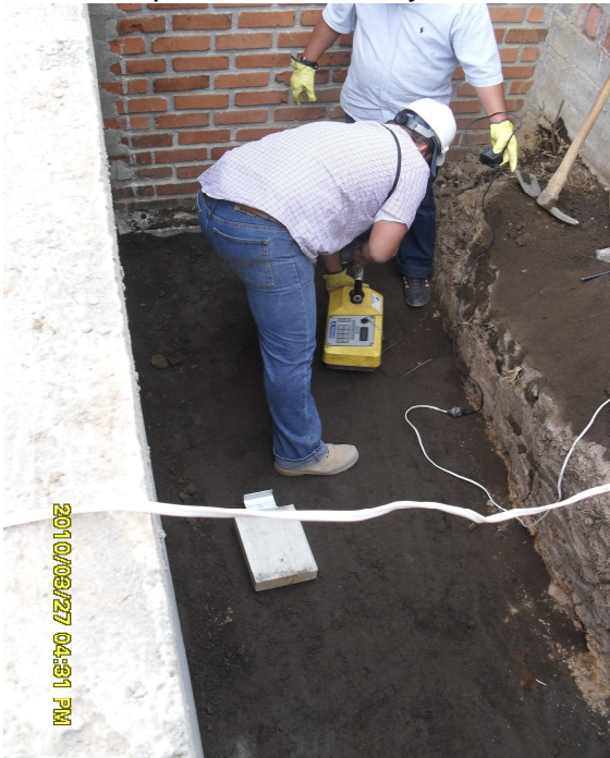
Fotografía N° 106 Toma de densidad En la compactación de C1 y C2
