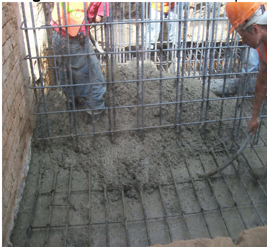
Fotografía N° 72 Fundición de zapata D1
