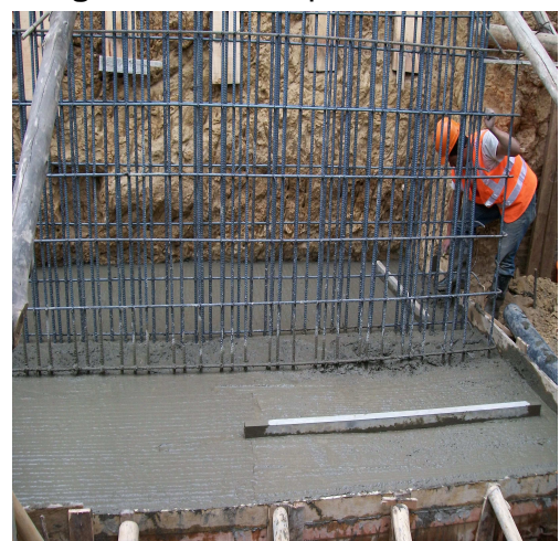
Fotografía N° 68 Zapata C5 terminada
