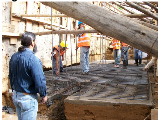
Fotografía N° 71 Armado de zapata en D3
