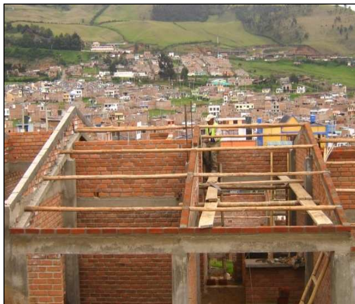
Fotografía N° 143. Colocación de madera rolliza
