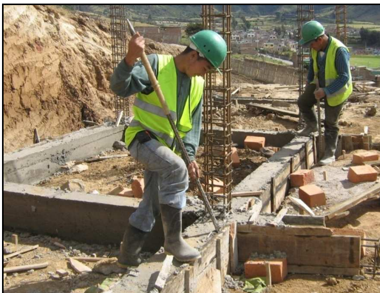
Fotografía N° 121. Desencofrado de viga
