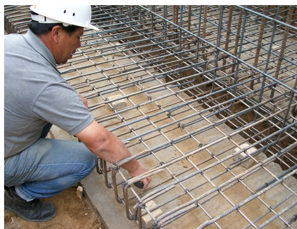
Fotografía N° 52. se comienza el armado de la parrillas de C3
