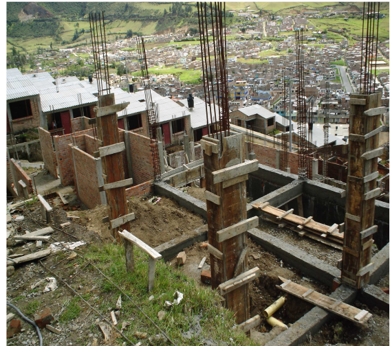
Fotografía N° 124 Encofrado de columnas
