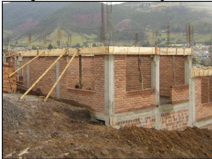
Fotografía N° 128. Encofrado de vigas aéreas
