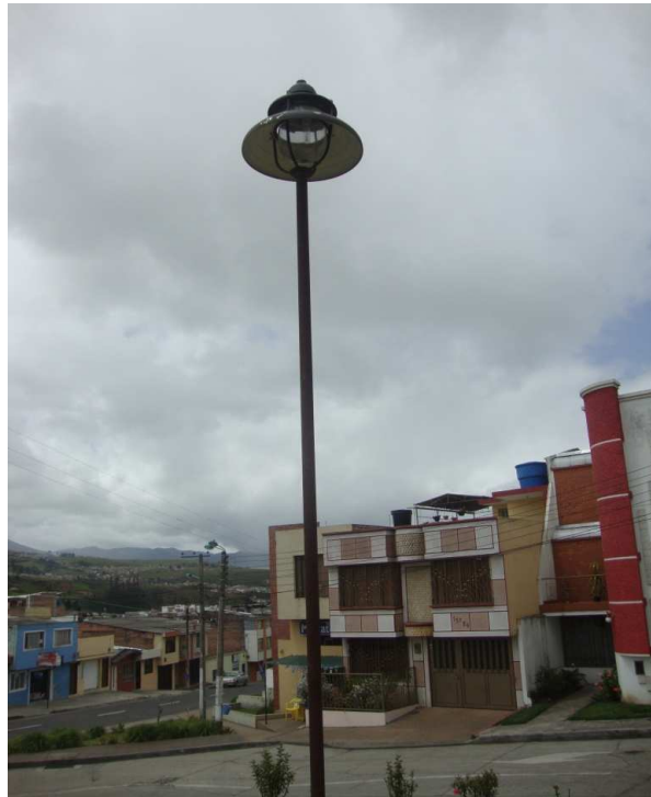
Figura 45. Poste de iluminación
