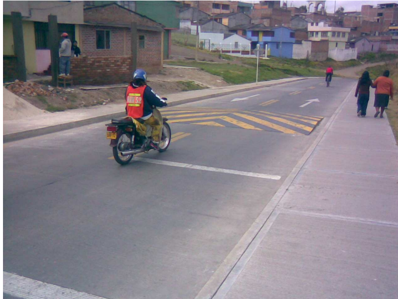
Figura 98. Otro de los resaltos en los que podemos observar la calzada y los andenes cumpliendo su objetivo
