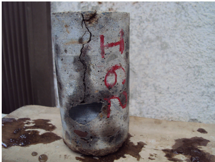
Figura 122. Núcleo tomado del lado izquierdo de la vía
