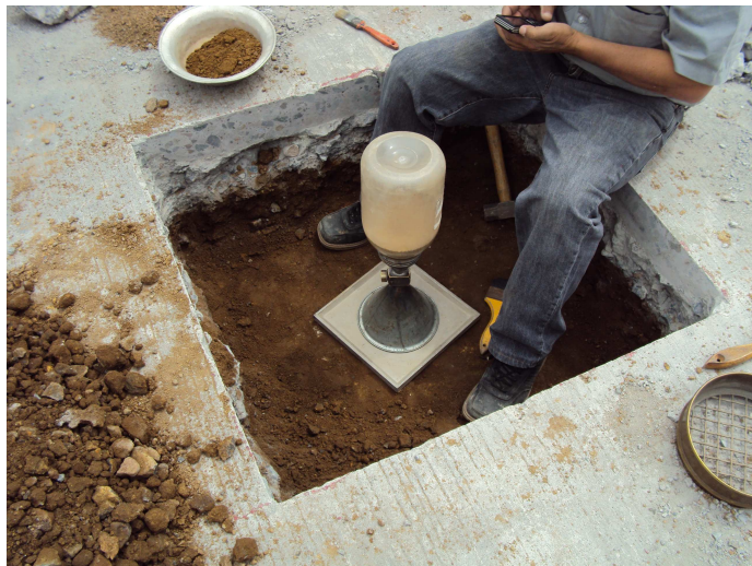
Figura 120. Realización del ensayo del cono y la arena, para la determinación de la densidad alcanzada en el terreno
