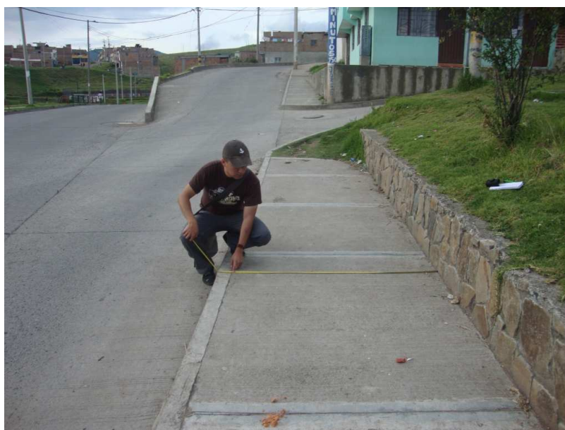
Figura 34. Medición de dimensiones de andén
