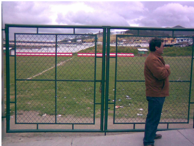
Figura 91. Puerta de acceso a zona recreativa construida en tubo estructural, ángulo y malla eslabonada
