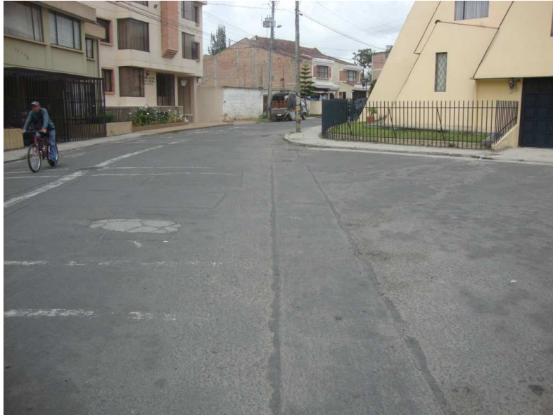
Figura 7. Verificación de trabajos ejecutados en el sector donde se puede observar el lugar por donde se realizaron las excavaciones
