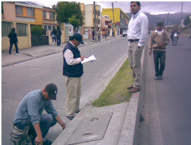
Figura 59. Uno de los sumideros de rejilla horizontal que reciben aguas tanto de la avenida Panamericana como de la paralela adyacente a la misma
