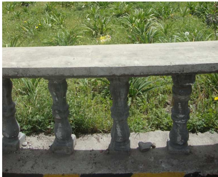
Figura 51. Detalle barras en balaustre
