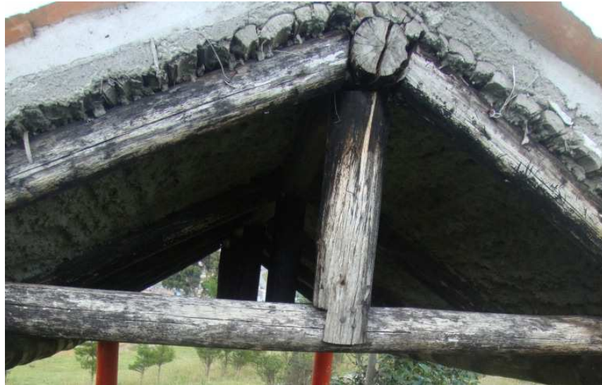
Figura 56. Detalle cubierta de puente en teja de barro sobre esterilla chapeada
