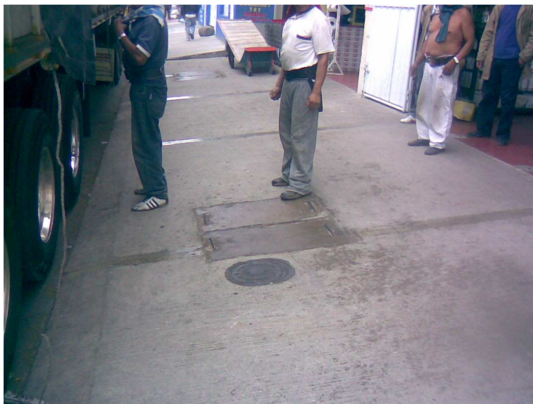
Figura 67. Andenes construidos en un sector de la obra
