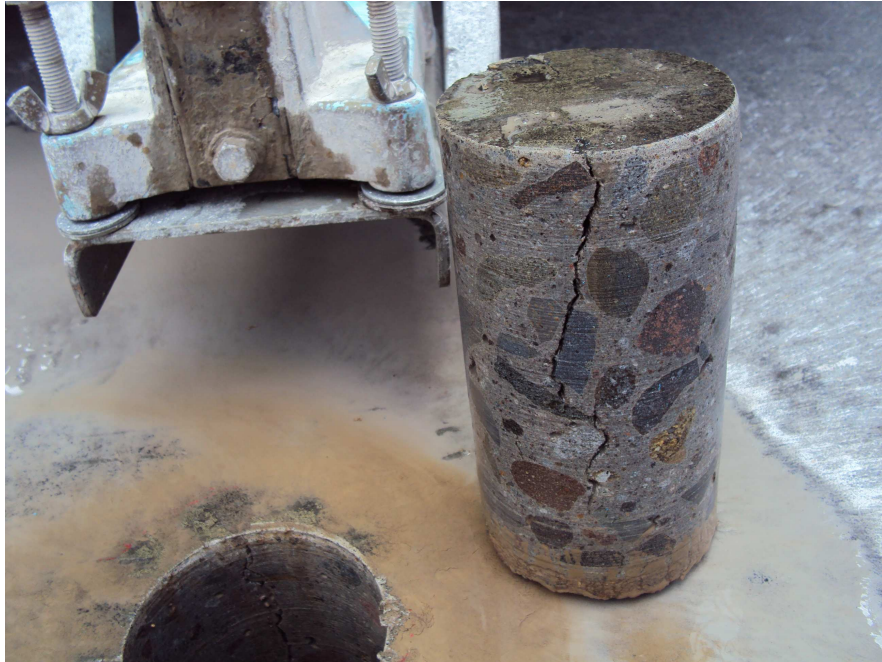
Figura 118. Otro de los núcleos extraídos donde se puede apreciar claramente la profundidad de las grietas
