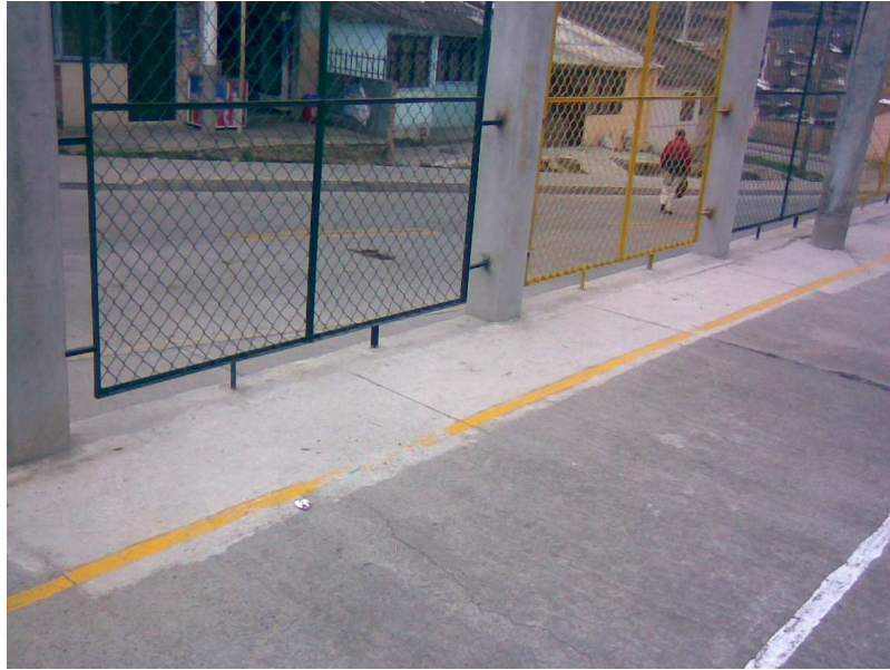
Figura 86. Muestra de los módulos de cierre en tubo estructural, ángulo y malla eslabonada en el sector del polideportivo. Podemos observar también el andén y parte de la calzada construidas en este proyecto
