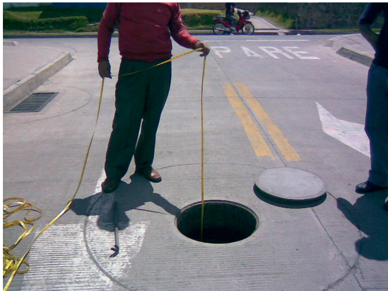
Figura 105. Verificando profundidad de cámaras y sumideros, estado de la vía y de andenes
