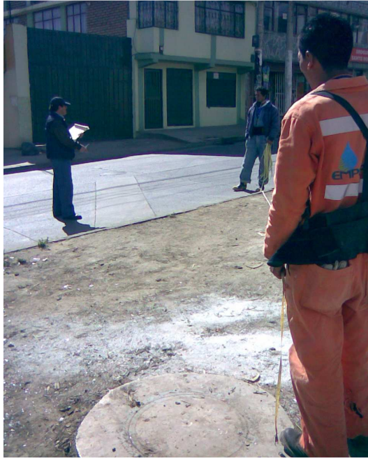
Figura 14. Verificación y medición de estado de cámara de inspección 2
