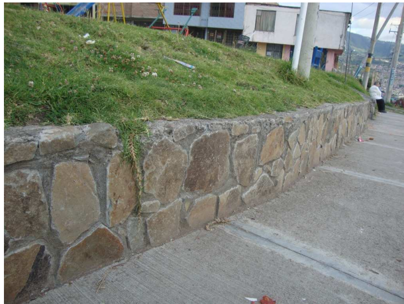
Figura 38. Muro en ciclópeo construido frente a la vía
