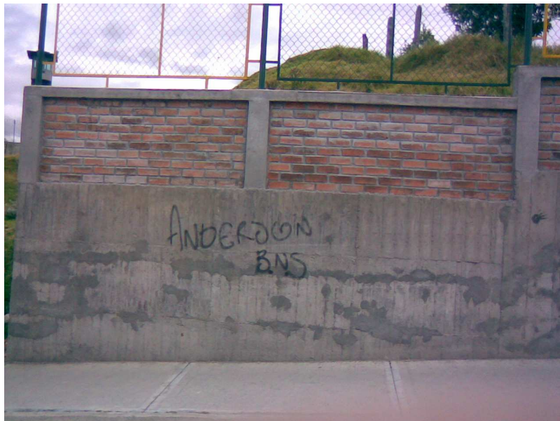
Figura 95. Aspecto de uno de los muros sobre el cual se construyó un muro en ladrillo con columnetas cada 5 metros y sobre su alfajía el muro de cierre en tubo estructural, ángulo y malla eslabonada
