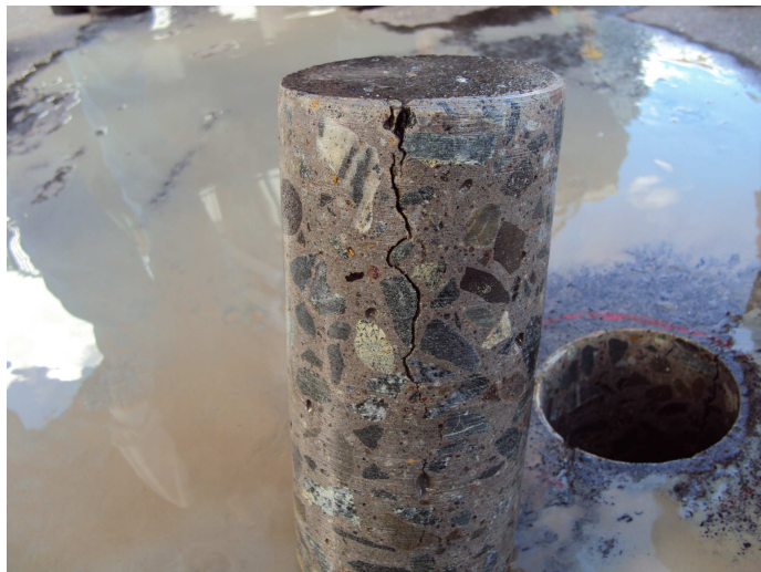
Figura 117. Núcleo extraído con una grieta profunda
