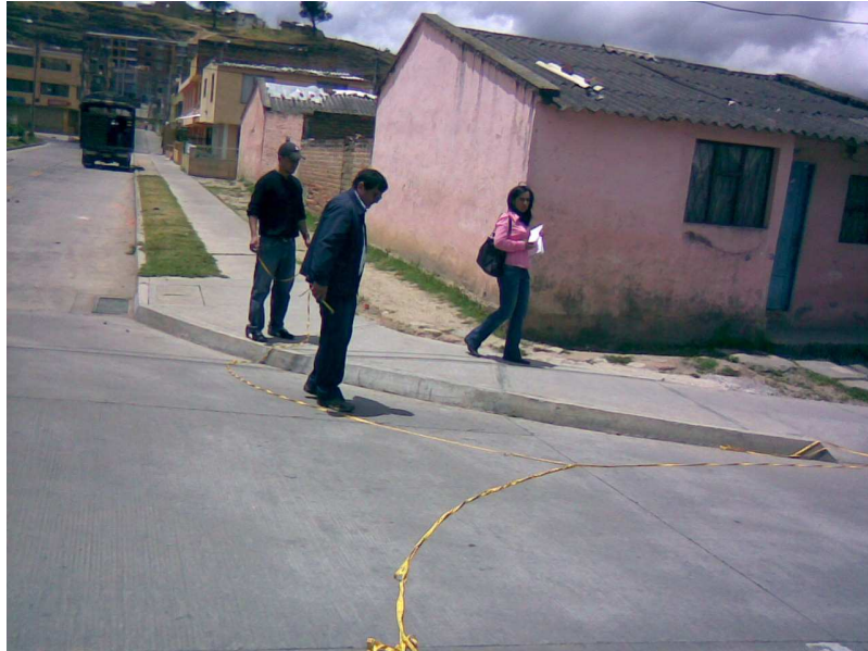
Figura 104. Verificación del estado de los sardineles en concreto de la vía y sus respectivos andenes
