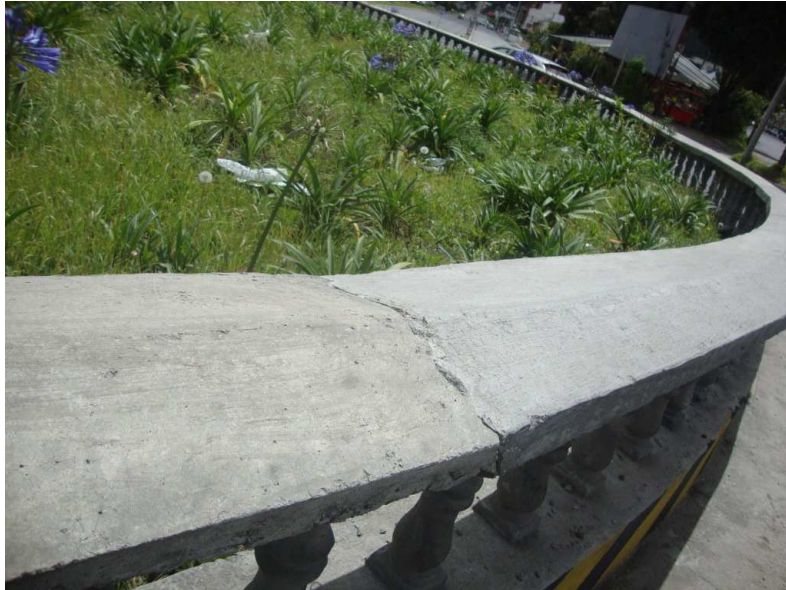
Figura 52. Junta de acoplamiento entre alfarjía antigua y alfarjía construida
