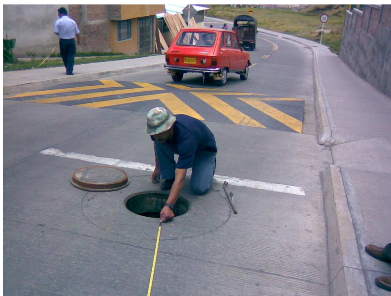
Figura 103. En la fotografía se mira uno de los 4 resaltes construídos sobre la vía, se mira además otra de las cámaras. El estado de la vía y parte de los andenes
