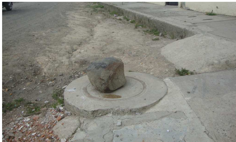
Figura 4. Verificación cámara de inspección 2
