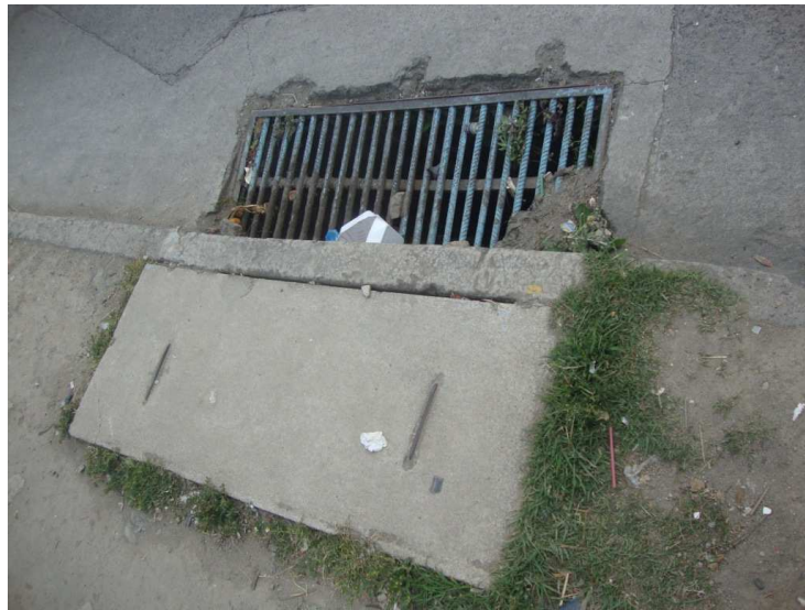
Figura 15. Sumidero construido en el sector
