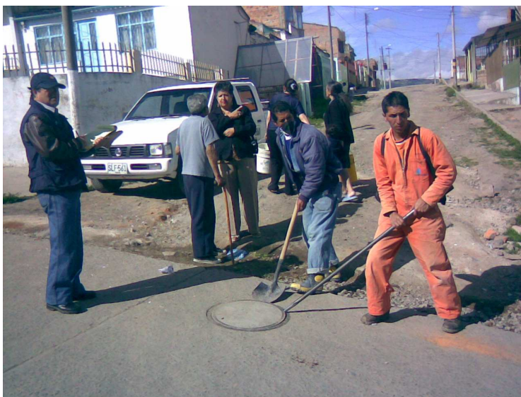
Figura 17. Verificación de estado de cámara de inspección 1
