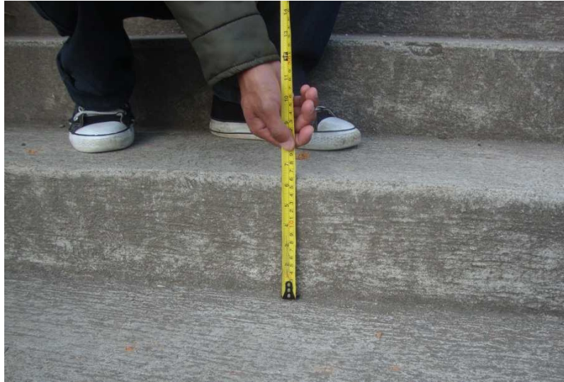
Figura 37. Medición de contrahuella en escalera
