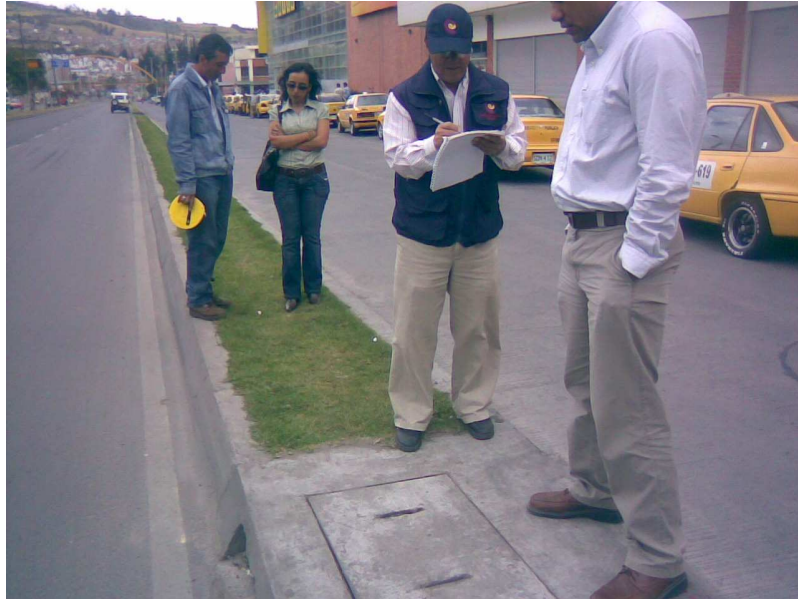
Figura 60. Otro de los sumideros construidos que sirven a las dos vías
