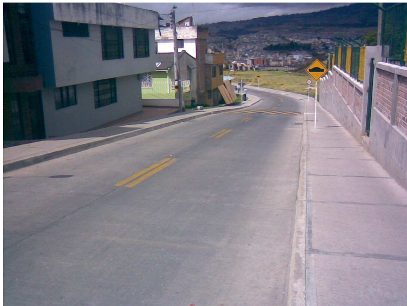
Figura 99. Señalización vertical y horizontal de la vía, andenes, calzada y muros
