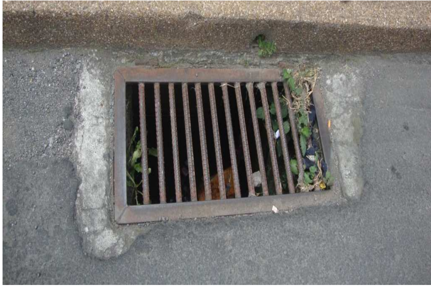
Figura 5. Sumidero construido en el sector
