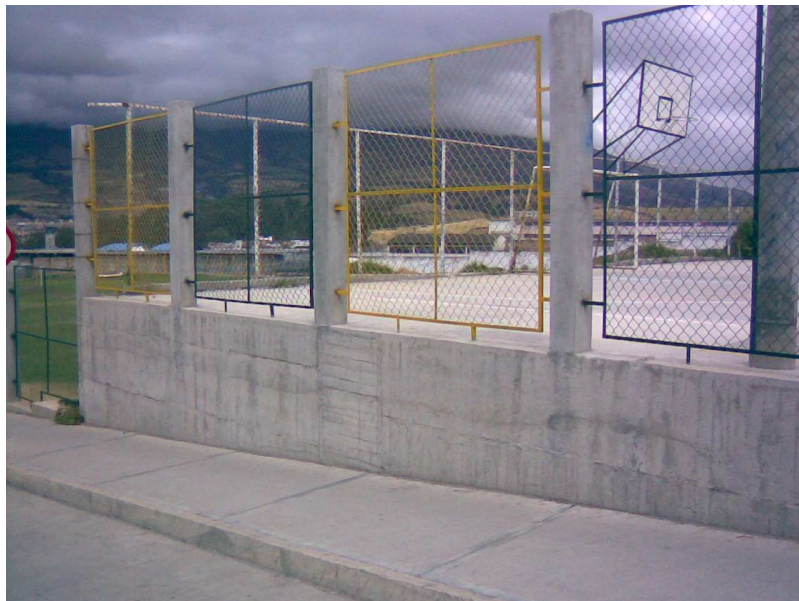
Figura 87. Muro en concreto ciclópeo construido para confinamiento de la vía y cierre del polideportivo
