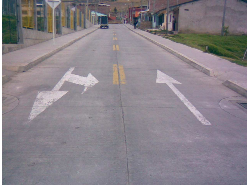
Figura 92. En el registro podemos observar la señalización horizontal y la vía con su calzada y andenes respectivos
