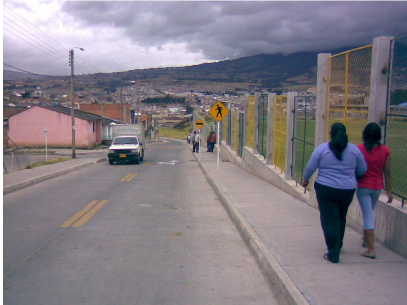
Figura 88. Otro de los muros con su cierre respectivo construidos en la vía y en pleno funcionamiento
