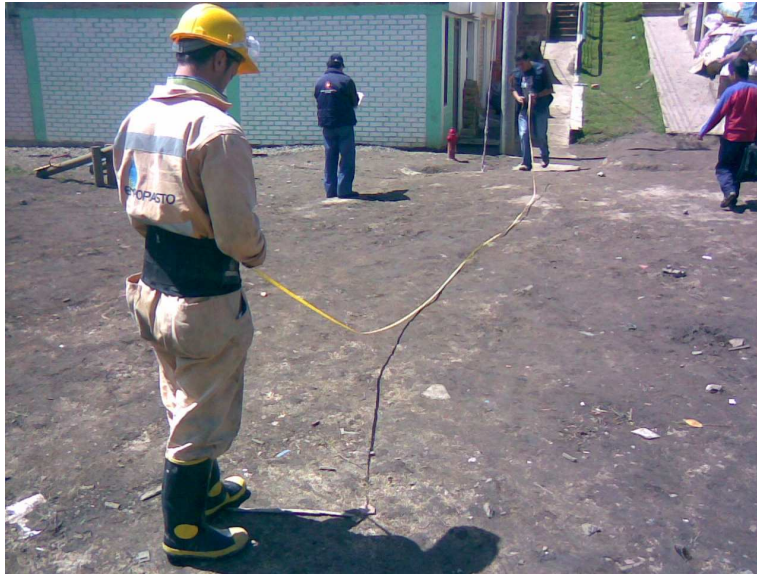
Figura 3. Medición entre derivación o empalme y válvula de control de hidrante
