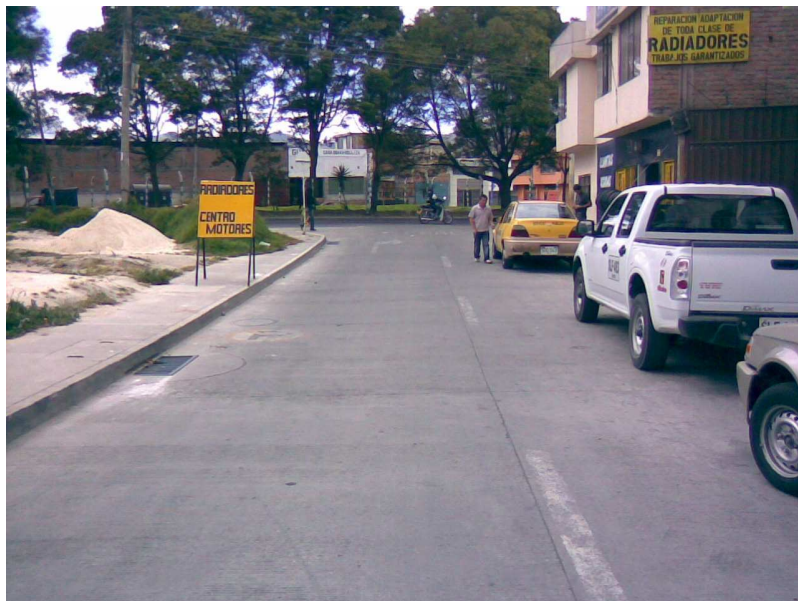
Figura 63. Otra vista de la construcción del pavimento y andén. La observamos cumpliendo su objetivo
