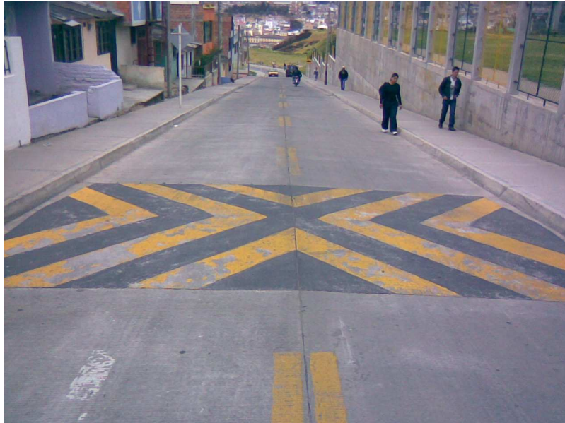
Figura 90. En la foto podemos observar uno de los cuatro reductores de velocidad, el muro y los andenes construidos en la obra
