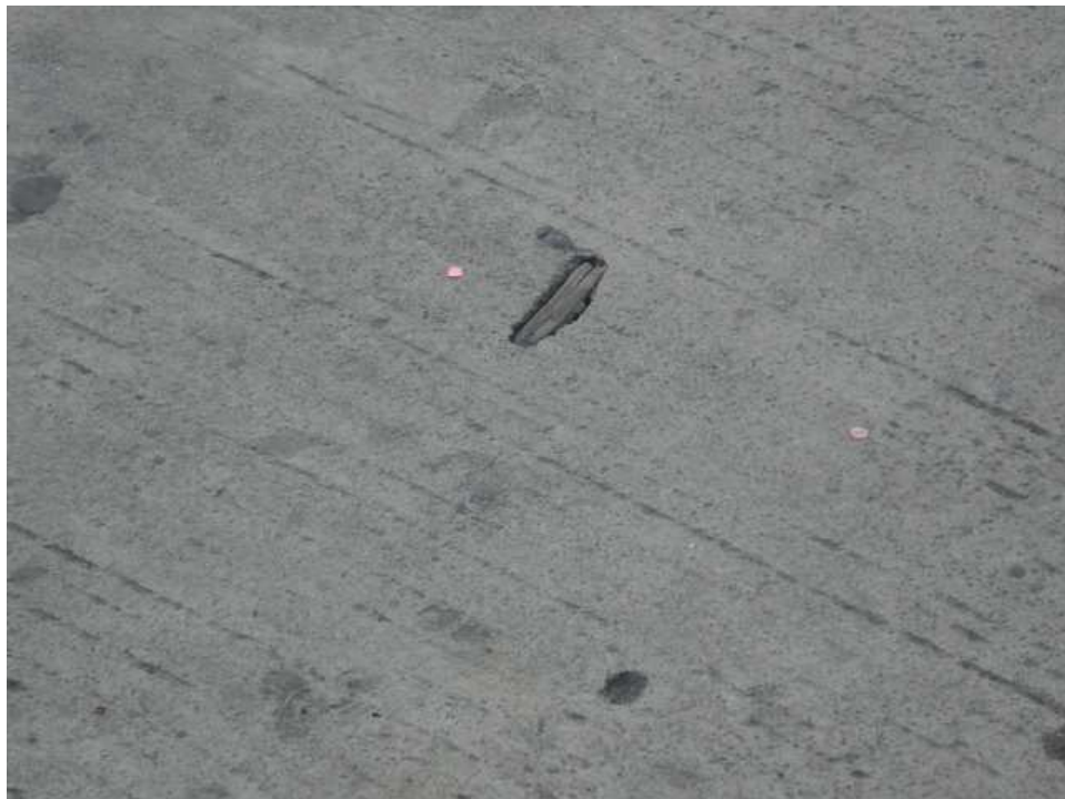
Figura 114. Uno de los paños donde se presentan trozos de madera fundidos junto con la placa
