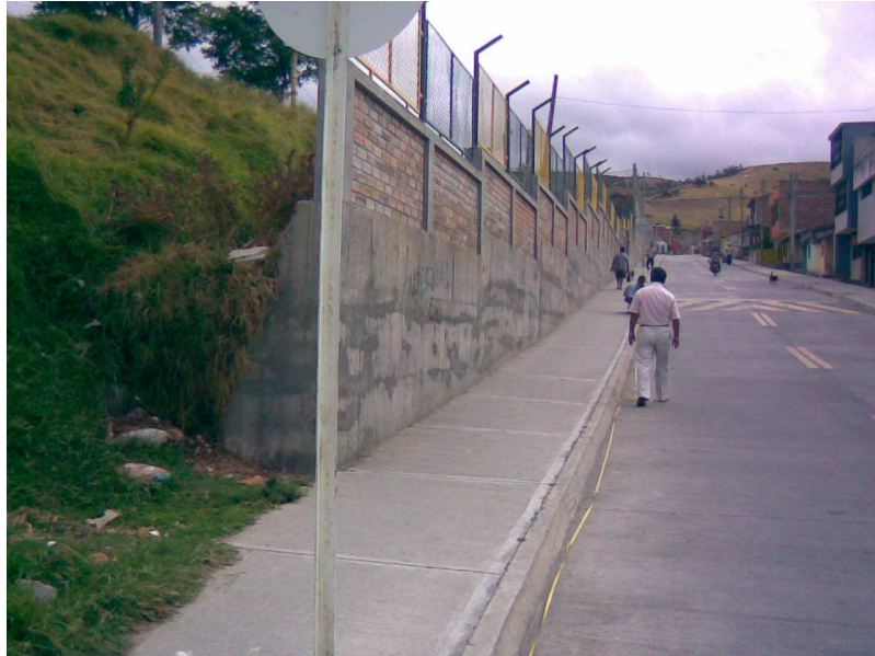
Figura 96. Vista del muro anteriormente descrito, andén y calzada
