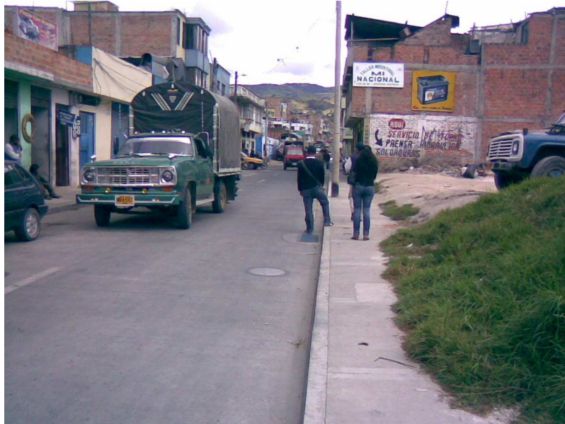
Figura 62. Pavimento y andén construidos en el sector de Villa del Río
