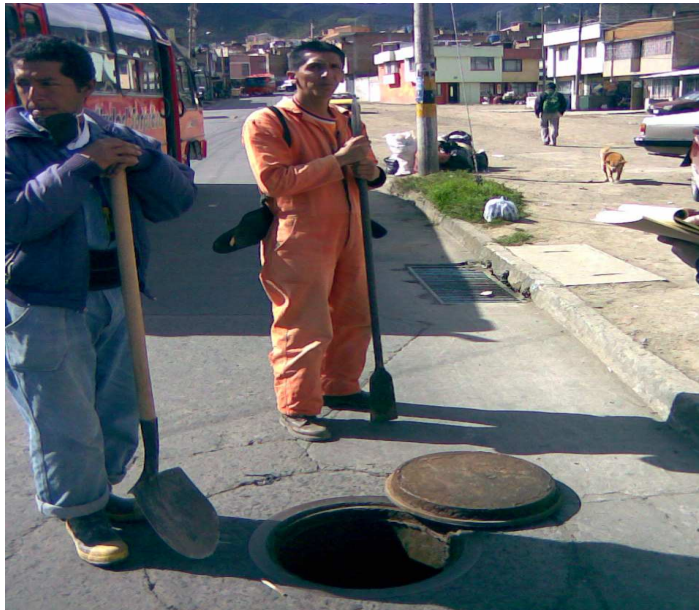
Figura 10. Verificación de estado de cámara de inspección 1
