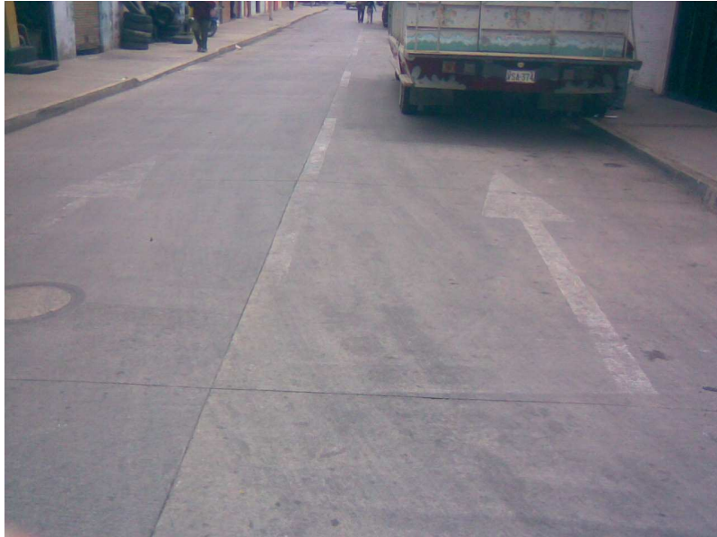
Figura 72. Calzada construida en concreto rígido sobre la calle 15
