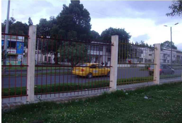
Figura 24. Vista general de los módulos tipo, componentes del cierre del parque
