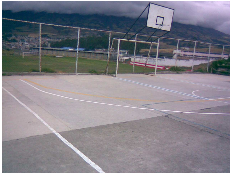
Figura 85. Parte reconstruida del polideportivo del barrio Corazón de Jesús que en la obra y presupuesto se tomó como construcción de andén
