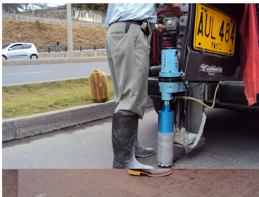
Figura 115. Equipo de perforación
