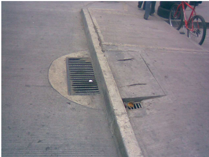
Figura 73. Sumidero construido sobre la calle 15
