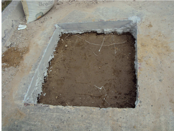
Figura 119. Corte en el concreto de 80 cm x 80 cm de lado
