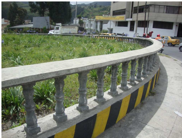
Figura 53. Vista general de cerramiento reparado en la glorieta Las Banderas
