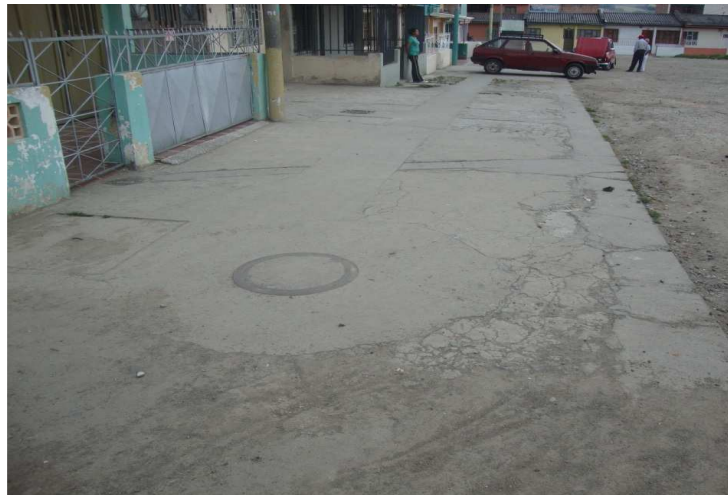
Figura 11. Verificación cámara construida sobre uno de los andenes del sector
