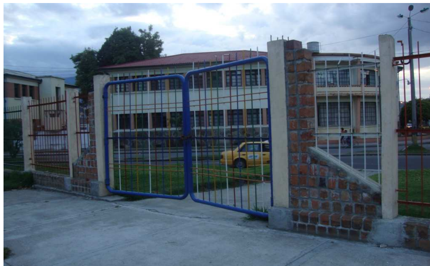
Figura 25. Vista puerta fabricada en tubo estructural
