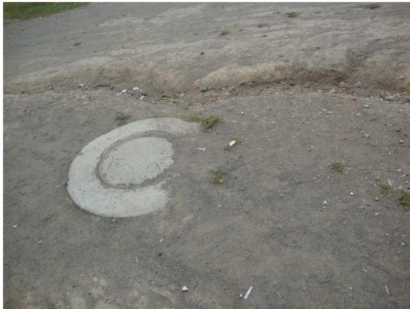
Figura 2. Verificación cámara de inspección 1
