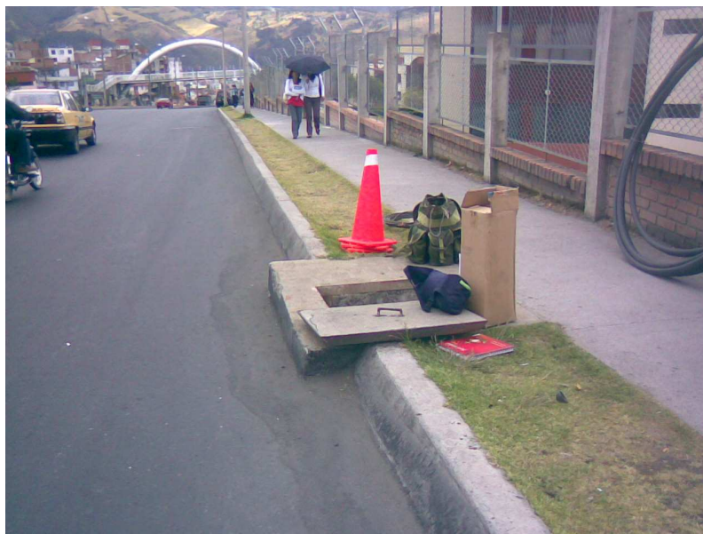
Figura 61. Construcción antitécnica de una caja de inspección de ductos telefónicos. Se puede apreciar que parte de la misma está sobre la vía
