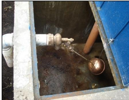
**\_Accesorios internos instalados en las cámaras de quiebre de presiones: Accesorios HG, Flotador, Rebose, Válvula Pozuelo y Coladera**
