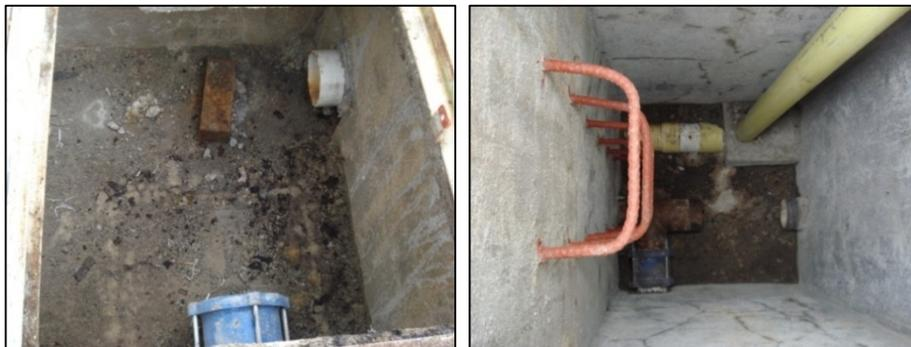
**Cajillas de entrada y salida del tanque de almacenamiento en el cerro la Piriola sin válvulas de control**
