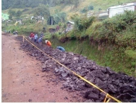
..Señalización con cinta de seguridad para instalación de tubería localizada sobre vías principales.
