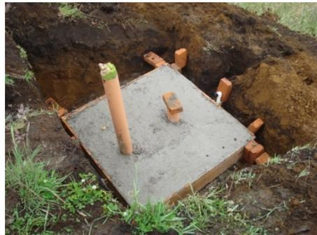
**...Fundación de Base en Concreto Reforzado de Cámaras de Quiebre de Presión – Se deja instalados accesorios para rebose y lavado 4”**
