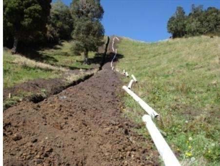
**\_Tubería colocada al pie de la excavación**
