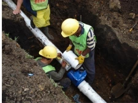
**\_Instalación válvulas de control de 6"**
