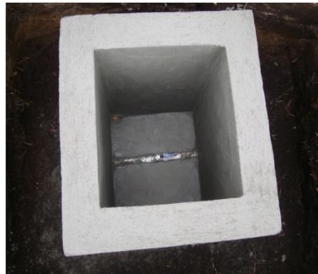
**..Pañetado Impermeabilizado Interno y externo de Cajillas de válvulas**
