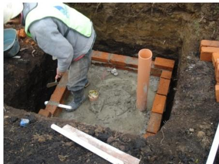
**...Pega de ladrillo tolete para conformación de paredes de la estructura hidráulica.**
