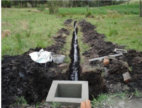
..Descole de tubería de desagüe de válvulas purga
