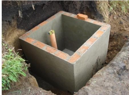
**\_Estructura Parcialmente terminada, repello impermeabilizado interno y externo y esmaltado impermeabilizado interno**
