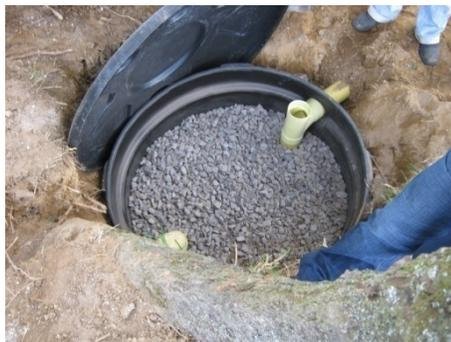
**..Filtro anaerobio con su respectivo material filtrante y accesorios**
