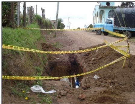
**Señalización con cinta de seguridad para construcción de estructuras localizadas sobre vías principales**
