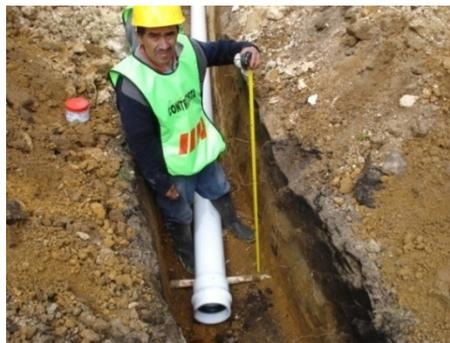
**..Chequeo de profundidad de la excavación mínimo 1m**
