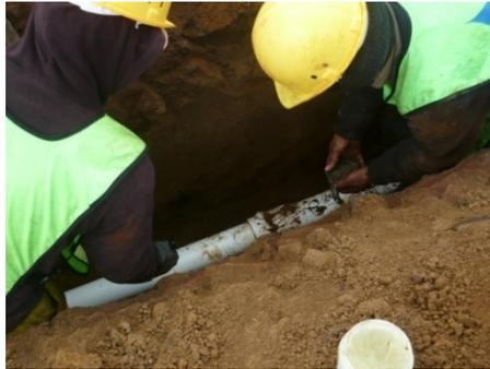
..Proceso de instalación tubería PVC UM Vereda Jurado
