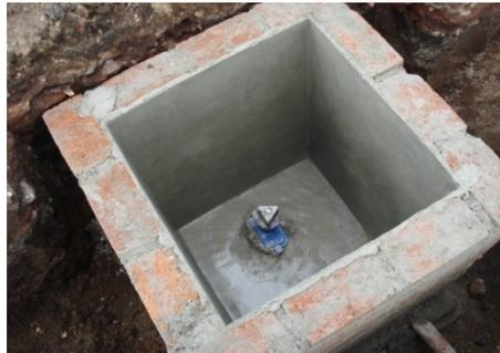
**..Válvulas de control ancladas para tuberías de diámetros 6", 4", 3" y 2".**
