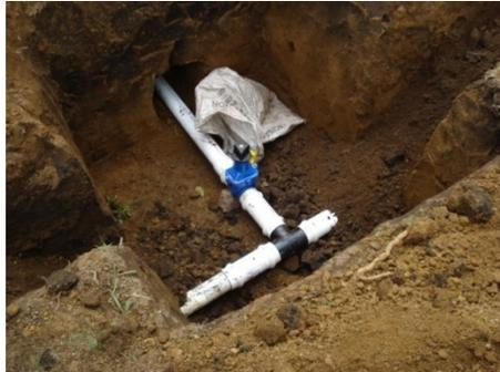
**...Instalación de válvulas purga con sus respectivos accesorios**
