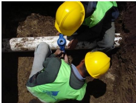
...Instalación de Collar de Derivación en HD para válvulas ventosas
