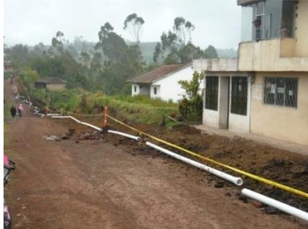
De igual manera se ejecutó la instalación de tubería sobre el Ramal A (Principal) que se deriva del  $\Delta 2$  del Ramal Uno, el tipo de tubería instalado fue de 4" pvc-um RDE 32.5, RDE 21, RDE 13.5 y RDE 11, en el sector de la vereda Concepción Bajo  $\Delta 10A$ , hace el cambio a tubería de 3" pvc-um RDE 13.5, RDE 21, RDE 26. En el  $\Delta 21A$ , cambia a tubería de 2" pvc-un RDE 21 y en el  $\Delta 22A$  cambia tubería de 1 ½" hasta el final de este Ramal.
