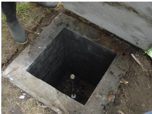
..Instalación de válvulas ventosas de:  $\frac{1}{2}$ " para tubería de 2", 1  $\frac{1}{2}$ " y 1" y de 1" para tubería de 6", 4" y 3".
