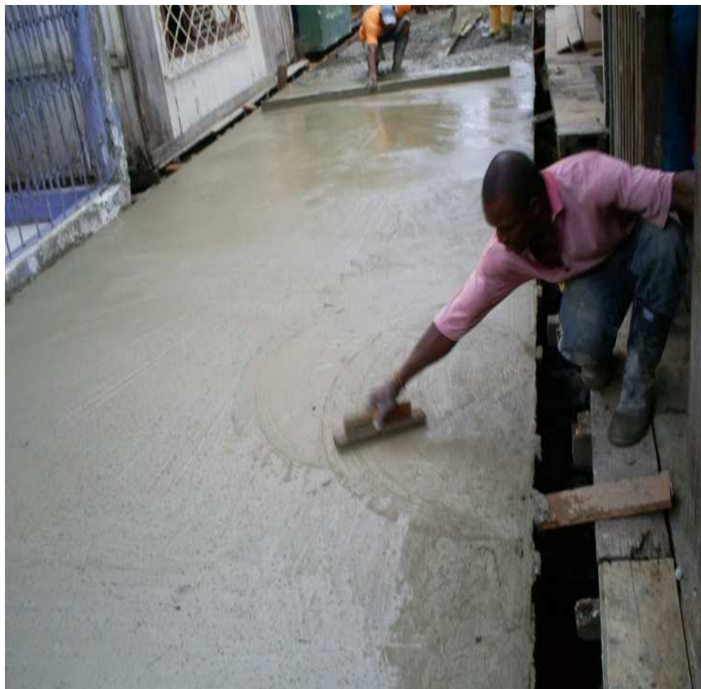
Fotografía 25. Acabado final puente Humberto Manzi.
