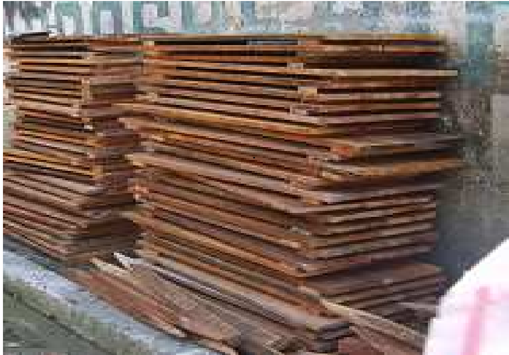
Fotografía 10. Construcción de tableros para formaletas.
