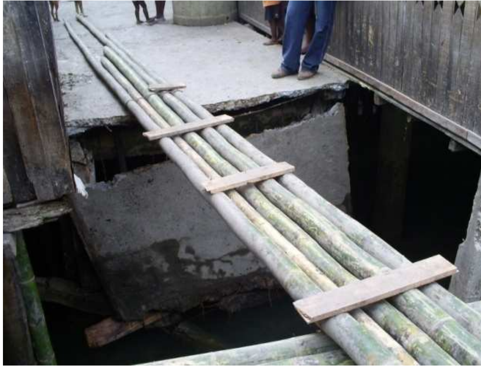
Fotografía 13. Construcción de puentes provisionales puente Barracón 1.
