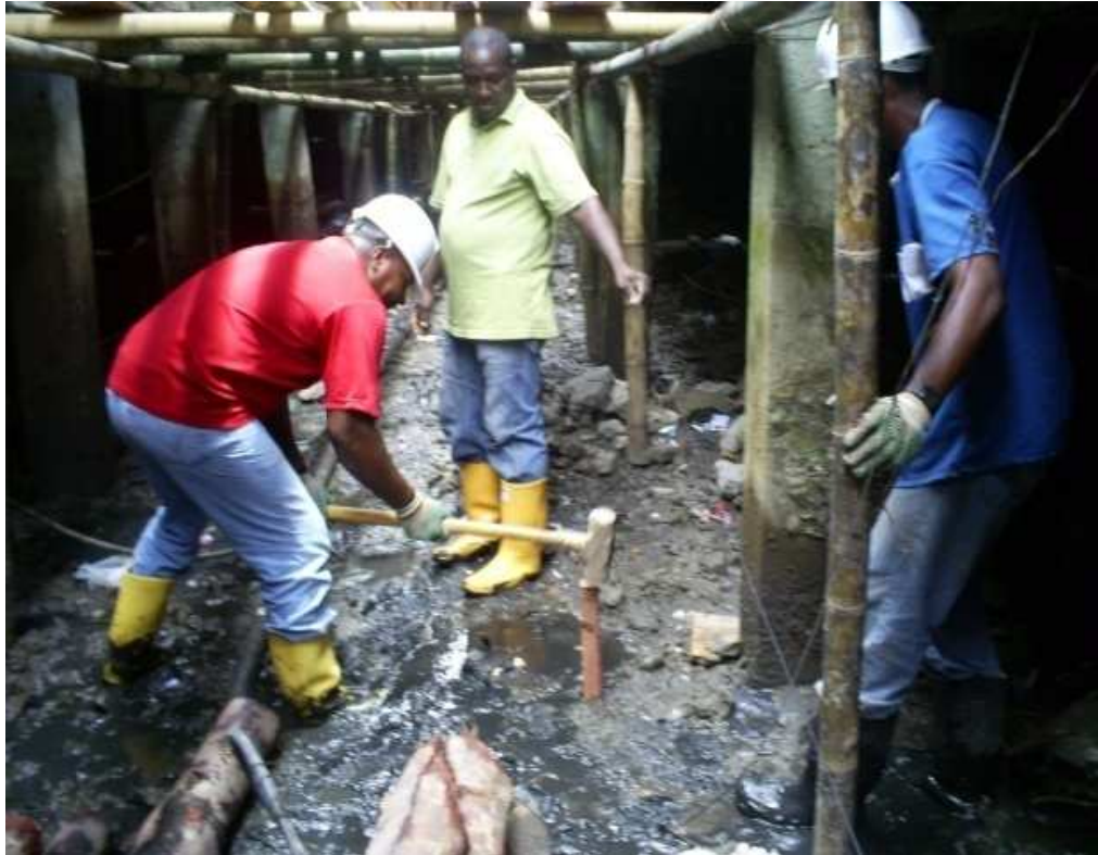
Fotografía 14. Localización de ejes puente Barracón 1.
