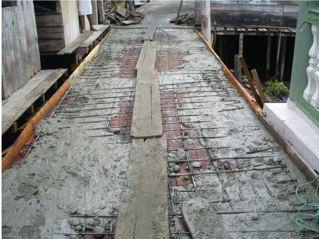
Fotografía 24. Fundición vigas aéreas y losa puente Humberto Manzi.
