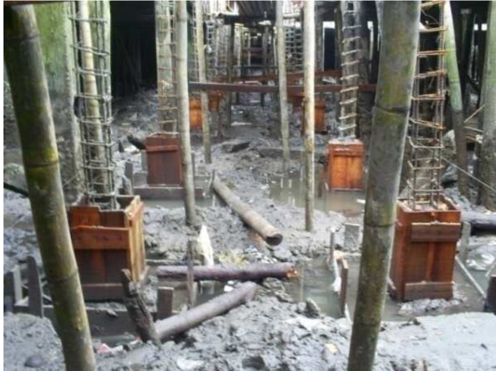
Fotografía 20. Fundición de pedestales puente Barracón 4.
