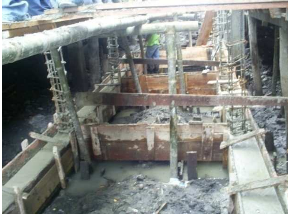
Fotografía 21. Viga de cimentación puente Barracón 4.
