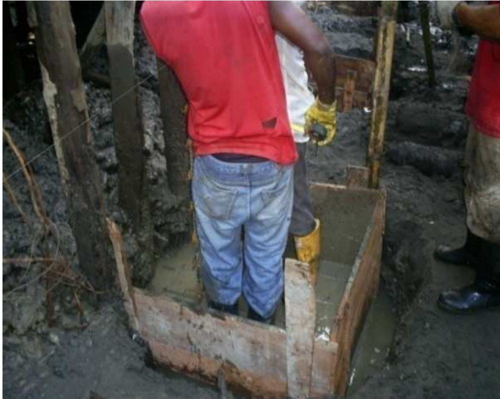
Fotografía 17. Vaciado del concreto de limpieza puente Barracón 3.
