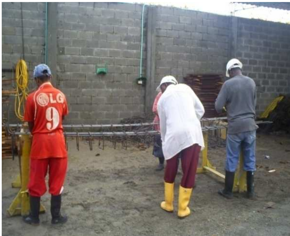
Fotografía 9. Corte, figurado y armado de refuerzo para zapatas, vigas de cimentación y columnas.
