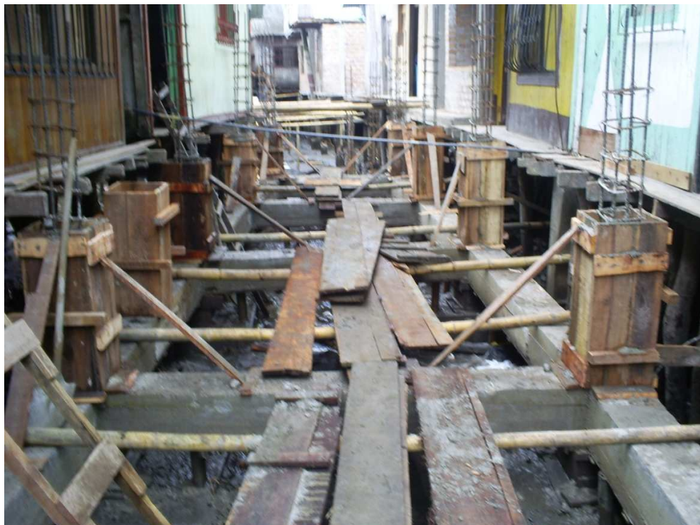
Fotografía 6. Encofrado y llenado de columnas.
