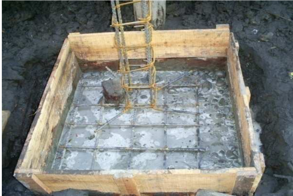
Fotografía 18. Figurado y armado de refuerzo para columnas puente Barracón 3
