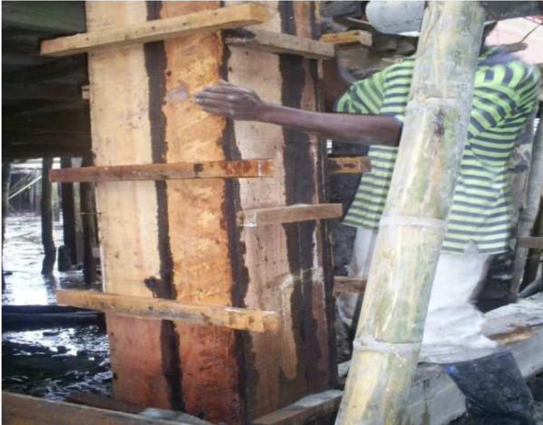
Fotografía 22. Fundición de columnas puente Barracón 4.
