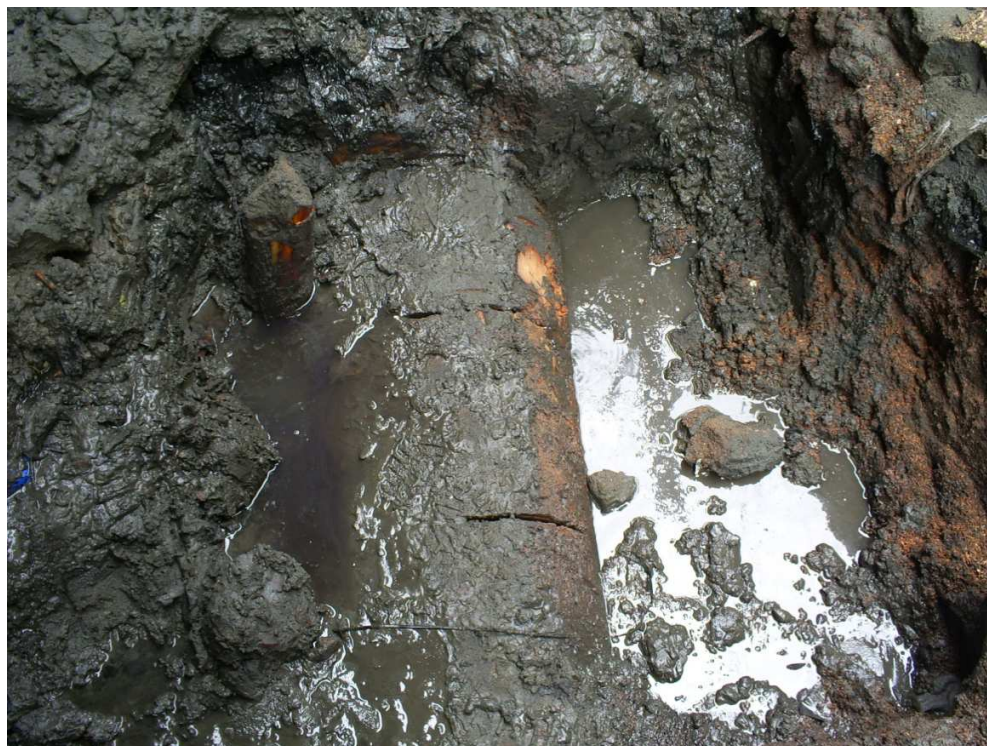
Fotografía 3. Tronco de árbol presente en excavaciones.
