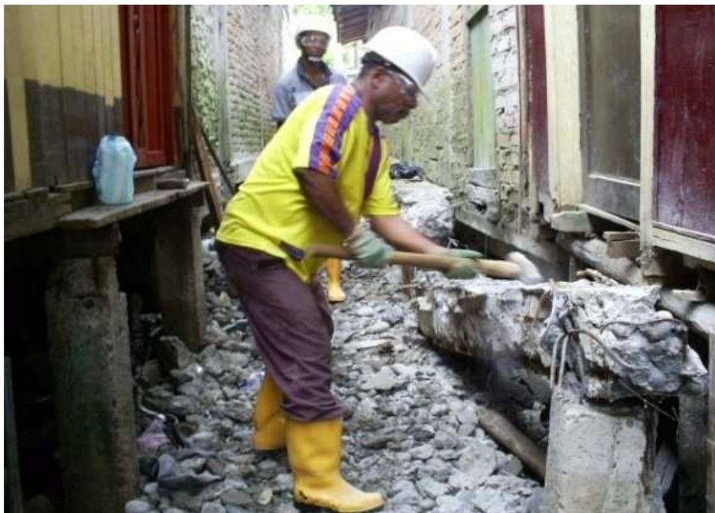
Fotografía 11. Demolición puente Barracón 1.
