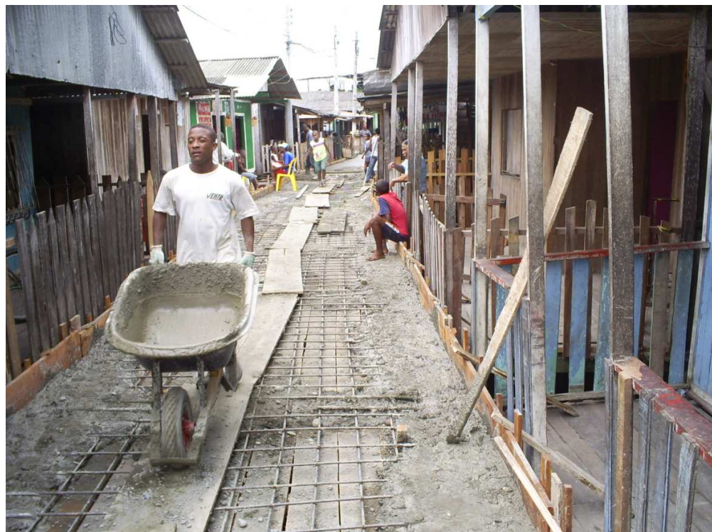
Fotografía 7. Transporte de concreto.
