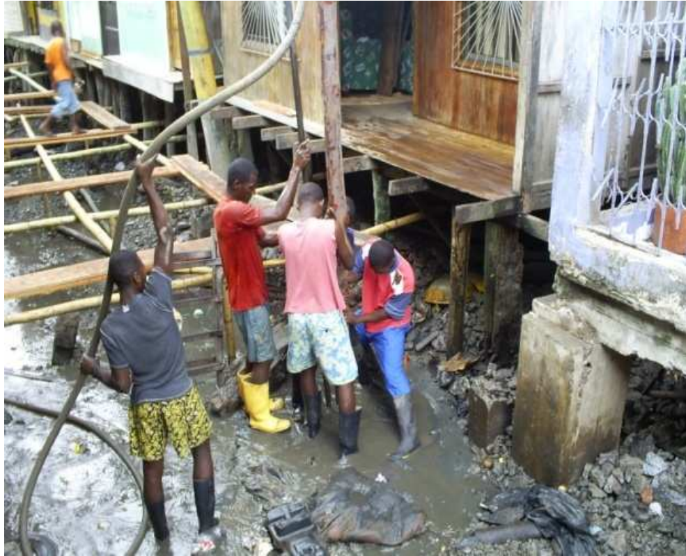
Fotografía 15. Hincado de pilotes en madera puente Barracón 3.
