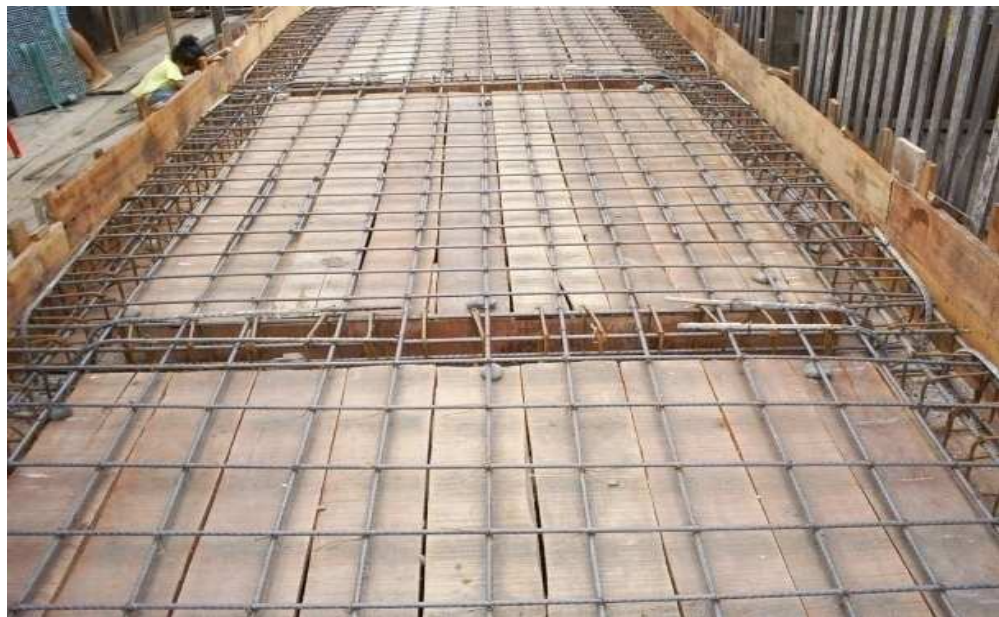
Fotografía 23. Encofrado y armado vigas aéreas y losa puente Humberto Manzi.
