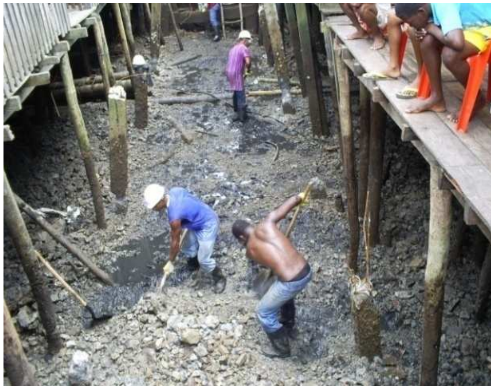
Fotografía 12. Desalojo de escombros puente Barracón 1.
