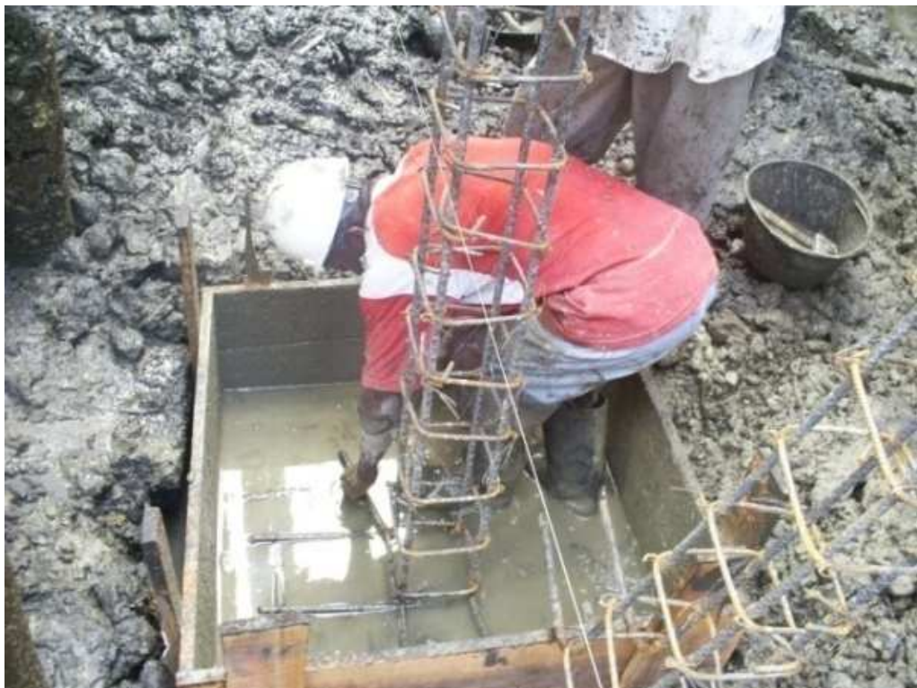
Fotografía 19. Fundición zapatas puente Barracón 4.
