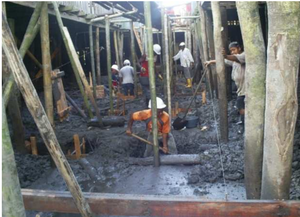
Fotografía 16. Excavación manual de tierra puente Barracón 3.
