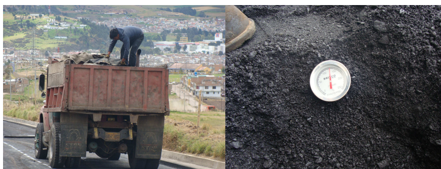
Figura 24. Chequeo de la temperatura de llegada del asfalto
