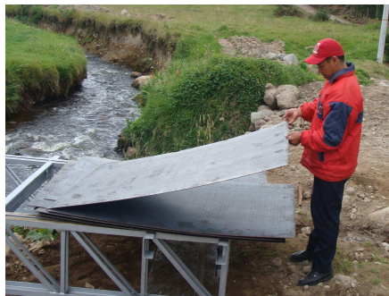
Figura 54. Instalación de lámina de alfajor
