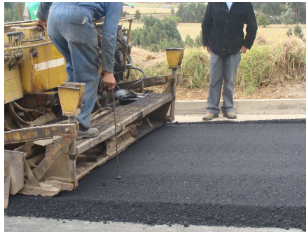
Figura 27. Verificación del espesor de la carpeta asfáltica
