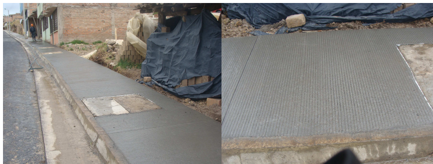
Figura 39. Andén en concreto clase D
