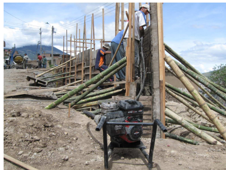
Figura 78. Vaciado y vibrado del concreto
