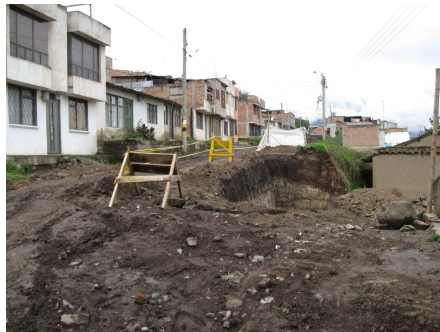
Figura 74. Trabajos culminados de la excavación para construcción de muro de contención
