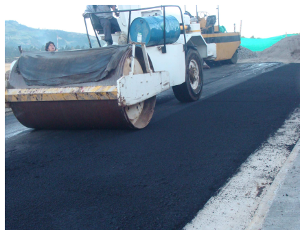
Figura 29. Compactación de las juntas longitudinales
