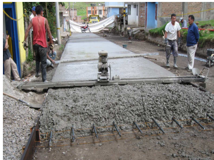
Figura 85. Vibrado con regla vibratoria
