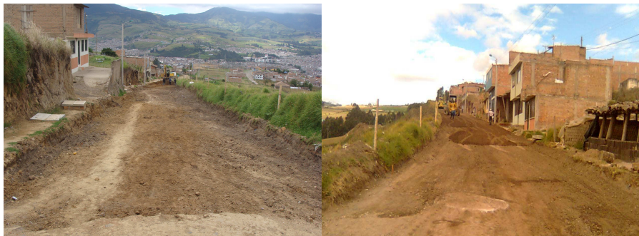
Figura 15. Nivelación y escarificación
