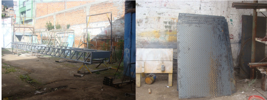
Figura 42. Construcción del puente en el taller
