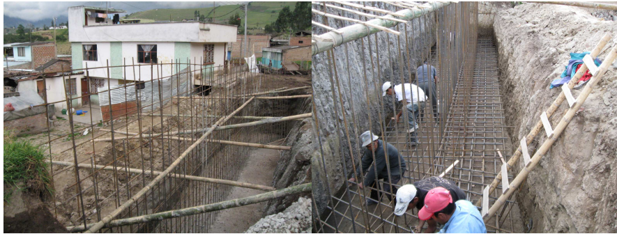
Figura 76. Armado del hierro
