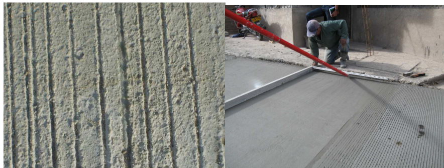
Figura 88. Macrotextura con cepillo metálico
