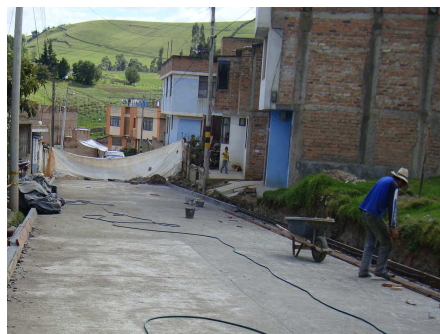
Figura 93. Vaciado del concreto para el sardinel
