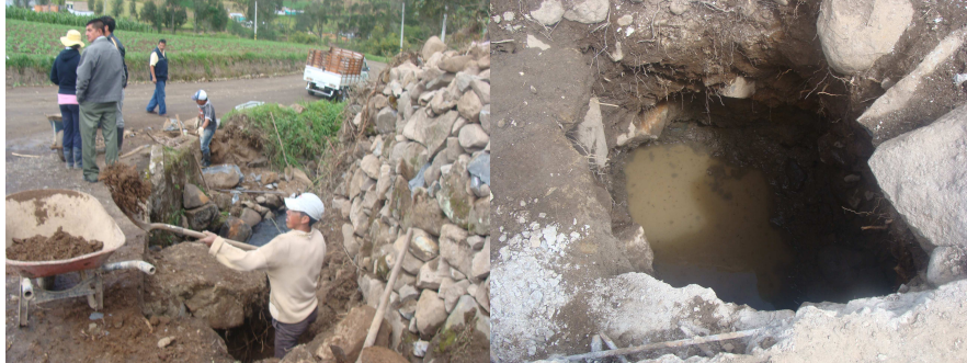
Figura 58. Excavación en roca bajo agua
