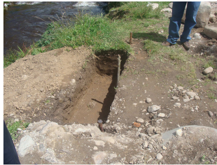
Figura 49. Preparación del terreno
