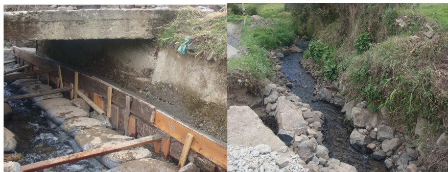
Figura 60. Desvió quebrada para la cimentación
