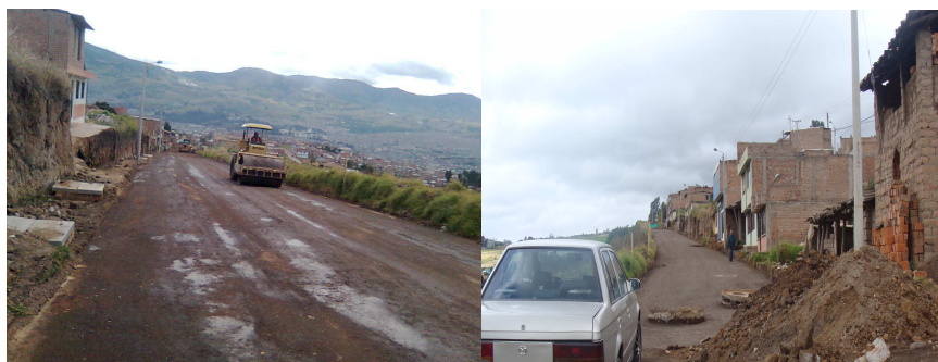
Figura 18. Compactación de la capa de subbase
