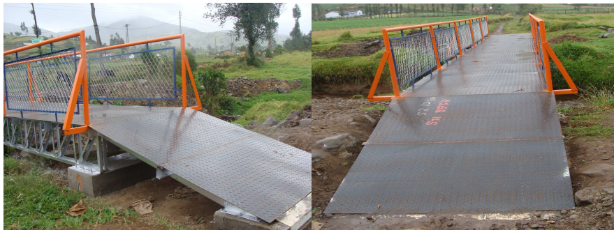
Figura 56. Instalación de rampas
