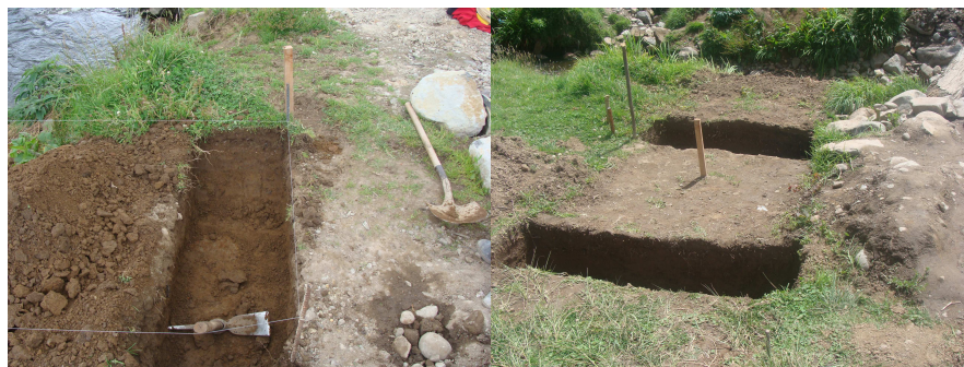
Figura 48. Excavación para cimiento
