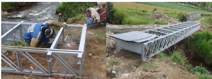
Figura 53. Instalación de la cercha en estructura metálica
