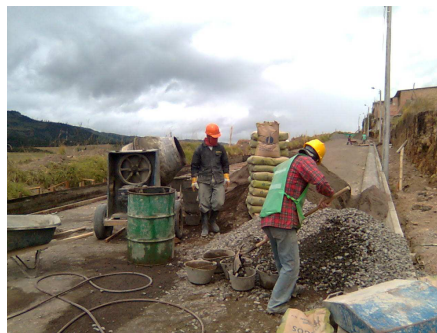
Figura 34. Elaboración del concreto
