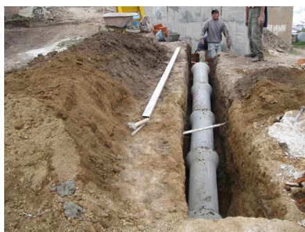
Figura 96. Instalación de tubería
