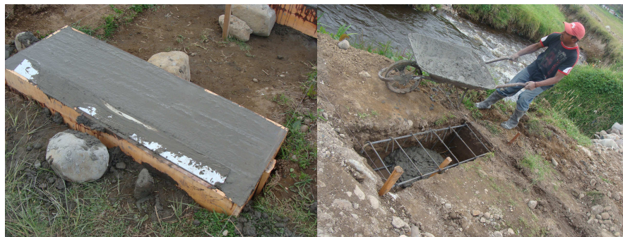
Figura 51. Vaciado de concreto
