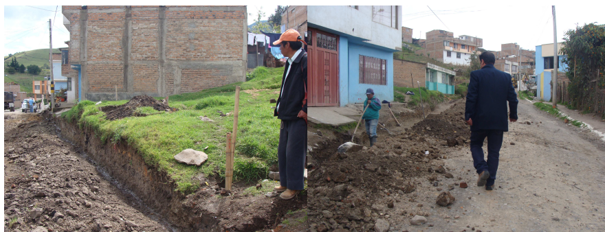
Figura 70. Cambio de redes domiciliarias.
