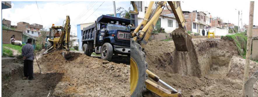
Figura 72. Excavación mecánica en material común de la explanación, canales y préstamos
