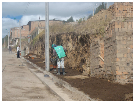
Figura 38. Compactación del material de base
