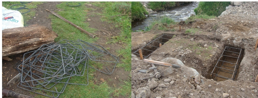
Figura 50. Colocación de acero de refuerzo
