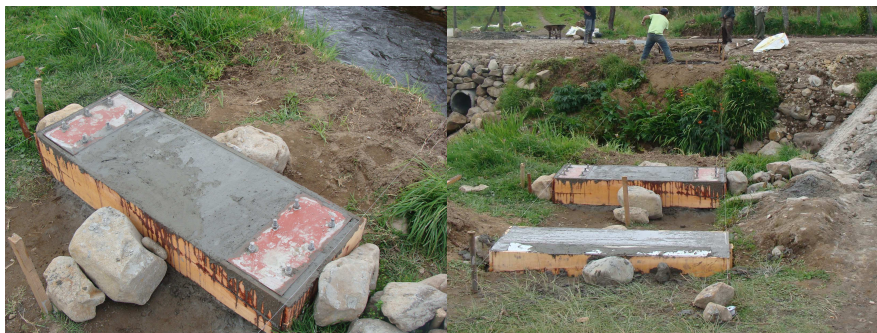
Figura 52. Colocado de platinas para cercha principal
