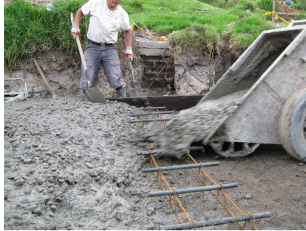
Figura 82. Vaciado del concreto
