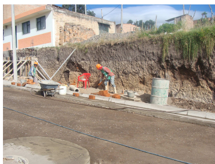
Figura 37. Preparación del terreno
