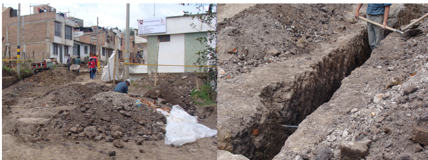
Figura 95. Excavación para tubería de alcantarillado
