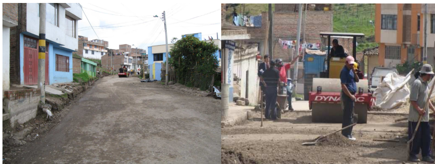
Figura 81. Compactación de la base
