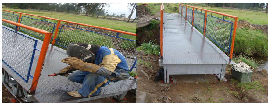
Figura 55. Instalación de baranda metálica
