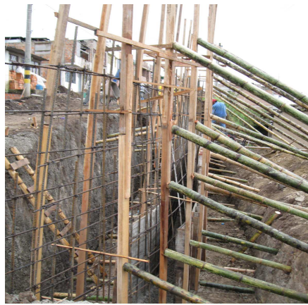
Figura 77. Instalación de la formaleta
