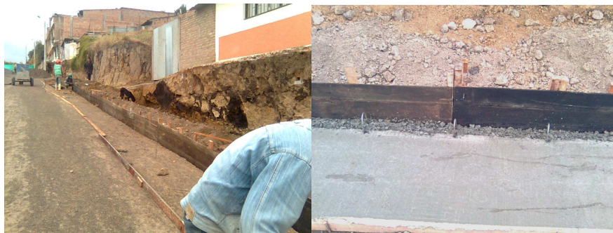
Figura 33. Colocación de la formaleta
