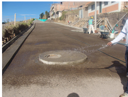
Figura 22. Humectación de la superficie
