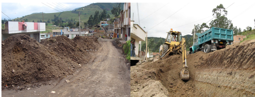
Figura 73. Retiro y disposición de material sobrante
