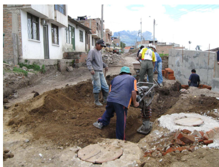
Figura 97. Compactación relleno de zanjas para alcantarillado
