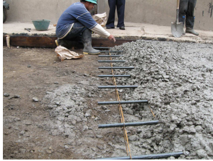
Figura 86. Colocación de pasadores en las juntas
