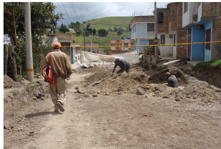
Figura 69. Preparación del terreno.
