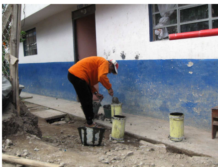
Figura 91. Toma de cilindros de concreto de losas de pavimento
