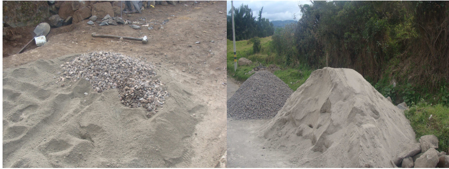
Figura 61. Materiales de la cimentación
