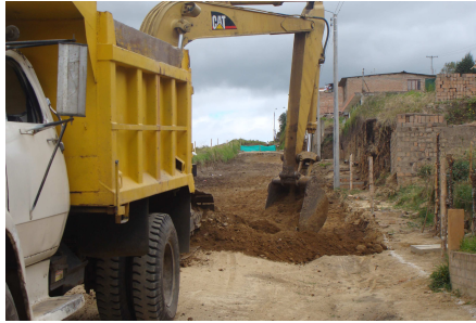
Figura 14. Actividades de excavación
