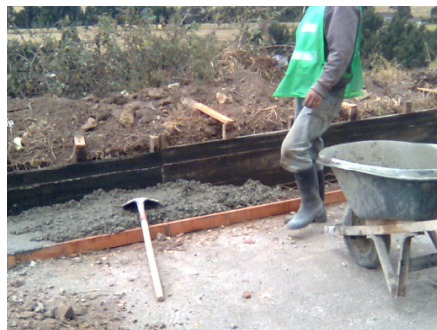
Figura 35. Vaciado del concreto
