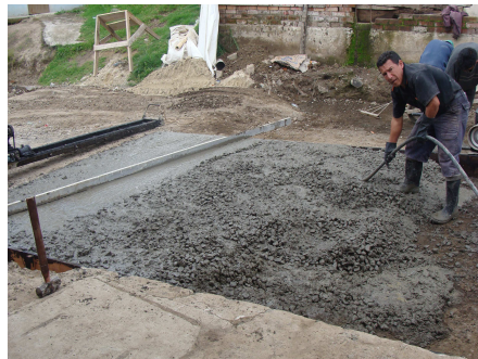
Figura 84. Vibrado con vibrador de aguja
