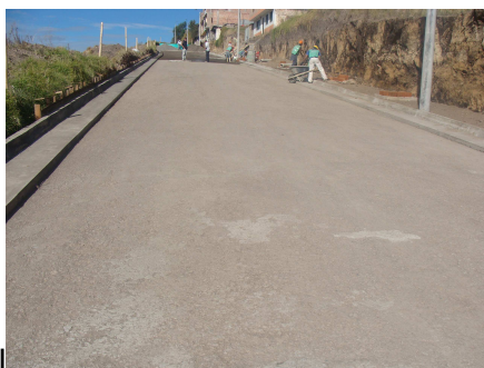
Figura 20. Capa de base compactada
