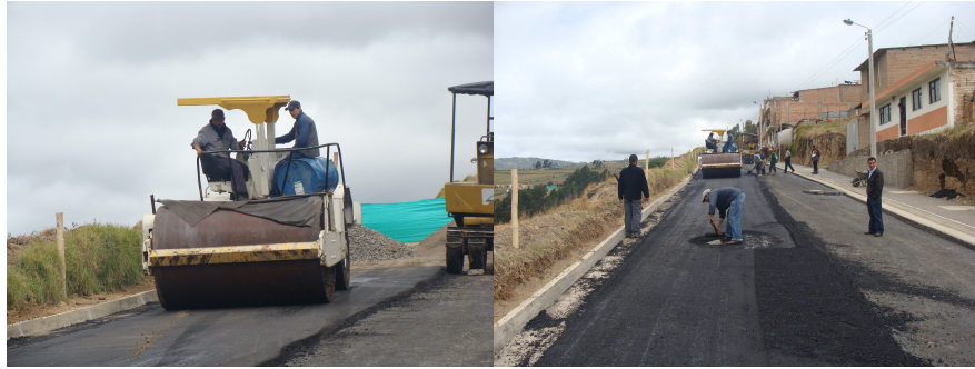
Figura 28. Compactación de la carpeta asfáltica
