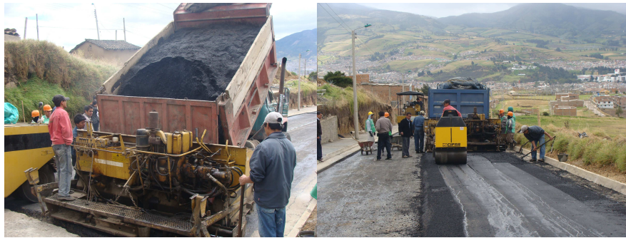
Figura 26. Extensión de la mezcla asfáltica
