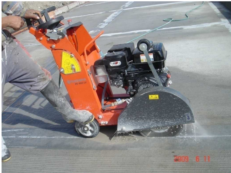
Figura 28. Corte de la junta de dilatación de la losa de concreto.
