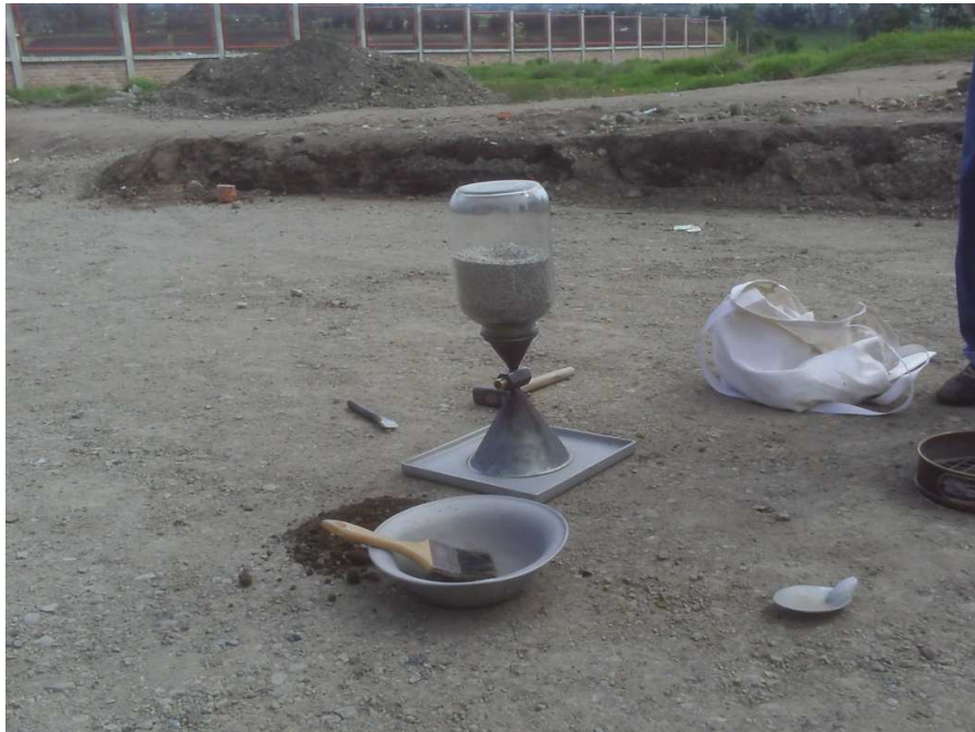
Figura 37. Ensayo de densidad en sitio. Método del cono y arena.
