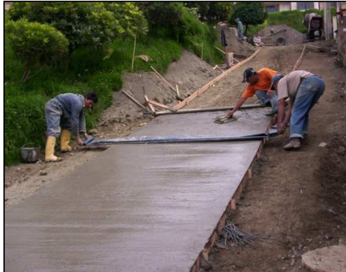
Figura 27. Texturizado de la losa de concreto (la Dorada).
