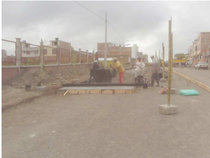
Figura 8. Colocación del concreto.
