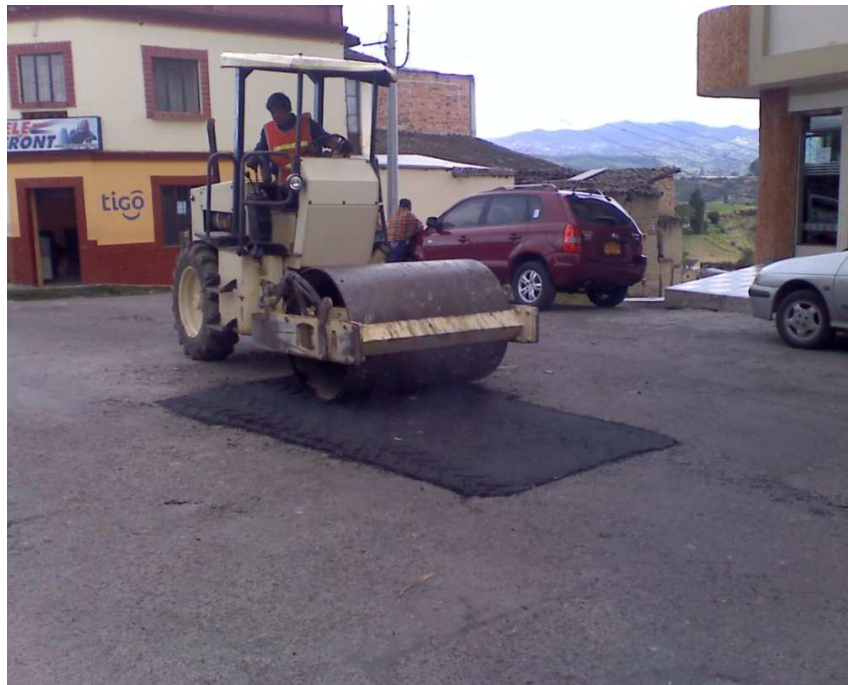
Figura 41 Compactación del concreto asfáltico, carrera 11 entre calle 13 y 14.
