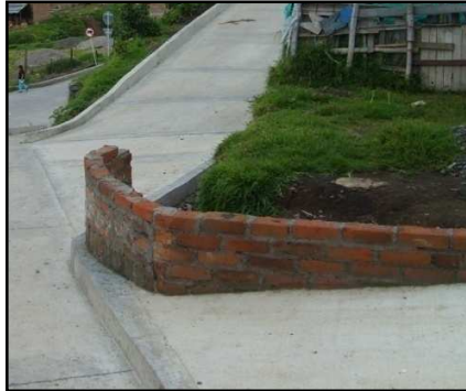
Figura 12. Construcción de Muros
