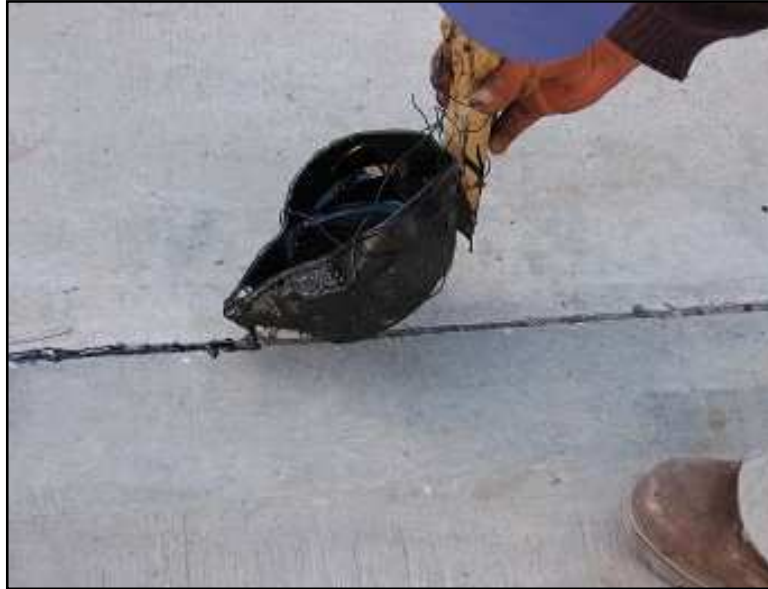
Figura 29. Sellamiento de las juntas de dilatación con material ligante.
