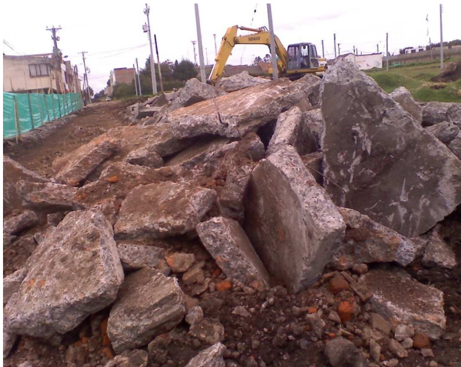
Figura 2. Demolición de la superficie de rodadura deteriorada de la cra. 8ª.
