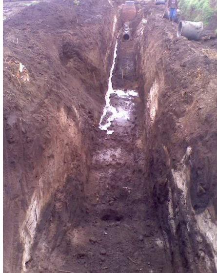
Figura 1. Excavación remplazo de redes de acueducto, alcantarillado y retiro de material.
