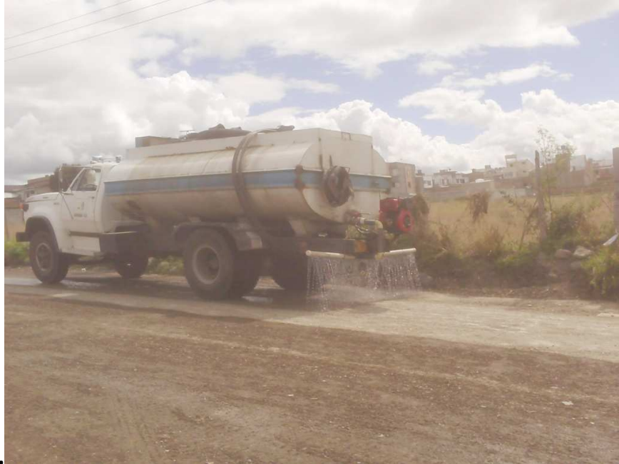
Figura 6. Llevar el material a la humedad optima para obtener la compactación requerida, cra. 5ª entre 23 y
