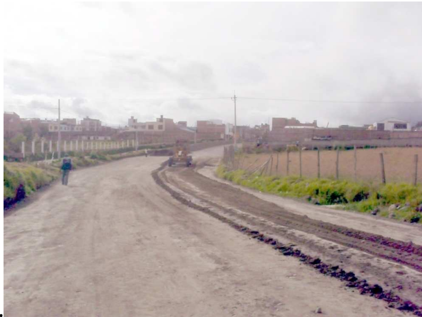
Figura 5. Conformación del material cra. 5ª entre 23 y
