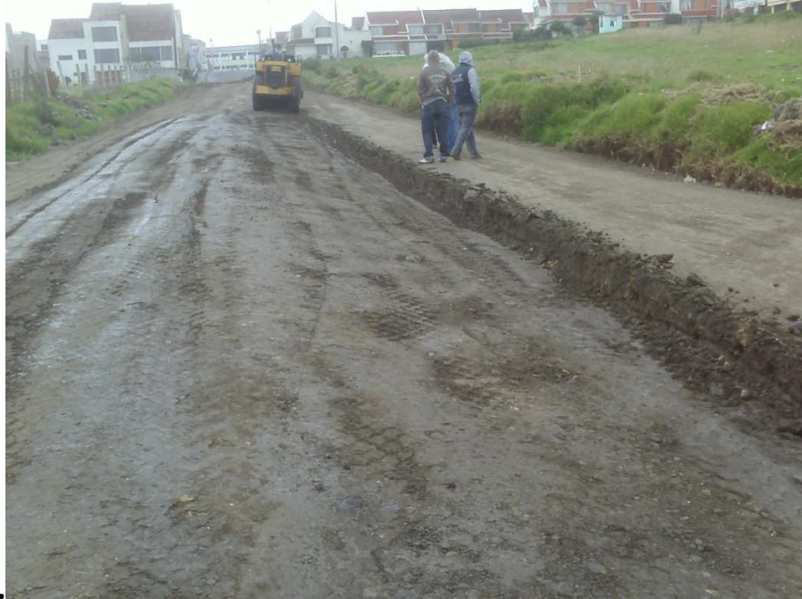
Figura 7 compactación del material granular cra. 5ª entre 23 y
